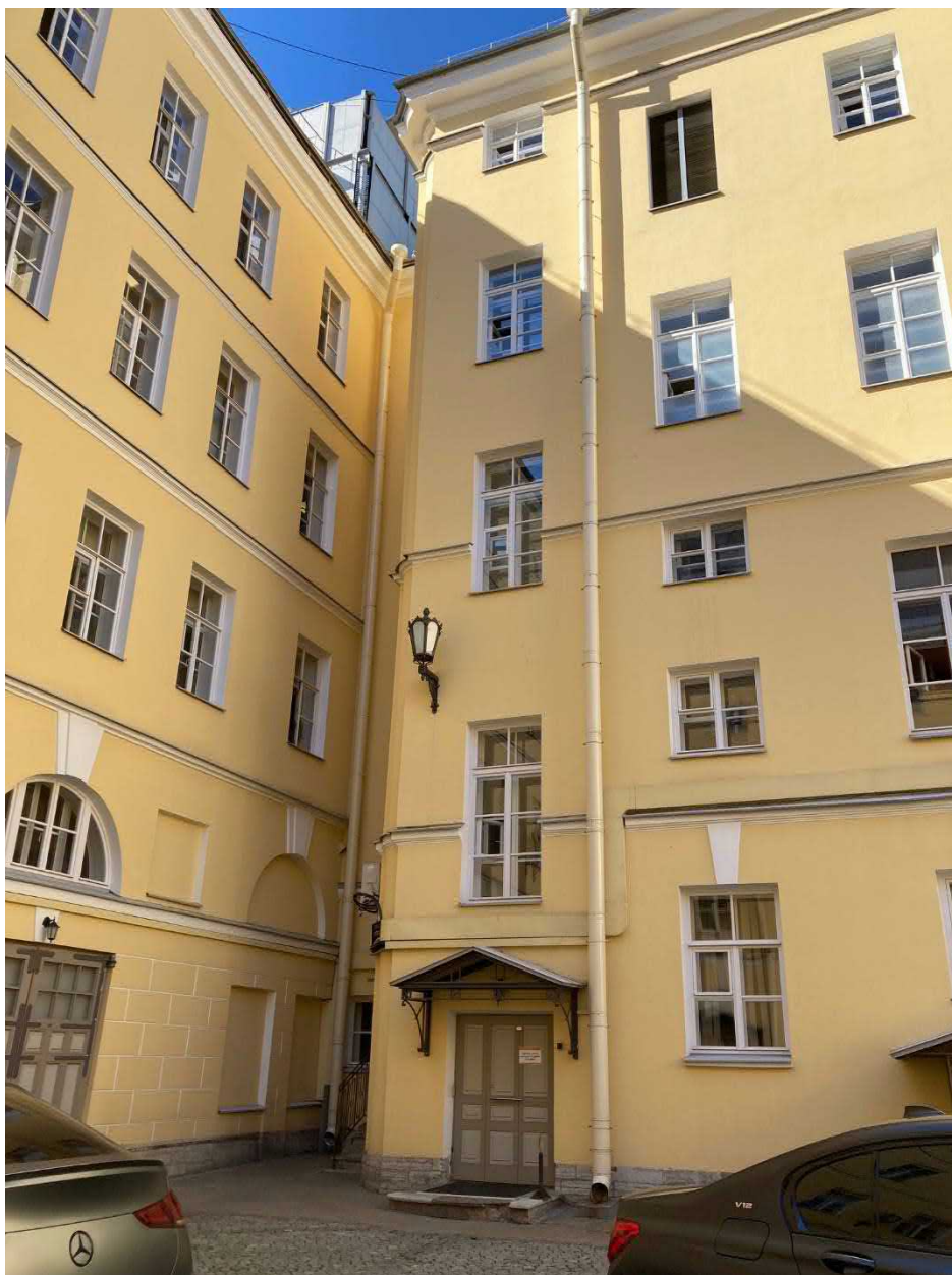
Фото 13. ОКН федерального значения «Дом Голенищева-Кутузова П.В. Здесь в 1924 – 1939 гг. жил художник Бродский И.И.» (Санкт-Петербург, Искусств пл., 3, лит. А). Двор. Водосточные трубы
