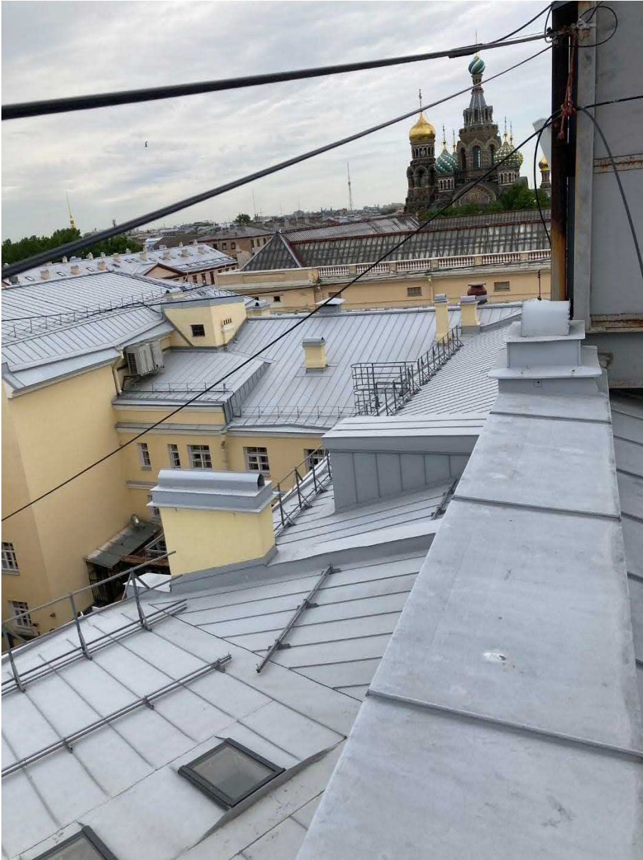
Фото 6. ОКН федерального значения «Театр Михайловский» (Санкт-Петербург, Искусств пл., 1, Инженерная ул., 1, кан. Грибоедова наб. 4). Крыша
