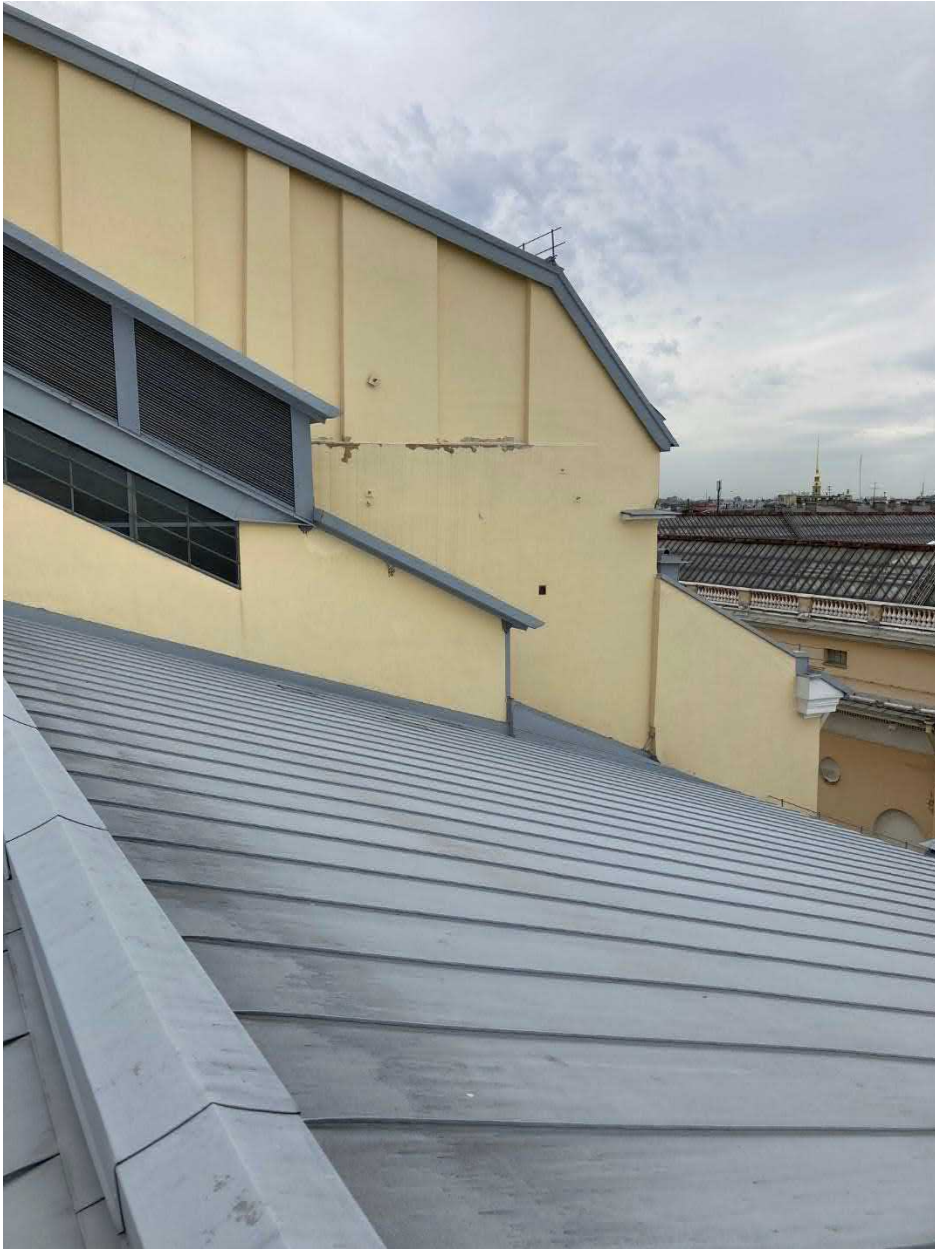
Фото 7. ОКН федерального значения «Театр Михайловский» (Санкт-Петербург, Искусств пл., 1, Инженерная ул., 1, кан. Грибоедова наб. 4). Крыша
