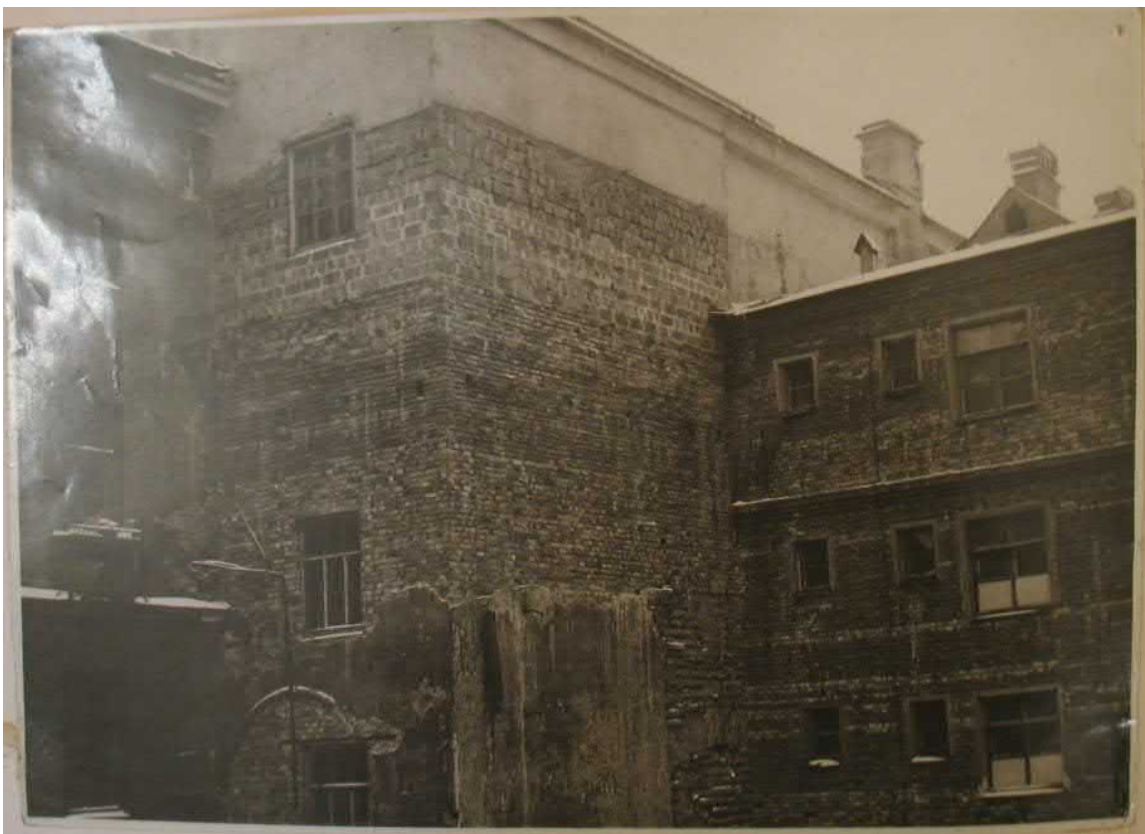
Илл. 26. Строительство репетиционных залов и расширение гримуборных . Вид со двора. 1937 г. Фото из собрания театра.
