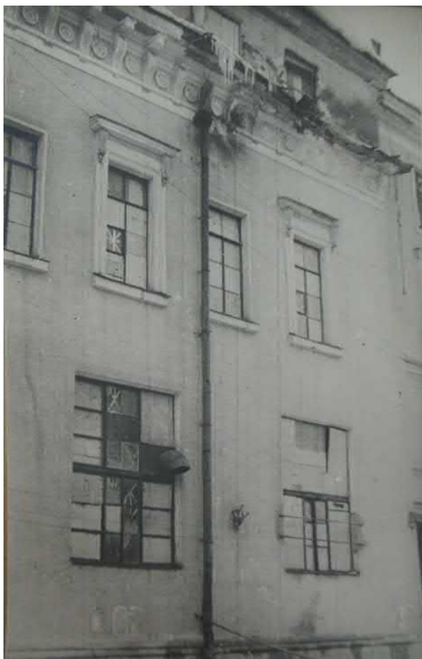
Илл. 29. Михайловский театр. Разрушение карниза артиллерийским снарядом. 1944 г. / Архив КГИОП. П-199.
