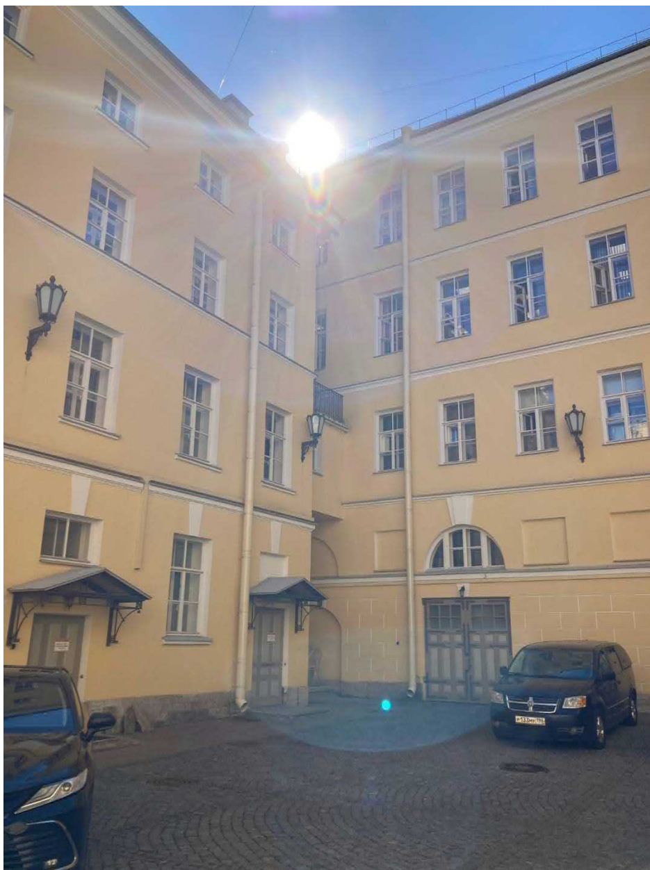
Фото 12. ОКН федерального значения «Дом Голенищева-Кутузова П.В. Здесь в 1924 – 1939 гг. жил художник Бродский И.И.» (Санкт-Петербург, Искусств пл., 3, лит. А). Двор. Водосточные трубы
