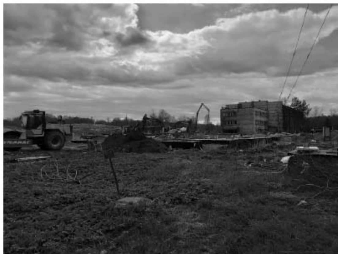
Рис. 14. СПб-2022. Красносельский район. МО Горелово. Комплекс по переработке отходов Волхонка. Общий вид участка обследования. Точка фотофиксации 4. Вид с юга.
