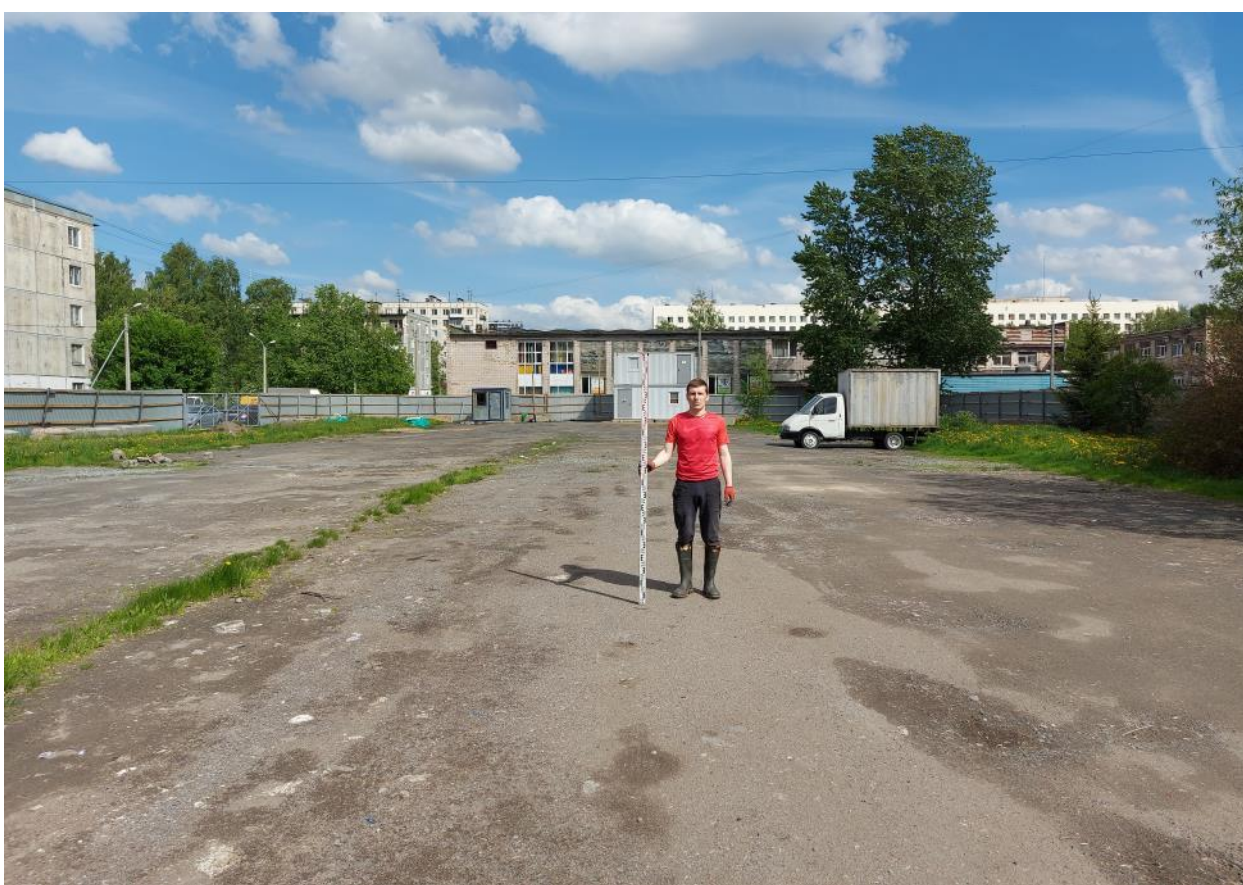
Рис. 14. Общий вид участка обследования. Вид на восток.
