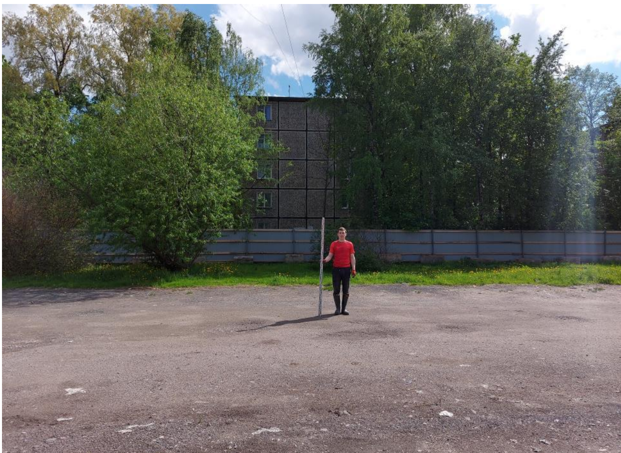
Рис. 11. Общий вид участка обследования. Вид на юг.
