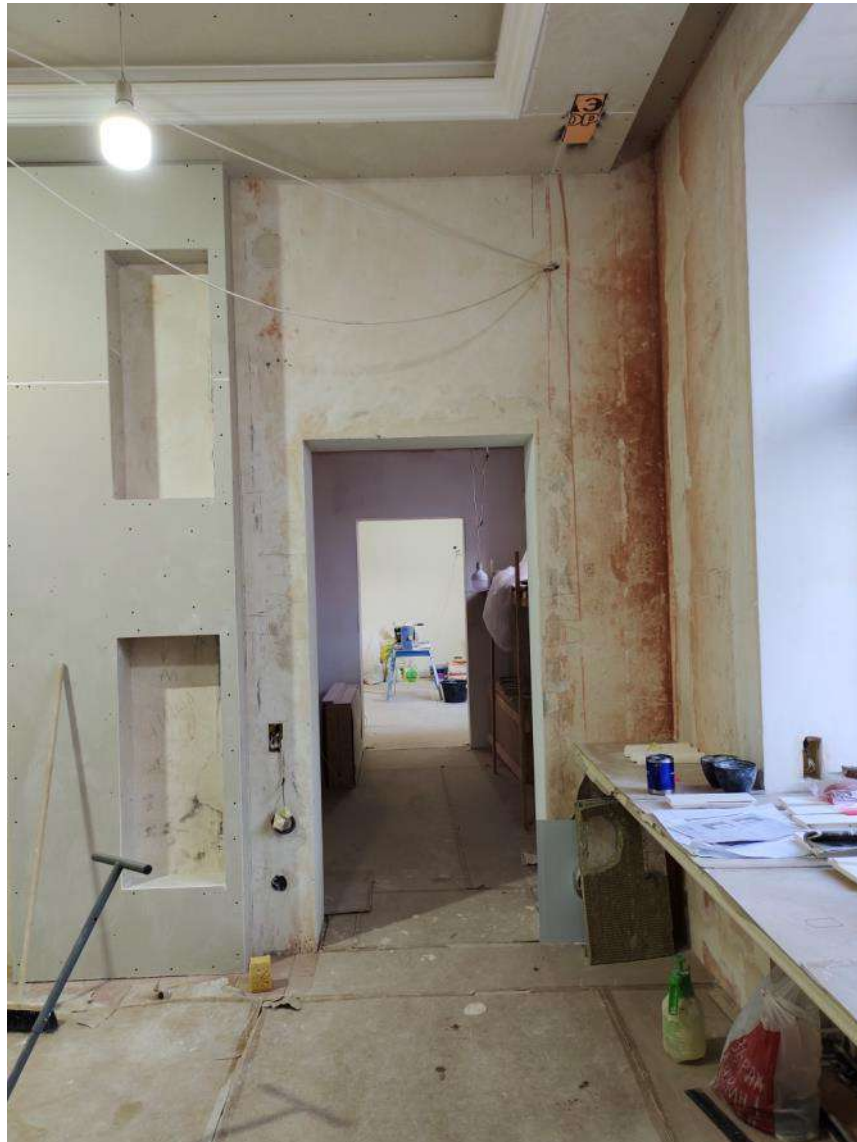
23. Объект культурного наследия регионального значения «Дом М.П. Толстого» (г. Санкт-Петербург, Фонтанки р. наб., 54; Рубинштейна ул., 15-17). Помещение квартиры № 563.
