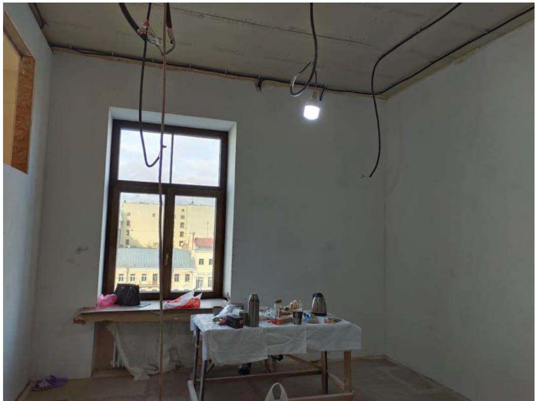
39. Объект культурного наследия регионального значения «Дом М.П. Толстого» (г. Санкт-Петербург, Фонтанки р. наб., 54; Рубинштейна ул., 15-17). Помещение квартиры № 563.
