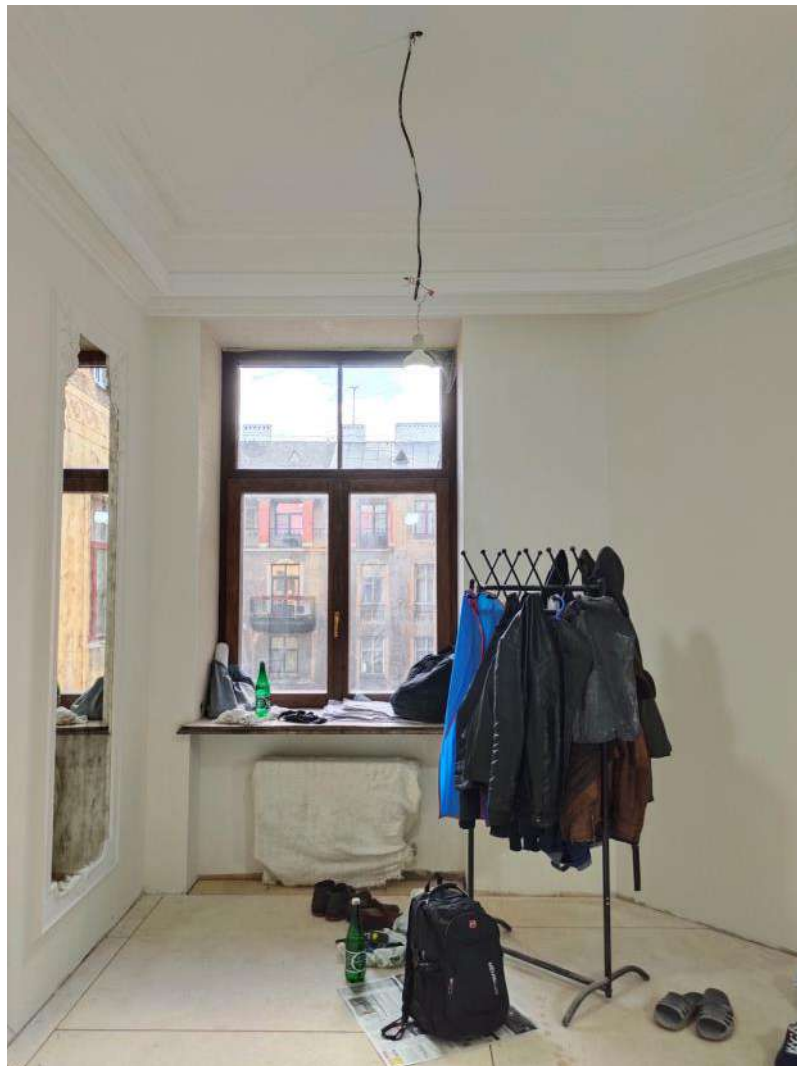
45. Объект культурного наследия регионального значения «Дом М.П. Толстого» (г. Санкт-Петербург, Фонтанки р. наб., 54; Рубинштейна ул., 15-17). Помещение квартиры № 563.
