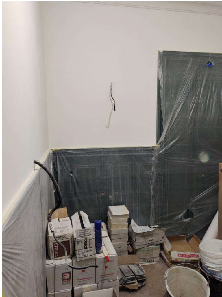
41. Объект культурного наследия регионального значения «Дом М.П. Толстого» (г. Санкт-Петербург, Фонтанки р. наб., 54; Рубинштейна ул., 15-17). Помещение квартиры № 563.
