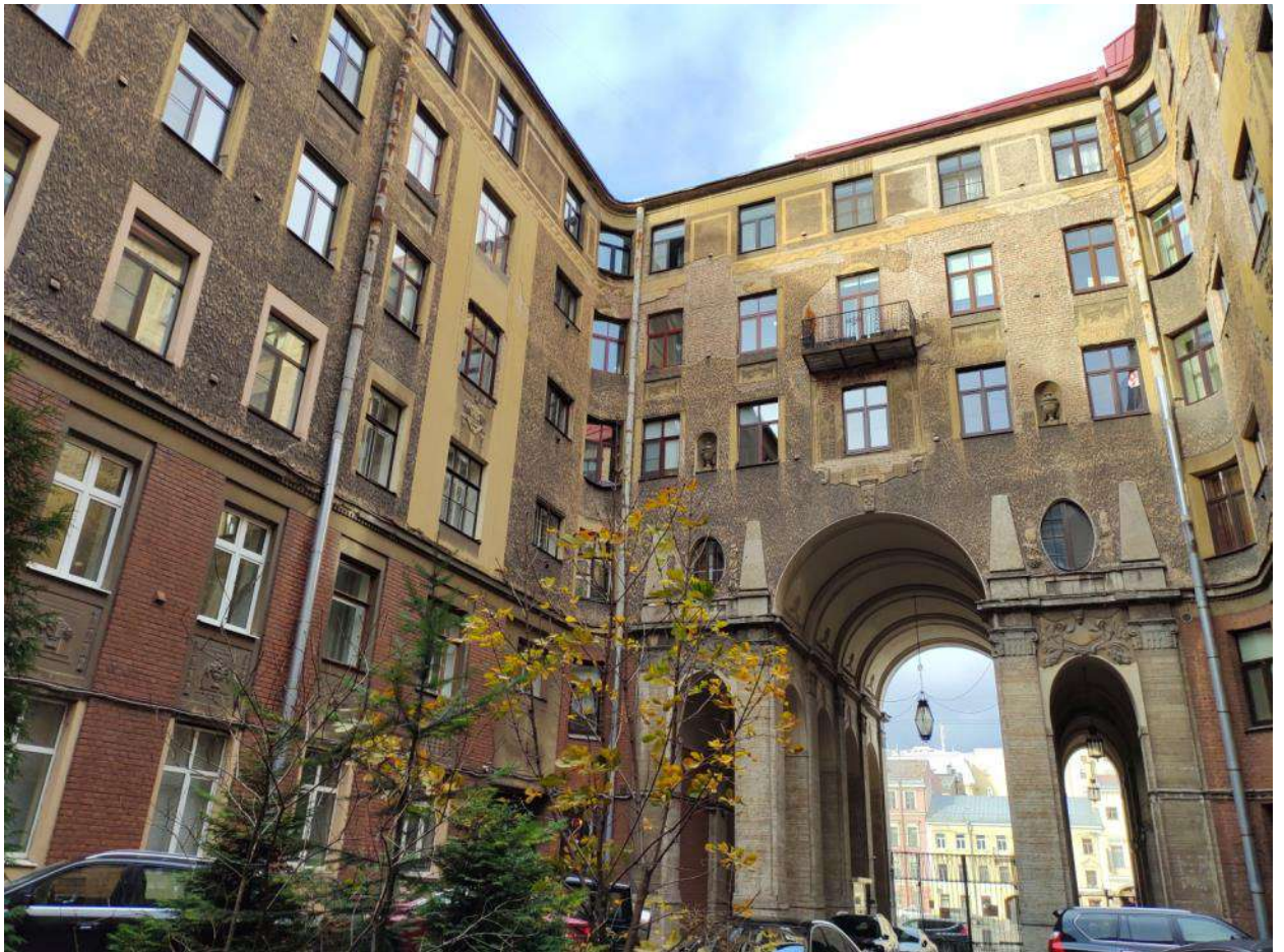
5. Объект культурного наследия регионального значения «Дом М.П. Толстого» (г. Санкт-Петербург, Фонтанки р. наб., 54; Рубинштейна ул., 15-17). Парадный двор.
