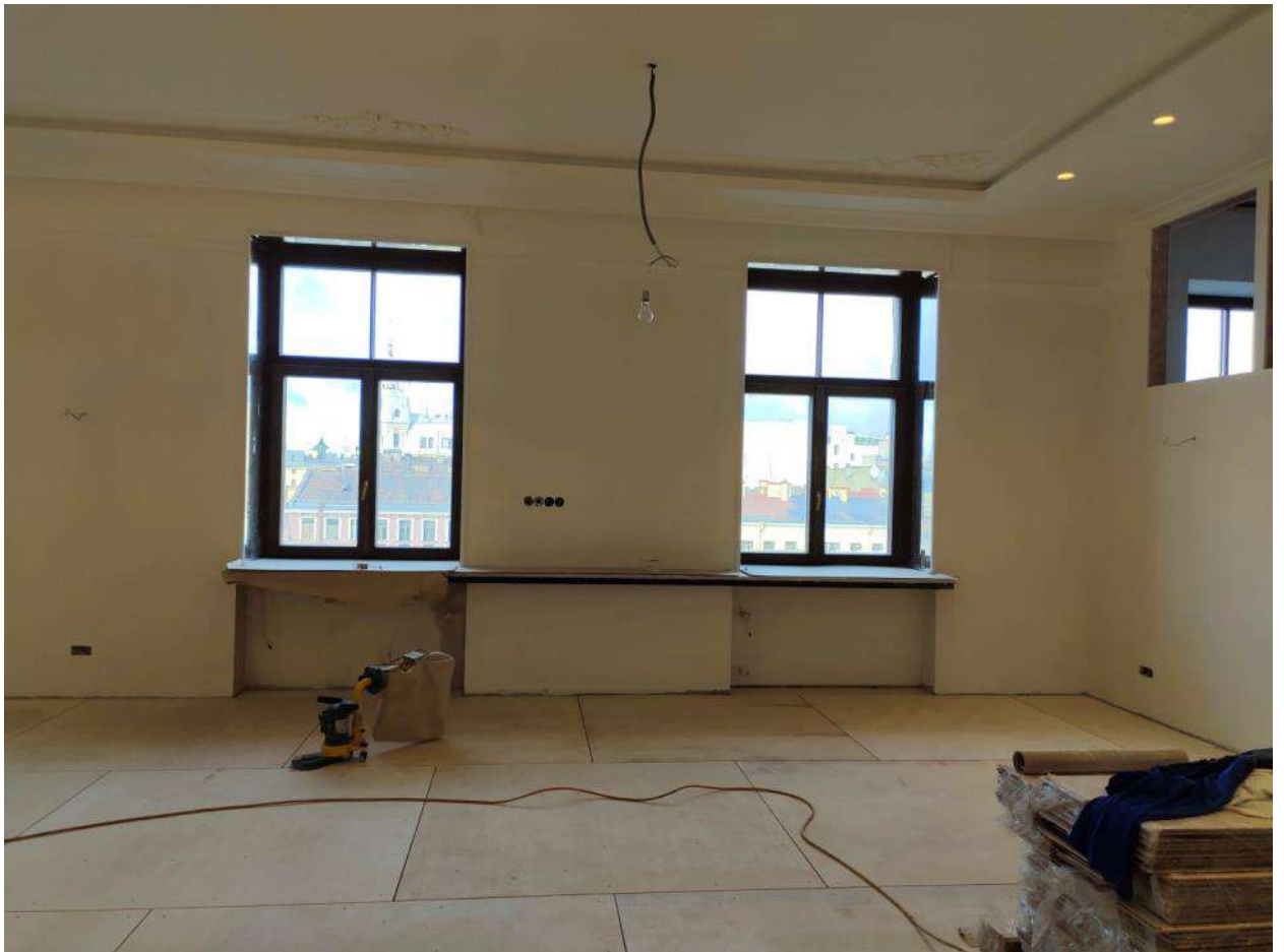
37. Объект культурного наследия регионального значения «Дом М.П. Толстого» (г. Санкт-Петербург, Фонтанки р. наб., 54; Рубинштейна ул., 15-17). Помещение квартиры № 563.
