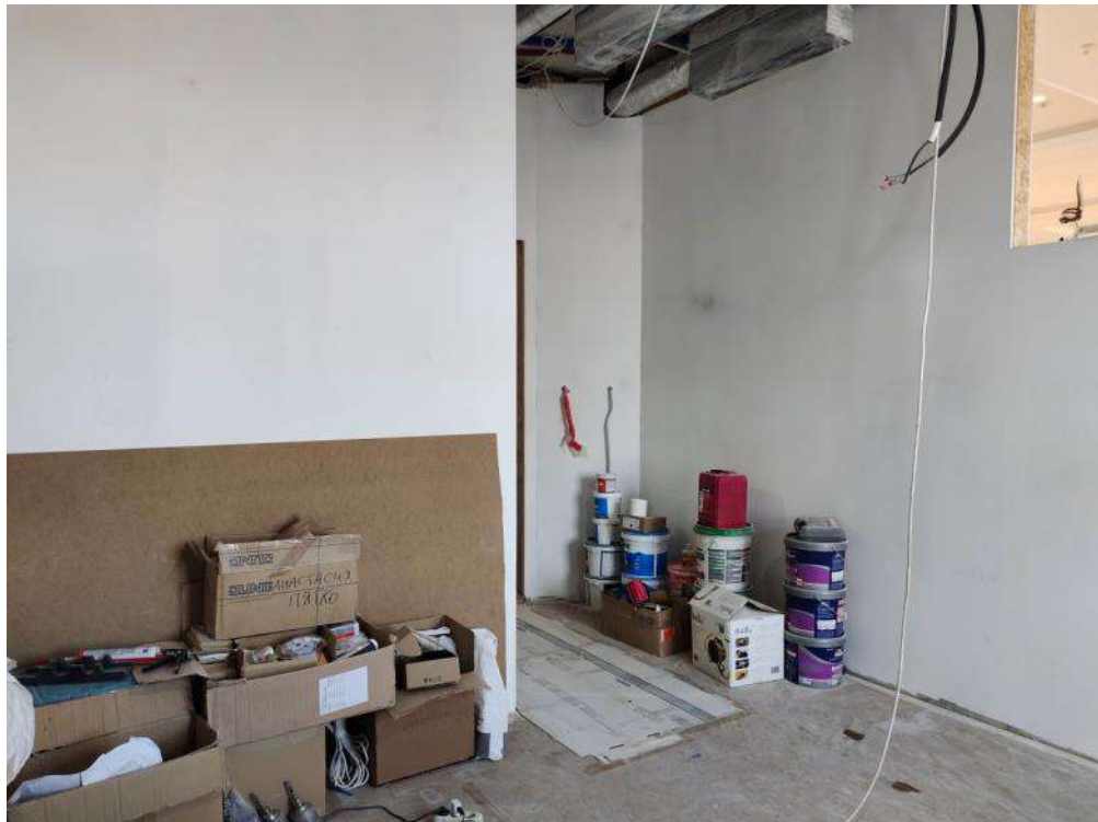
40. Объект культурного наследия регионального значения «Дом М.П. Толстого» (г. Санкт-Петербург, Фонтанки р. наб., 54; Рубинштейна ул., 15-17). Помещение квартиры № 563.
