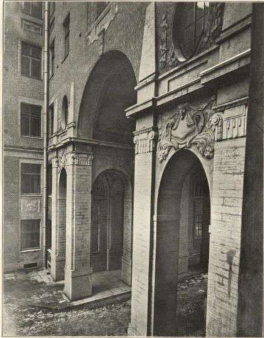
Домовый дворъ. С.-Петербургъ, Фонтанка, 32-34. Проектъ и стр. Ф. И. ЛИНДАЛЬ, академ. архит. С.П.Бурга.
