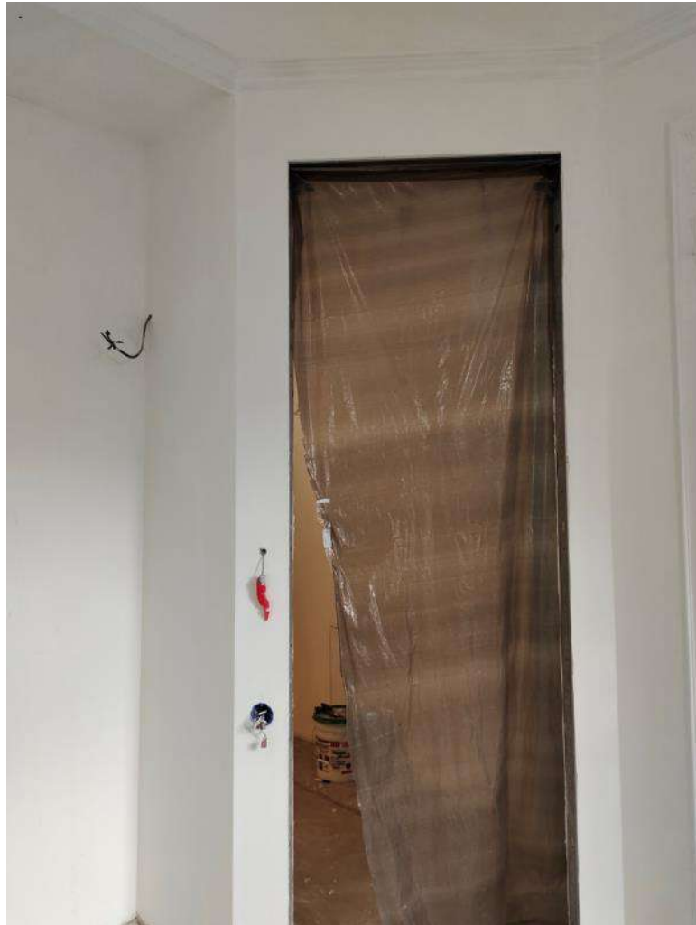
46. Объект культурного наследия регионального значения «Дом М.П. Толстого» (г. Санкт-Петербург, Фонтанки р. наб., 54; Рубинштейна ул., 15-17). Помещение квартиры № 563.
