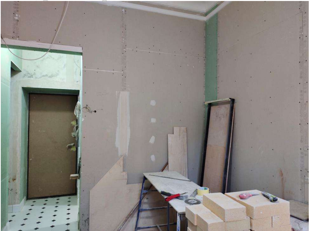
22. Объект культурного наследия регионального значения «Дом М.П. Толстого» (г. Санкт-Петербург, Фонтанки р. наб., 54; Рубинштейна ул., 15-17). Помещение квартиры № 563.
