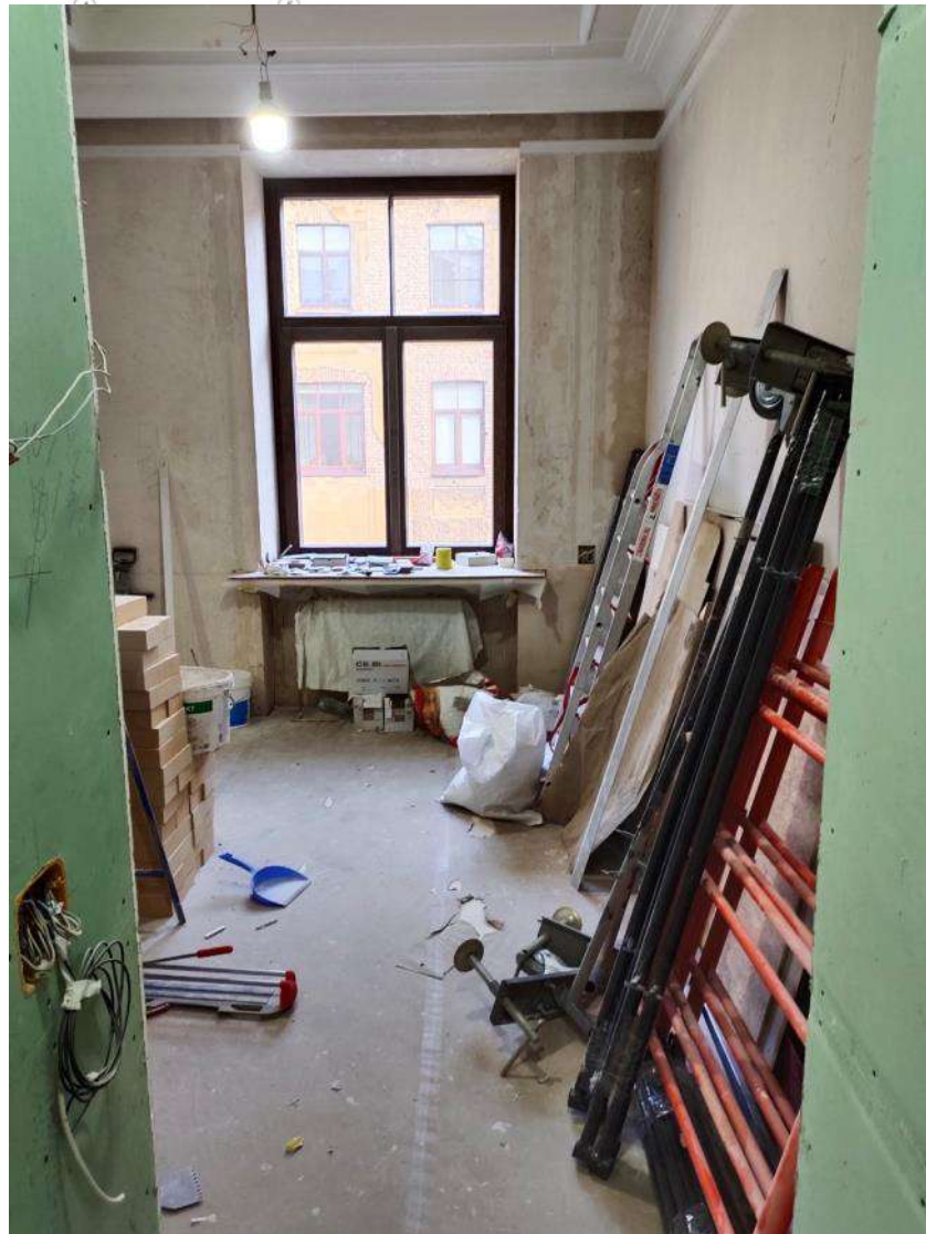
21. Объект культурного наследия регионального значения «Дом М.П. Толстого» (г. Санкт-Петербург, Фонтанки р. наб., 54; Рубинштейна ул., 15-17). Помещение квартиры № 563.
