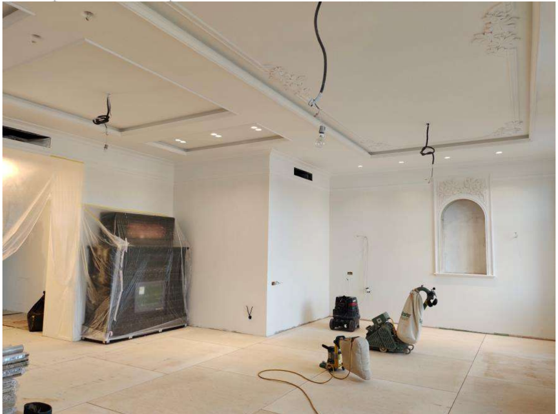
35. Объект культурного наследия регионального значения «Дом М.П. Толстого» (г. Санкт-Петербург, Фонтанки р. наб., 54; Рубинштейна ул., 15-17). Помещение квартиры № 563.
