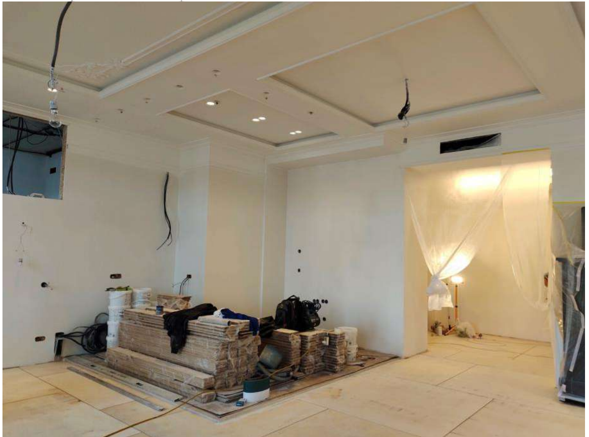
36. Объект культурного наследия регионального значения «Дом М.П. Толстого» (г. Санкт-Петербург, Фонтанки р. наб., 54; Рубинштейна ул., 15-17). Помещение квартиры № 563.
