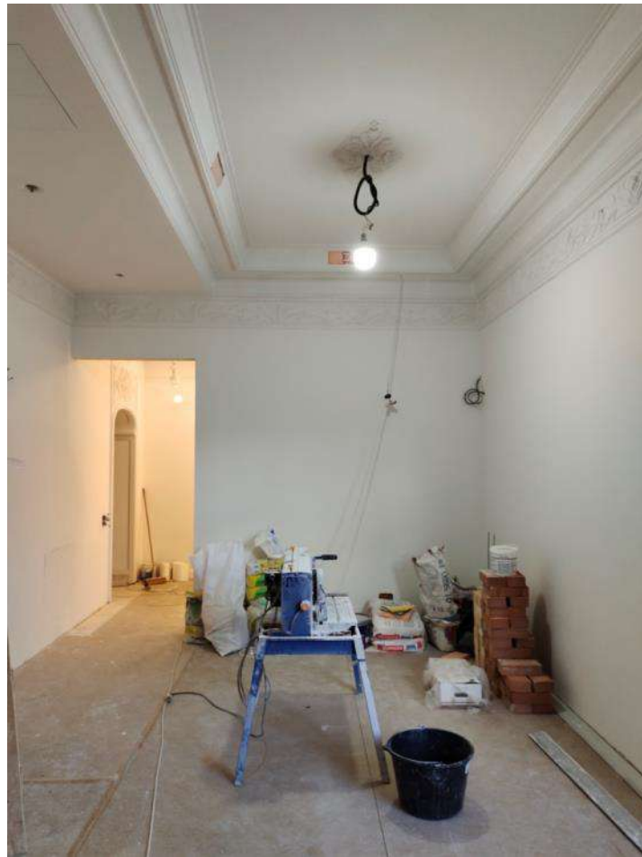
31. Объект культурного наследия регионального значения «Дом М.П. Толстого» (г. Санкт-Петербург, Фонтанки р. наб., 54; Рубинштейна ул., 15-17). Помещение квартиры № 563.
