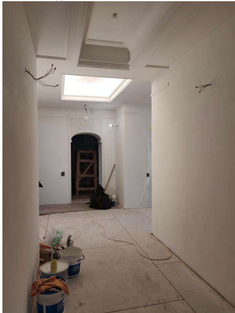
38. Объект культурного наследия регионального значения «Дом М.П. Толстого» (г. Санкт-Петербург, Фонтанки р. наб., 54; Рубинштейна ул., 15-17). Помещение квартиры № 563.
