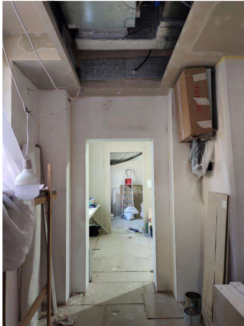
28. Объект культурного наследия регионального значения «Дом М.П. Толстого» (г. Санкт-Петербург, Фонтанки р. наб., 54; Рубинштейна ул., 15-17). Помещение квартиры № 563.
