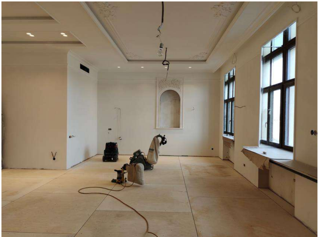
34. Объект культурного наследия регионального значения «Дом М.П. Толстого» (г. Санкт-Петербург, Фонтанки р. наб., 54; Рубинштейна ул., 15-17). Помещение квартиры № 563.
