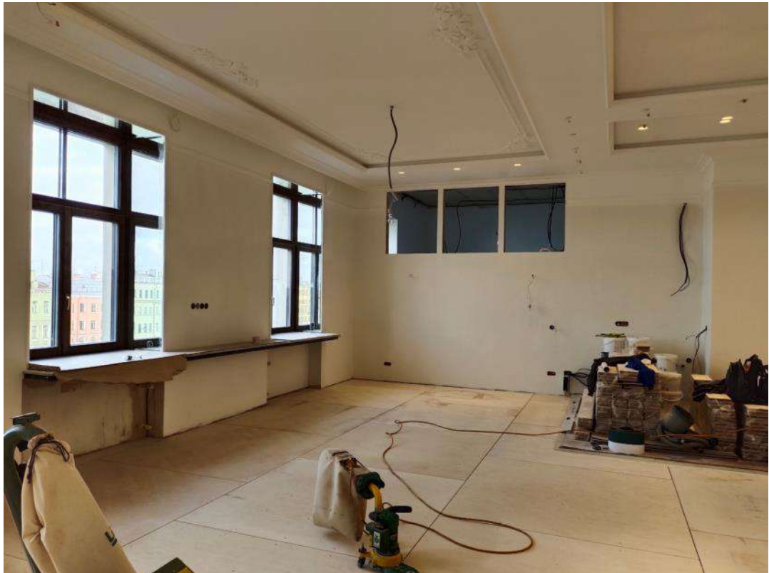
33. Объект культурного наследия регионального значения «Дом М.П. Толстого» (г. Санкт-Петербург, Фонтанки р. наб., 54; Рубинштейна ул., 15-17). Помещение квартиры № 563.
