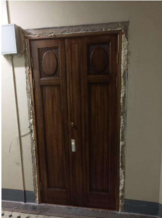
17. Объект культурного наследия регионального значения «Дом М.П. Толстого» (г. Санкт-Петербург, Фонтанки р. наб., 54; Рубинштейна ул., 15-17). Парадная лестница.
