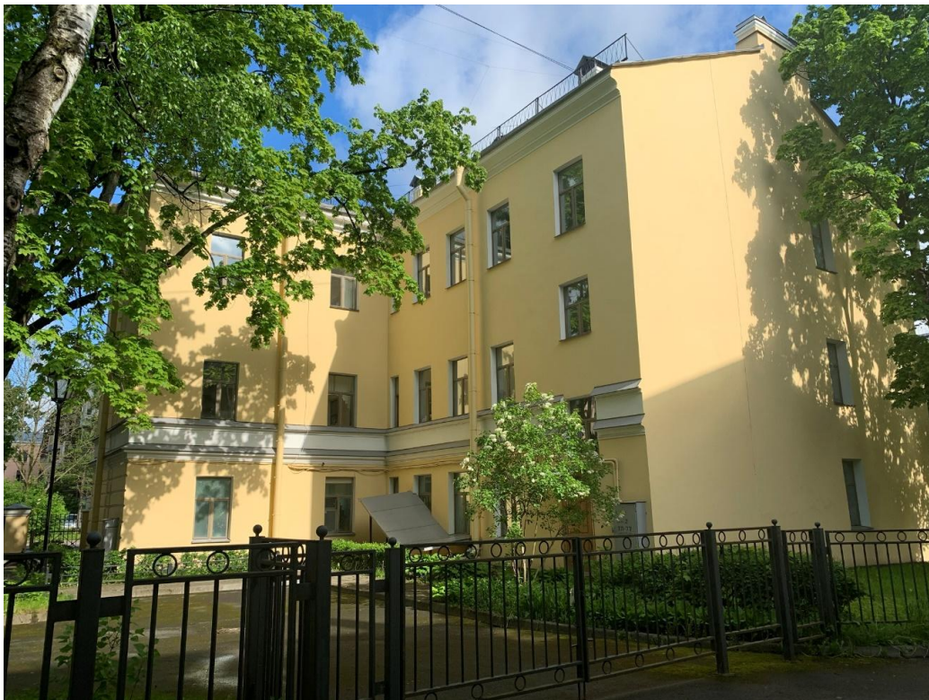
5. Выявленный объект культурного наследия «Дом Белозеровых» по адресу: г. Санкт-Петербург, Пушкинский район, г. Пушкин, ул. Конюшенная, д.33/35, лит. А. Дворовые фасады. Общий вид.
