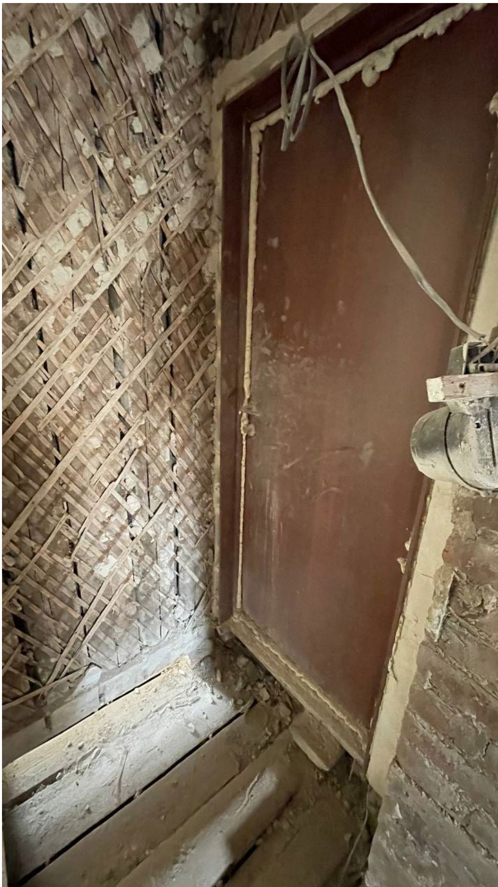
12. Вид на дверь в комнату (помещение №8);
