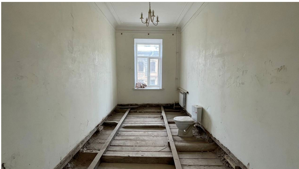
16. Фрагмент интерьера комнаты (помещение №6);
