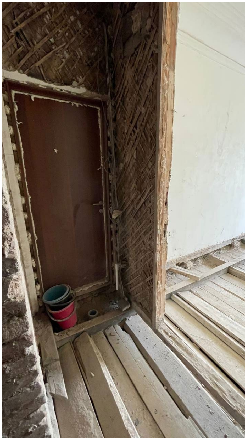
14. Вид на дверь в комнату (помещение №5);
