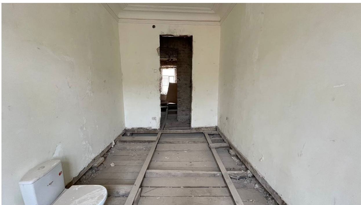
17. Фрагмент интерьера комнаты (помещение №6);
