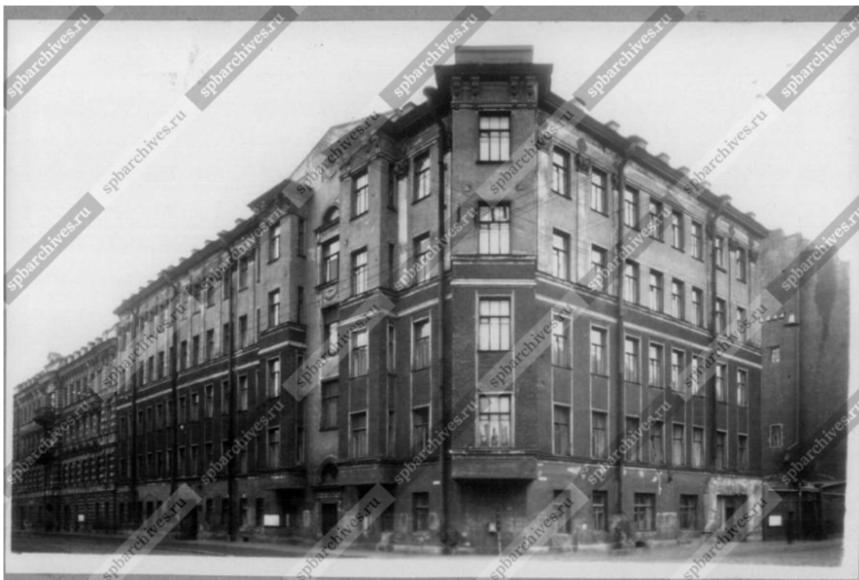
Илл. 24. Общий вид фасада углового дома №25-32 на пересечении Дегтярной улицы и 7-й Советской улицы. ЦГАКФФД СПб. Фотодокумент Гр 76137. 1960 г.;
