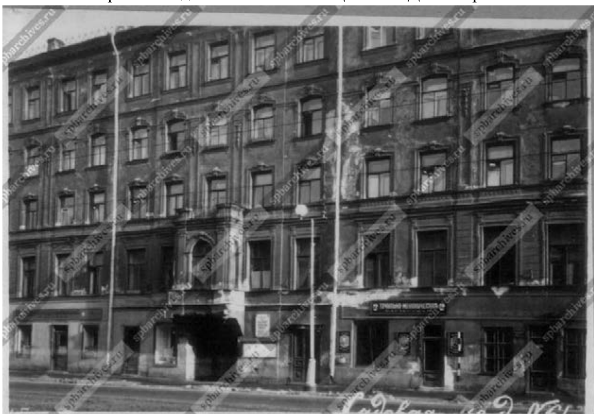
Илл. 97. Фасад дома №61 на Садовой улице. Бывший дом Шаховской (Чугреева), начало XIX века, перестроен в 1875 г. и 1903 г., архитекторы Ф.И.Черненко, Л.П.Андреев. 1949 г. ЦГАКФФД СПб Гр 71527.
