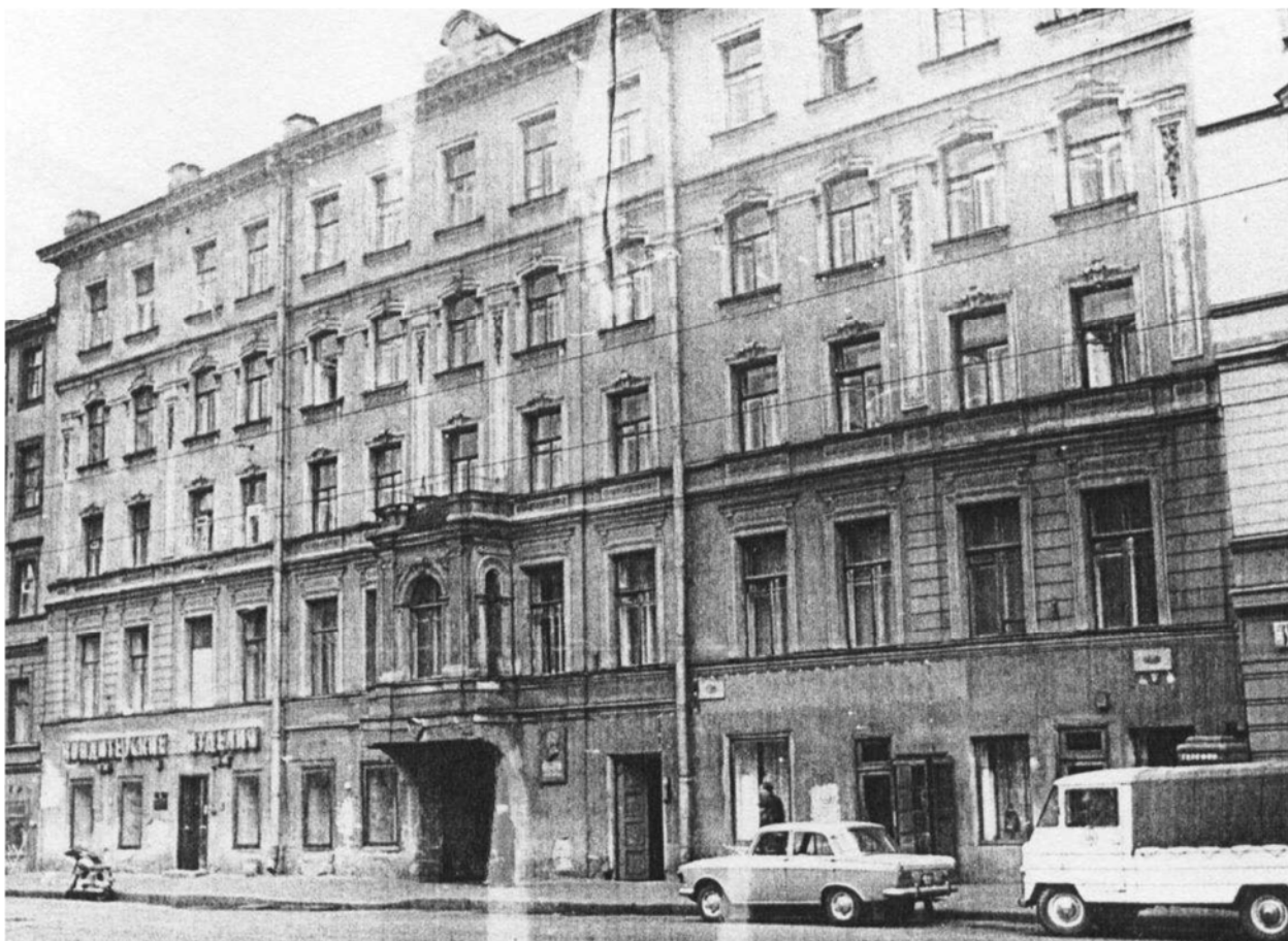
Илл.103 Фасад по Садовой ул. 1974г. Архив института «Ленжилпроект»
