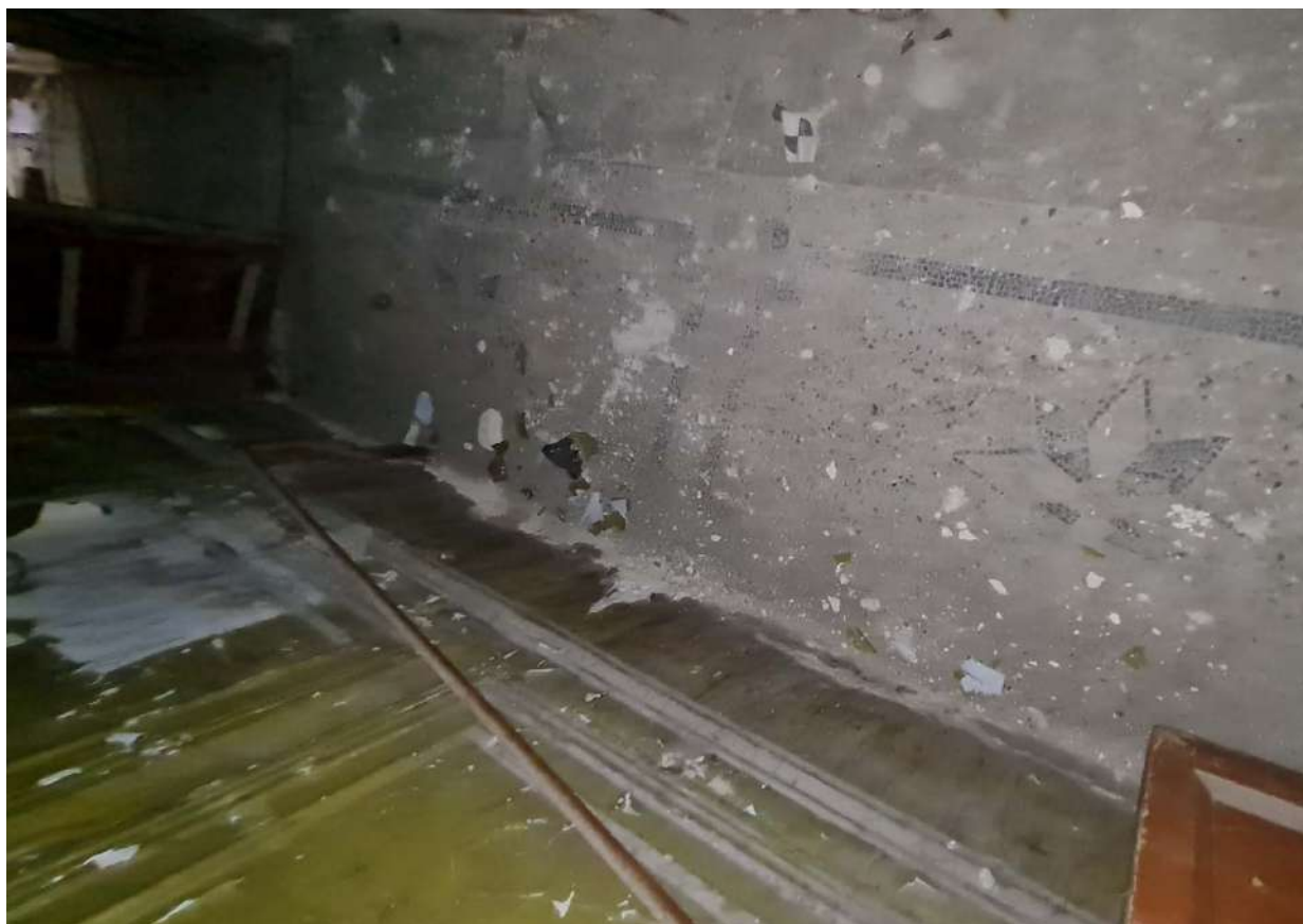
21. Объект культурного наследия регионального значения «Дом кн. Шаховской (купца Чугреева). В этом доме в 1836-1837 гг. жил М.Ю.Лермонтов» по адресу: Санкт-Петербург, Садовая ул., д.61, лит.А Лестница Л-3. Фрагмент наливного пола площадки лестницы Дата съемки: 23.06.2022
