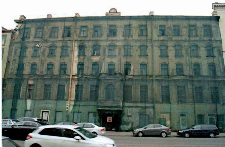
1. (Лицевой фасад по Садовой ул.)
