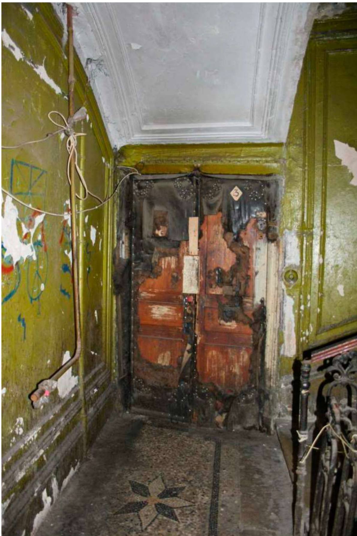
Илл. 123 Парадная лестница. Лестничная площадка, 2014 г. Фото из группы Вконтакте «Дом Лермонтова на Садовой, 61» https://vk.com/dom_lermontova
