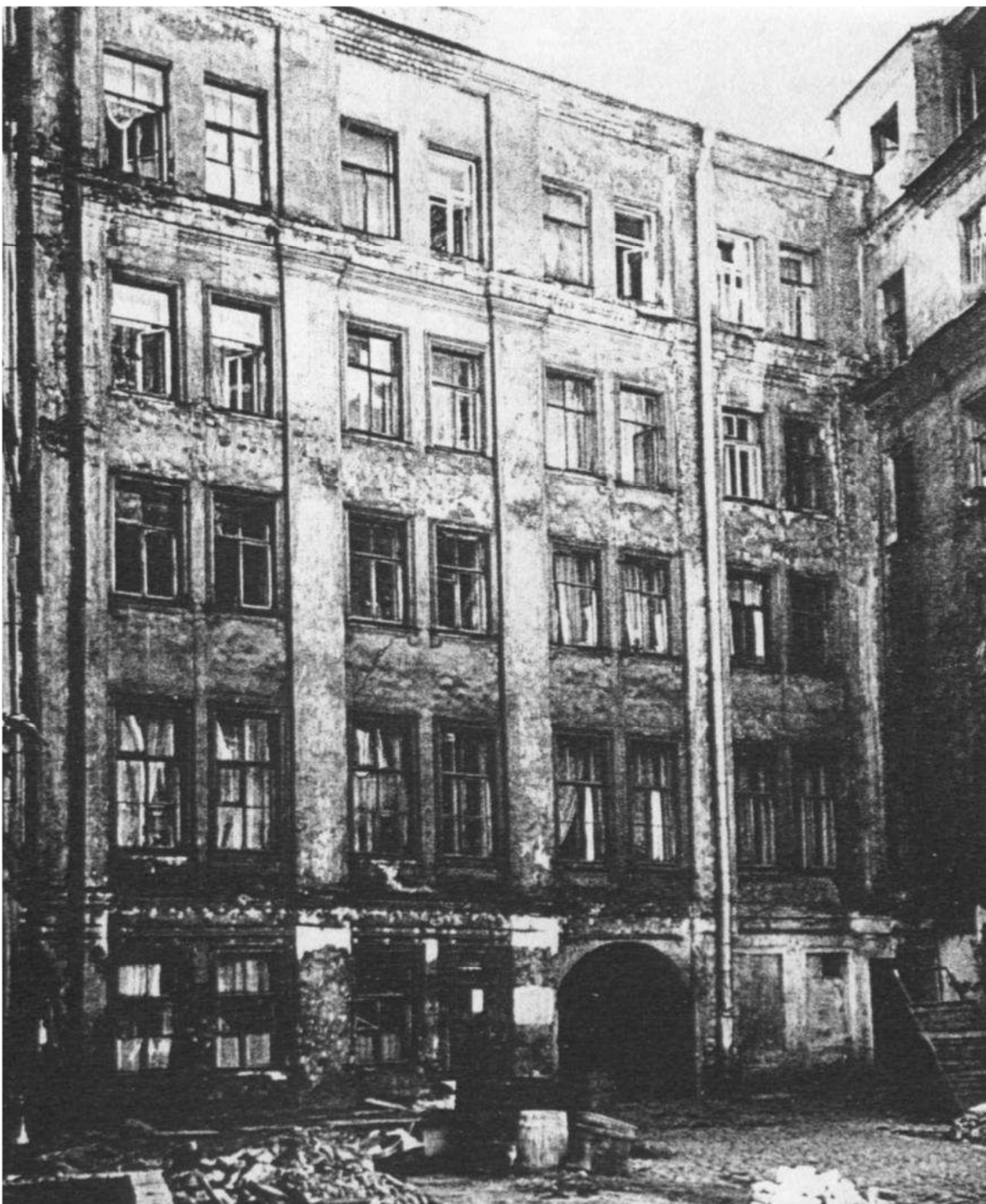
Илл. 109 Дворовый фасад лицевого флигеля. 1981 г. Архив института «Ленжилпроект»
