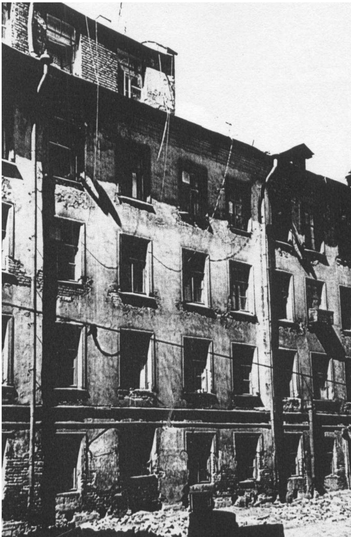
Илл. 110 Фасад западного дворового флигеля. 1981 г. Архив института «Ленжилпроект»
