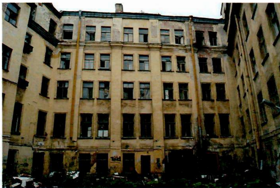
4. (Фрагмент дворового фасада)
