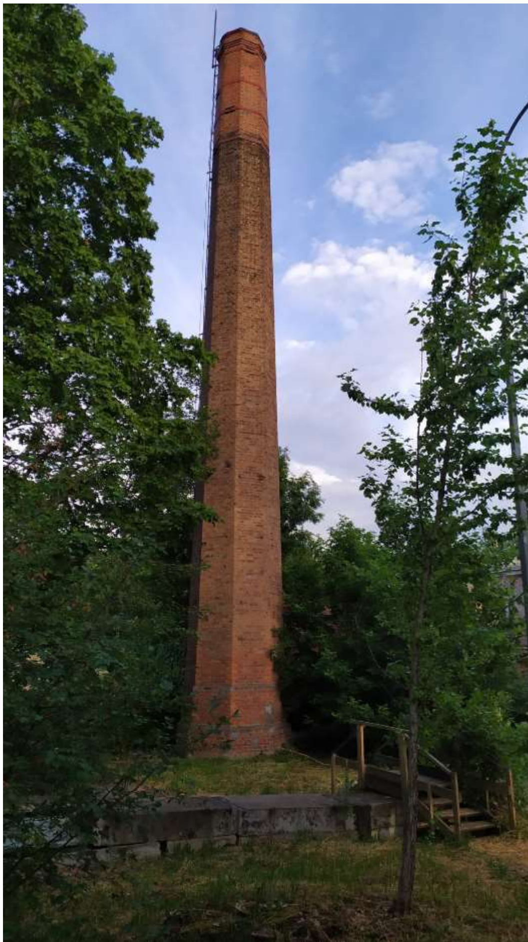
фото 59. Промышленная дымовая труба отремонтирована в 2017 году.
