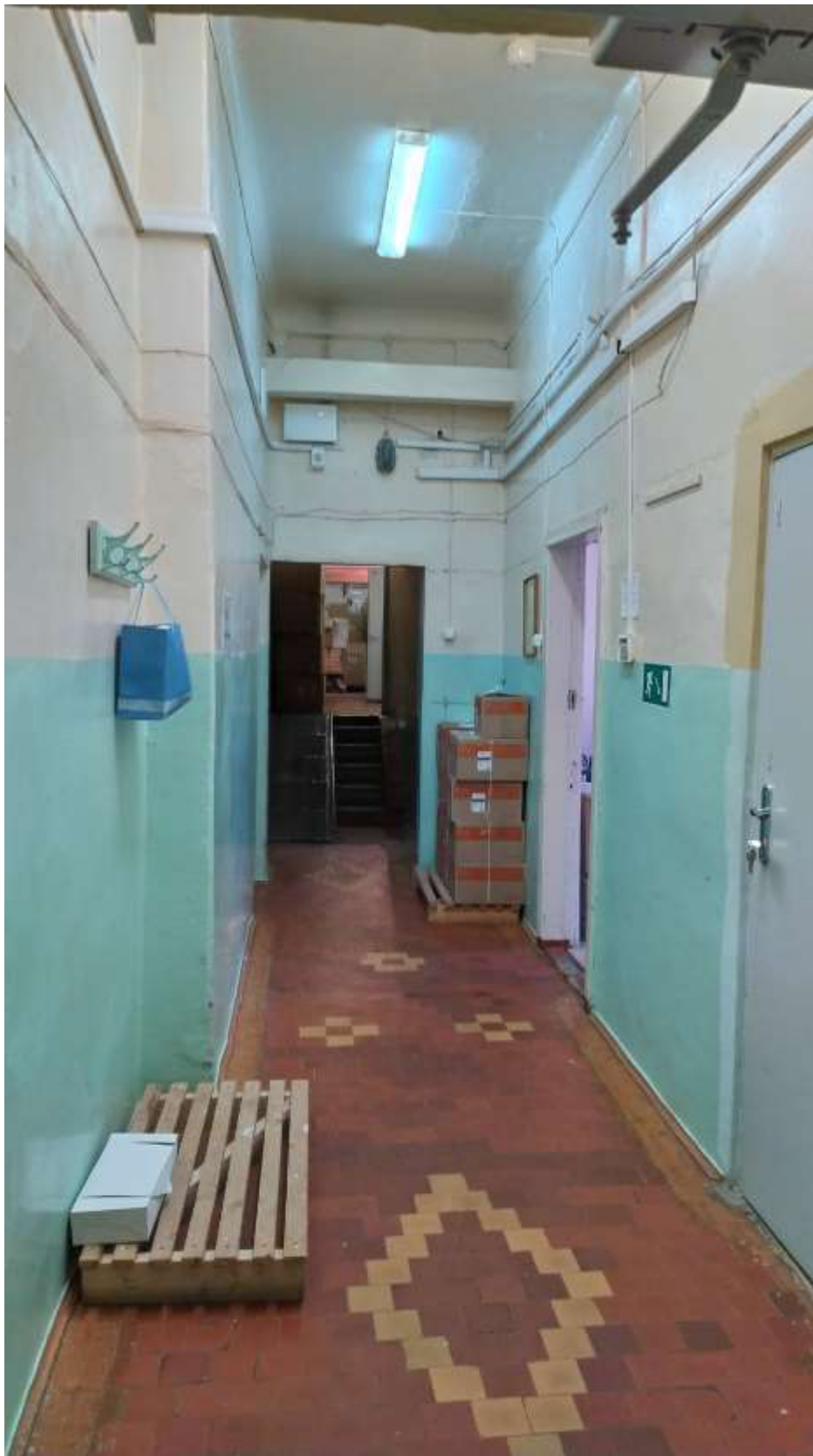
фото 15. Полы в помещениях прачечной. Блок 1.
