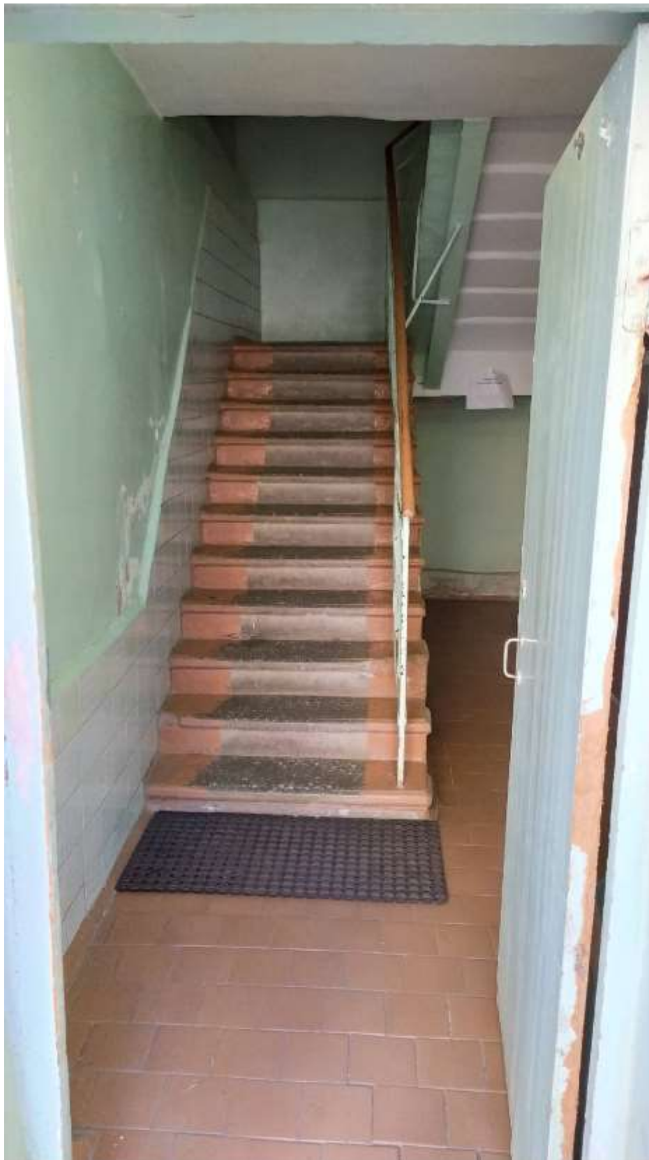
фото 13. Лестниц без повреждений. Блок 1.
