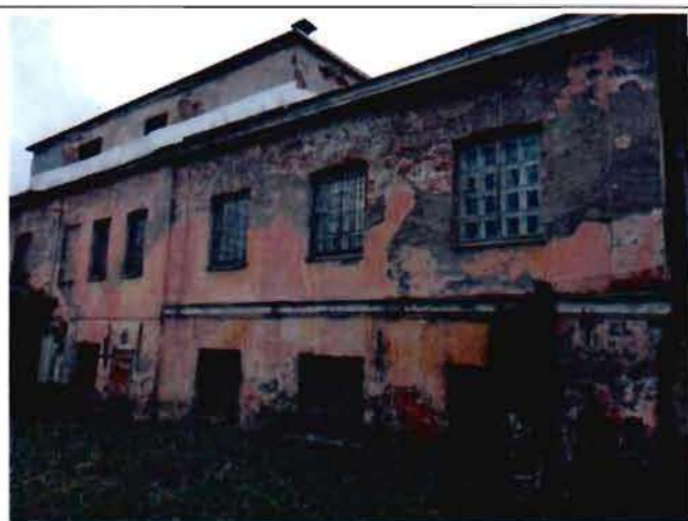
2. Фрагмент северного фасада
