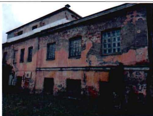
2. Фрагмент северного фасада
