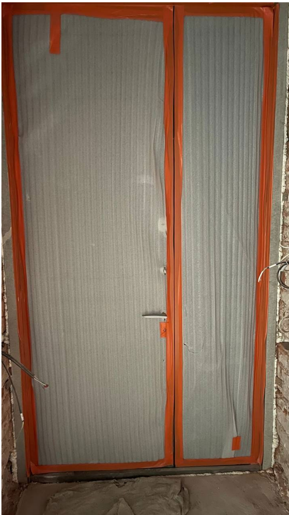
7. Вид на входную дверь в квартире №5;
