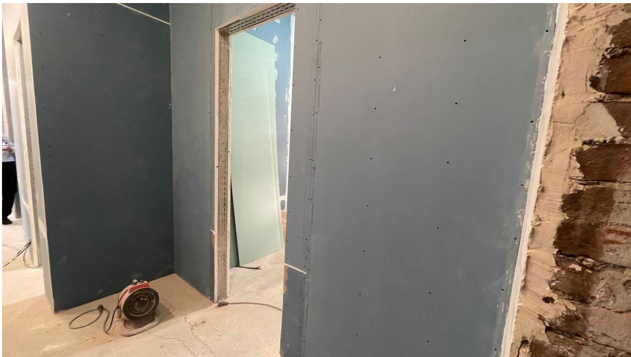
8. Вид на коридор и комнату (помещение №1 и №8);
