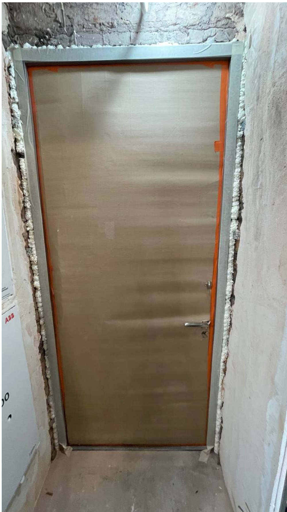
12. Вид на дверь в квартире, ведущую на чёрную лестницу;
