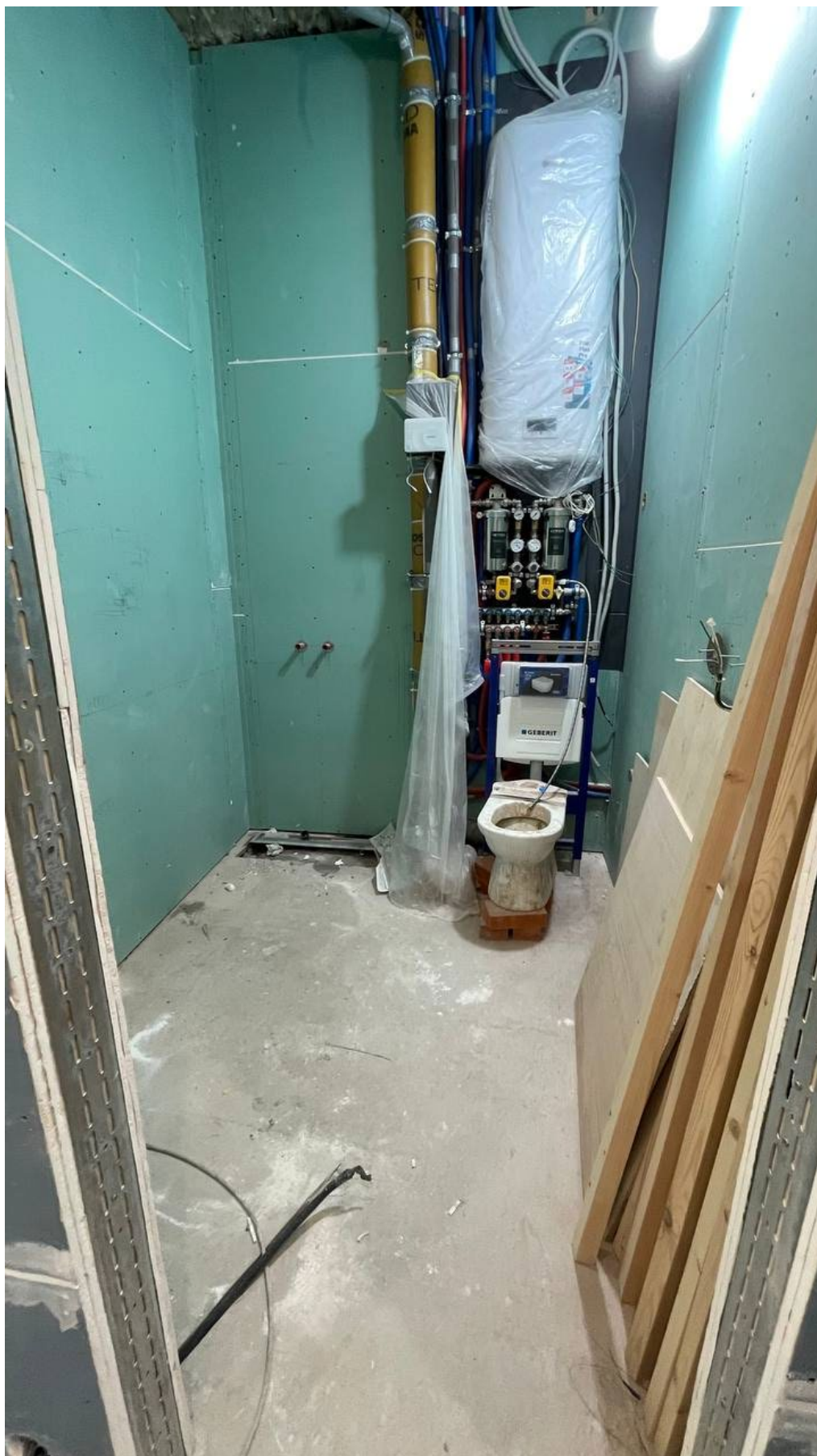
23. Фрагмент интерьера санузла (помещение №6);
