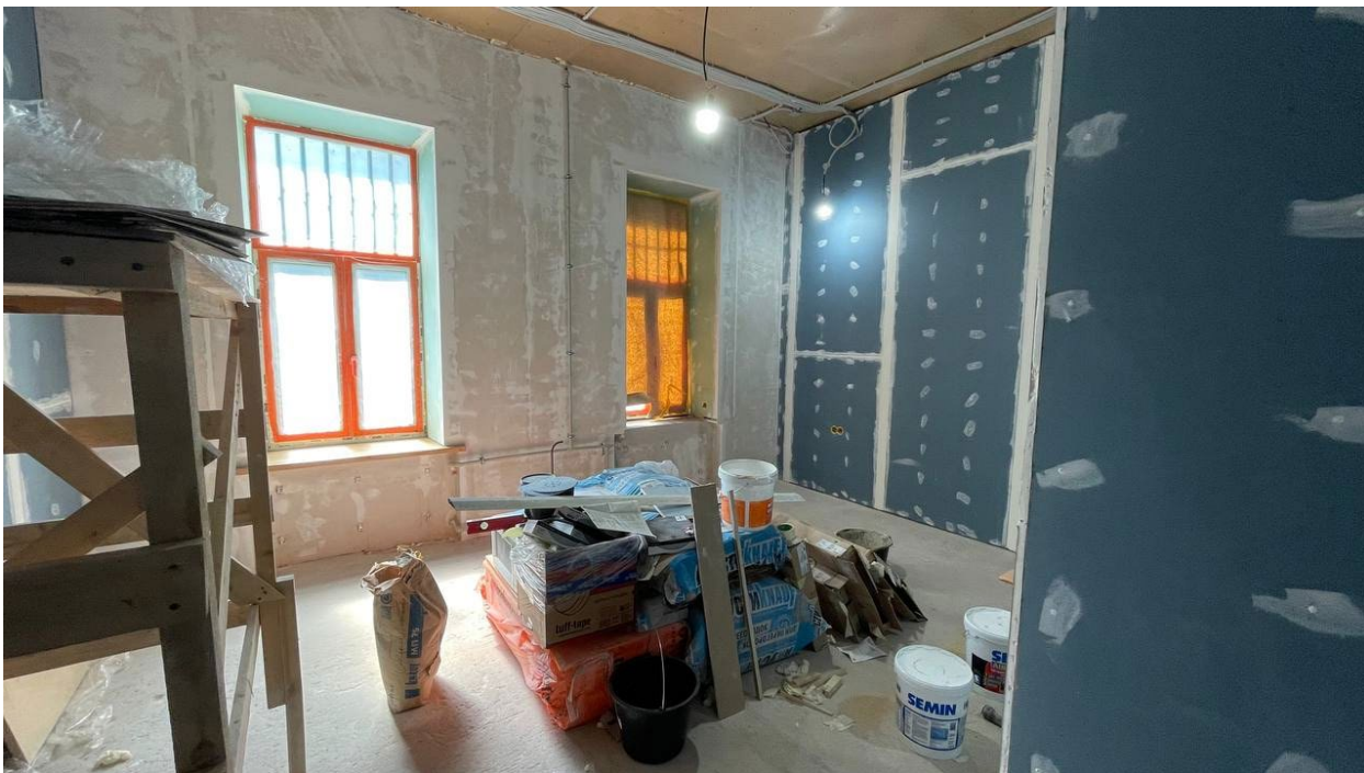
18. Фрагмент интерьера комнаты (помещение №3);
