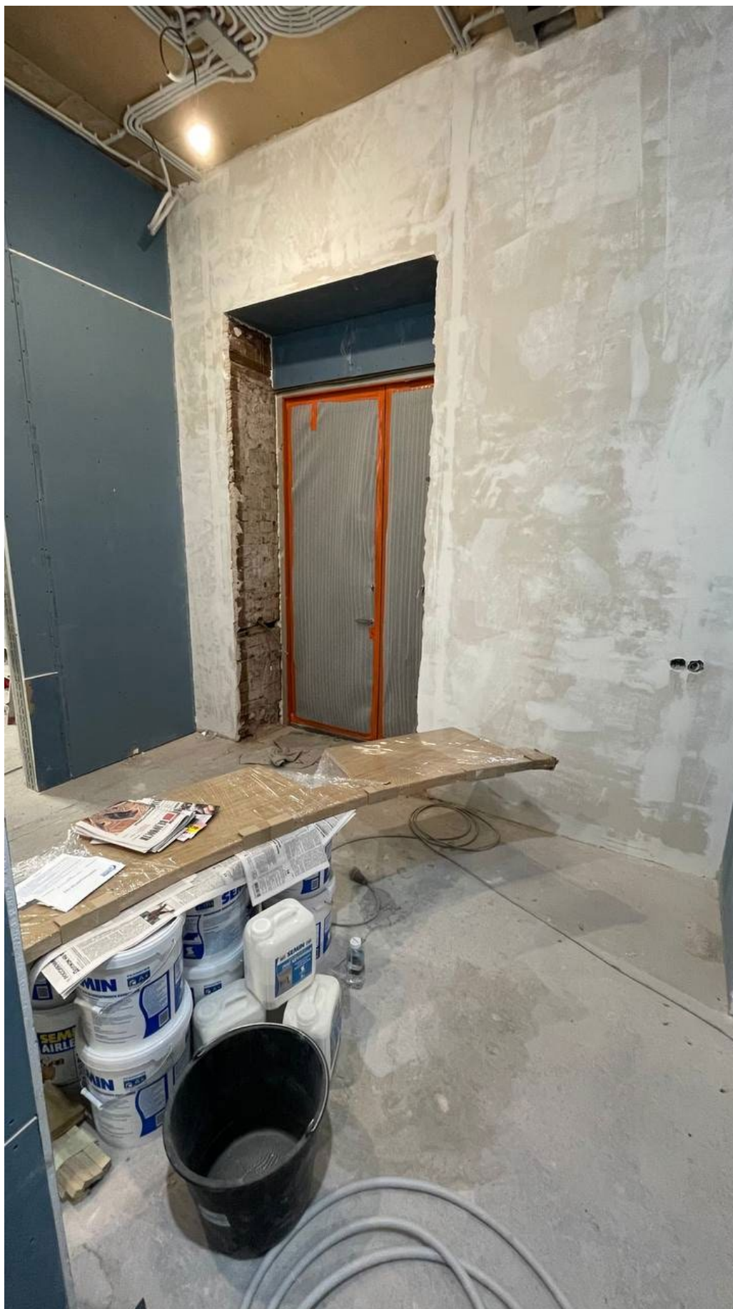
16. Вид на коридор (помещение №1);
