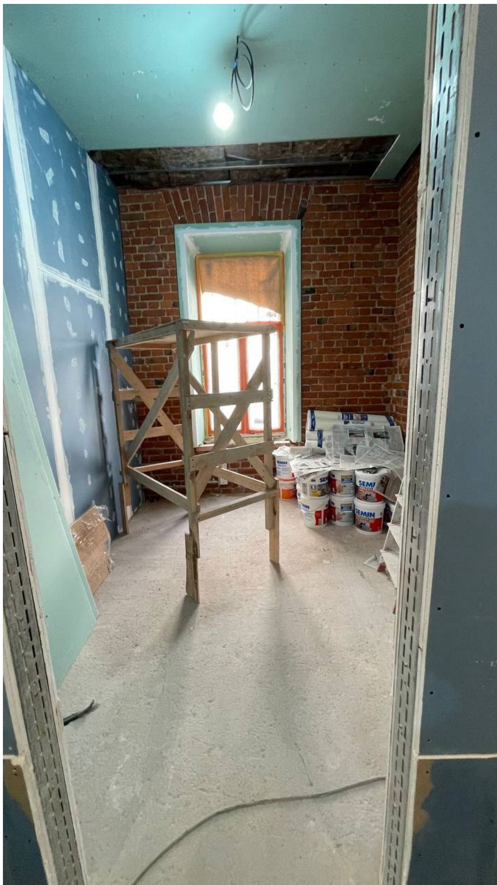
10. Фрагмент интерьера комнаты (помещение №8);
