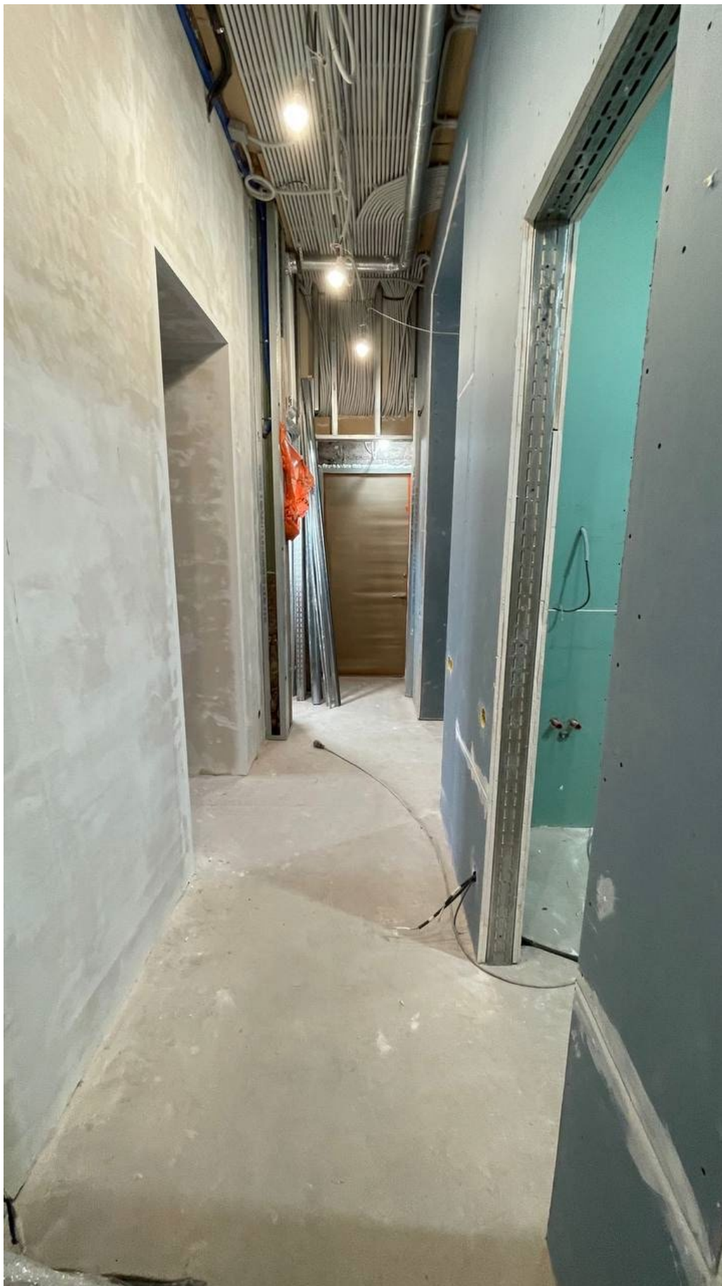
9. Фрагмент интеръера коридора (помещение №1);
