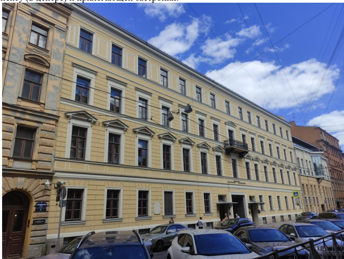
Фото 4. Объект культурного наследия регионального значения «Дом, в котором с 1869 г. жил и в 1887 г. умер актер Самойлов Василий Васильевич», расположенный по адресу: г. Санкт-Петербург, Невский проспект, дом 57, литера А. Общий вид лицевого фасада по Стремянной ул.
