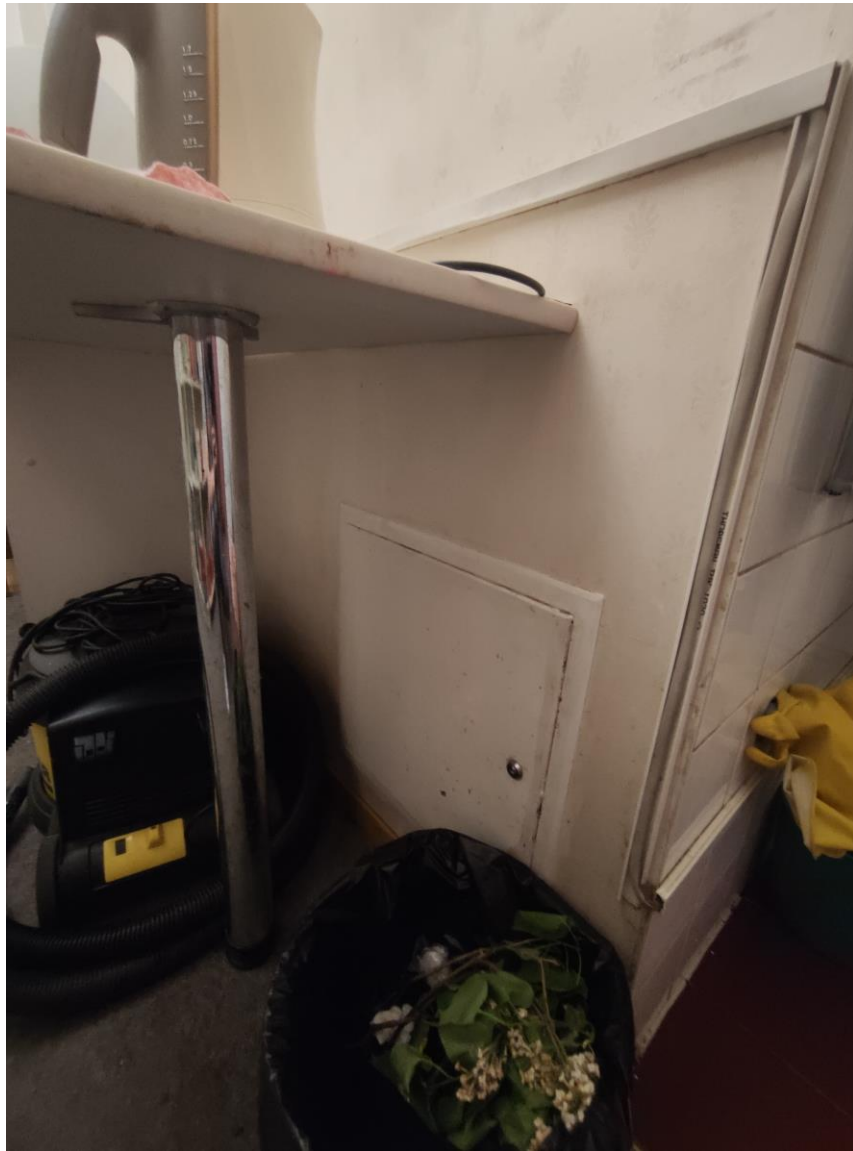
Фото 21. Объект культурного наследия регионального значения «Дом, в котором с 1869 г. жил и в 1887 г. умер актер Самойлов Василий Васильевич», расположенный по адресу: г. Санкт-Петербург, Невский проспект, дом 57, литера А. Фрагмент пом. № 1-Н(295). Технологическая шахта со смотровым лючком.
