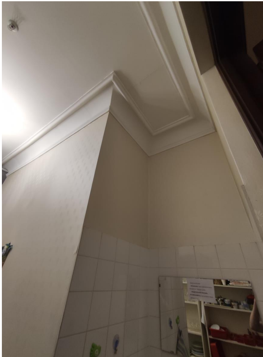
Фото 18. Объект культурного наследия регионального значения «Дом, в котором с 1869 г. жил и в 1887 г. умер актер Самойлов Василий Васильевич», расположенный по адресу: г. Санкт-Петербург, Невский проспект, дом 57, литера А. Фрагмент пом. № 1-Н(295). Технологическая шахта, подвесной потолок.
