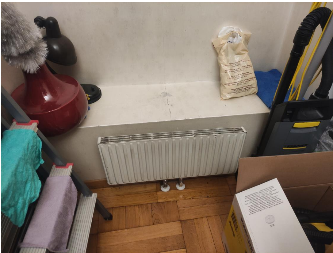
Фото 19. Объект культурного наследия регионального значения «Дом, в котором с 1869 г. жил и в 1887 г. умер актер Самойлов Василий Васильевич», расположенный по адресу: г. Санкт-Петербург, Невский проспект, дом 57, литера А. Фрагмент пом. № 1-Н(295). Ниша в торцевой стене, существующий радиатор отопления.
