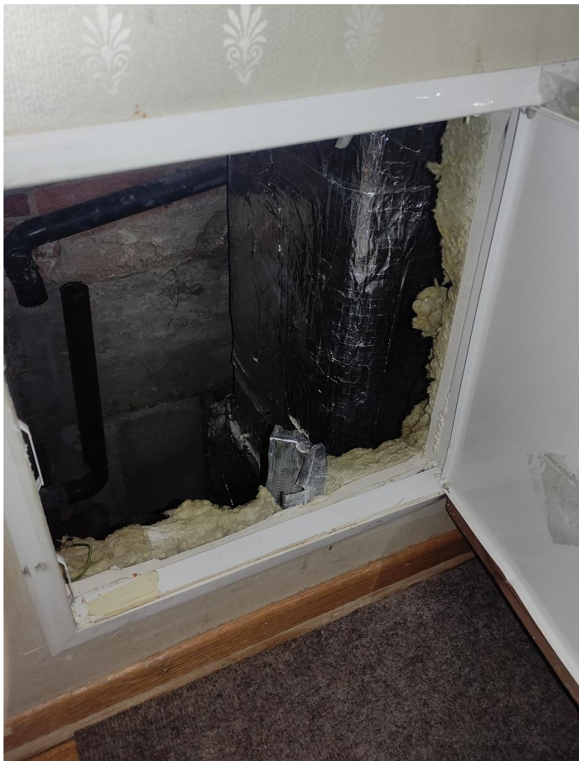
Фото 22. Объект культурного наследия регионального значения «Дом, в котором с 1869 г. жил и в 1887 г. умер актер Самойлов Василий Васильевич», расположенный по адресу: г. Санкт-Петербург, Невский проспект, дом 57, литера А. Фрагмент пом. № 1-Н(295). Технологическая шахта, существующие сети.
