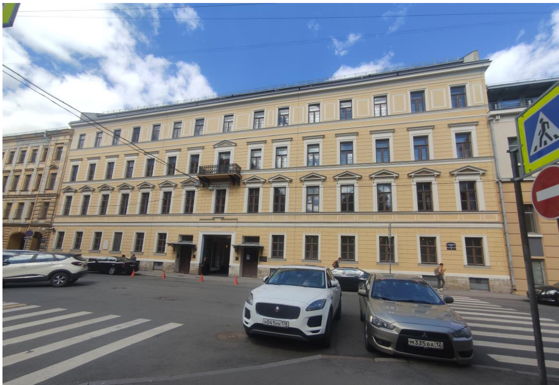
Фото 5. Объект культурного наследия регионального значения «Дом, в котором с 1869 г. жил и в 1887 г. умер актер Самойлов Василий Васильевич», расположенный по адресу: г. Санкт-Петербург, Невский проспект, дом 57, литера А. Общий вид лицевого фасада по Стремянной ул.
