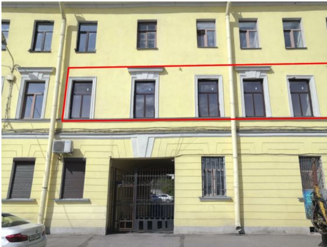
Фото 4. Фрагмент лицевого фасада дома №28 по Синопской наб. (обозначены окна кв. №16)
