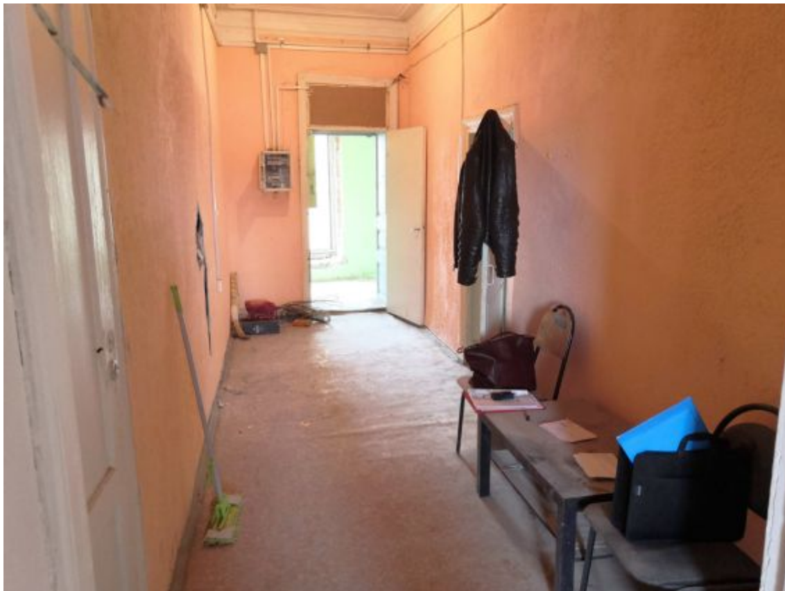
Фото 31. Холл 8. Общий вид помещения в сторону лестничного вестибюля
