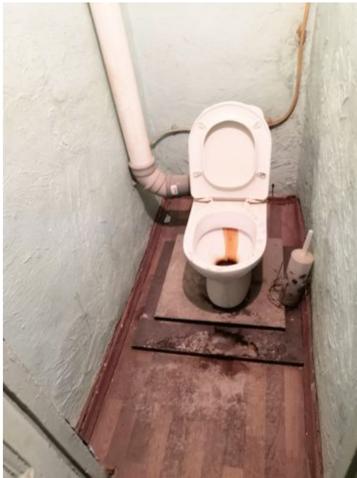
Фото 38. Санузел 13. Общий вид помещения.
