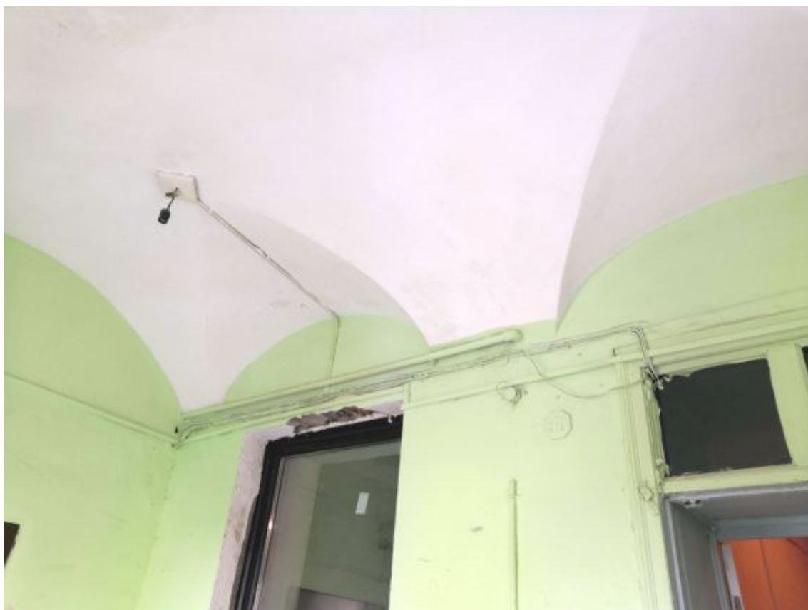
Фото 8. Лестничный холл 2-го этажа. Своды
