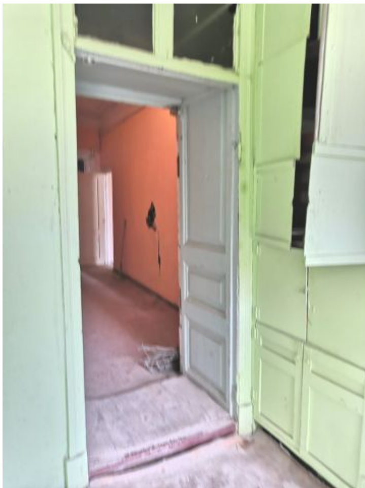
Фото 9. Вход в квартиру №16 из лестничного холла 2-го этажа.
