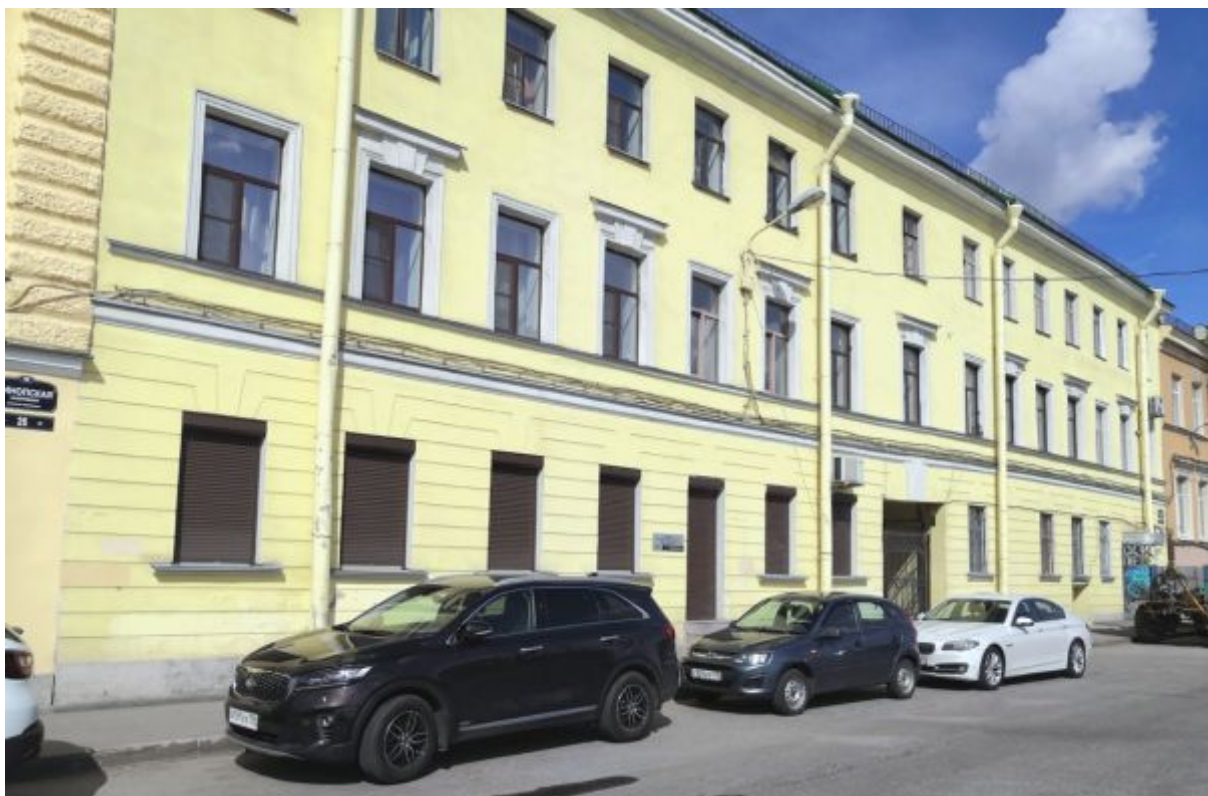
Фото 1. Общий вид лицевого фасада дома №28 по Синопской наб.
