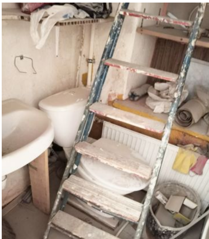
Фото 37. Санузел 12 . Общий вид помещения.
