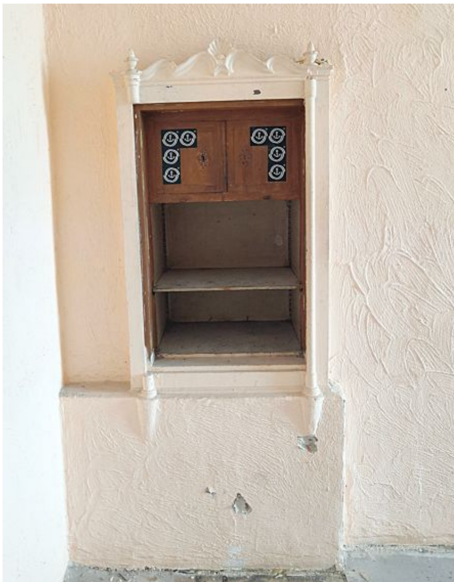
Фото 13. Комната 1 . Стенной шкаф.
