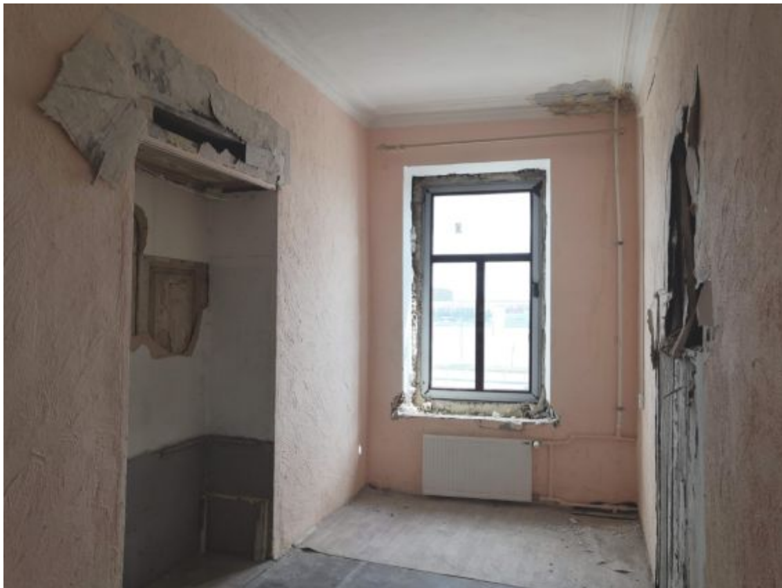
Фото 11. Комната 1 . Общий вид в сторону окна.
