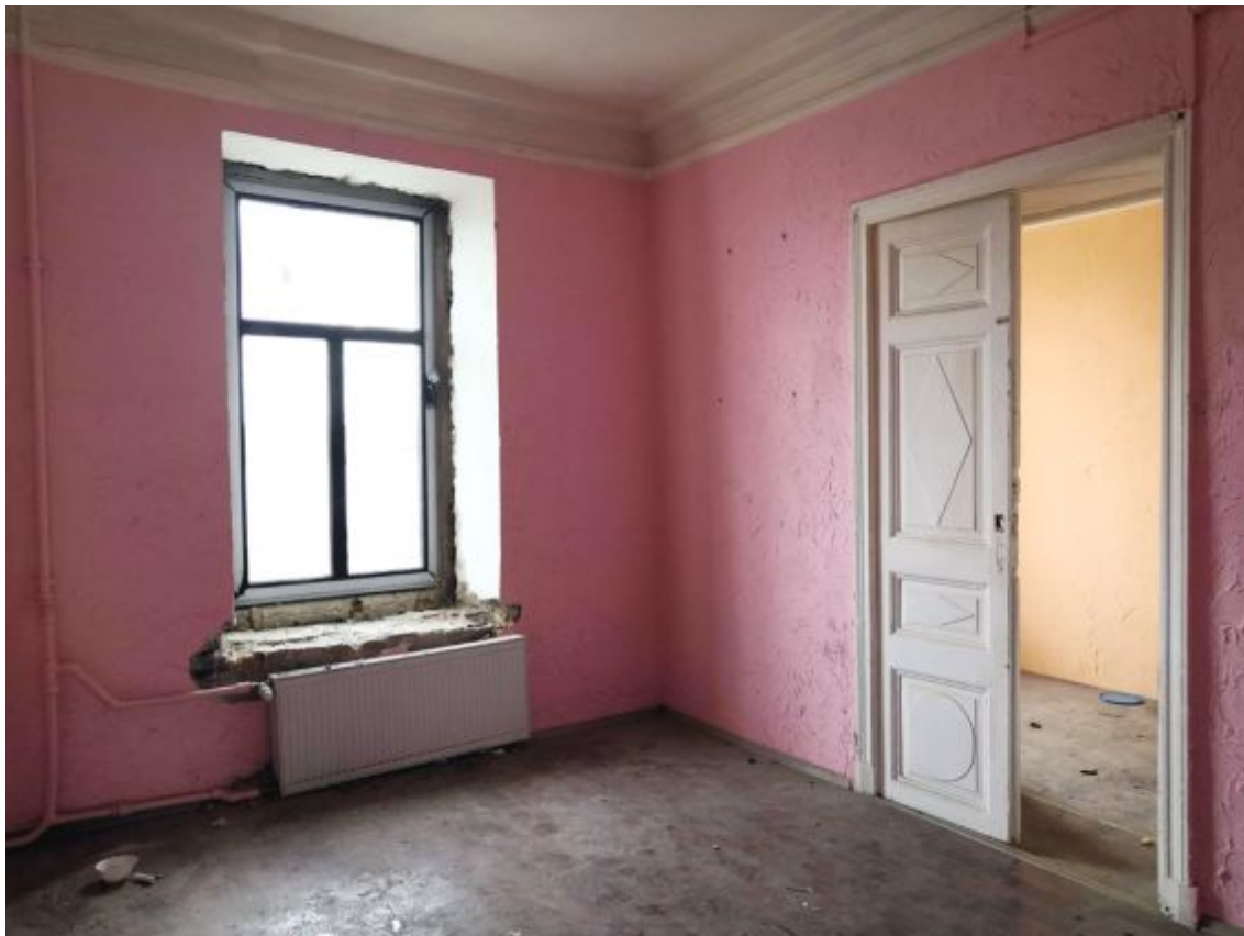
Фото 21. Комната 5 . Общий вид в сторону окна.
