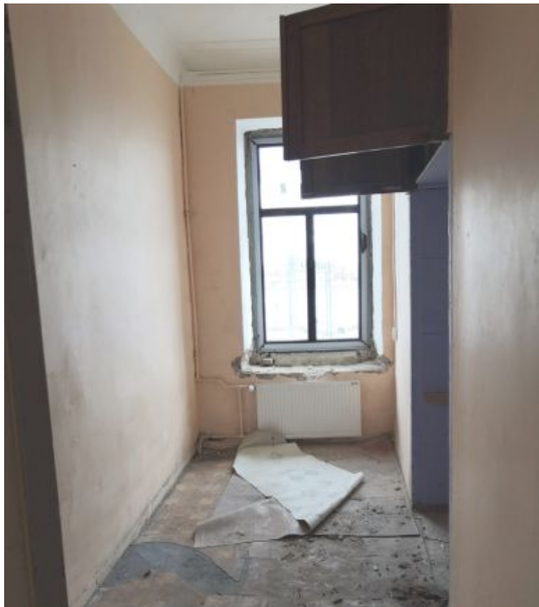
Фото 19. Комната 4 . Вид в сторону окна
