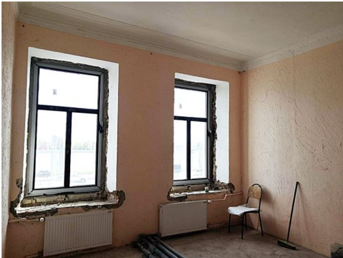
Фото 14. Комната 2 . Общий вид в сторону окна.
