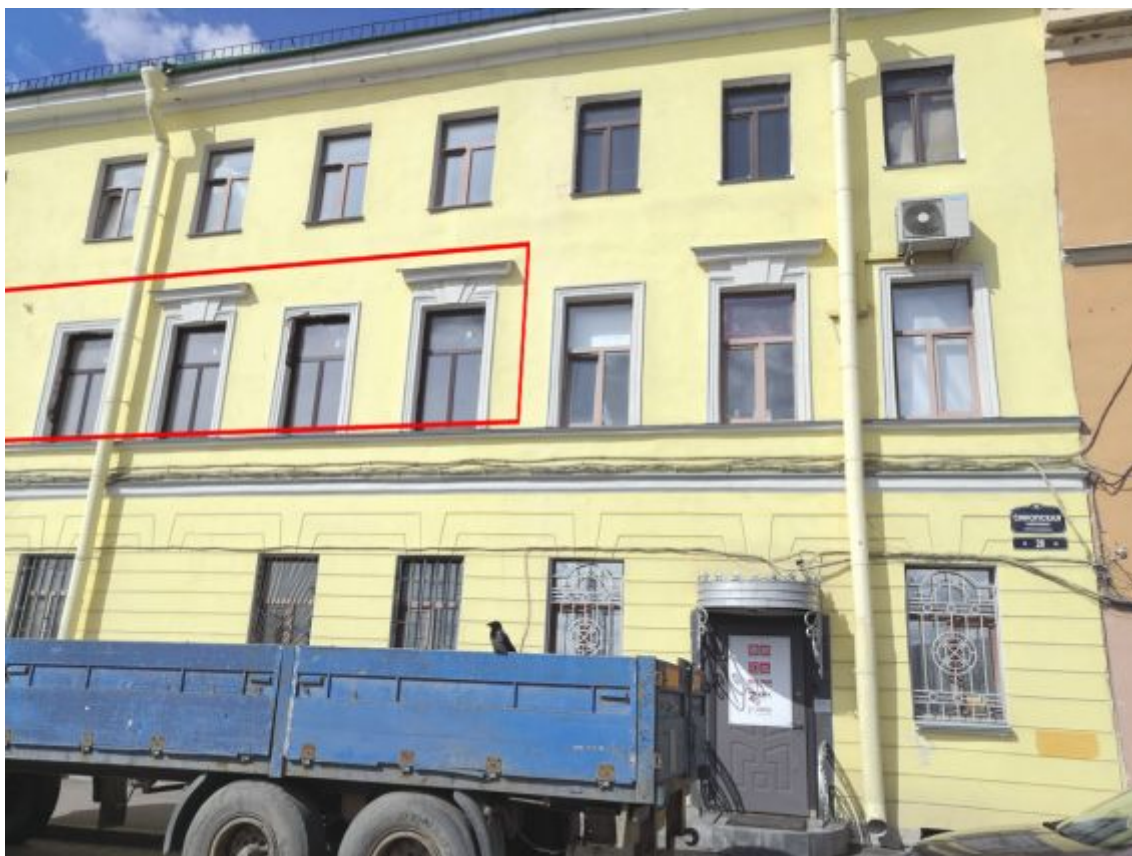
Фото 3. Фрагмент лицевого фасада дома №28 по Синопской наб. (обозначены окна кв. №16)
