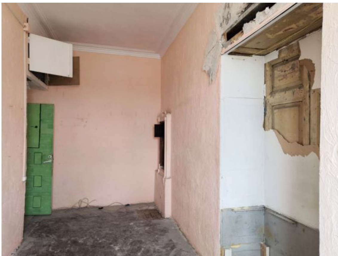
Фото 12. Комната 1 . Общий вид от окна.
