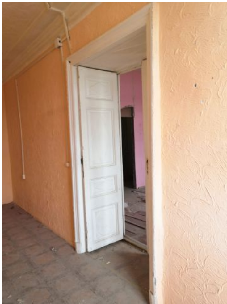
Фото 35. Комната 10 . Общий вид помещения в сторону комнаты 5.
