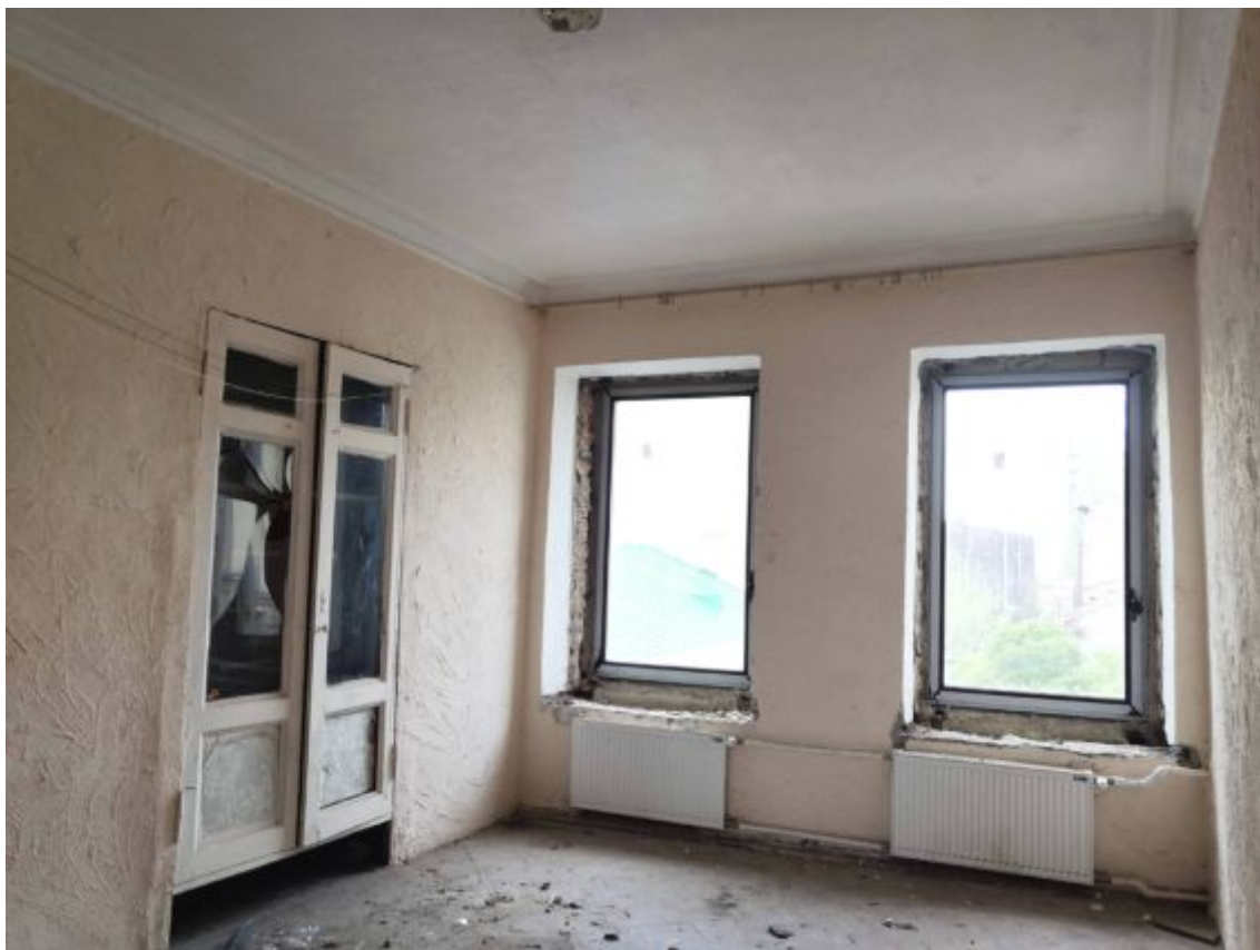
Фото 24. Комната 6 . Вид в сторону окна.
