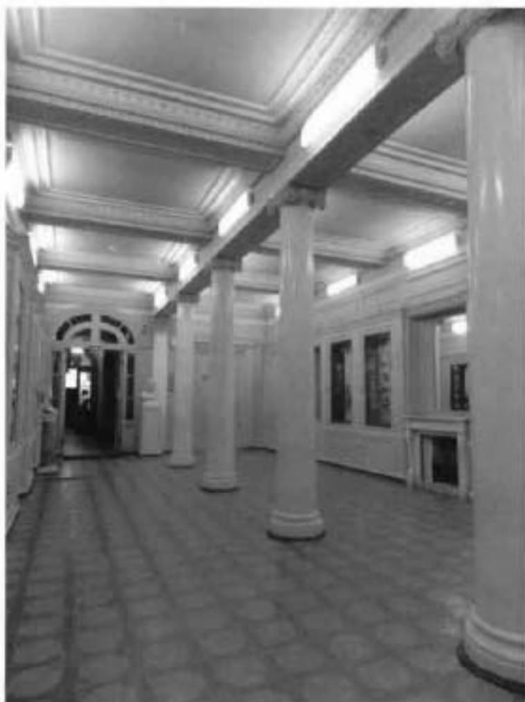
6. Помещение 1 этажа (10-Н (1)).
