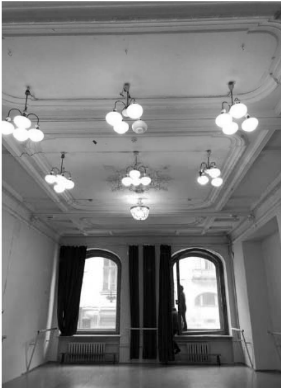
26. «Особняк Безобразовой». Санкт-Петербург, Моховая ул., 34, литера А (Моховая ул., 34). Лицевой корпус. 1-й этаж. Фрагмент помещения 10-Н(2). Фото: 26.10.2021.
