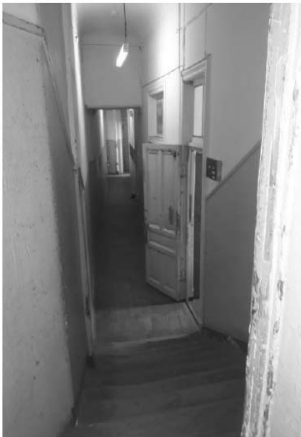
152. «Особняк Безобразовой». Санкт-Петербург, Моховая ул., 34, литера А (Моховая ул., 34). Дворовый корпус. 3-й этаж. Фрагмент помещения 21-Н(21). Фото: 26.10.2021.
