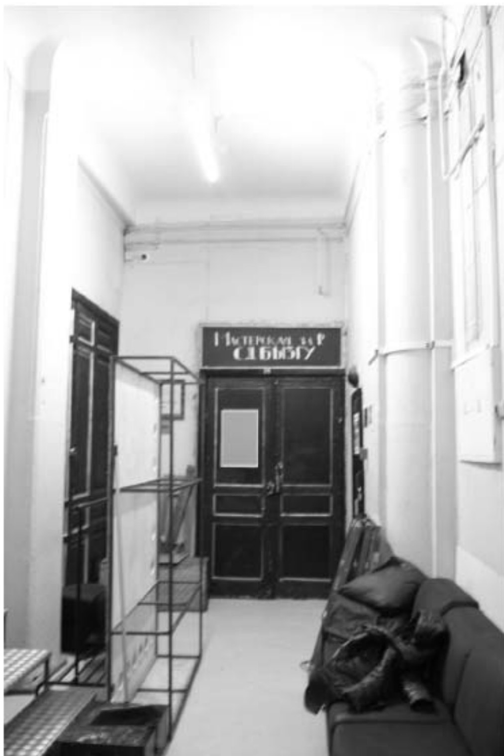
127. «Особняк Безобразовой». Санкт-Петербург, Моховая ул., 34, литера А (Моховая ул., 34). Лицевой корпус. 3-й этаж. Фрагмент помещения 21-Н(3). Фото: 26.10.2021.
