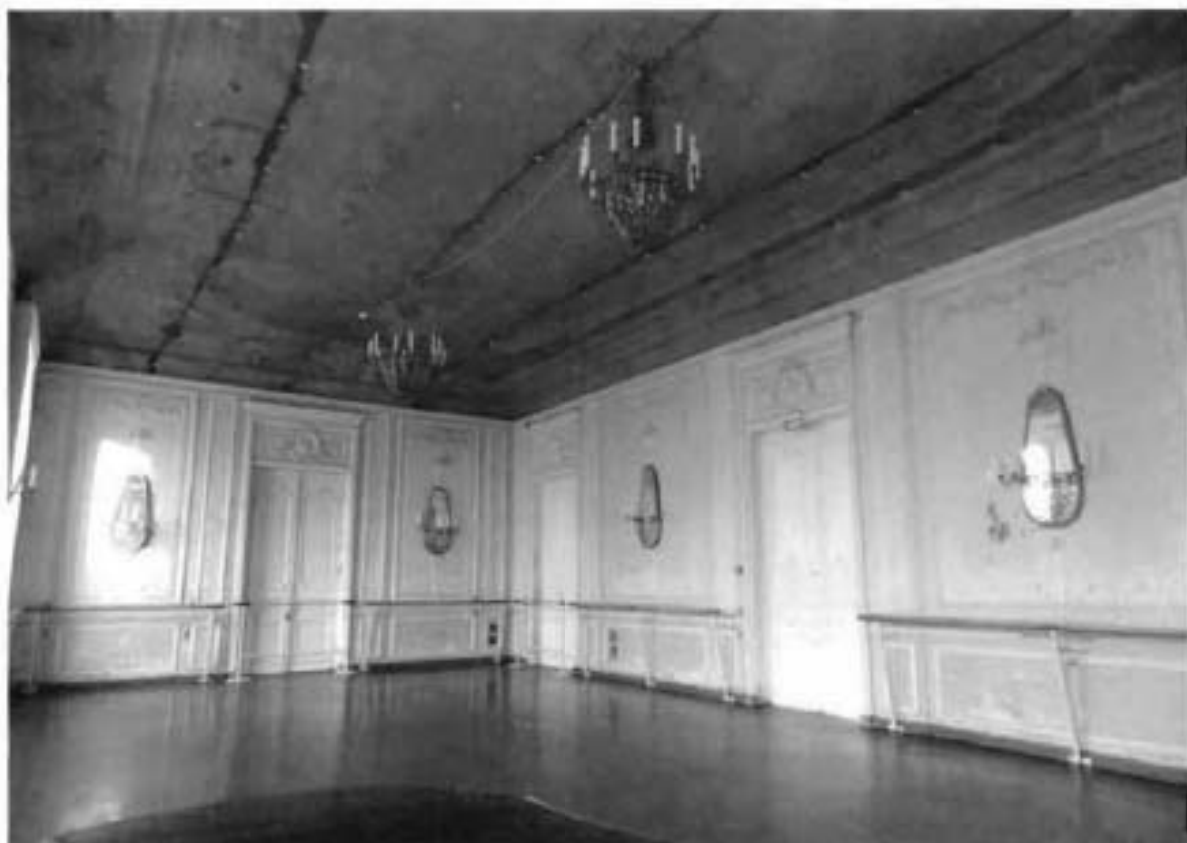
12. Помещение 2 этажа (18-Н(2)).
