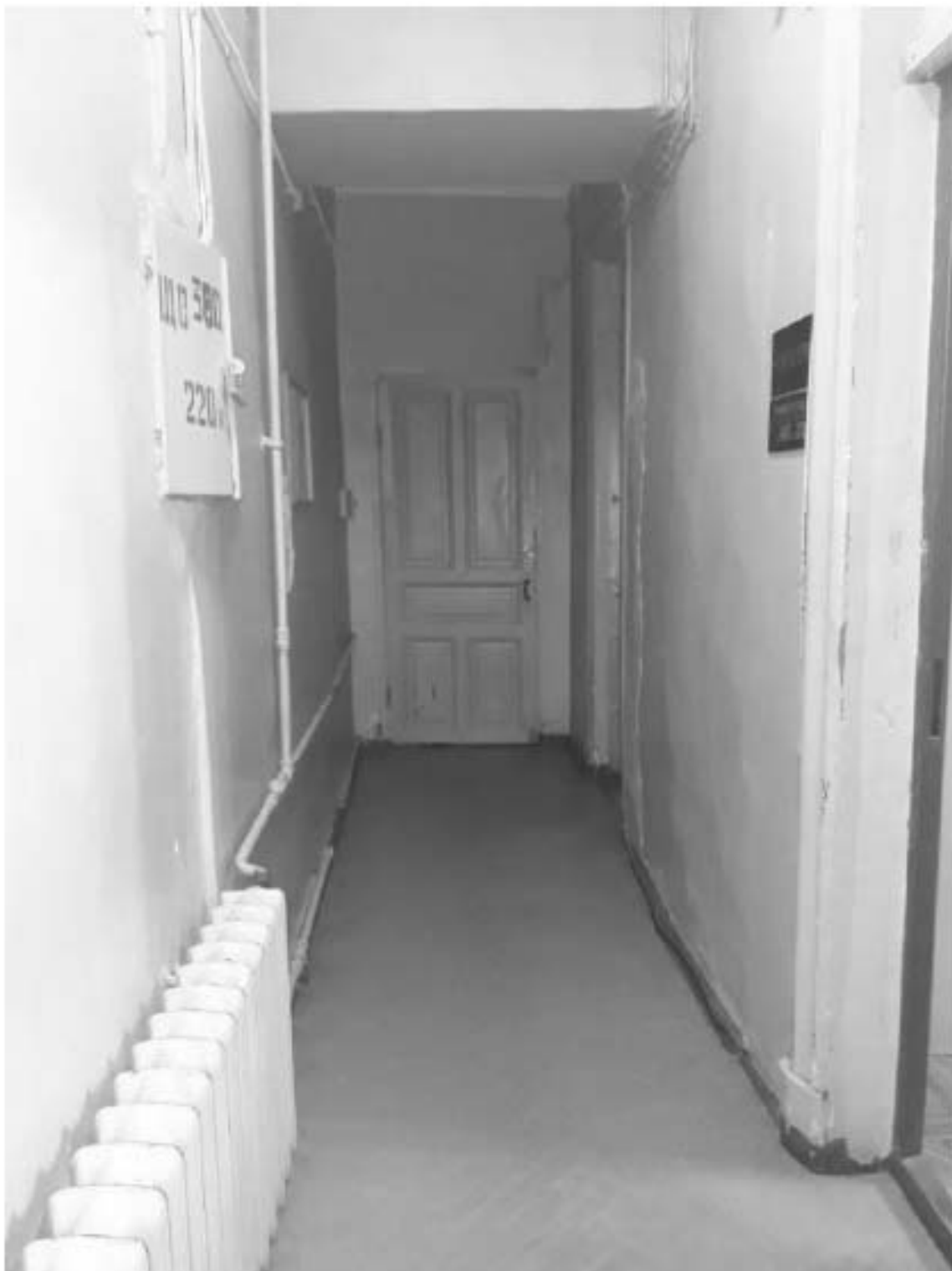
101. «Особняк Безобразовой». Санкт-Петербург, Моховая ул., 34, литера А (Моховая ул., 34). Дворовый корпус. 3-й этаж. Фрагмент помещения 20-Н(1). Фото: 26.10.2021.
