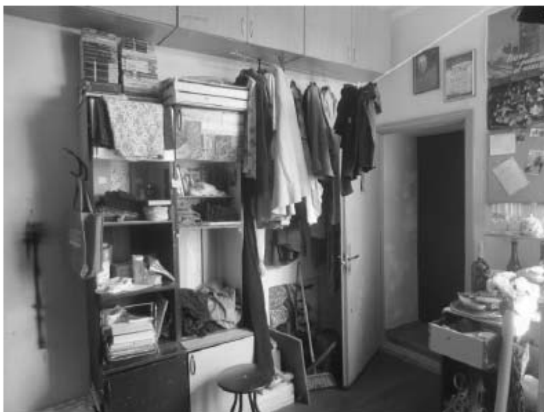
173. «Особняк Безобразовой». Санкт-Петербург, Молоховая ул., 34, литера А (Молоховая ул., 34). Дворовый корпус. 5-й этаж. Фрагмент помещения 27-Н(4). Фото: 26.10.2021.
