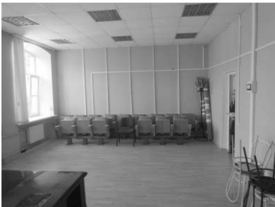
169. «Особняк Безобразовой». Санкт-Петербург, Моховая ул., 34, литера А (Моховая ул., 34). Дворовый корпус. 5-й этаж. Фрагмент помещения 26-Н(11). Фото: 26.10.2021.
