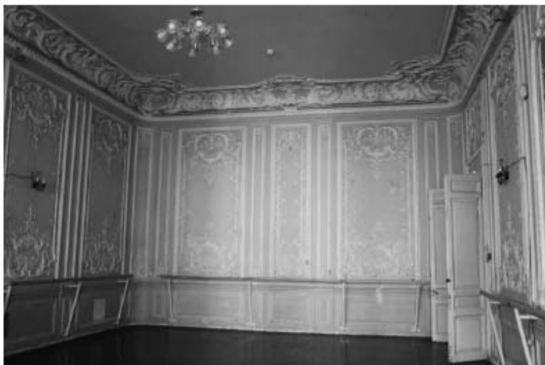
64. «Особняк Безобразовой». Санкт-Петербург, Моховая ул., 34, литера А (Моховая ул., 34). Лицевой корпус. 2-й этаж. Фрагмент помещения 18-Н(1). Фото: 26.10.2021.
