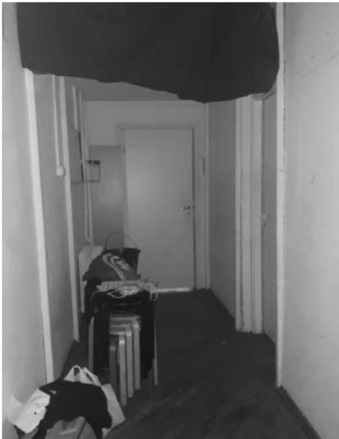
156. «Особняк Безобразовой». Санкт-Петербург, Моховая ул., 34, литера А (Моховая ул., 34). Дворовый корпус. 4-й этаж. Фрагмент помещения 22-Н(2). Фото: 26.10.2021.
