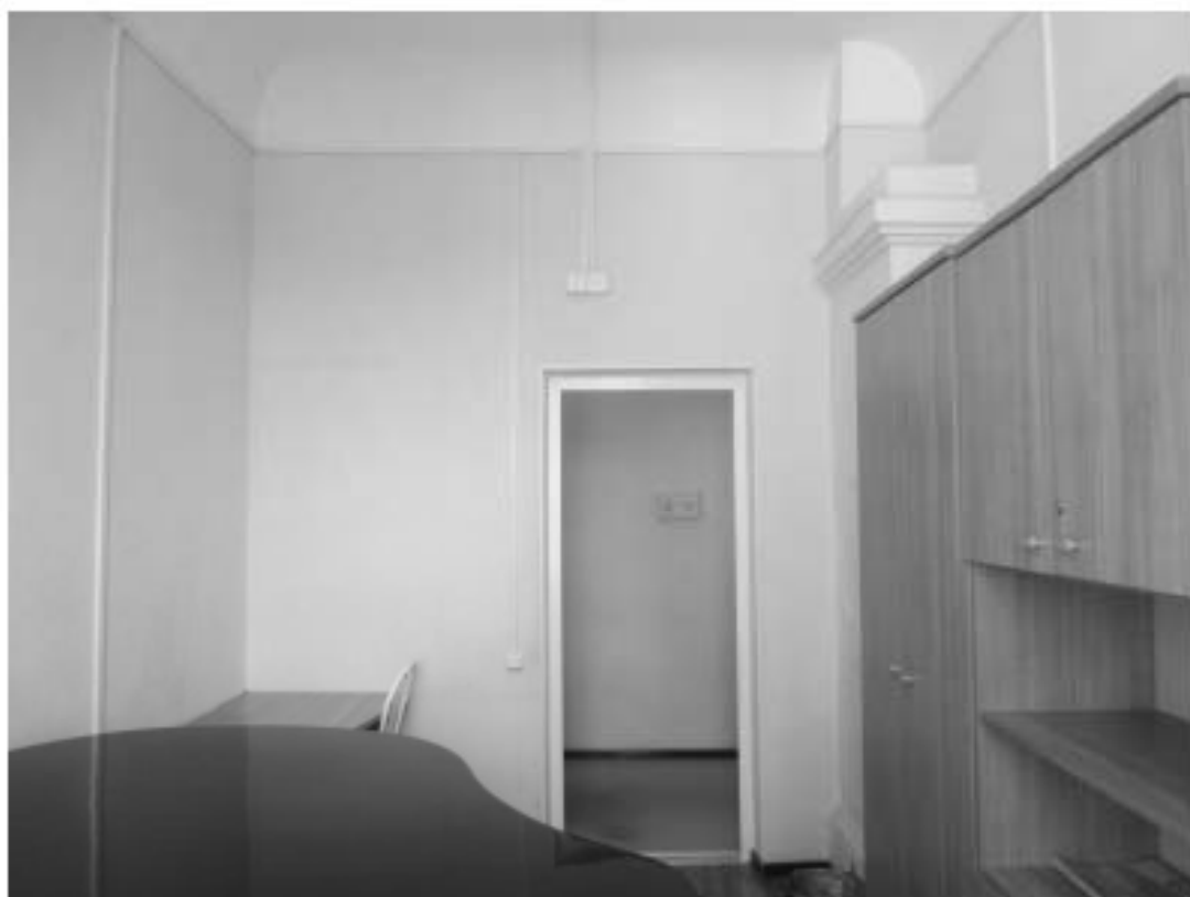
134. «Особняк Безобразовой». Санкт-Петербург, Моховая ул., 34, литера А (Моховая ул., 34). Дворовый корпус. 5-й этаж. Фрагмент помещения 24-Н(4). Фото: 26.10.2021.
