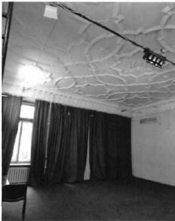
8. Помещение 1 этажа (10-Н(20)).
