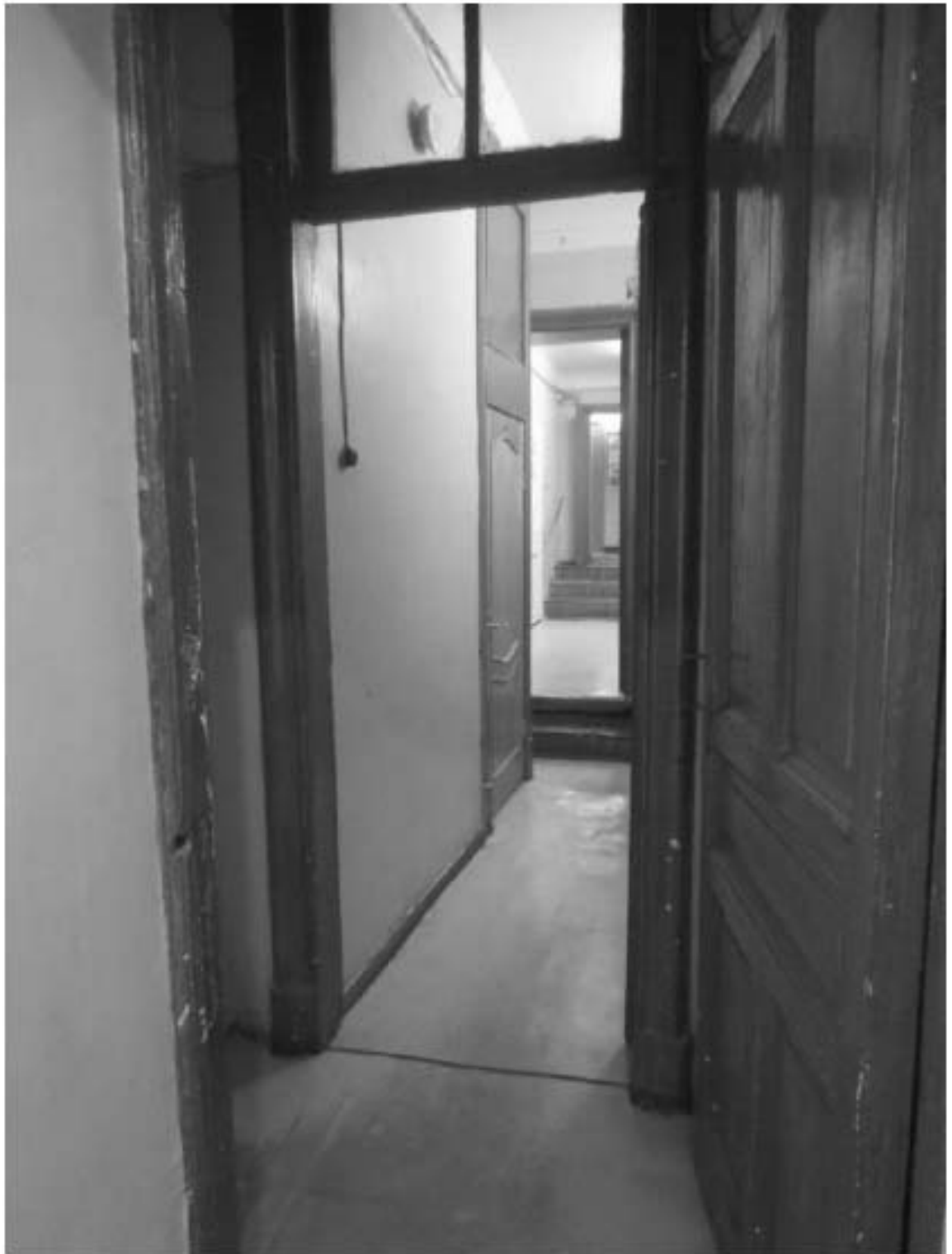
46. «Особняк Безобразовой». Санкт-Петербург, Моховая ул., 34, литера А (Моховая ул., 34). Лицевой корпус. 1-й этаж. Фрагмент помещения 15-Н(3). Фото: 26.10.2021.
