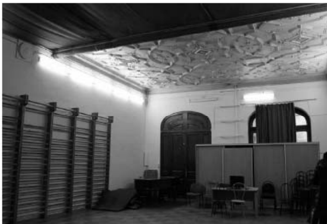
91. «Особняк Безобразовой». Санкт-Петербург, Моховая ул., 34, литера А (Моховая ул., 34). Дворовый корпус. 2-й этаж. Фрагмент помещения 19-Н(14). Фото: 26.10.2021.
