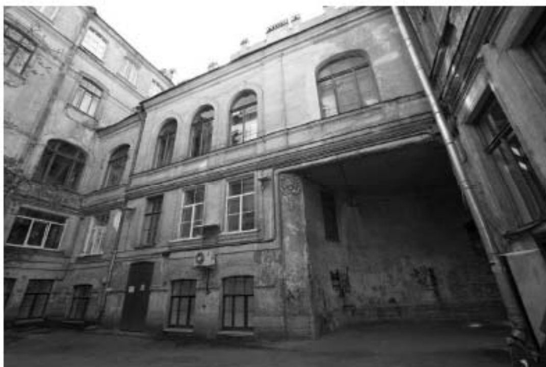
16. «Особняк Безобразовой». Санкт-Петербург, Моховая ул., 34, литера А (Моховая ул., 34). Центральный внутренний двор. Вид с севера на юг. Фото: 26.10.2021.
