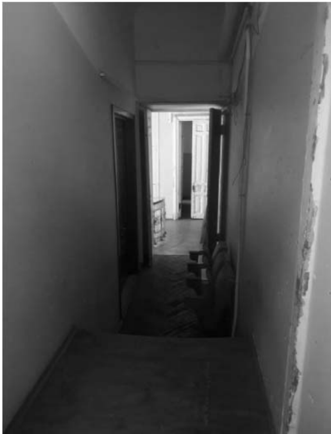
151. «Особняк Безобразовой». Санкт-Петербург, Моховая ул., 34, литера А (Моховая ул., 34). Дворовый корпус. 3-й этаж. Фрагмент помещения 21-Н(25,27). Фото: 26.10.2021.
