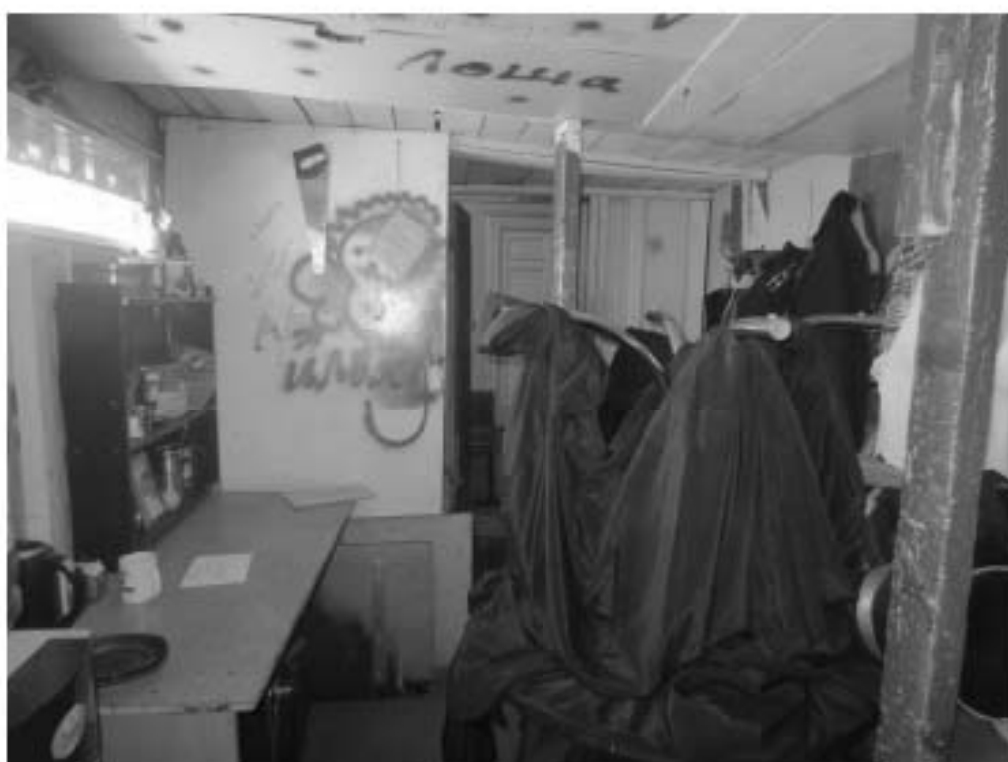
126. «Особняк Безобразовой». Санкт-Петербург, Моховая ул., 34, литера А (Моховая ул., 34). Лицевой корпус. 3-й этаж. Фрагмент помещения 21-Н(5). Фото: 26.10.2021.
