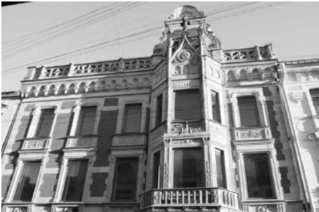
3. «Особняк Безобразовой». Санкт-Петербург, Моховая ул., 34, литера А (Моховая ул., 34). Лицевой фасад. Верхняя часть. Фото: 26.10.2021.
