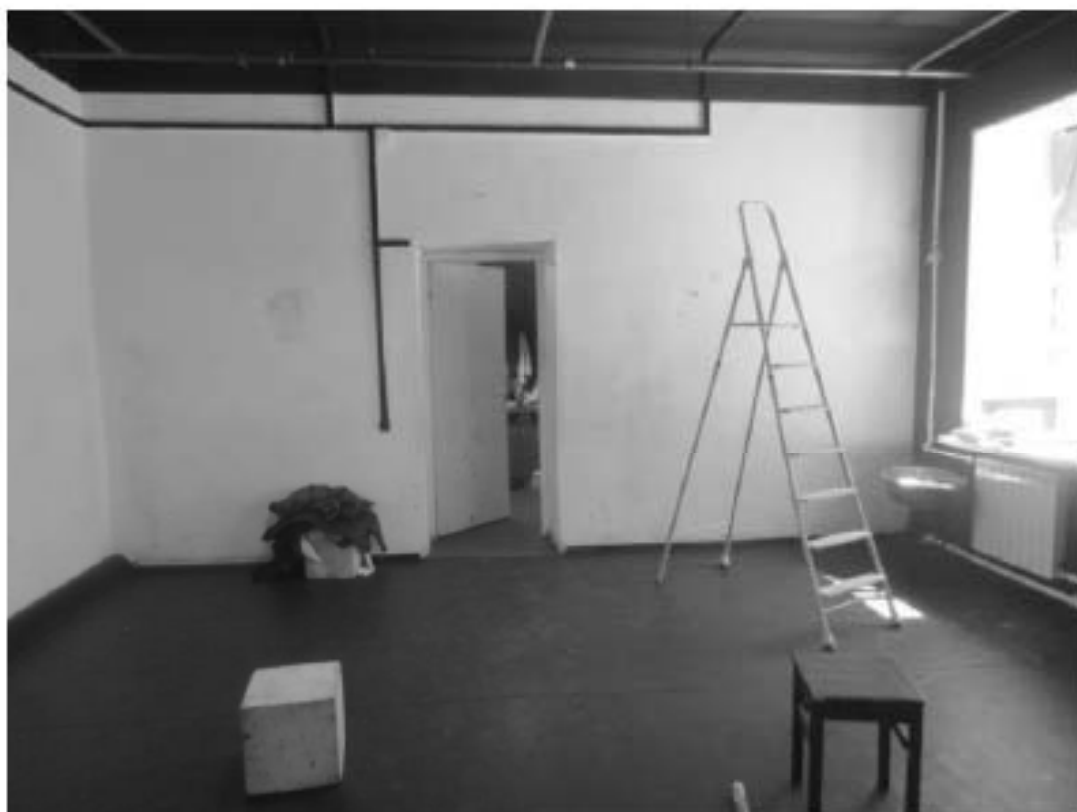
44. «Особняк Безобразовой». Санкт-Петербург, Моховая ул., 34, литера А (Моховая ул., 34). Лицевой корпус. 1-й этаж. Фрагмент помещения 12-Н(2). Фото: 26.10.2021.
