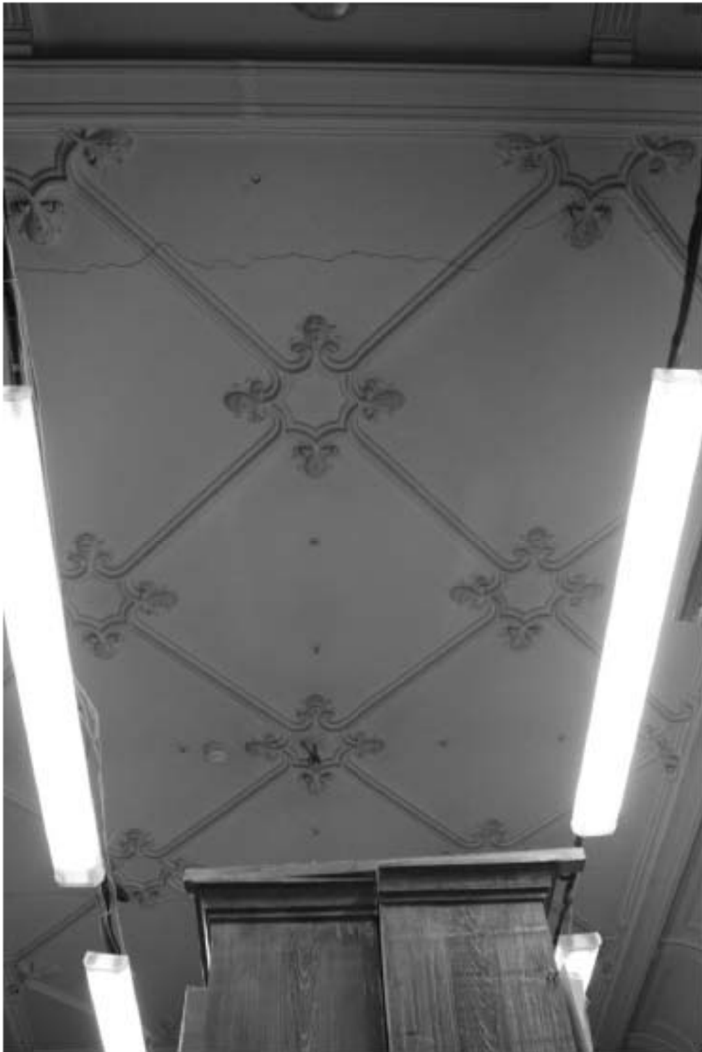
82. «Особняк Безобразовой». Санкт-Петербург, Моховая ул., 34, литера А (Моховая ул., 34). Лицевой корпус. 2-й этаж. Фрагмент помещения 19-Н(4). Фото: 26.10.2021.
