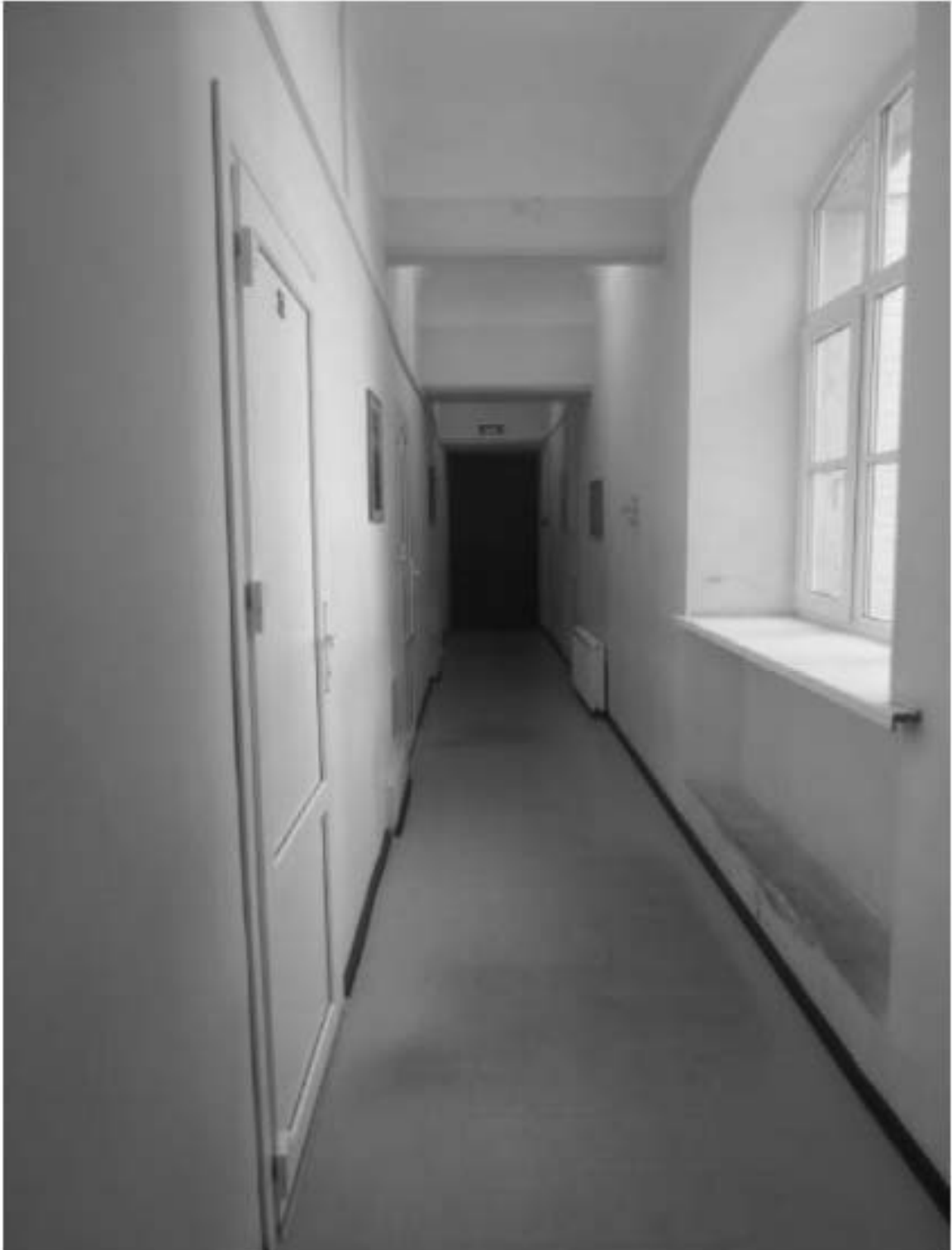
139. «Особняк Безобразовой». Санкт-Петербург, Моховая ул., 34, литера А (Моховая ул., 34). Дворовый корпус. 5-й этаж. Фрагмент помещения 24-Н(1). Фото: 26.10.2021.
