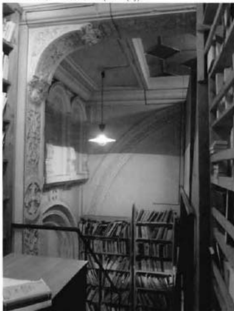
13. Помещение 2 этажа (19-Н(2)).
