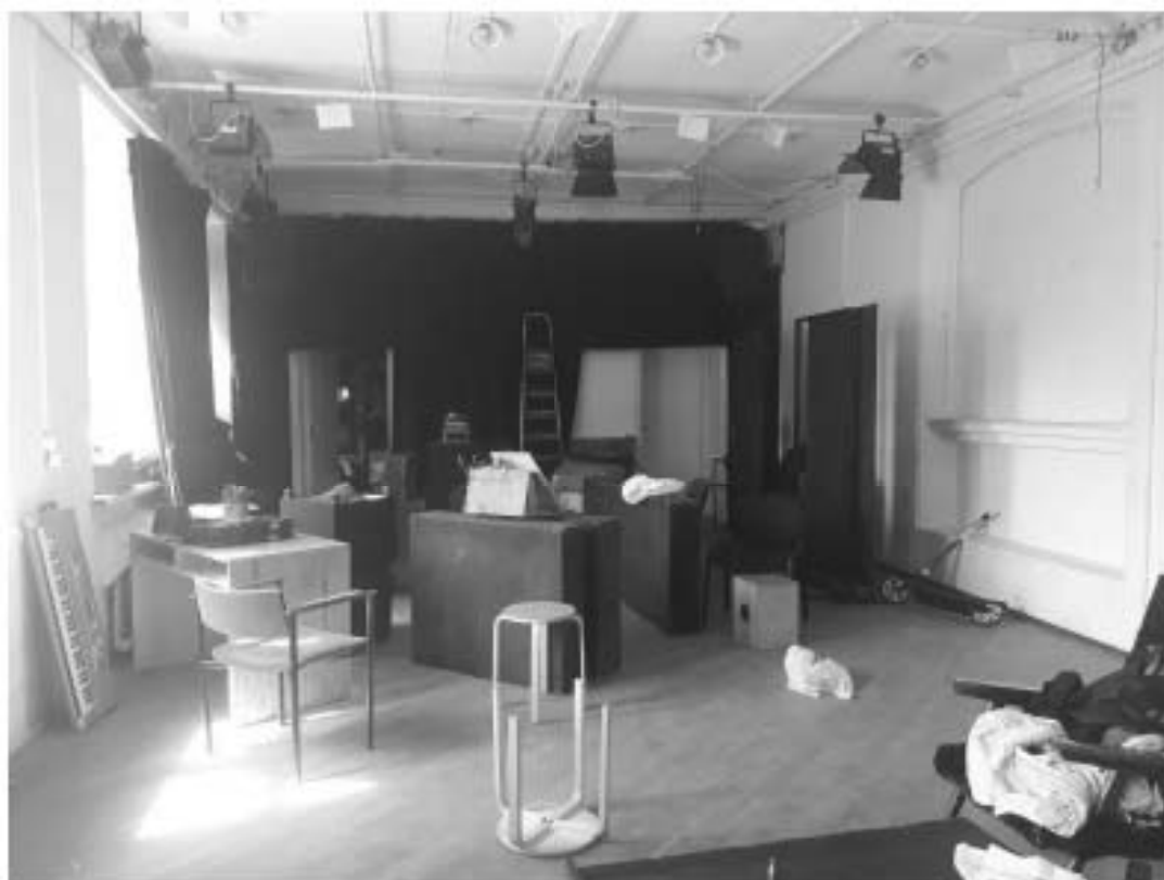
158. «Особняк Безобразовой». Санкт-Петербург, Моховая ул., 34, литера А (Моховая ул., 34). Дворовый корпус. 3-й этаж. Фрагмент помещения 22-Н(1). Фото: 26.10.2021.
