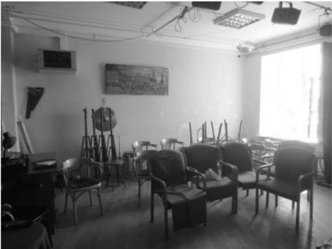
175. «Особняк Безобразовой». Санкт-Петербург, Молоховая ул., 34, литера А (Молоховая ул., 34). Дворовый корпус. 6-й этаж. Фрагмент помещения 27-Н(1). Фото: 26.10.2021.
