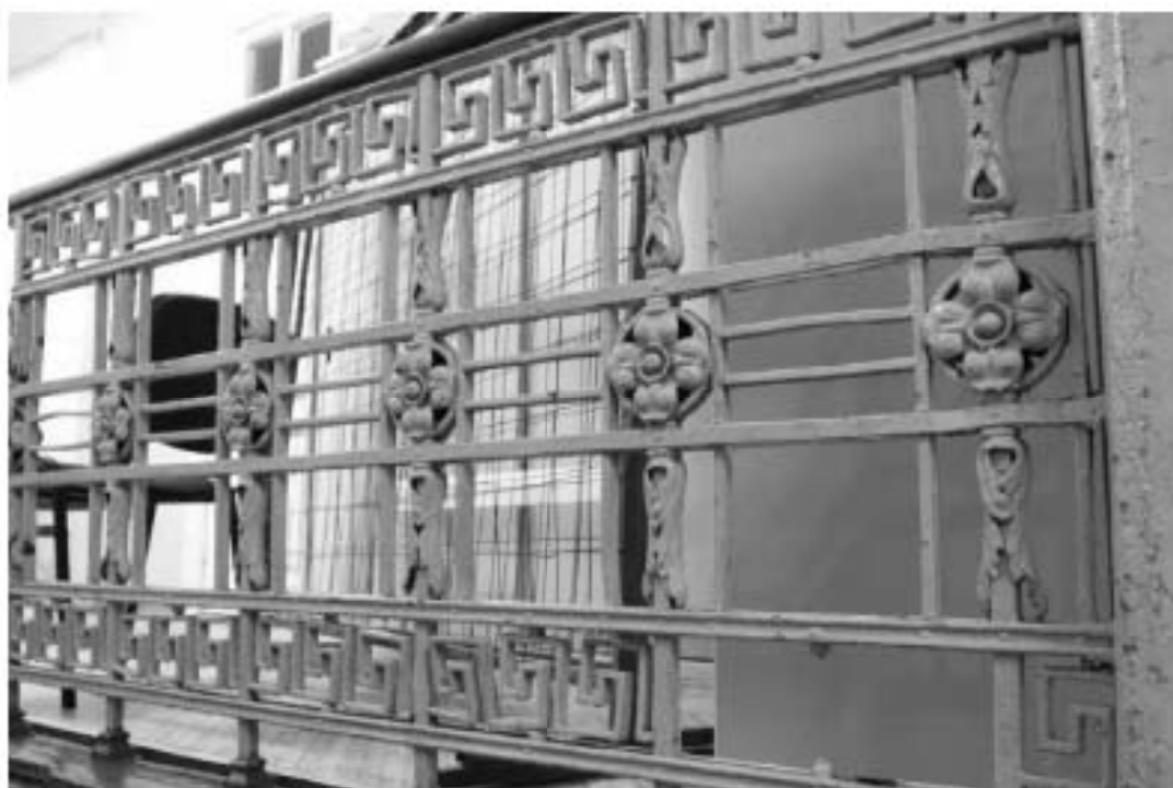
155. «Особняк Безобразовой». Санкт-Петербург, Моховая ул., 34, литера А (Моховая ул., 34). Дворовый корпус. 3-й этаж. Фрагмент помещения 21-Н(17). Фото: 26.10.2021.
