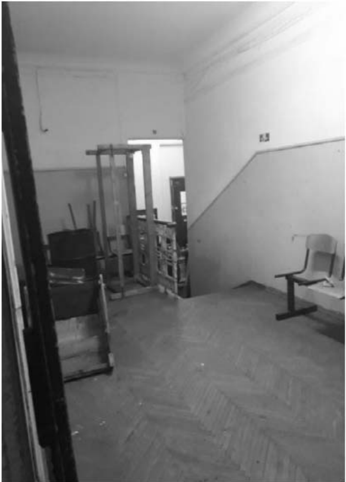
153. «Особняк Безобразовой». Санкт-Петербург, Моховая ул., 34, литера А (Моховая ул., 34). Дворовый корпус. 3-й этаж. Фрагмент помещения 21-Н(17). Фото: 26.10.2021.
