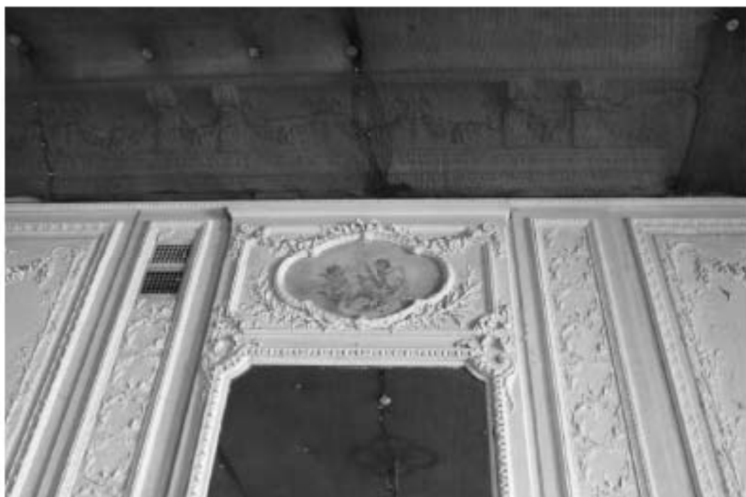
69. «Особняк Безобразовой». Санкт-Петербург, Моховая ул., 34, литера А (Моховая ул., 34). Лицевой корпус. 2-й этаж. Фрагмент помещения 18-Н(2). Фото: 26.10.2021.
