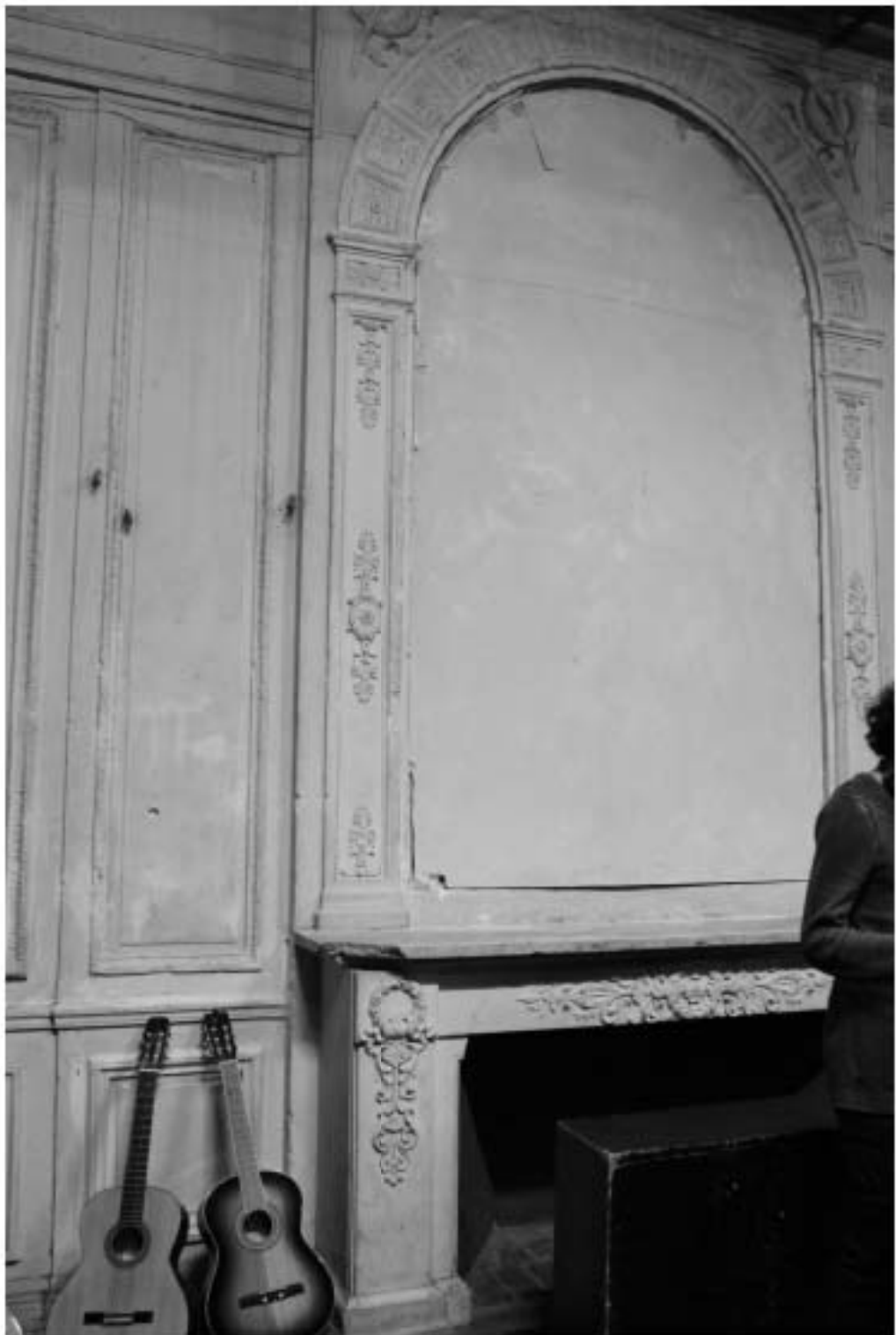
73. «Особняк Безобразовой». Санкт-Петербург, Моховая ул., 34, литера А (Моховая ул., 34). Лицевой корпус. 2-й этаж. Фрагмент помещения 19-Н(3). Фото: 26.10.2021.
