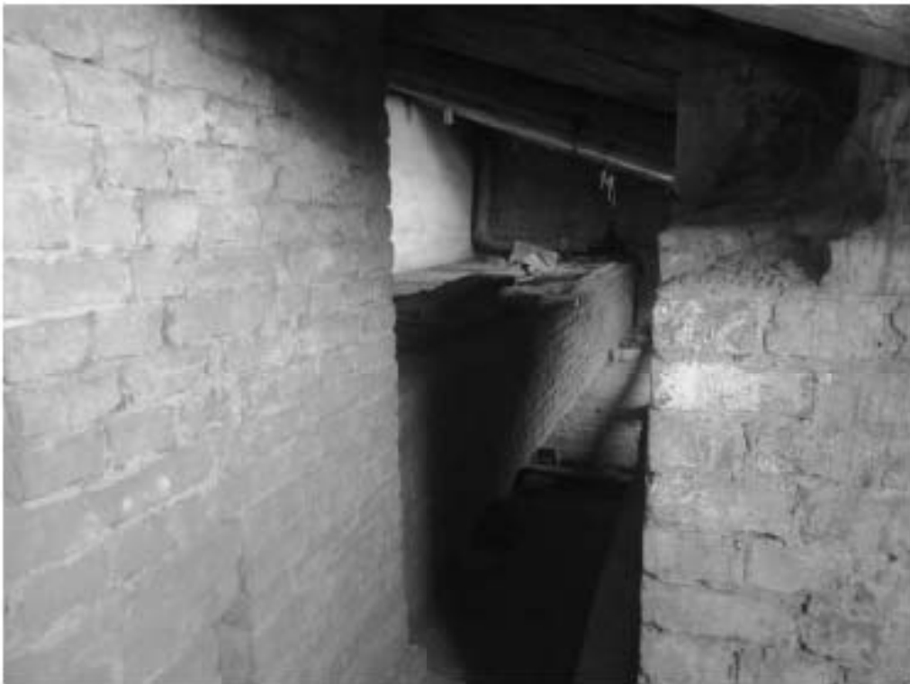
183. «Особняк Безобразовой». Санкт-Петербург, Моховая ул., 34, литера А (Моховая ул., 34). Фрагмент чердачного помещения. Фото: 26.10.2021.
