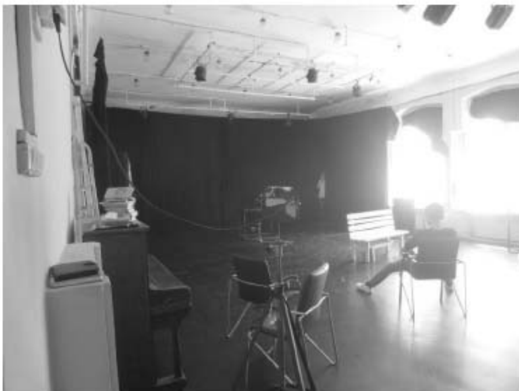
129. «Особняк Безобразовой». Санкт-Петербург, Моховая ул., 34, литера А (Моховая ул., 34). Лицевой корпус. 3-й этаж. Фрагмент помещения 21-Н(16). Фото: 26.10.2021.
