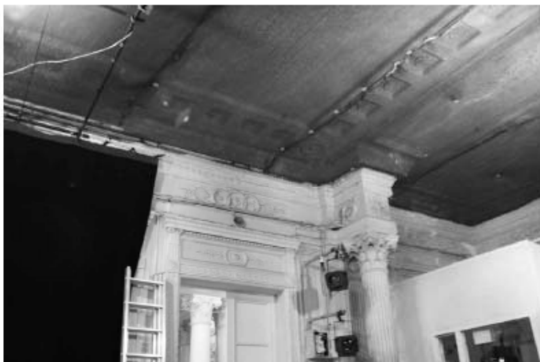
72. «Особняк Безобразовой». Санкт-Петербург, Моховая ул., 34, литера А (Моховая ул., 34). Лицевой корпус. 2-й этаж. Фрагмент помещения 19-Н(3). Фото: 26.10.2021.
