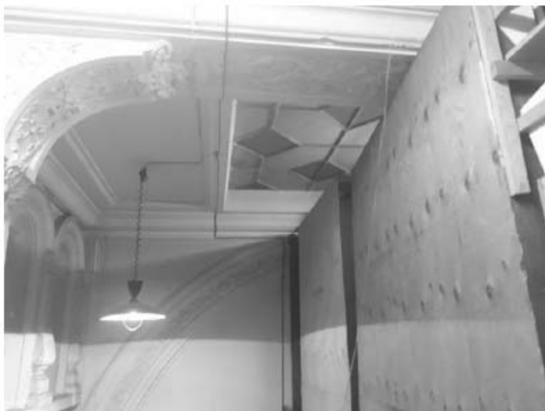
79. «Особняк Безобразовой». Санкт-Петербург, Моховая ул., 34, литера А (Моховая ул., 34). Лицевой корпус. 2-й этаж (антресоль). Фрагмент помещения 19-Н(2). Фото: 26.10.2021.
