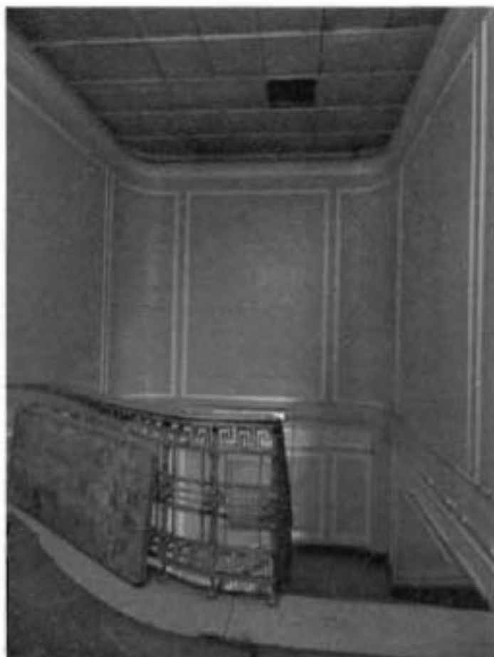
20. Лестница в северо-западной части здания
