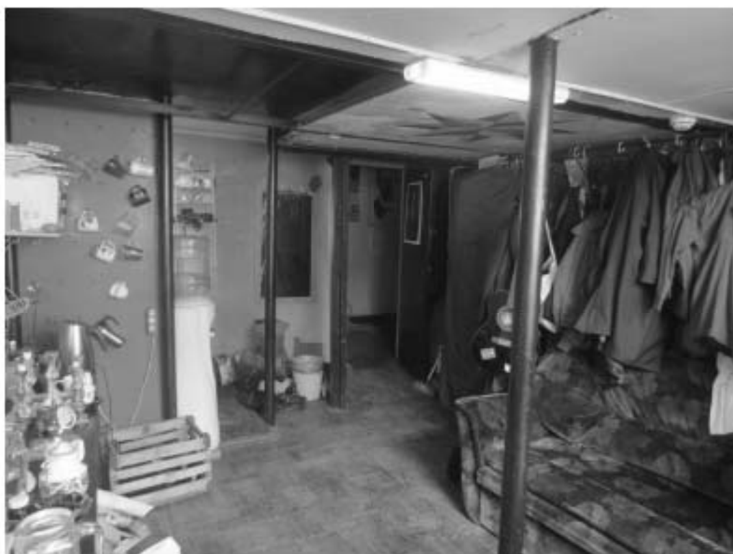
142. «Особняк Безобразовой». Санкт-Петербург, Моховая ул., 34, литера А (Моховая ул., 34). Дворовый корпус. 4-й этаж. Фрагмент помещения 23-Н(2). Фото: 26.10.2021.
