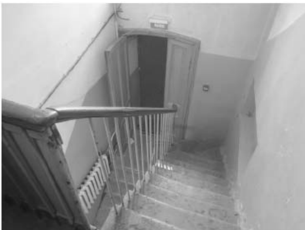
11. «Особняк Безобразовой». Санкт-Петербург, Моховая ул., 34, литера А (Моховая ул., 34). Дворовой корпус. Лестница 3 ЛК. Фото: 26.10.2021.
