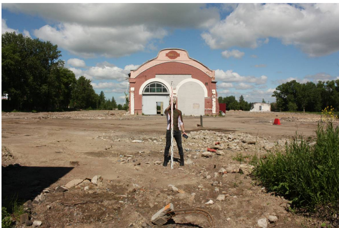
Рис. 15. Санкт-Петербург-2022. Земельный участок с кадастровым № 78:42:1812703:1676. Точка фотофиксации 5. Вид с юго-востока
