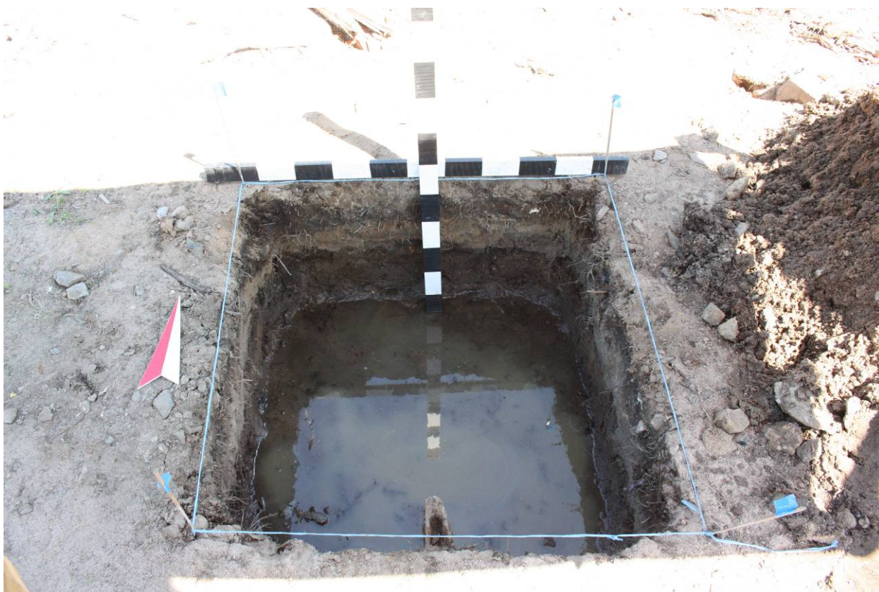
Рис. 83. Санкт-Петербург-2022. Земельный участок с кадастровым № 78:42:1812703:1676. Шурф 8. Уровень грунтовых вод. Общий вид шурфа. Вид с юга
