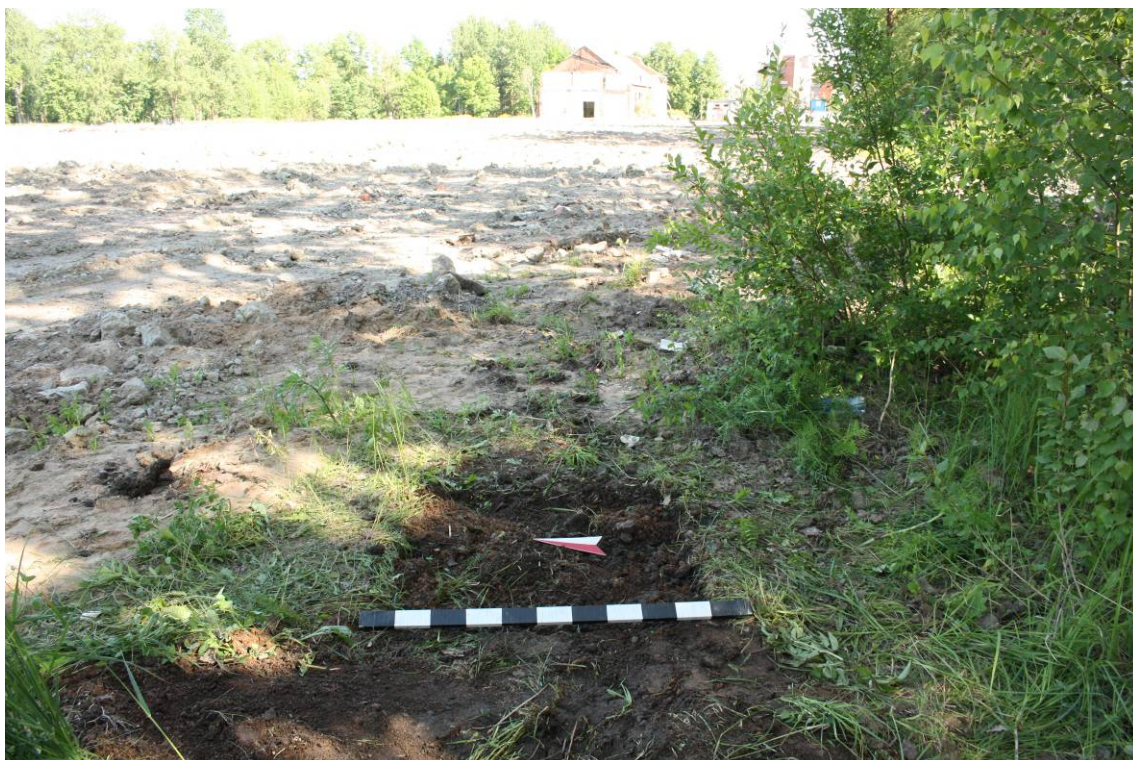
Рис. 76. Санкт-Петербург-2022. Земельный участок с кадастровым № 78:42:1812703:1676. Шурф 6. Рекультивация. Вид с запада
