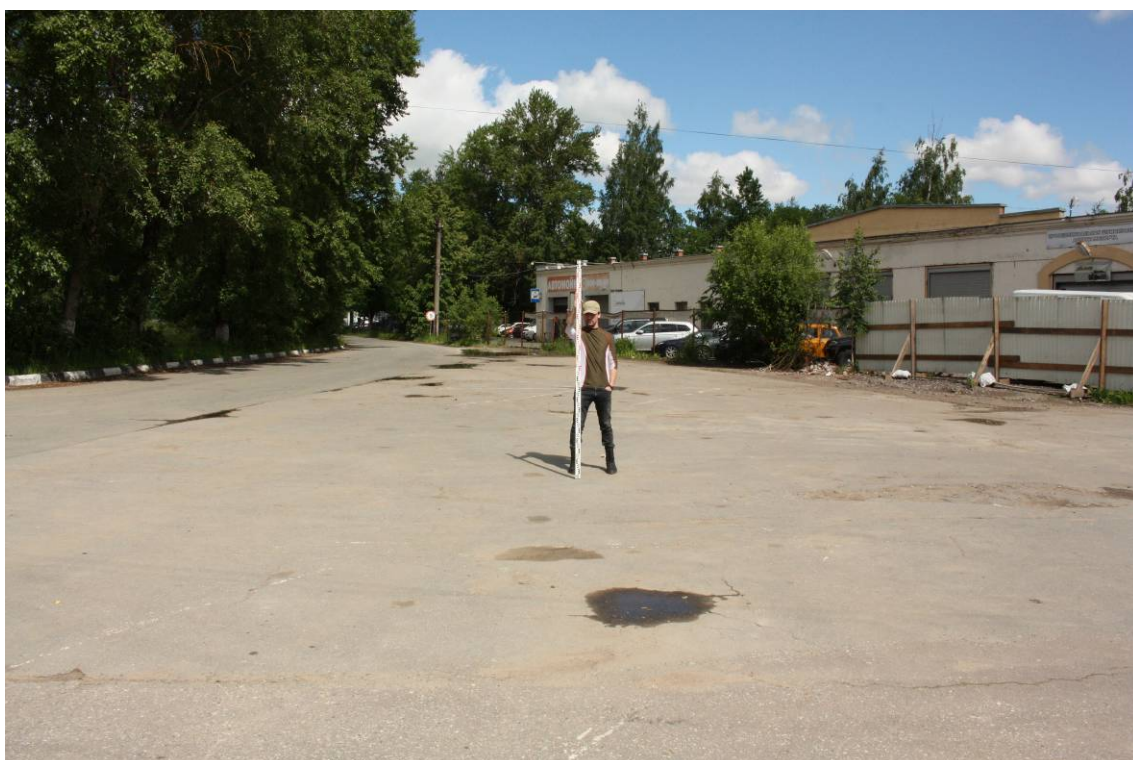
Рис. 11. Санкт-Петербург-2022. Земельный участок с кадастровым № 78:42:1812703:1676. Точка фотофиксации 1. Вид с юга
