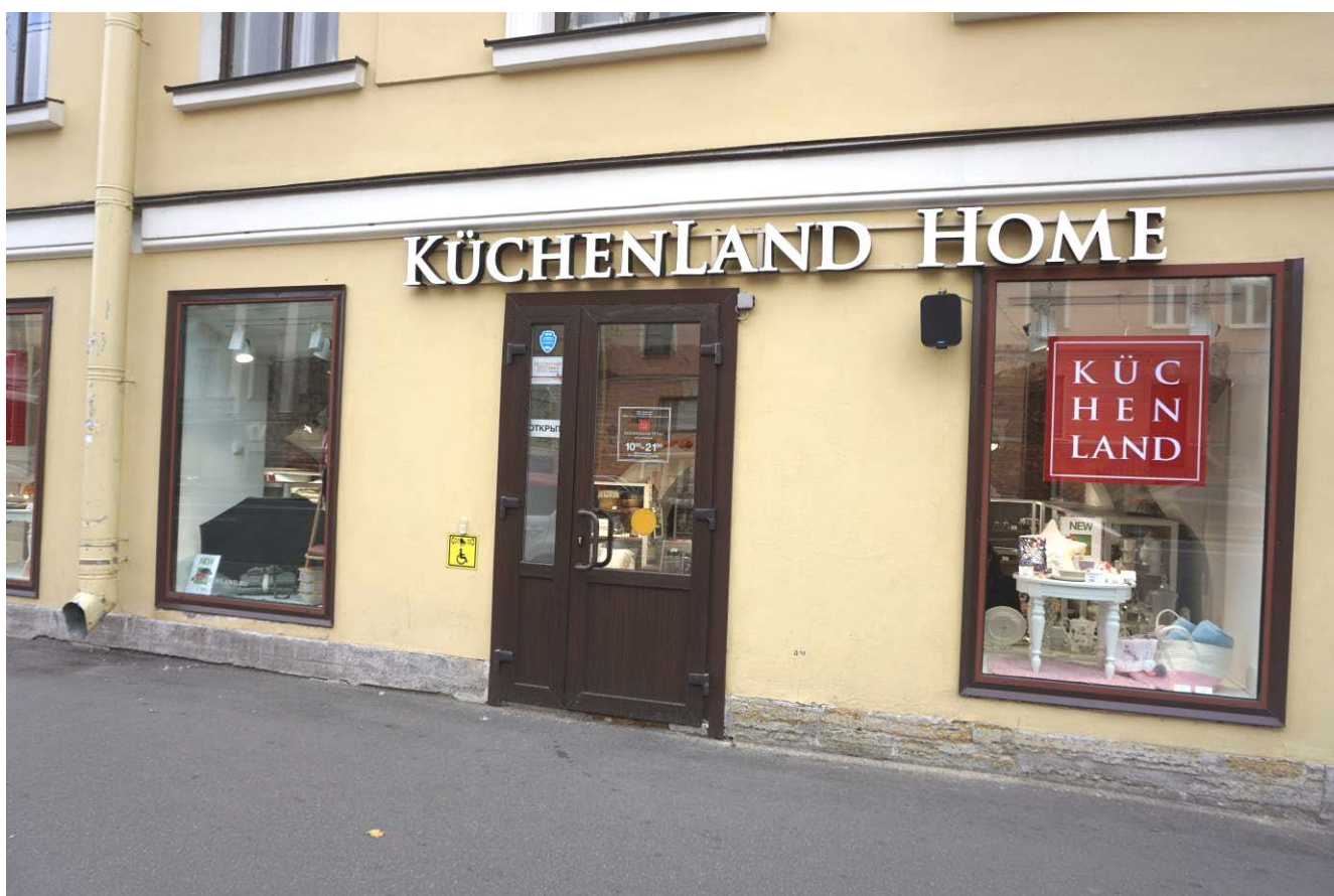
Фото 4. Входная группа выявленного объекта культурного наследия «Дом А.В. Шувалова» со стороны 1-ой линии В.О. Оконные и дверной проемы помещения 7-Н.
