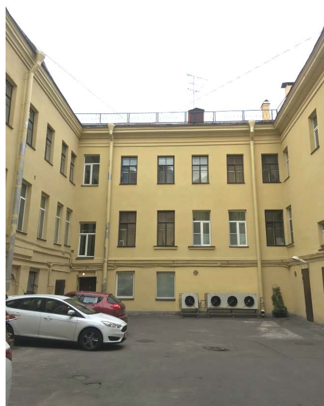
Фото 10. Вид на дворовые фасады выявленного объекта культурного наследия «Дом А.В. Шувалова».
