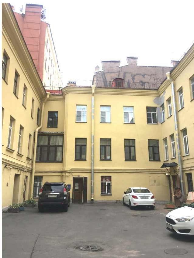
Фото 9. Вид на дворовые фасады выявленного объекта культурного наследия «Дом А.В. Шувалова».
