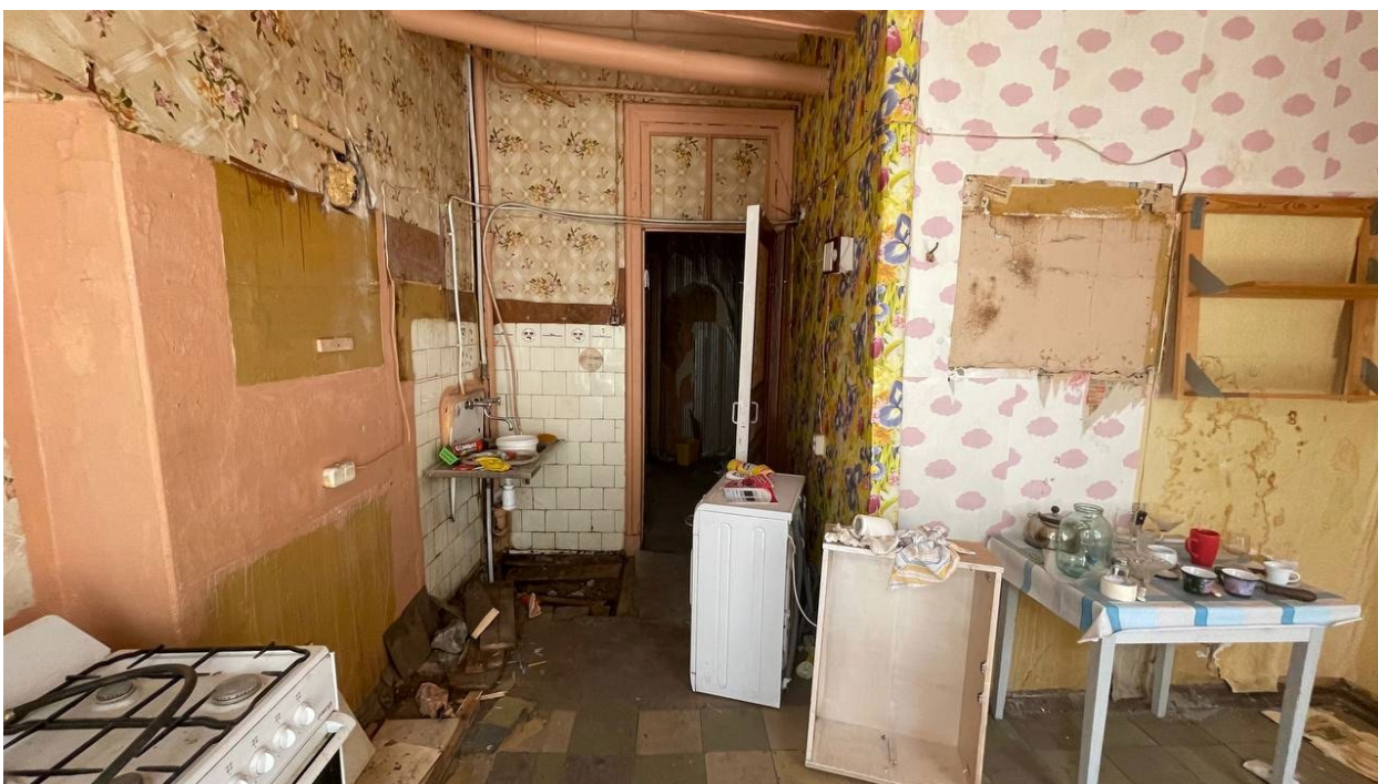
25. Фрагмент интерьера кухни-столовой (помещение №4);
