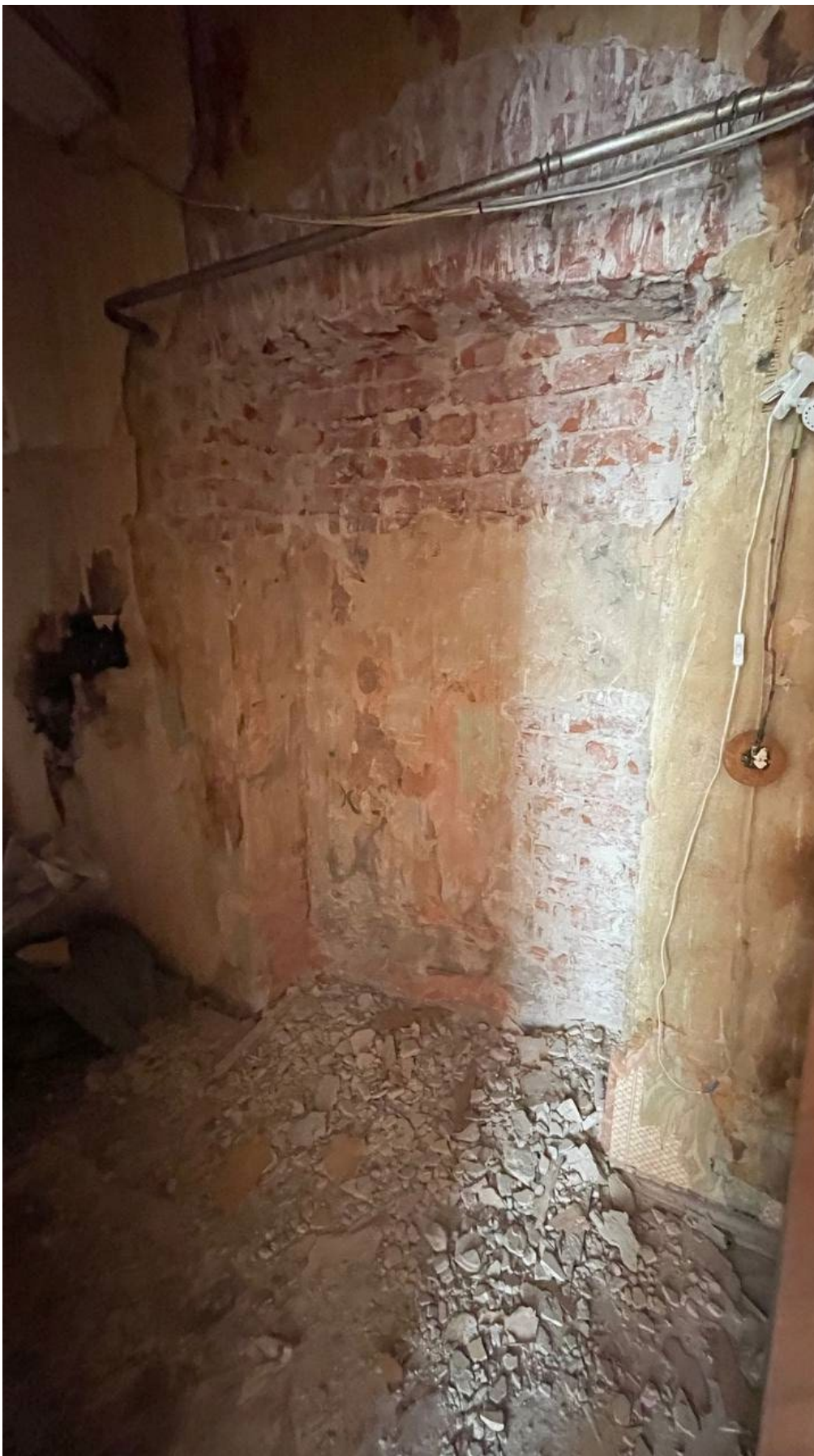
15. Фрагмент интеръера коридора (помещение №6);
