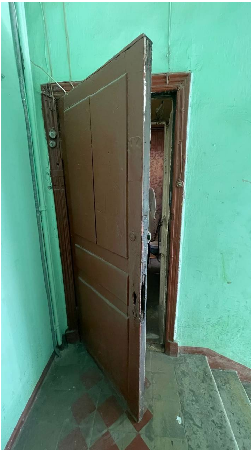
35. Вид на входную дверь с чёрной лестницы.
