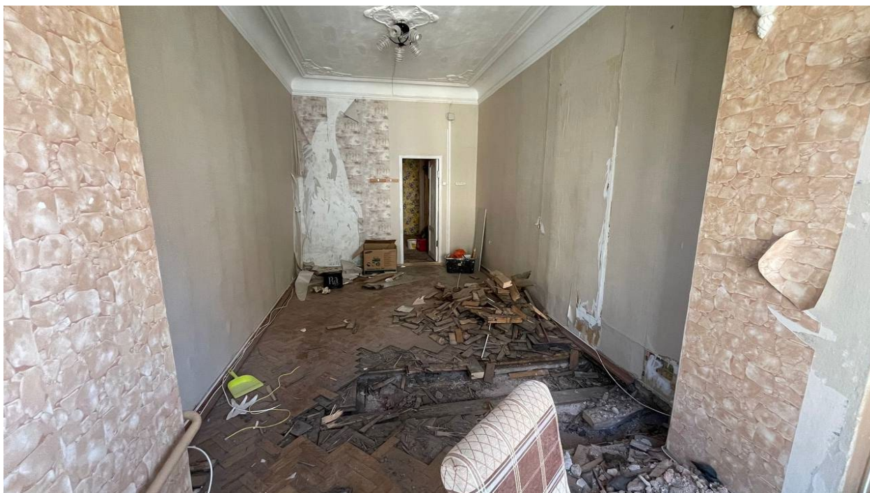
39. Фрагмент интерьера комнаты (помещение №7);
