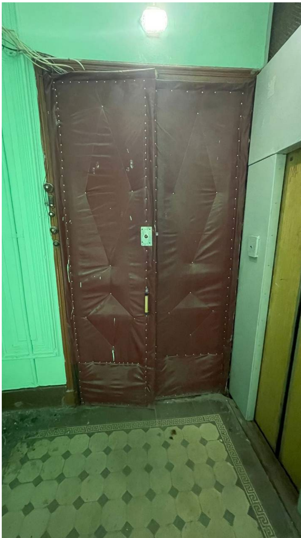
6. Вид на входную дверь квартиры №5;
