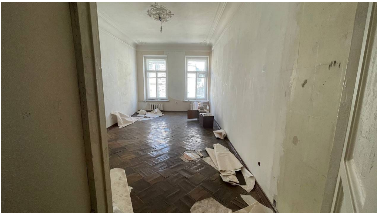
18. Фрагмент интерьера комнаты (помещение №10);
