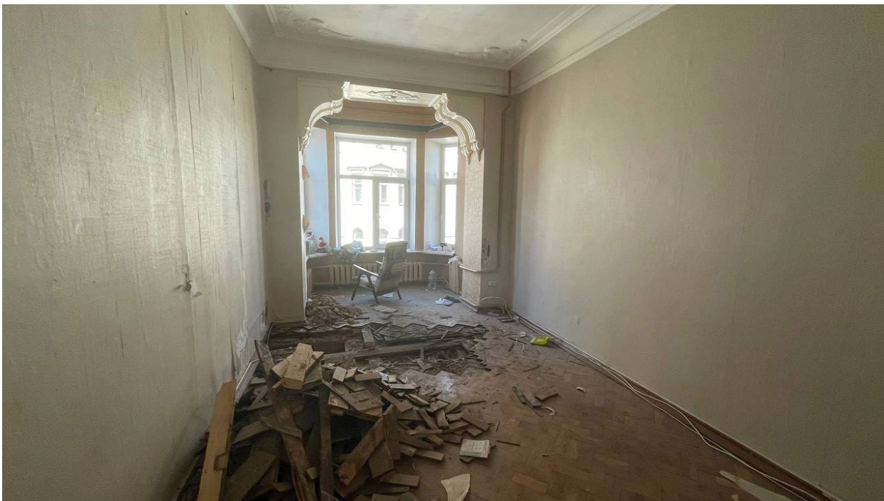
37. Фрагмент интерьера комнаты (помещение №7);
