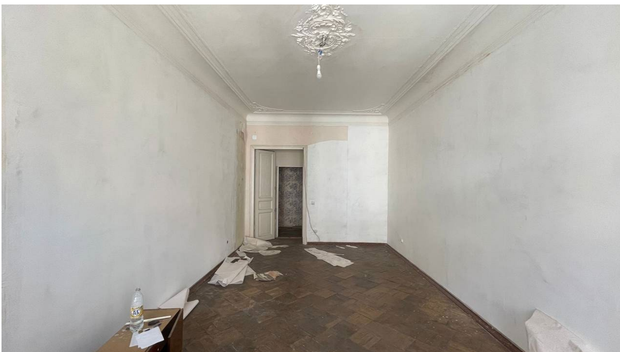
19. Фрагмент интерьера комнаты (помещение №10);
