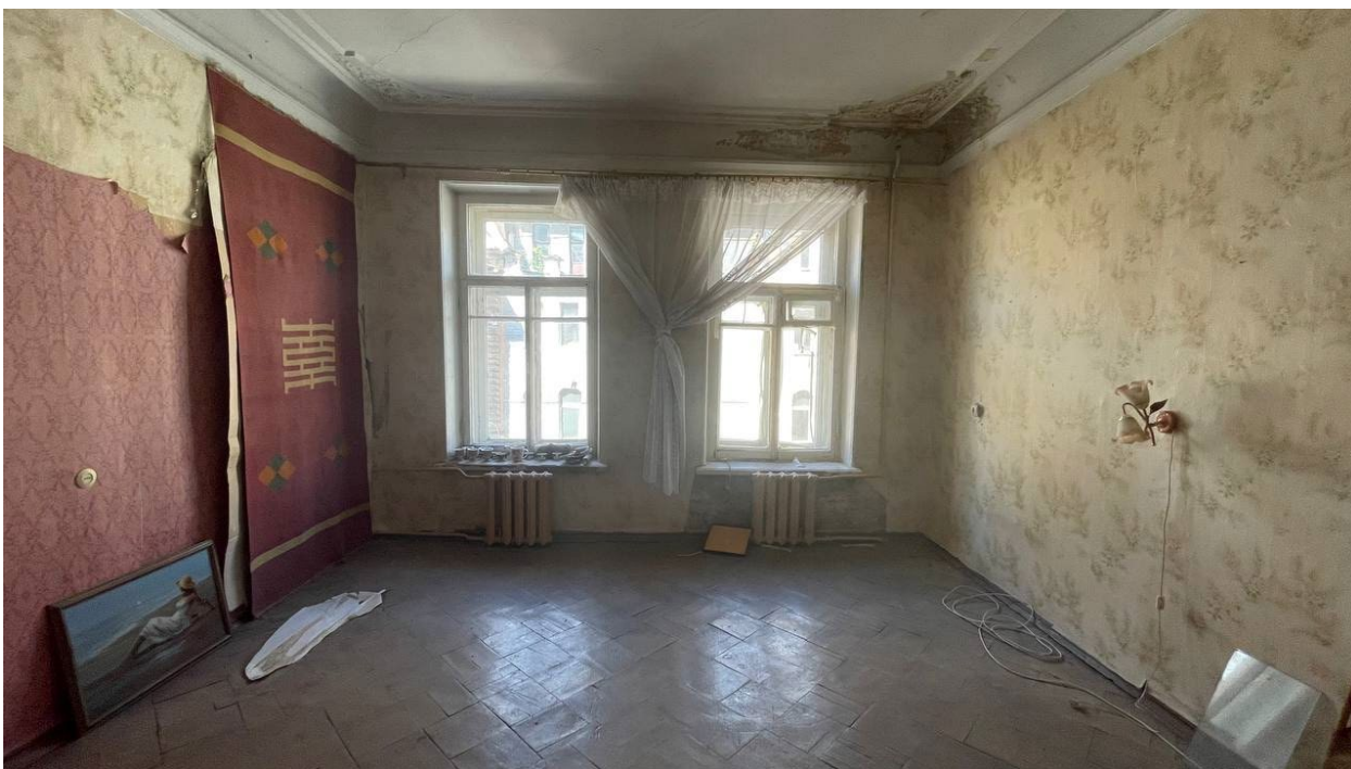
47. Фрагмент интерьера комнаты (помещение №11);
