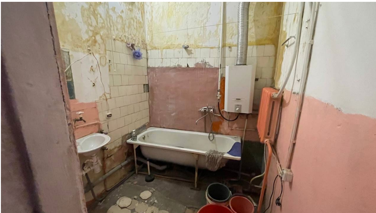
16. Фрагмент интерьера совмещённого санузла (помещение №5);
