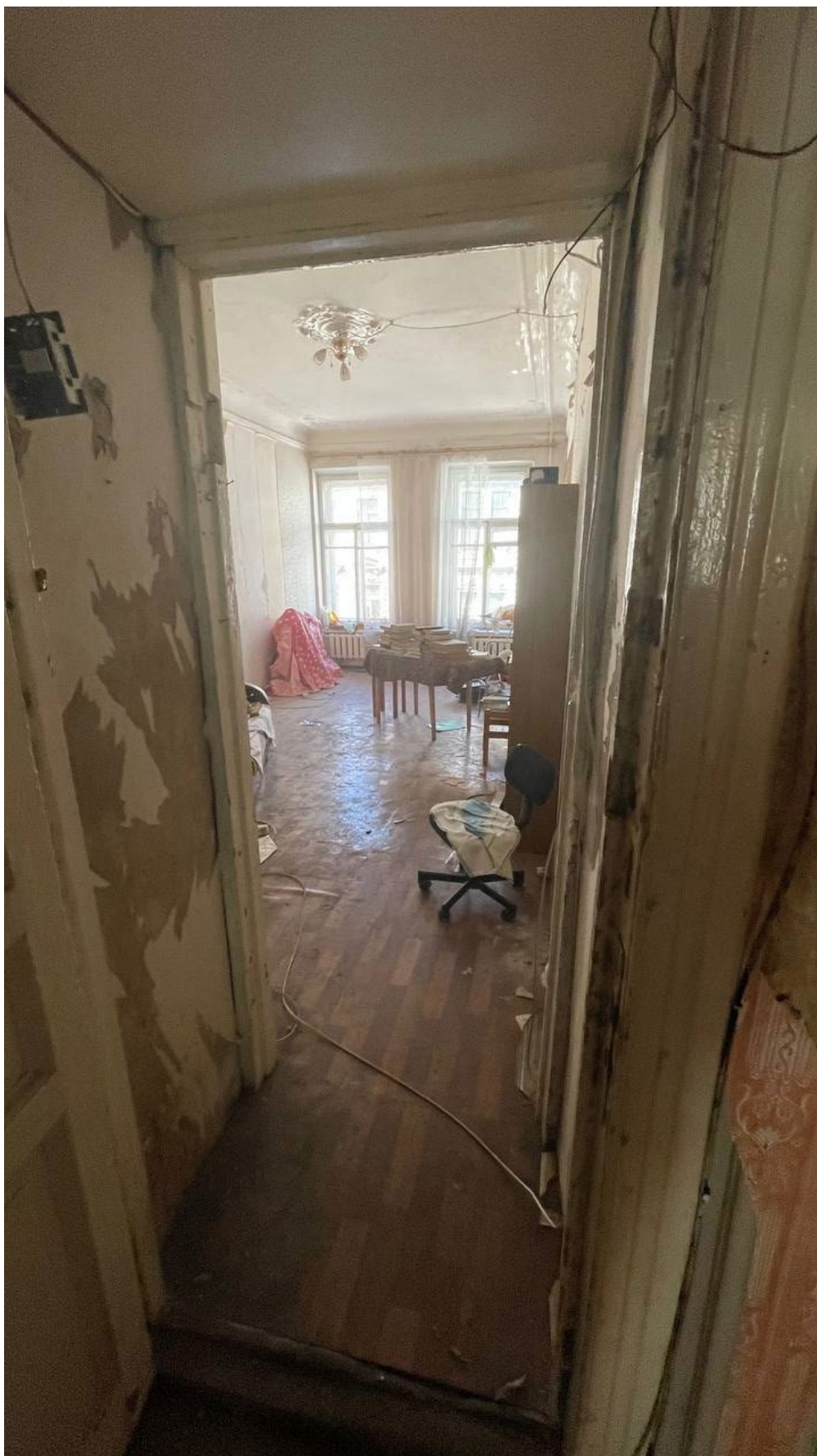
28. Фрагмент интеръера коридора и вид на комнату (помещение №6 и №9);
