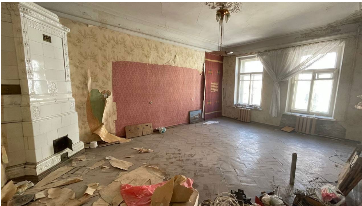
46. Фрагмент интерьера комнаты (помещение №11);
