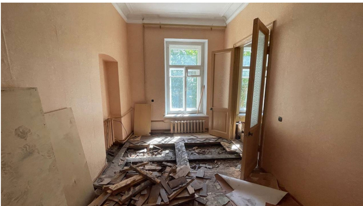
11. Фрагмент интерьера комнаты (помещение №2);
