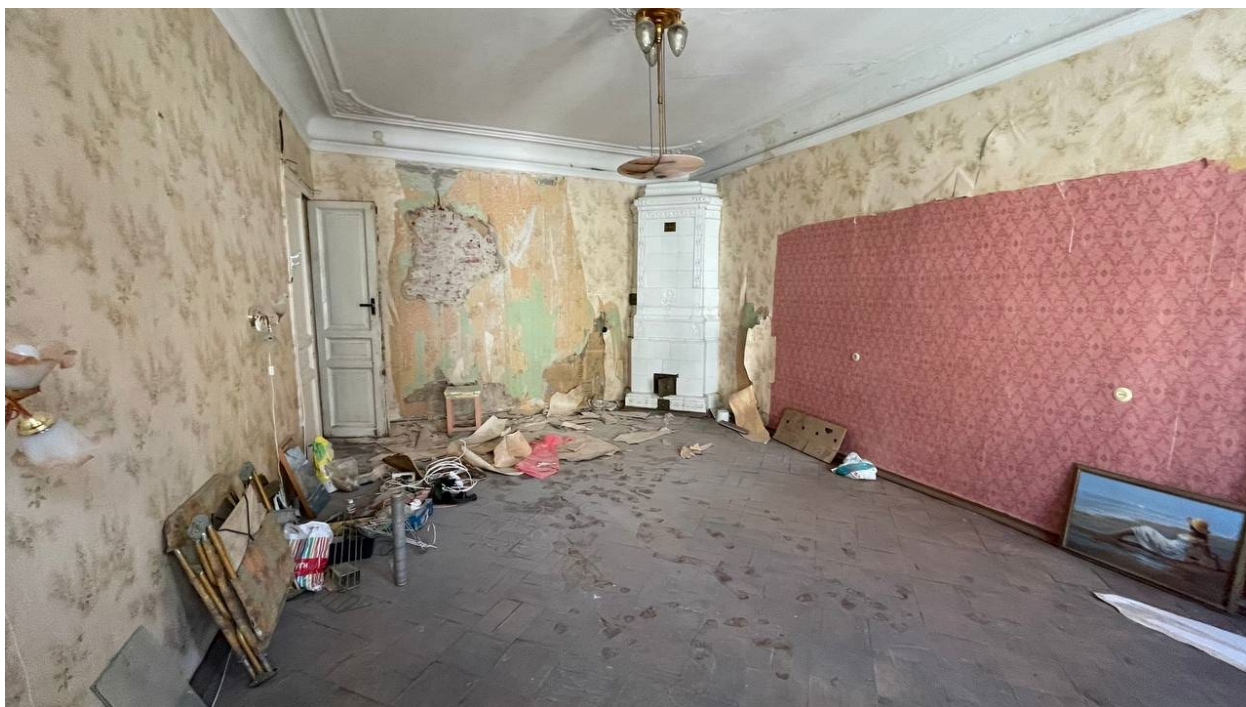
48. Фрагмент интерьера комнаты (помещение №11);
