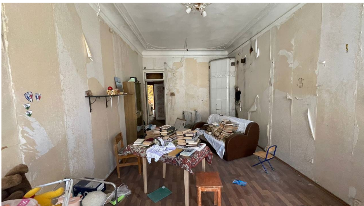
31. Фрагмент интерьера комнаты (помещение №9);
