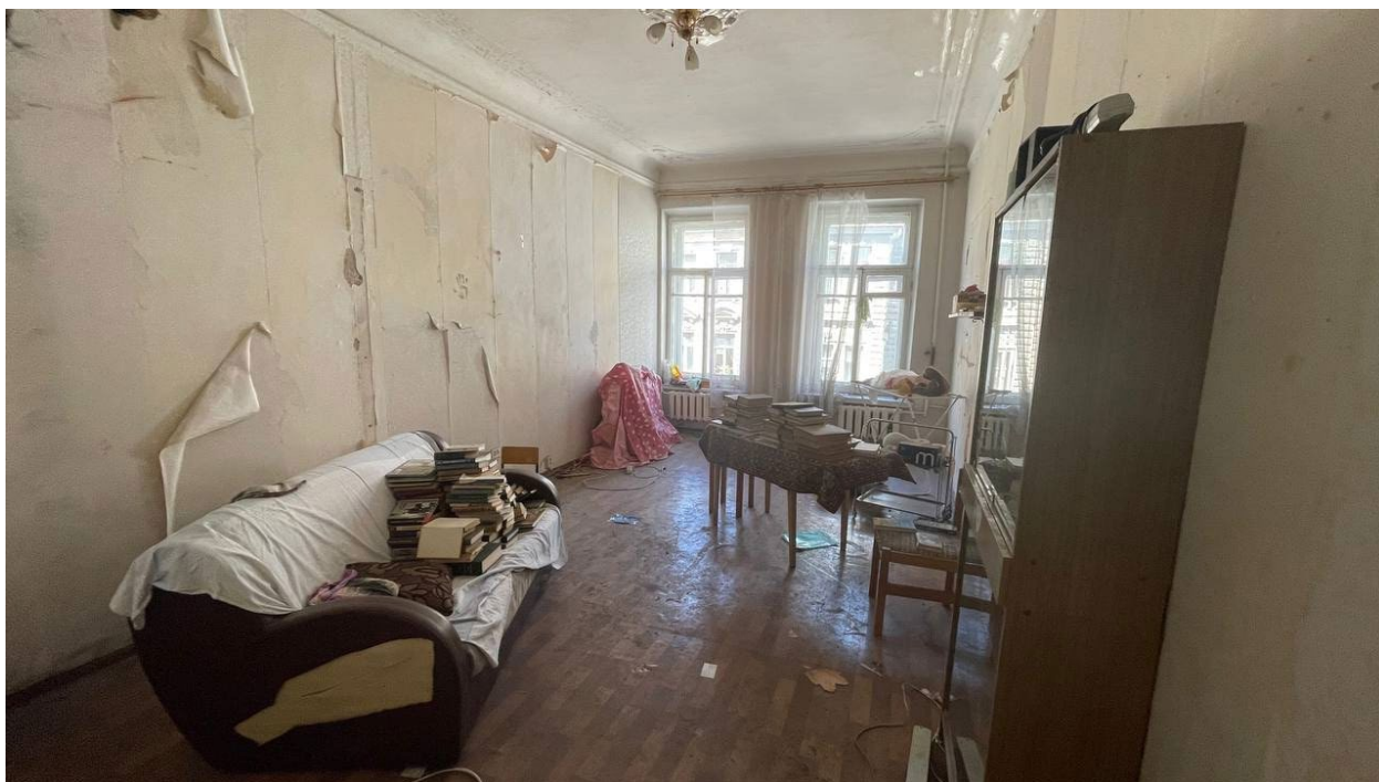
30. Фрагмент интерьера комнаты (помещение №9);
