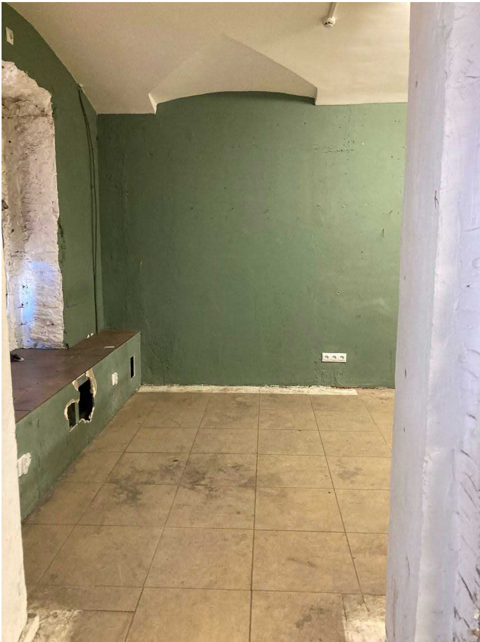
Фото 6. Проход в помещение №4
