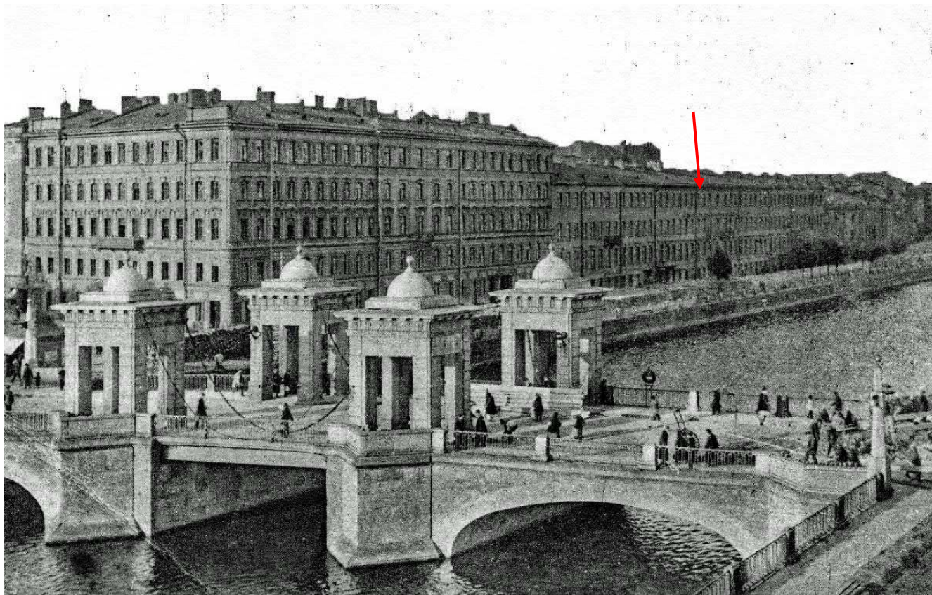
Илл.22. Чернышев мост 1925–1930. Адрес: Фонтанки наб., 55/Ломоносова пл., 6, далее Фонтанки наб., 53. Источник: www.pastvu.com . Стрелкой показан бывший доходный четырехэтажный дом Лыткиных.
