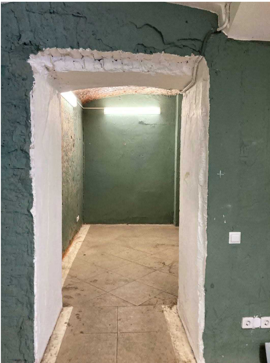
Фото 10. Проход в помещение №8
