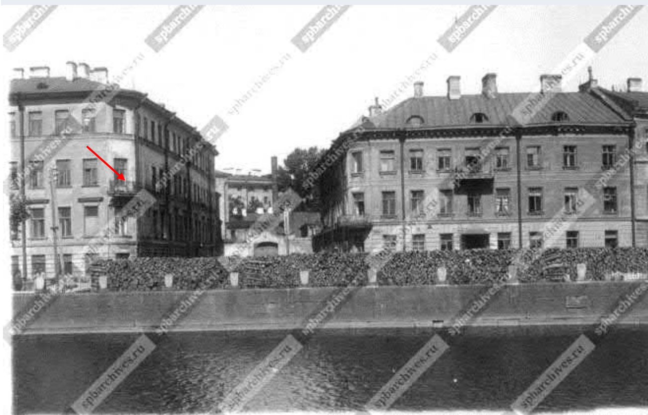
Илл.26. ЦГАКФФД СПб, Шифр: Гр 65885. Аннотация: Фасады домов №49-№51 на набережной реки Фонтанки до перестройки. Дата съёмки: июль 1926 г. Стрелкой показан угловой балкон у уровне третьего этажа. Бывший дом Лыткиных в 1926 году четырёхэтажный.
