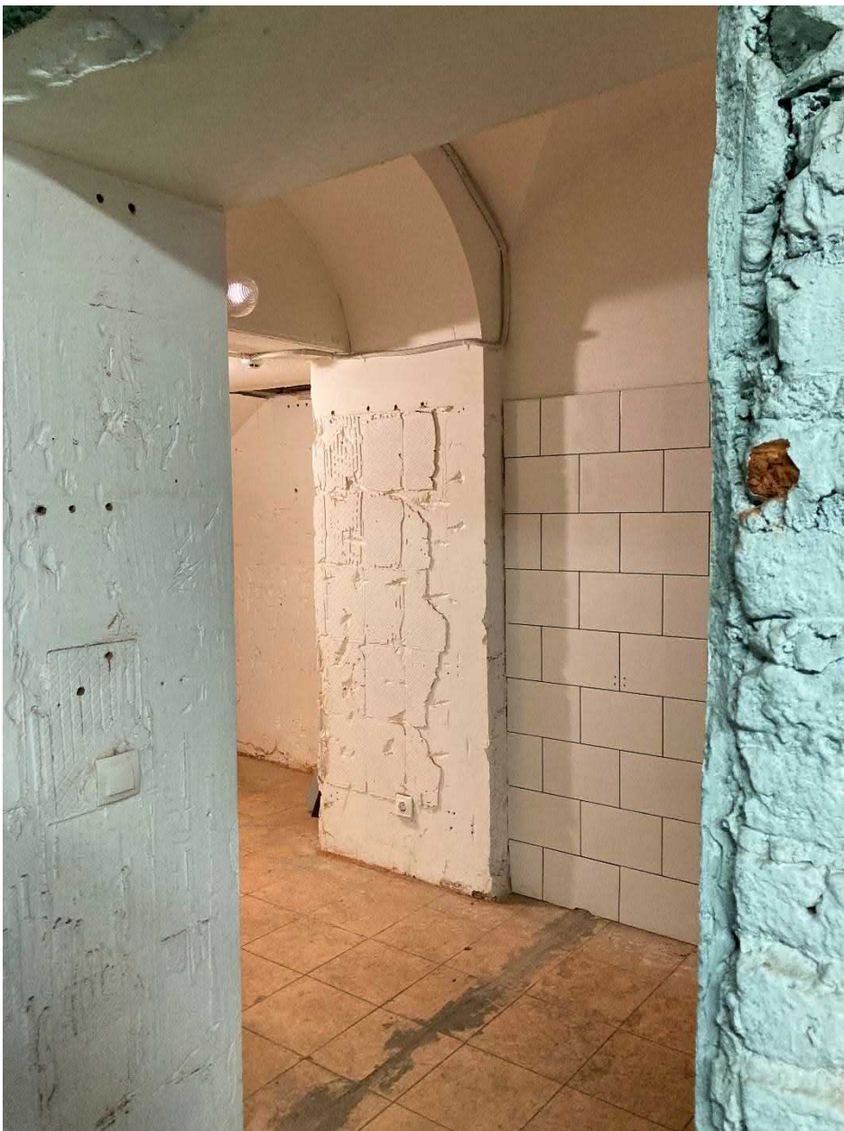
Фото 13. Проход в помещения №6.2, 7
