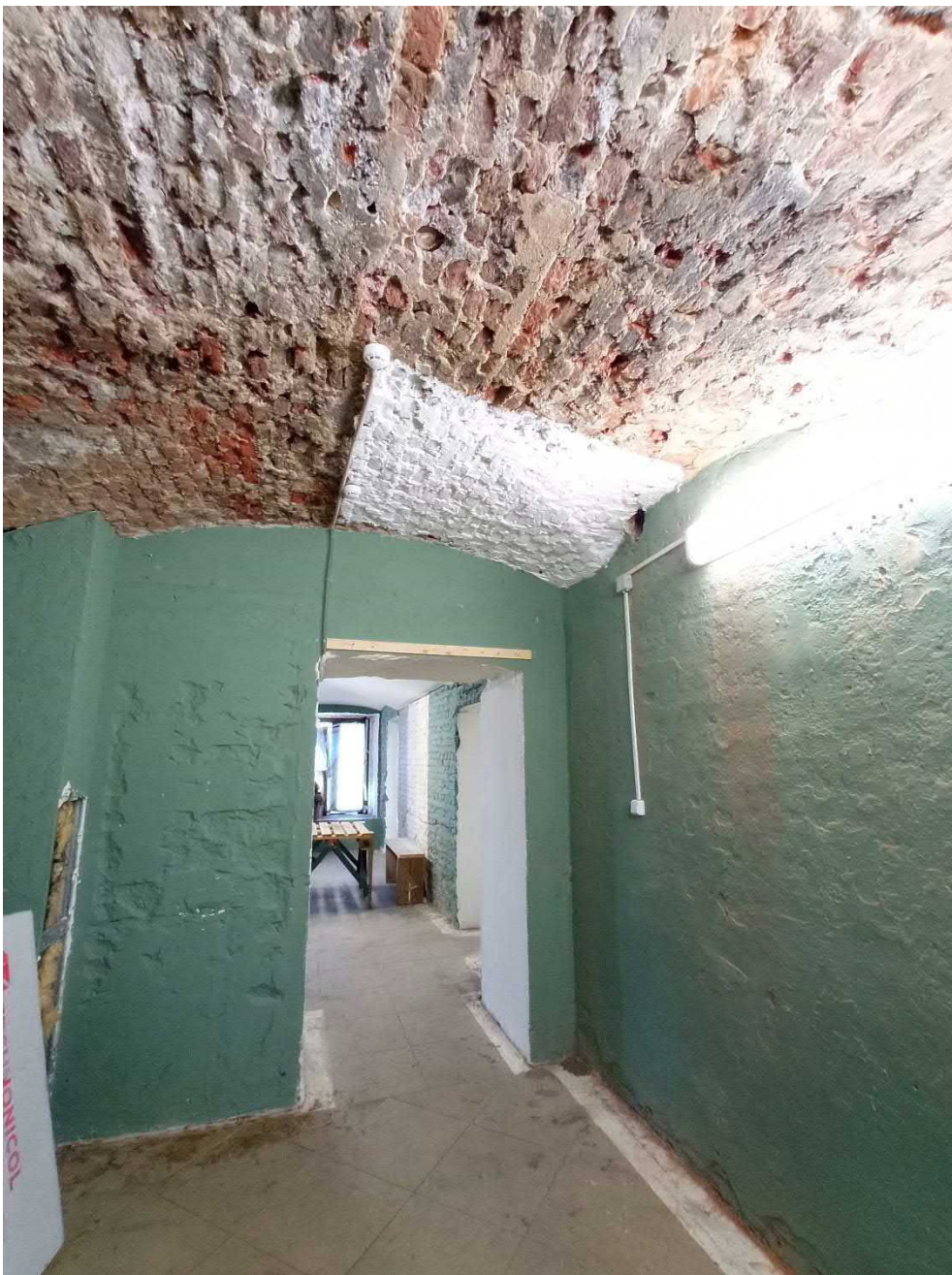
Фото 16. Проход в помещение № 3
