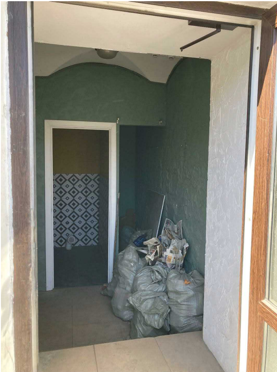
Фото 2. Вход в помещение 17-Н. Помещения 1, 2.1, 2.2
