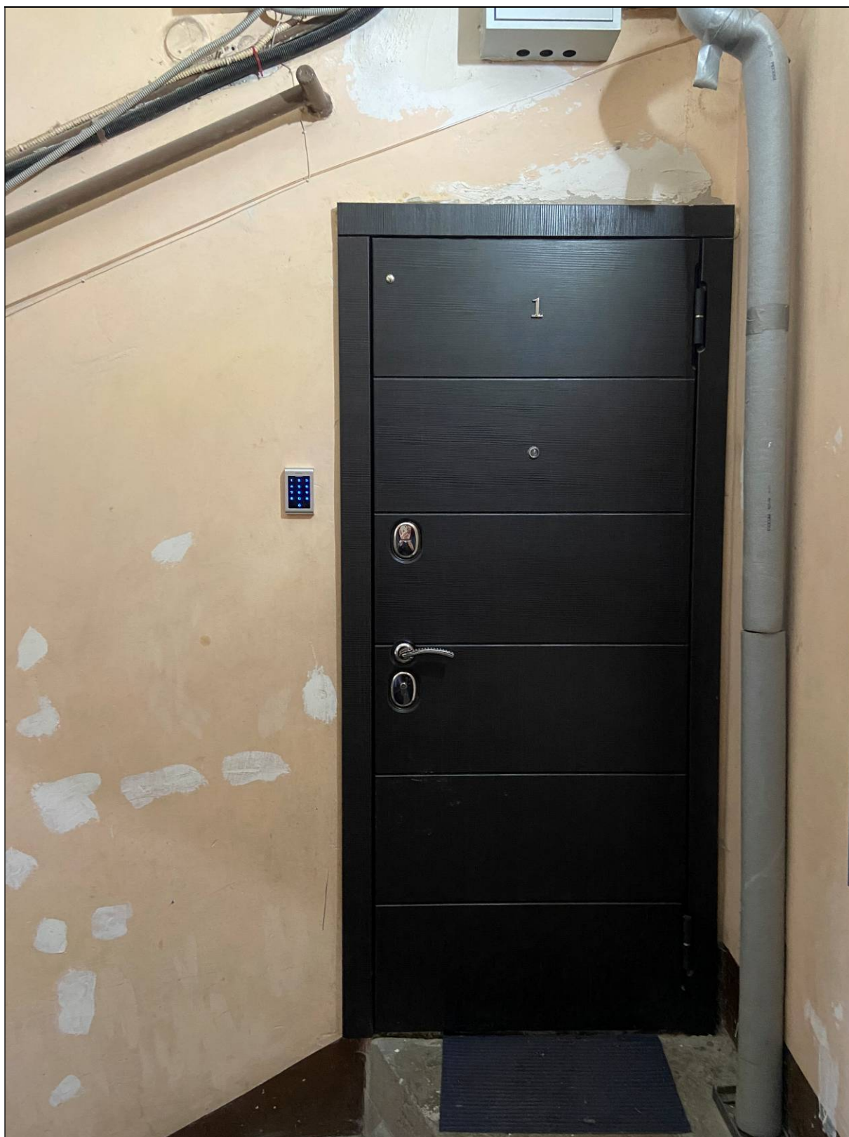
12. Выявленный объект культурного наследия «Жилой дом при заводе Ф.К. Сан-Галли». Лестница Л-4. Вход в квартиру № 1. 02.11.2021 г.
