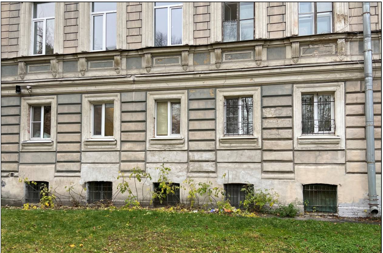
5. Выявленный объект культурного наследия «Жилой дом при заводе Ф.К. Сан-Галли». Фрагмент юго-восточного фасада. Оконные проемы квартиры № 1. 02.11.2021 г.
