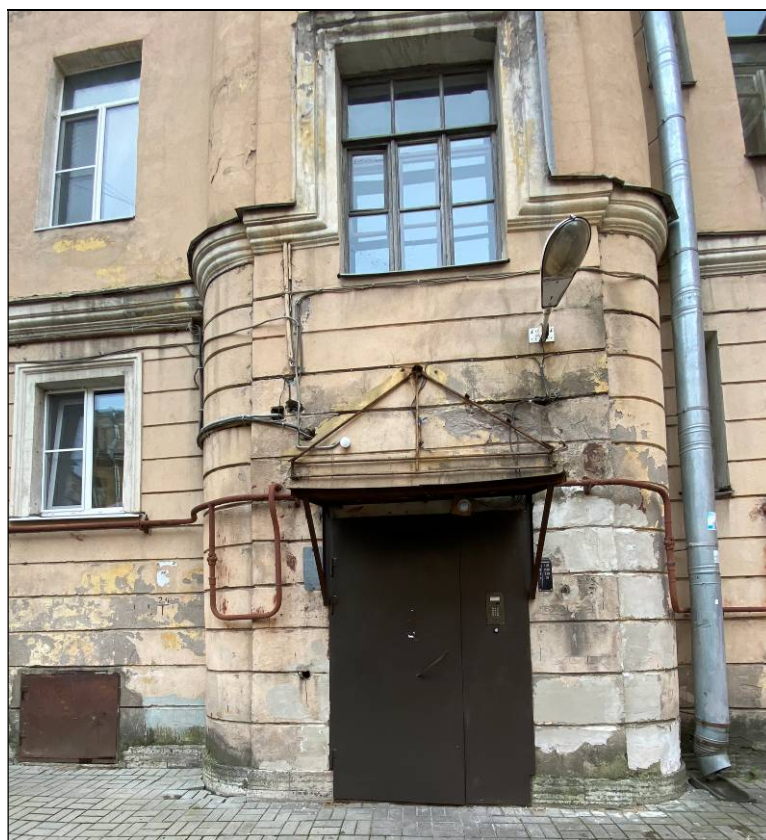
9. Выявленный объект культурного наследия «Жилой дом при заводе Ф.К. Сан-Галли». Фрагмент дворового юго-западного фасада. Вход на лестницу Л-4. 02.11.2021 г.
