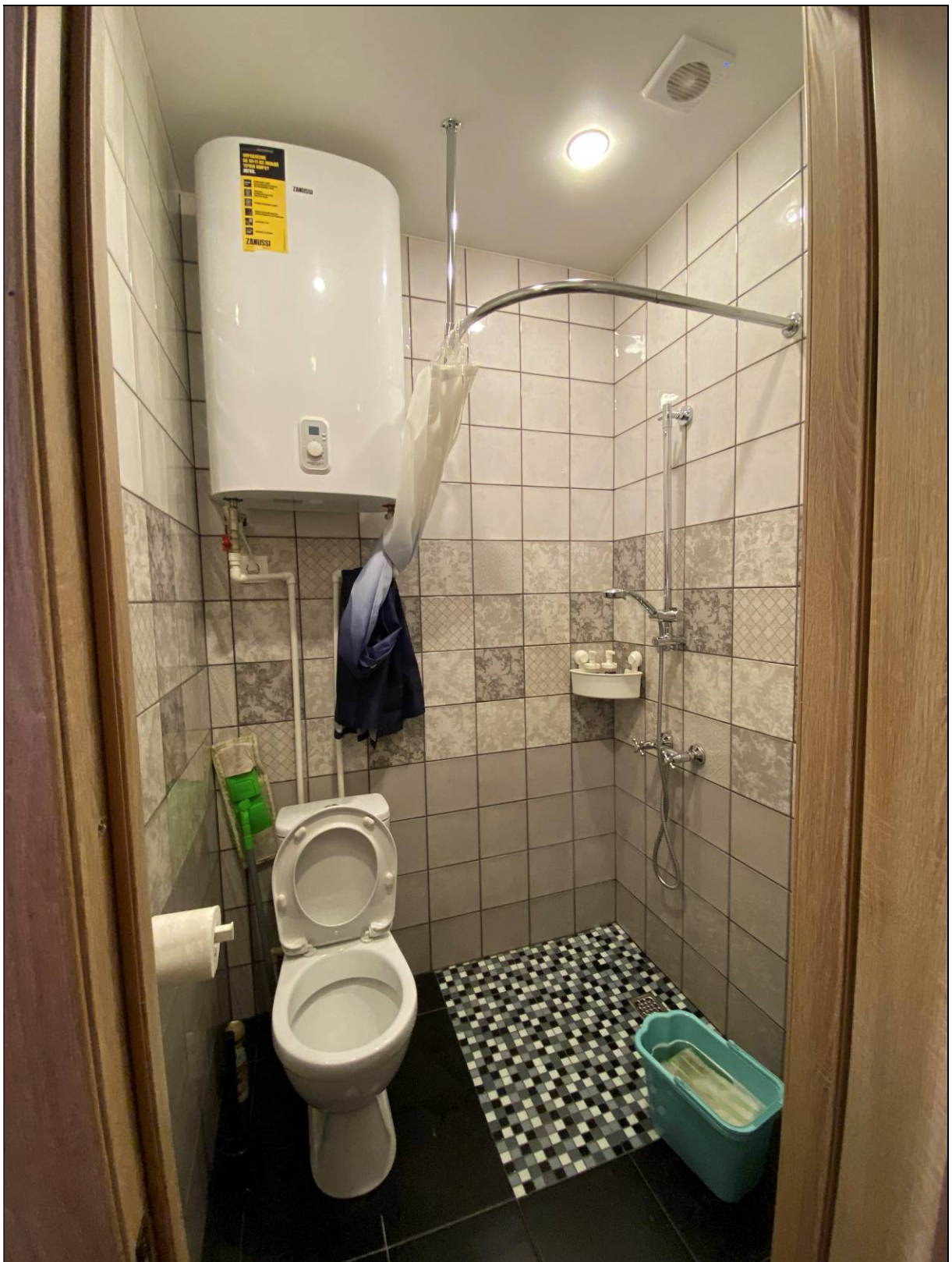
17. Выявленный объект культурного наследия «Жилой дом при заводе Ф.К. Сан-Галли». Квартира № 1. Помещение № 3. 02.11.2021 г.
