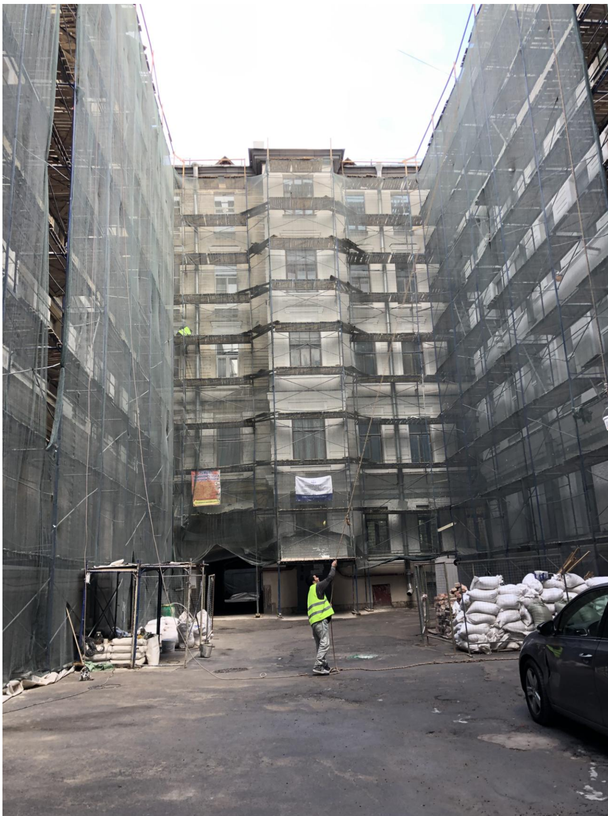
Фото 6. Вид на юго-восток первого двора дома № 26 по Загородному проспекту.
