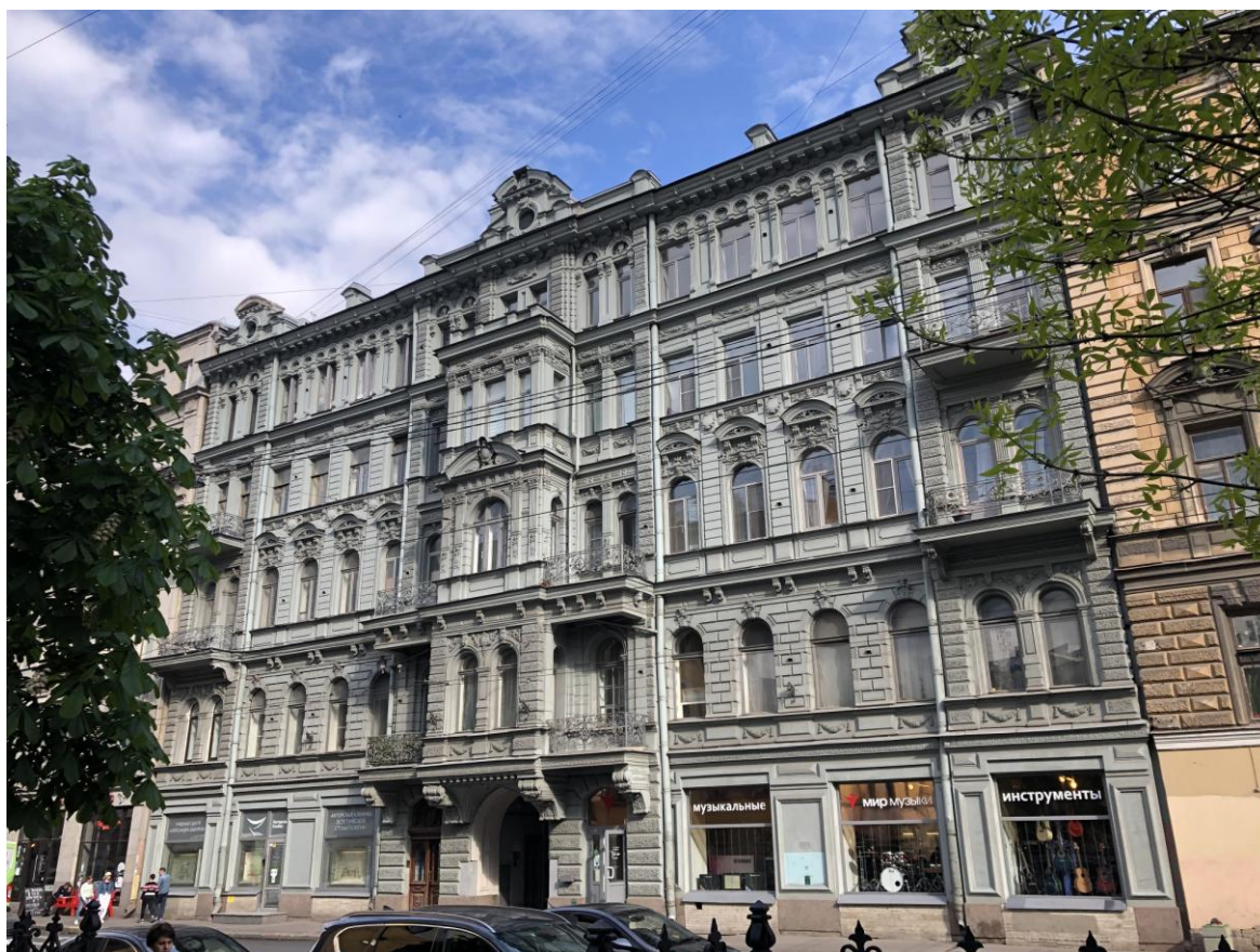
Фото 3. Вид на лицевой фасад дома № 26 по Загородному проспекту с юго-востока.
