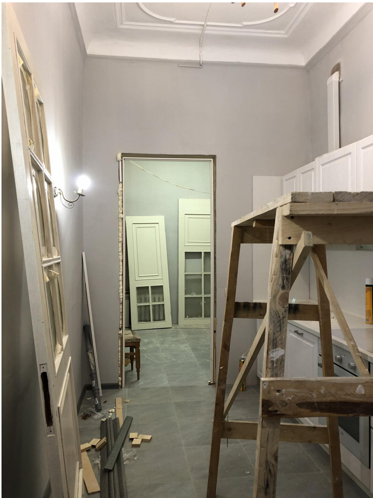
Фото 7. Вид на кухню (помещение № 2).
