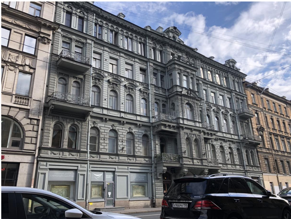
Фото 2. Вид на лицевой фасада дом № 26 по Загородному проспекту с северо-востока.
