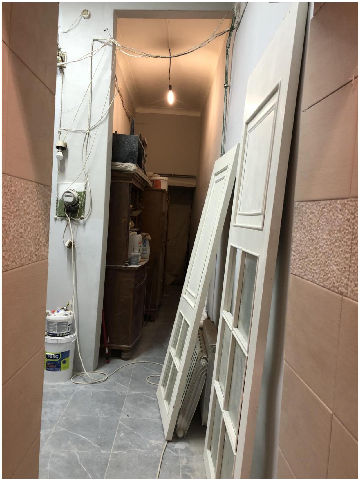
Фото 4. Вид на коридор.
