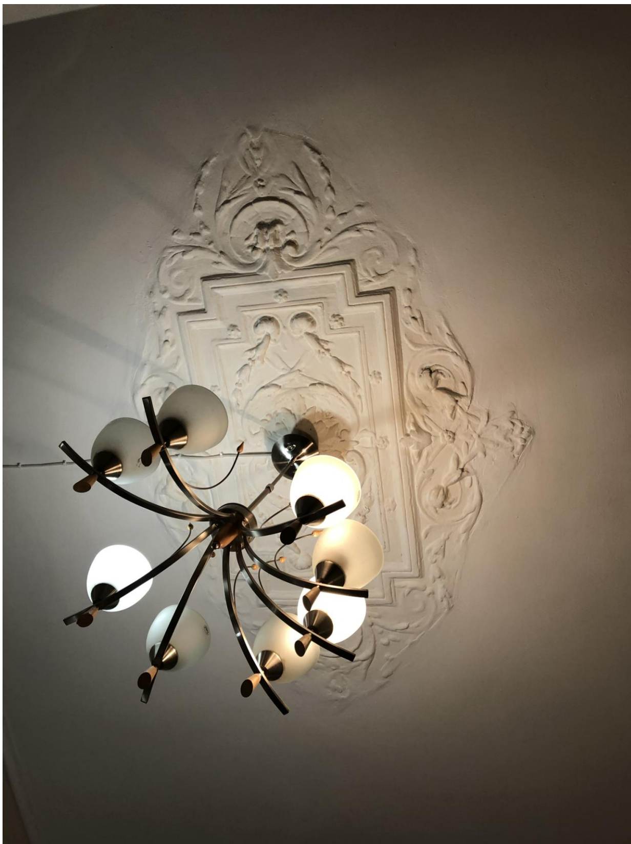
Фото 11. Вид на розетку в спальне (помещение № 3).
