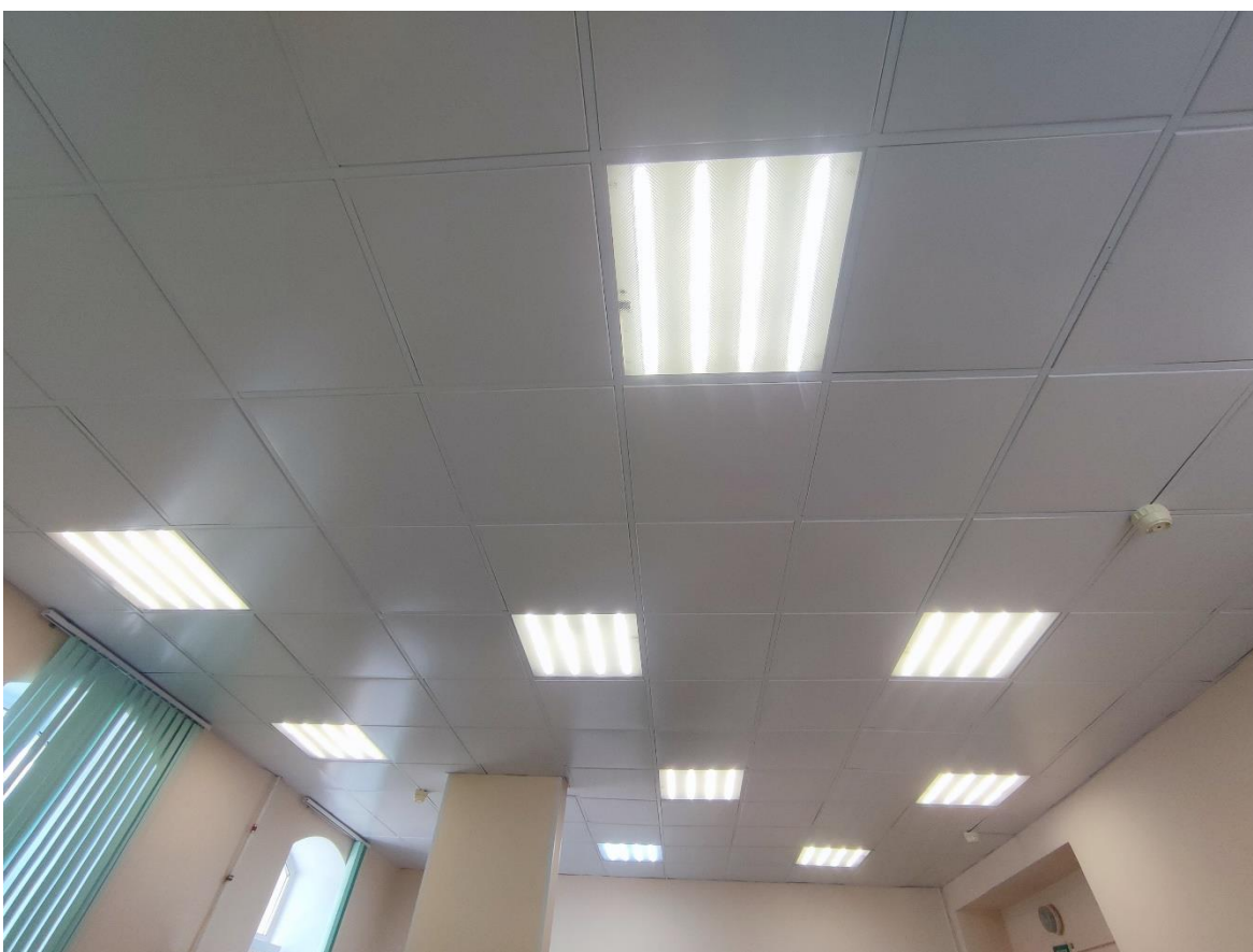
18. Общий вид подвесного потолка в пом. 1-Н (62-65) в уровне 2-го этажа.
