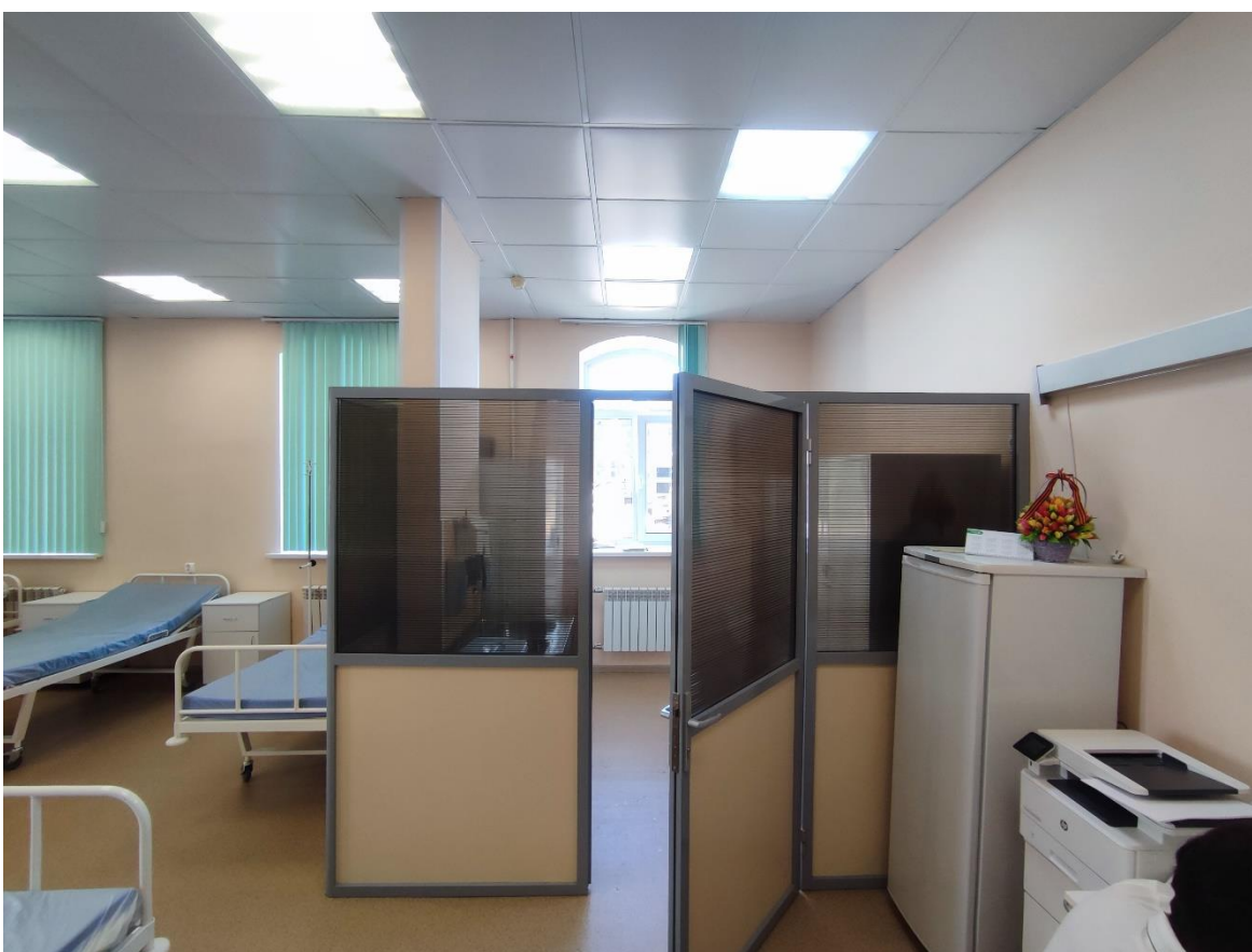
12. Фрагмент пом. 1-Н (62-65) в уровне 2-го этажа. Установлены перегородки «Glassnoff», ограждающие помещение для персонала площадью 9,38 м 2 .
