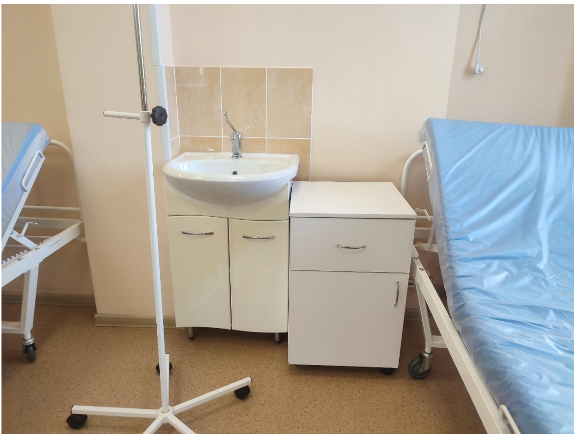
17. Фрагмент пом. 1-Н (62-65) в уровне 2-го этажа. Установлен керамический умывальник.
