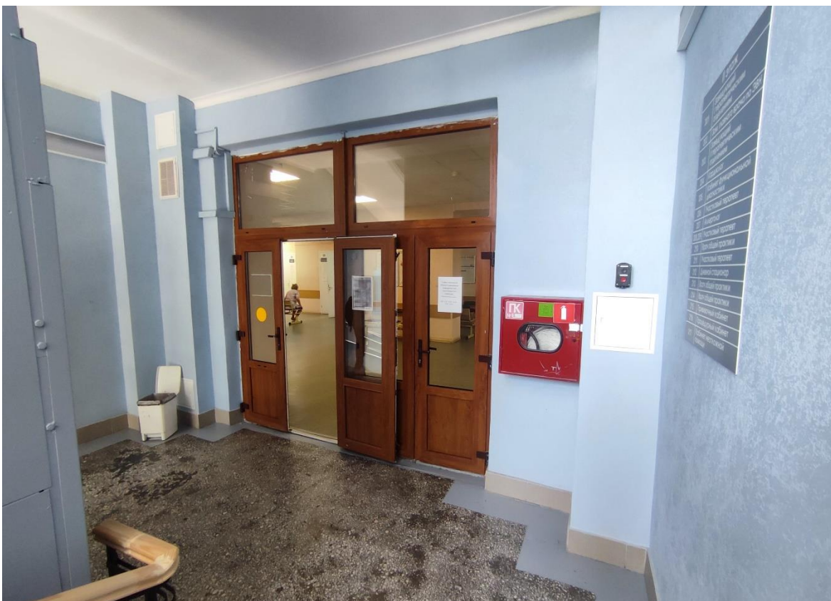
8. Общий вид площадки центральной трехмаршевой лестницы в уровне 2-го этажа.
