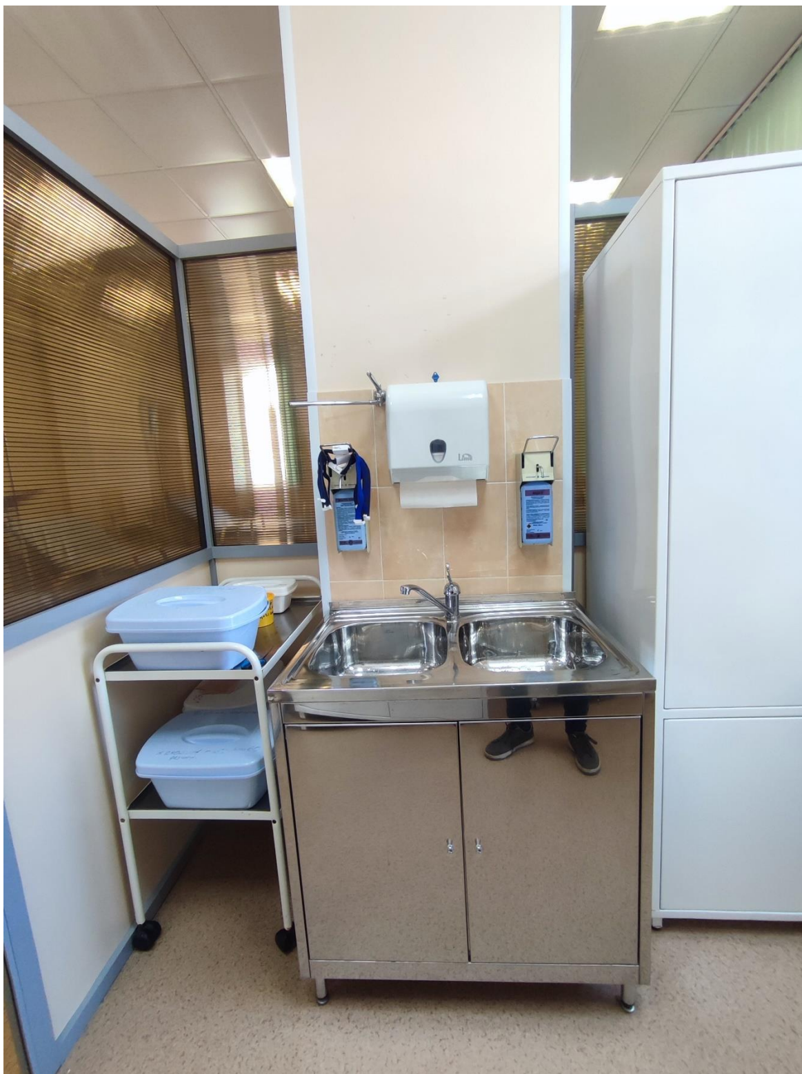
19. Фрагмент пом. 1-Н (62-65) в уровне 2-го этажа. В помещении для персонала установлена металлическая мойка.
