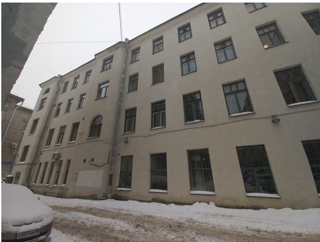
Фото 2. Дворовый (юго-восточный) фасад.
