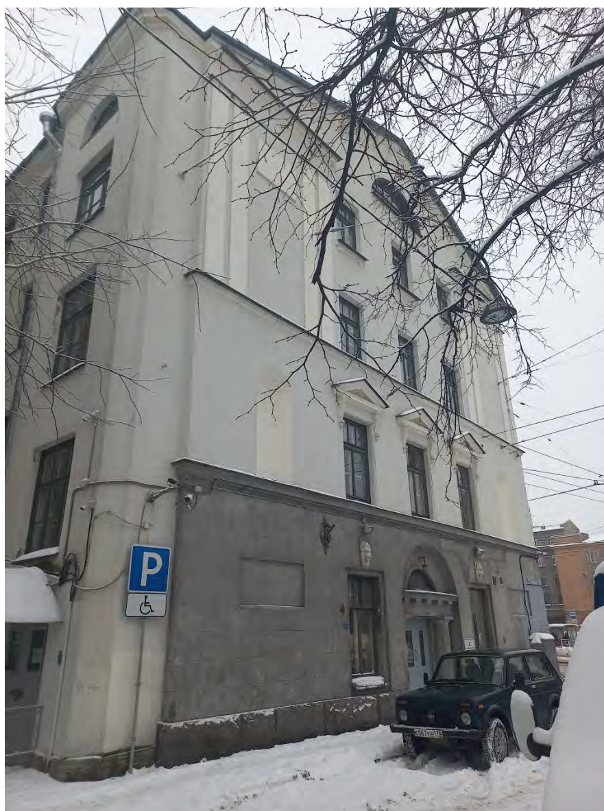
Фото 5. Торцевой (северо-восточный) фасад. Вид с ул. Подрезова.
