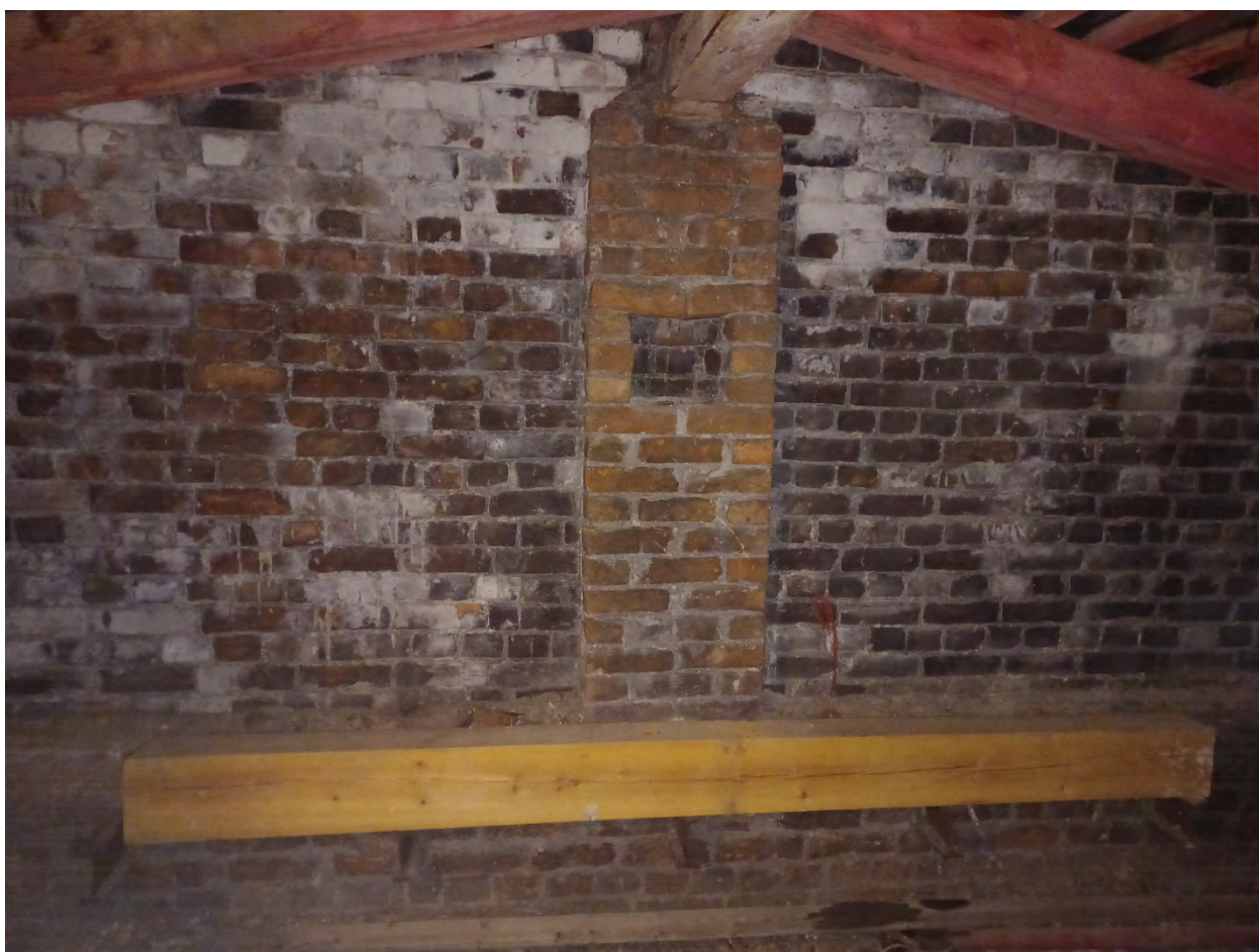
Фото 14. Помещение чердака. Щипец на металлических опорах.
