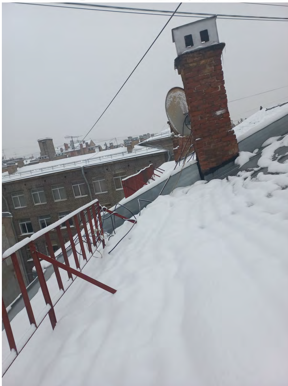
Фото 16. Кровля. Общий вид.
