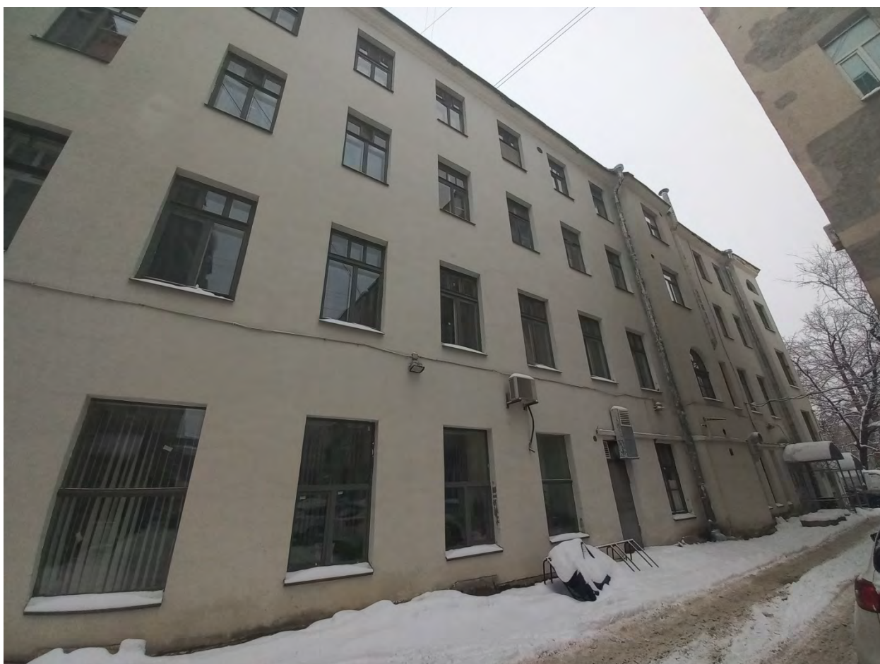
Фото 3. Дворовый (юго-восточный) фасад.
