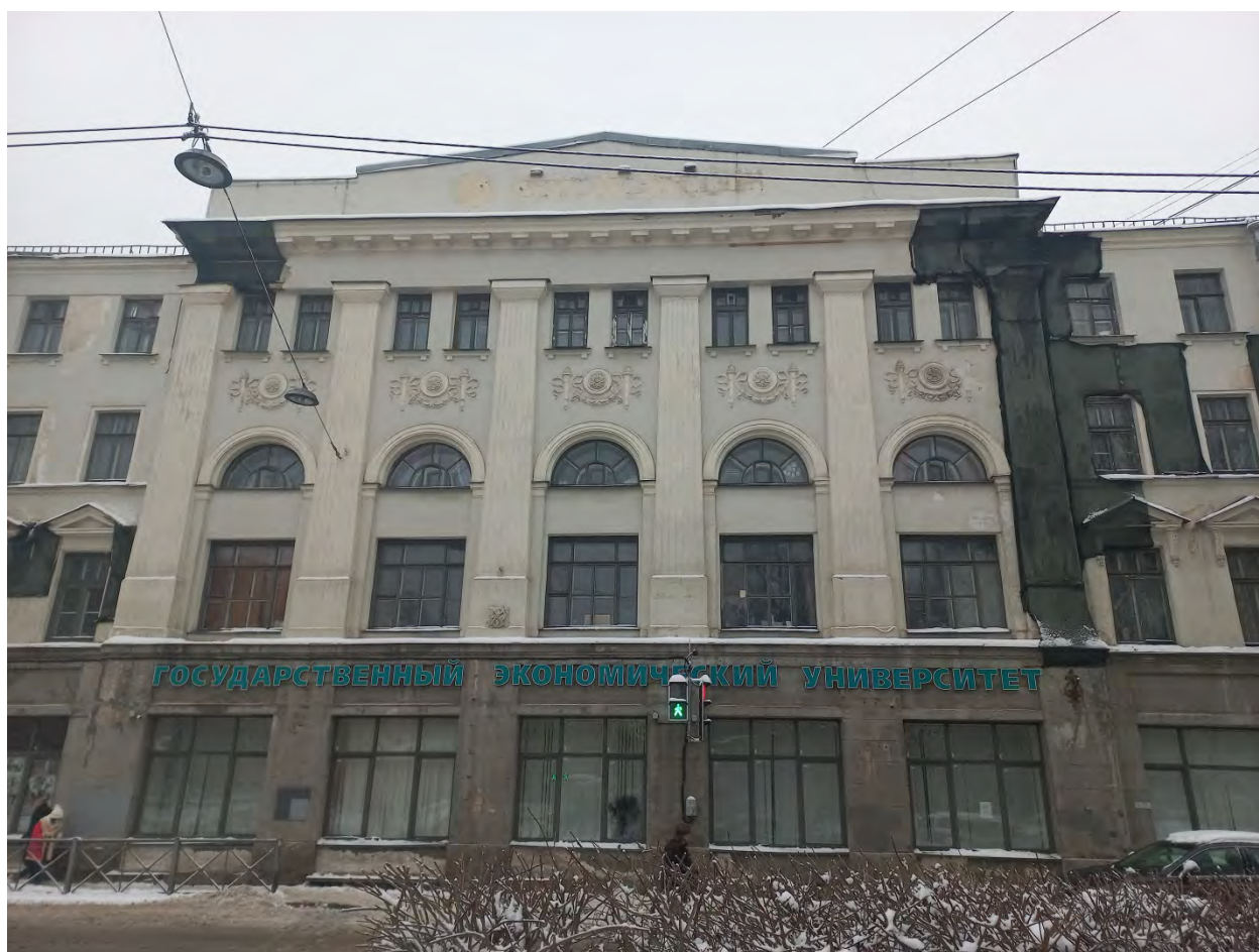
Фото 9. Главный (юго-западный) фасад. Центральный ризалит.
