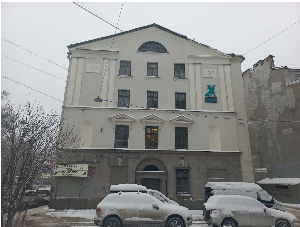
Фото 1. Торцевой (юго-западный) фасад. Вид с ул. Подковырова.
