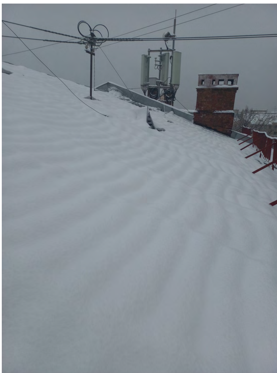
Фото 15. Кровля. Общий вид.
