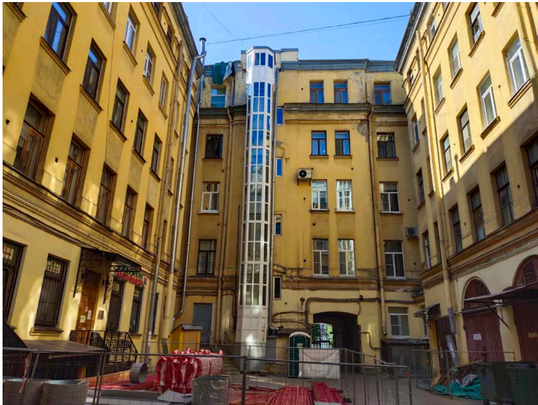
4. ОКН регионального значения «Дом Зайцевой Н.Н.» (г. Санкт-Петербург, Фурштатская ул., д. 20, Лит. А). Двор.
