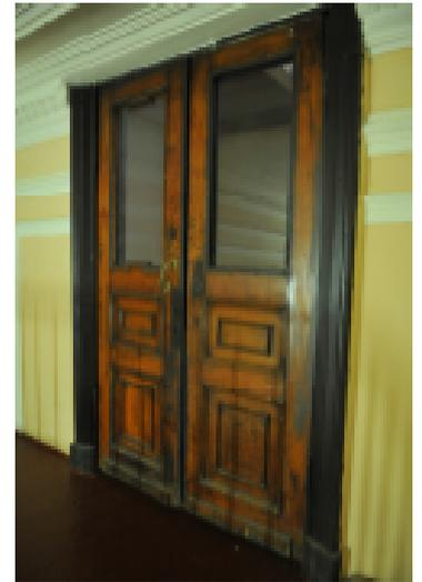
дверное заполнение тамбура лестницы Л1 – двустворчатое, каждая створка на три глубокие филленки; двучастная светлая фрамуга, с порезкой в виде дентикул, материал (дуб), профилированные наличники с ушками;
