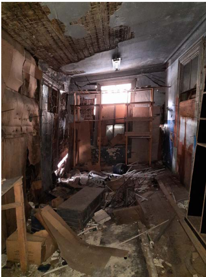
Фото 9. Интерьер здания объекта культурного наследия регионального значения «Удельное земледельческое училище (комплекс с территорией парком)».
