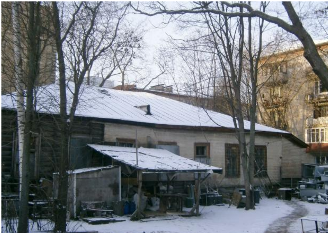
12. Бывший учебный корпус. 2014 г. — Клуб при больнице им. Скворцова-Степанова. Библиотека // Citywalls.ru – архитектурный сайт Петербурга [Электронный ресурс]. URL: https://www.citywalls.ru/house22763.html .
