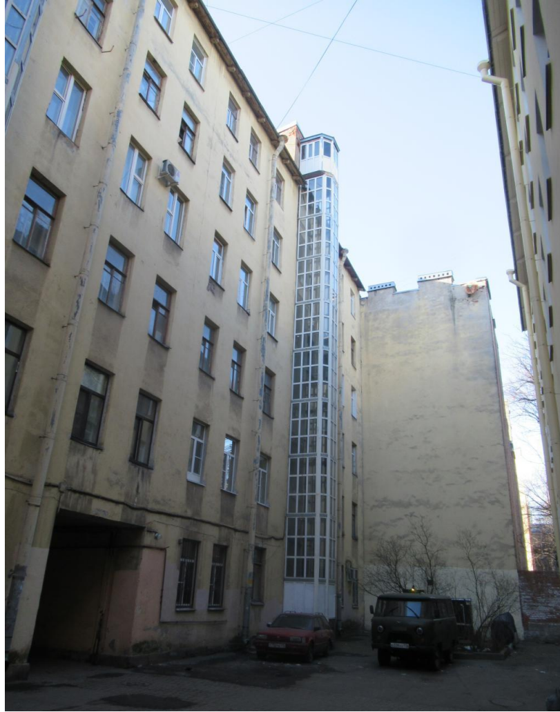
10. Фрагмент северо-восточного фасад дворового флигеля. Вид со стороны второго двора.
