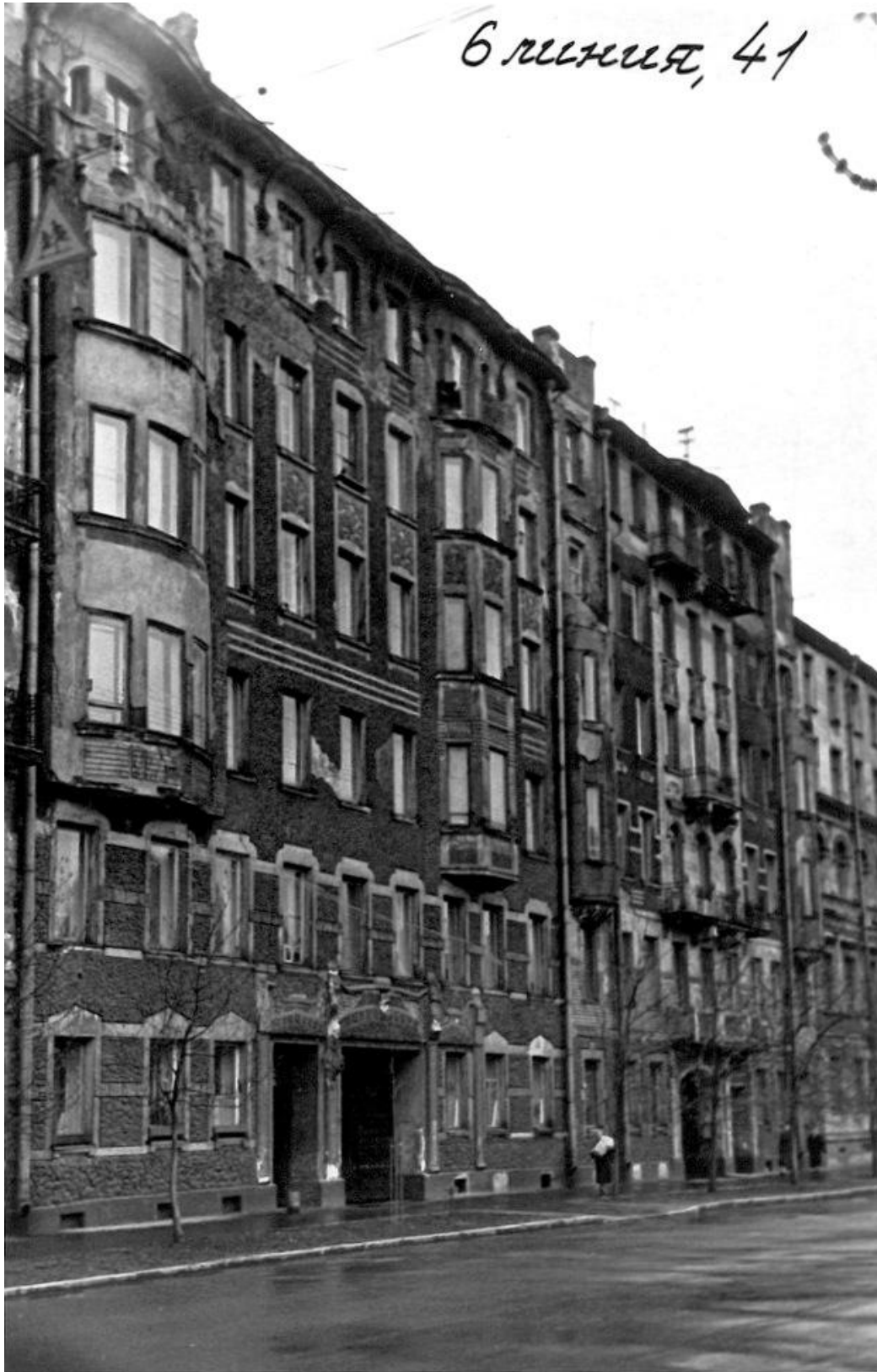
Илл. 22. Фасад здания по 6-й линии В.О., дом 41. Фото 1950-х гг. ЦГАКФФД СПб. 135538.
