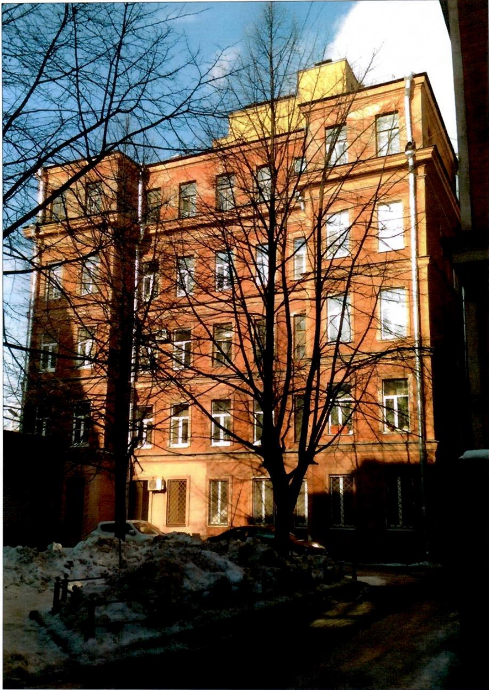
13. Лит. Б. Общий вид с юго-востока.
