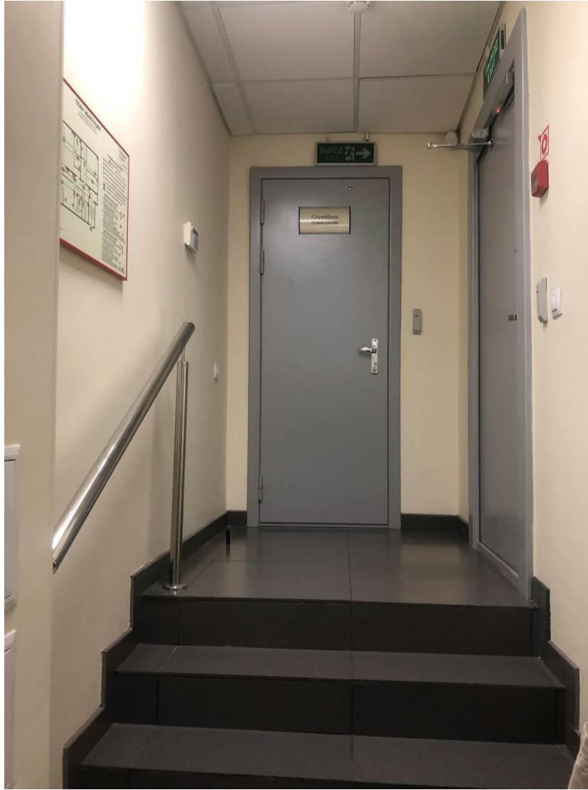
13. Объект культурного наследия регионального значения «Дом, где в 1917-1918гг. находилось центральное бюро петроградских профсоюзов», расположенный по адресу: г. Санкт-Петербург, ул. Фуриштатская, д. 40, лит. А, Б, В. Лицевой корпус (ул. Фуриштатская, д. 40, лит. А). Первый этаж. Помещение 22-Н. Внутренняя лестница.
