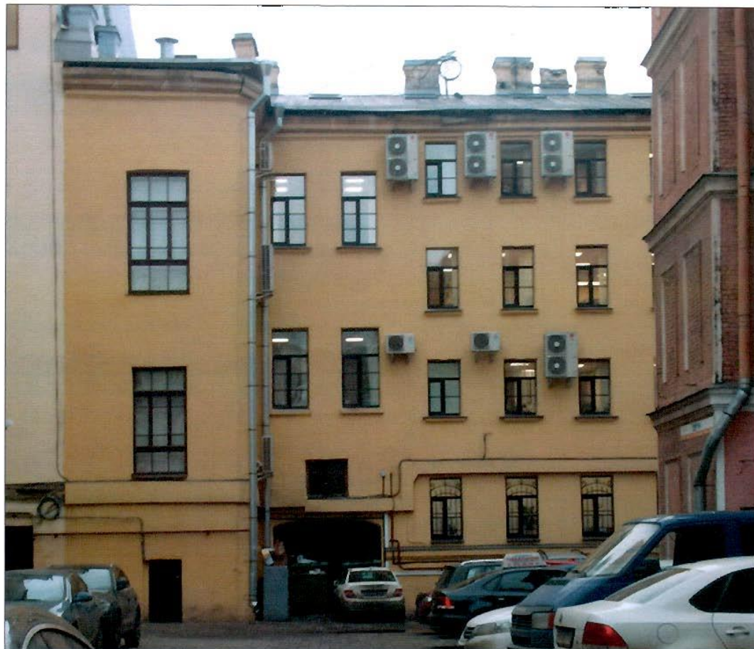
5. Лит. А. Дворовый фасад. Фрагмент.
