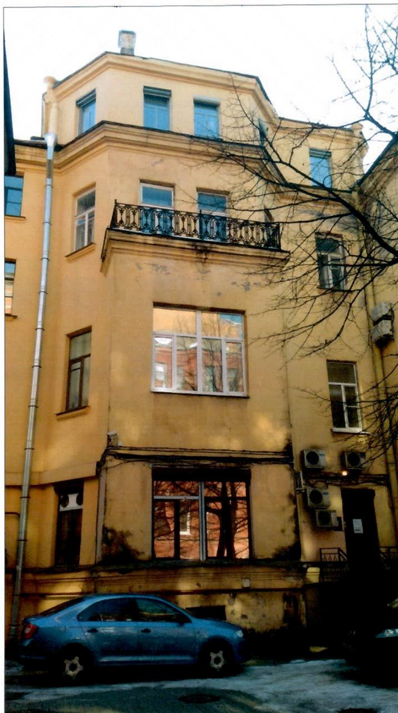
7. Лит. А. Ризалит дворового фасада.
