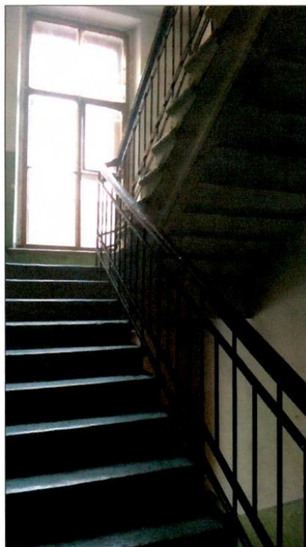
14. Лит. Б. Лестница в уровне третьего этажа.
