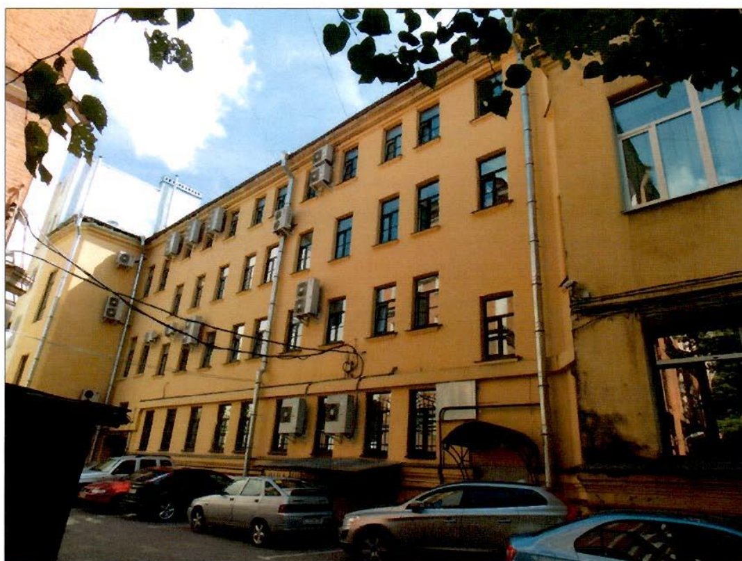
6. Лит. А. Дворовый фасад. Фрагмент.
