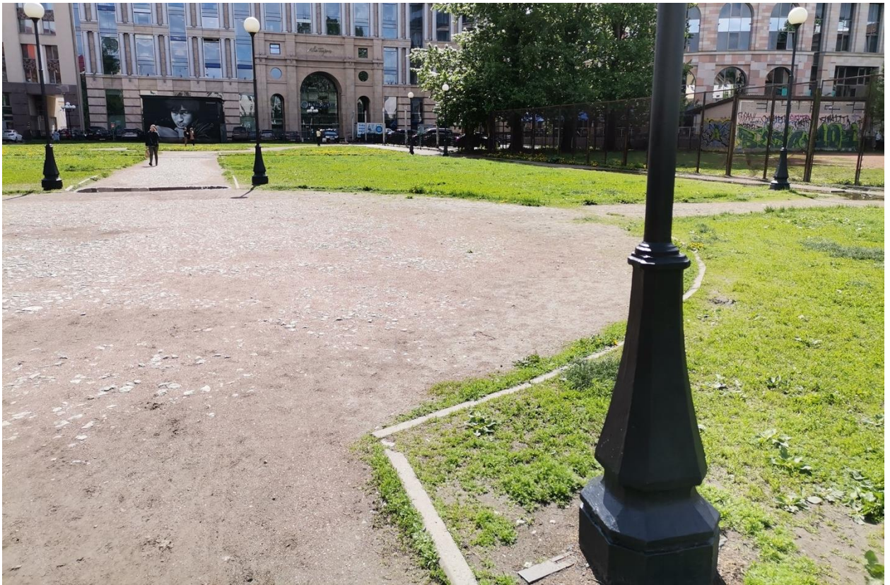
Фото 27. ОКН регионального значения «Павловский институт с территорией, садом и оградой» (ул. Восстания, дом 8 литер А). Западная часть сада. Набивные дорожки, участки газона. Вид с севера. Фрагмент. Съёмка 26.05.2021г.
