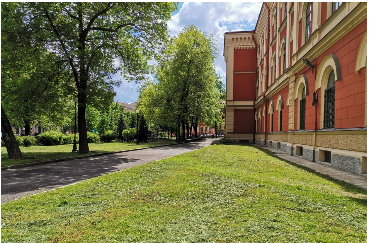
Фото 12. ОКН регионального значения «Павловский институт с территорией, садом и оградой» (ул. Восстания, дом 8 литер А). Лицевой восточный фасад здания, центральная часть сада (по ул. Восстания). Вид с северо-востока. Фрагмент. Съёмка 26.05.2021г.
