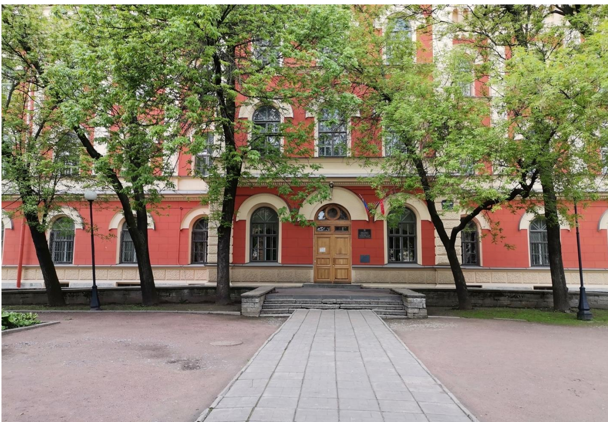
Фото 08. ОКН регионального значения «Павловский институт с территорией, садом и оградой» (ул. Восстания, дом 8 литера А). Посадка средневозрастных ясеней вдоль пандуса у главного входа в здание. Общий вид. Съёмка 26.05.2021г.
