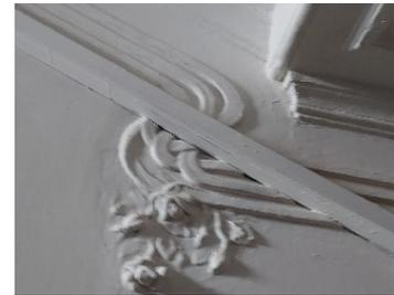
оформление потолков лестничных площадок: профилированные тяги по периметру; профилированный карниз в верхних частях стен;
