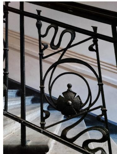
трехмаршевая лестница в юго-западной части здания (Л-1), на косоурах, с известняковыми ступенями и металлическим ограждением с деревянными профилированным поручнями;
