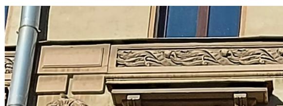
аттиковая стенка над угловой частью здания – с опорными тумбами и профилированным карнизом, боковые части с полуциркульным завершением;
