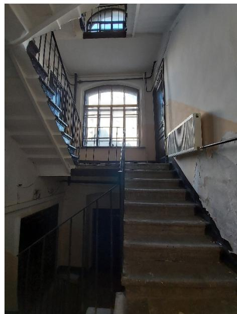
двухмаршевая межэтажная лестница с северо-восточной части здания (Л-2), на косоурах, с известняковыми ступенями и ограждением кованого железа (рисунок - горизонтальные тяги, вертикальные стойки с набалдашниками и перехватами, волютообразные завитки) и деревянными профилированными поручнями;
