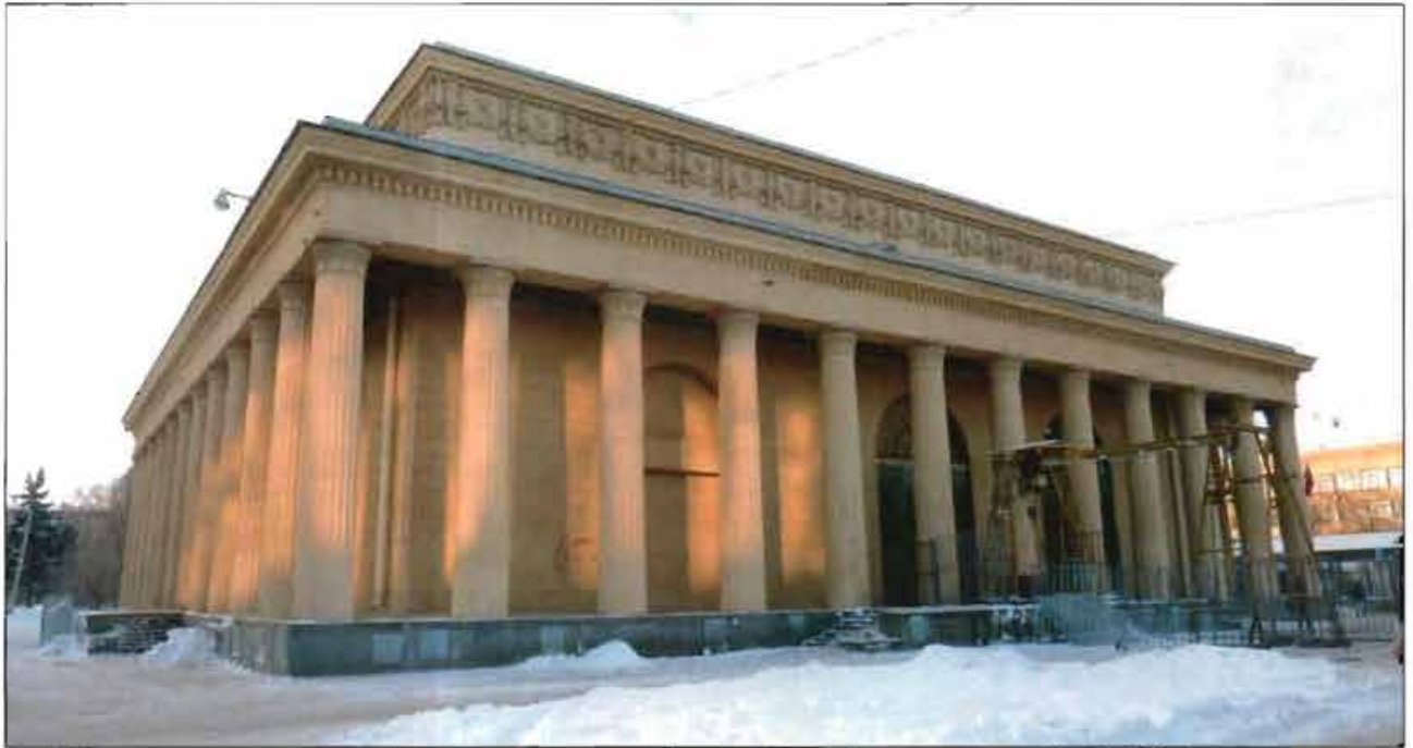
4. Объект культурного наследия. Северный фасад. Фотофиксация от 10.12.2021.
