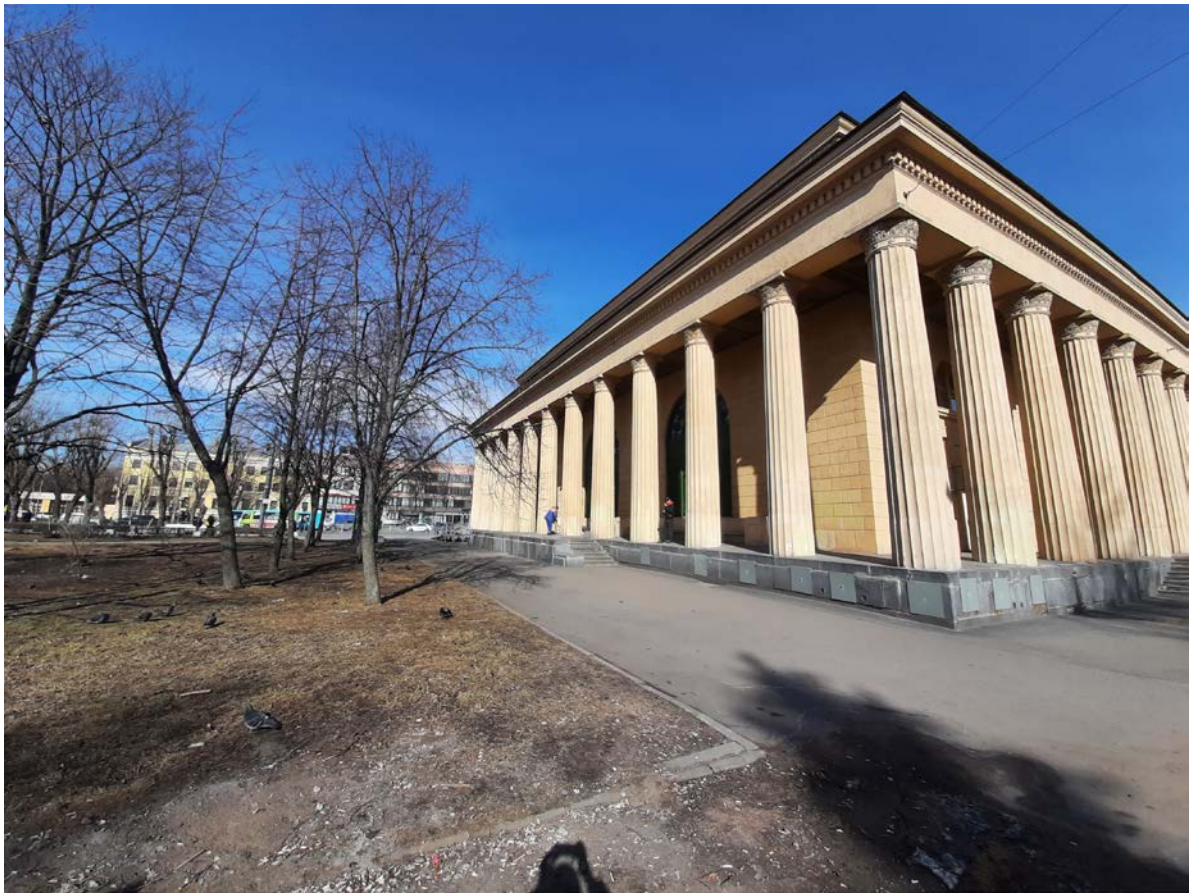
Фото 3 Боковой фасад объекта культурного наследия регионального значения «Станция метро «Кировский завод», г. Санкт-Петербург, пр. Стачек, д. 70, литера А.
