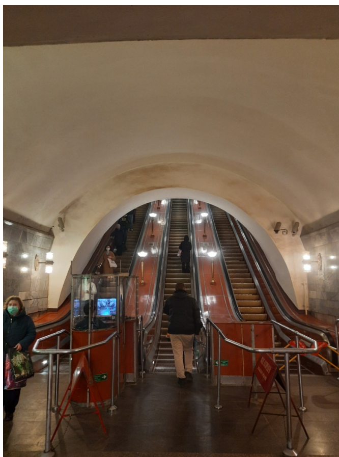
Фото 18 Фрагмент интерьера объекта культурного наследия регионального значения «Станция метро «Кировский завод», г. Санкт-Петербург, пр. Стачек, д. 70, литера А. (наклонный ход)
