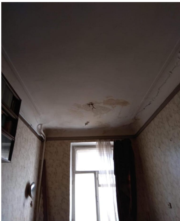
Фото 11. Помещение 2 (комната). Общий вид от двери.
