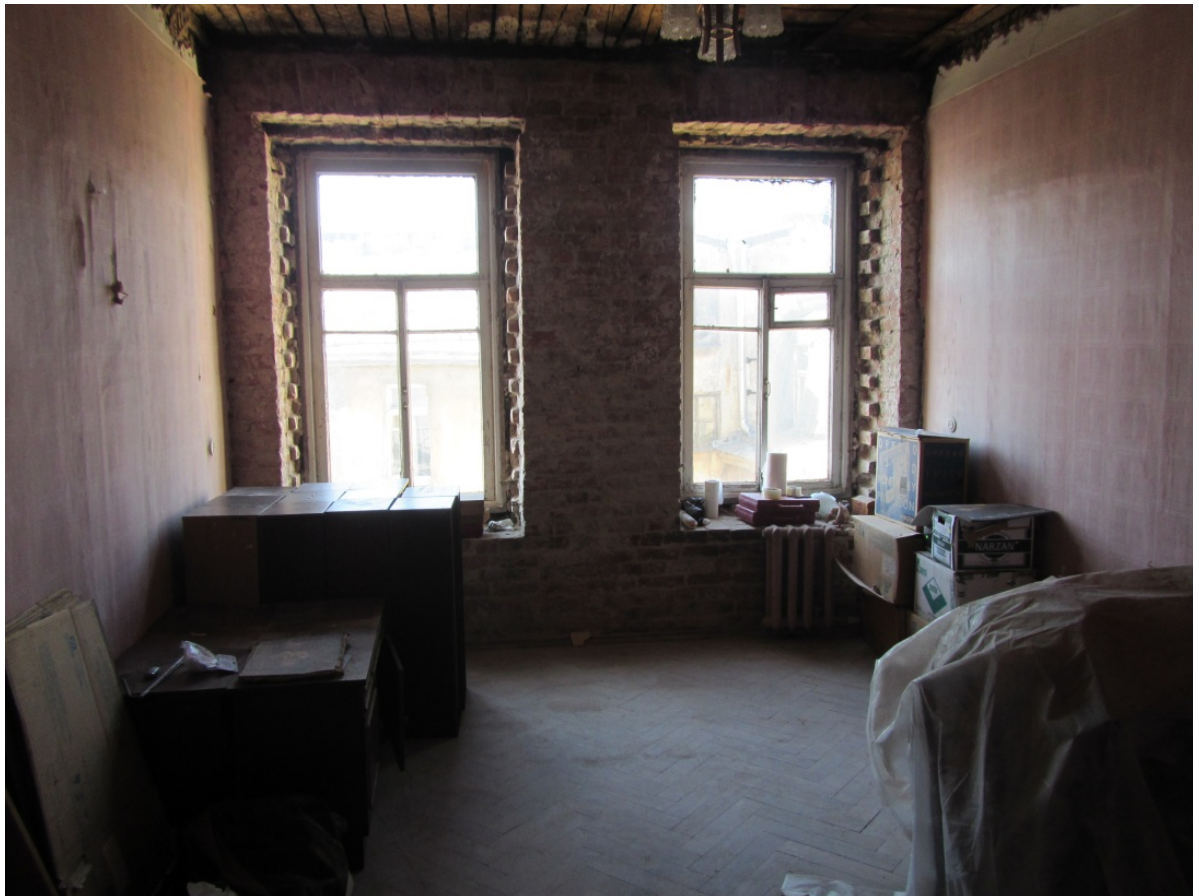
Фото 6. Помещение 5 (комната). Общий вид от двери
