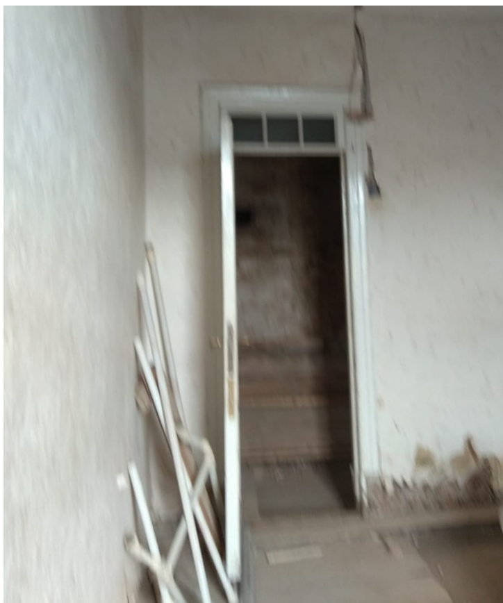
Фото 9. Помещение 4 (комната). Общий вид от окна.
