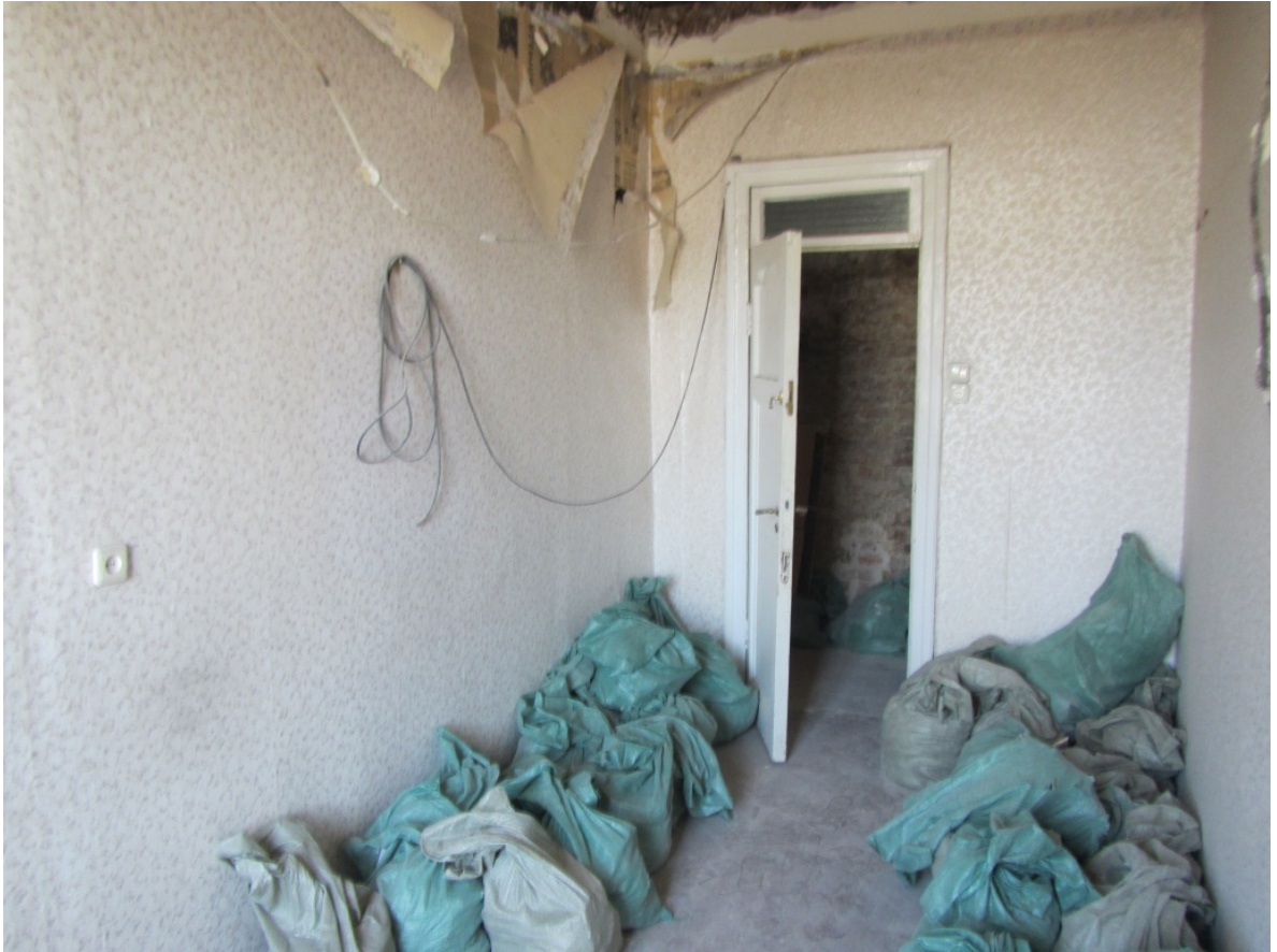
Фото 5. Помещение 6 (комната). Общий вид от окна.
