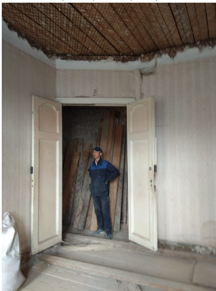
Фото 10. Помещение 3 (комната). Общий вид от окна.
