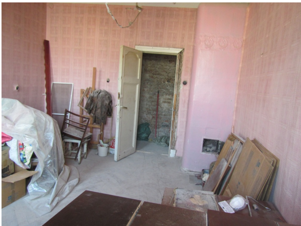
Фото 7. Помещение 5 (комната). Общий вид от окна.
