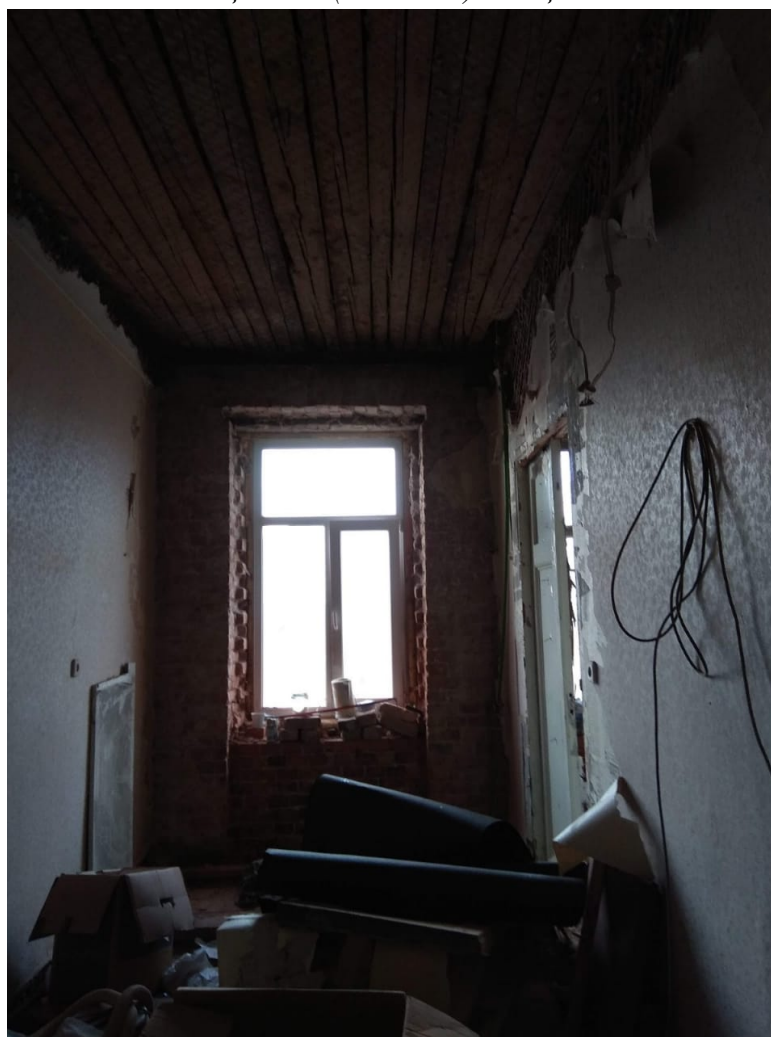
Фото 8. Помещение 4 (комната). Общий вид от двери.
