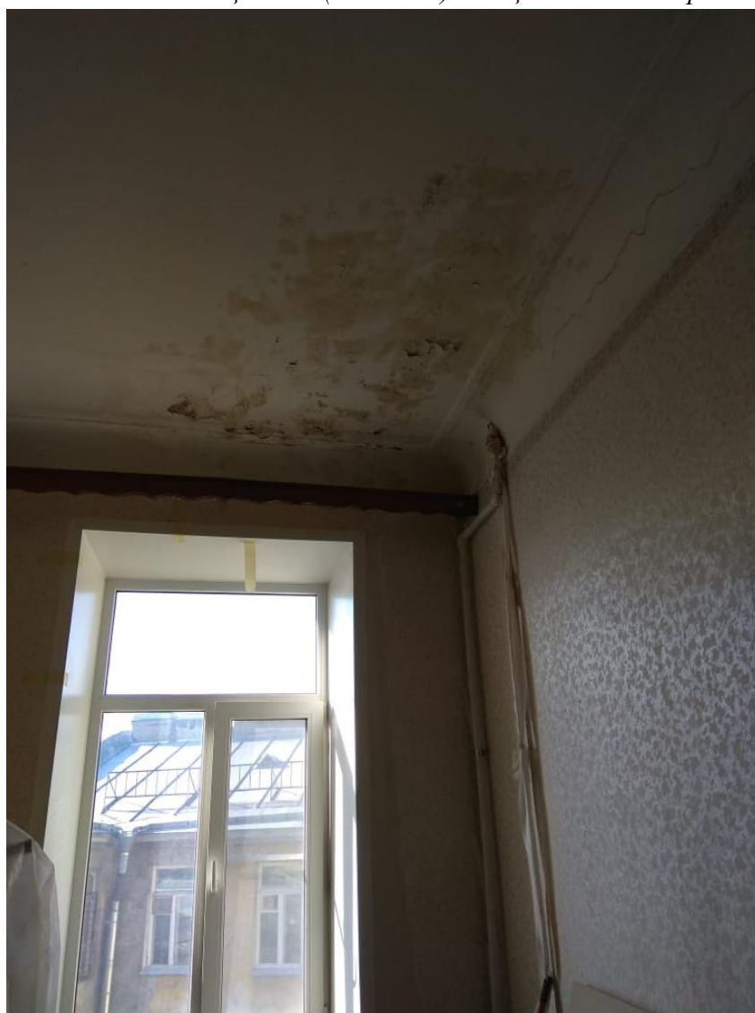
Фото 4. Помещение 6 (комната). Общий вид от двери.
