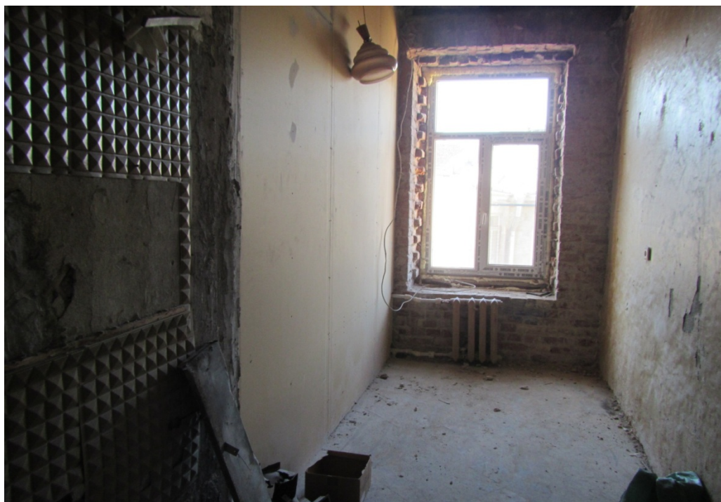
Фото 3. Помещение 7 (кладовая). Общий вид от двери.
