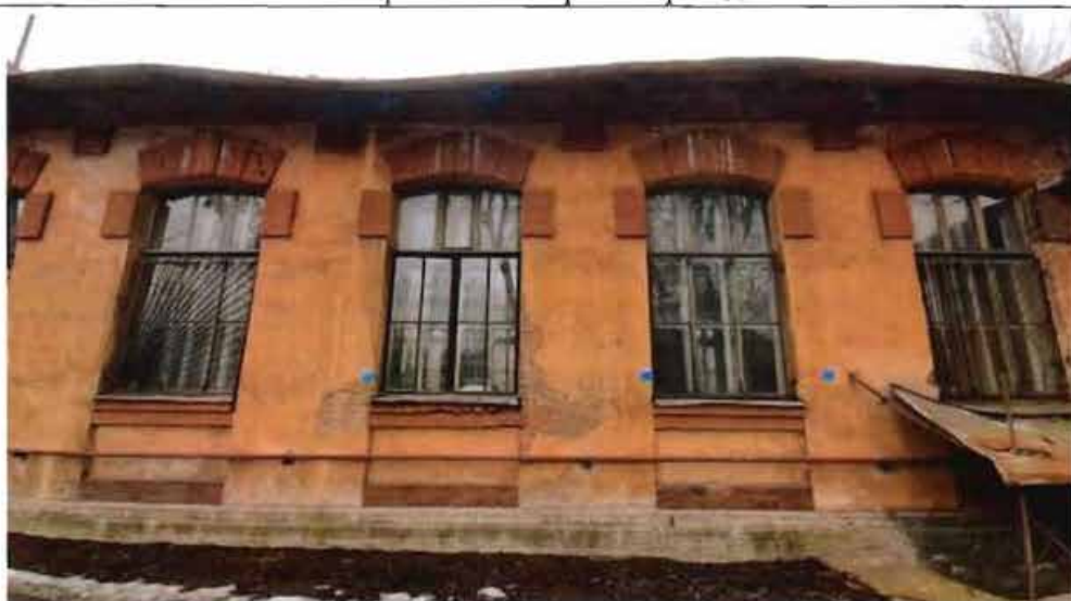
5. Фрагмент северного фасада
