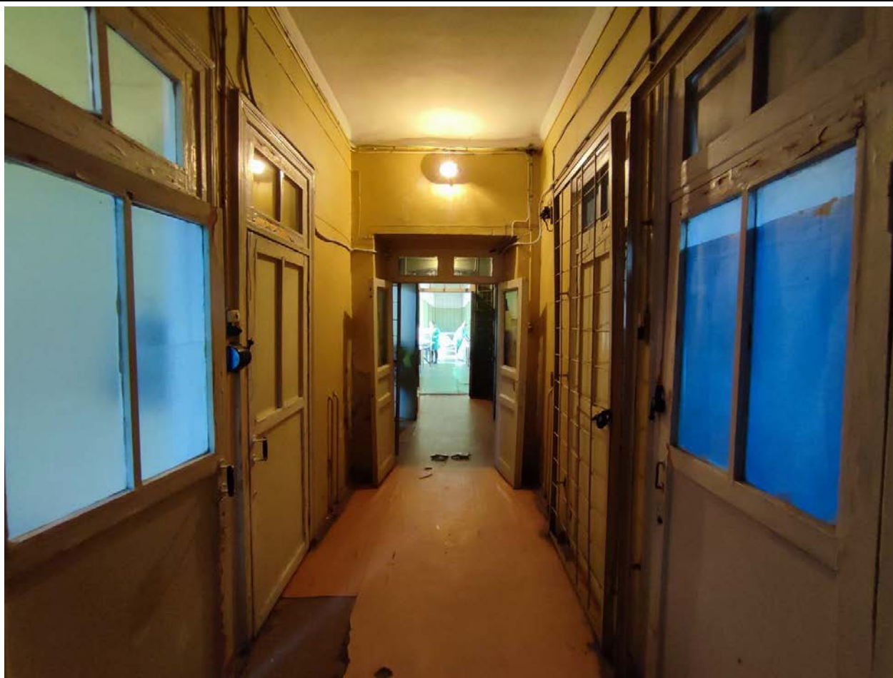
5. Общий вид помещения 2-Н (10) в уровне 1-го этажа.
