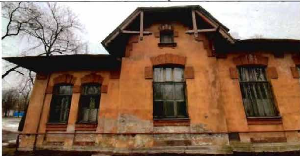
3. Фрагмент северного фасада
