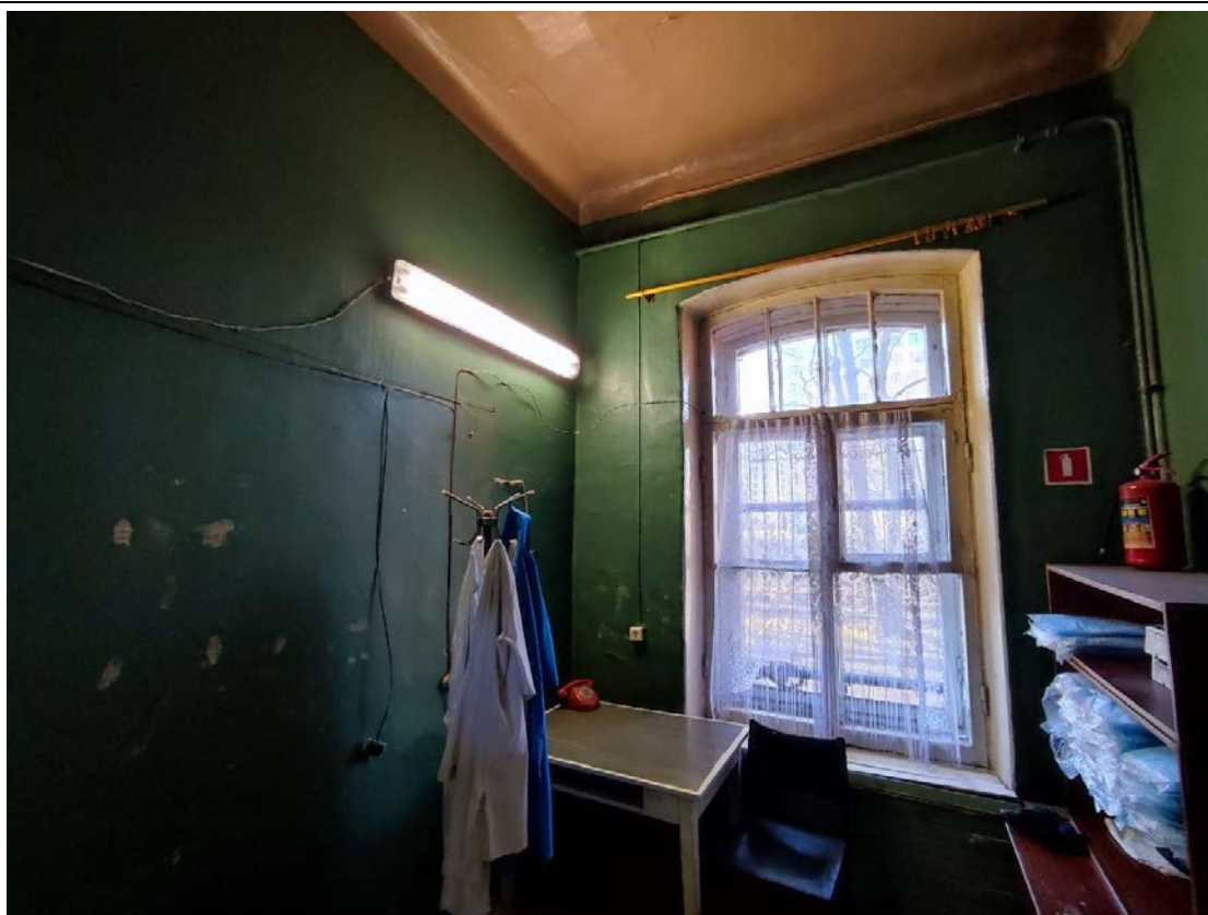
14. Общий вид помещения 2-Н (17) в уровне 1-го этажа.
