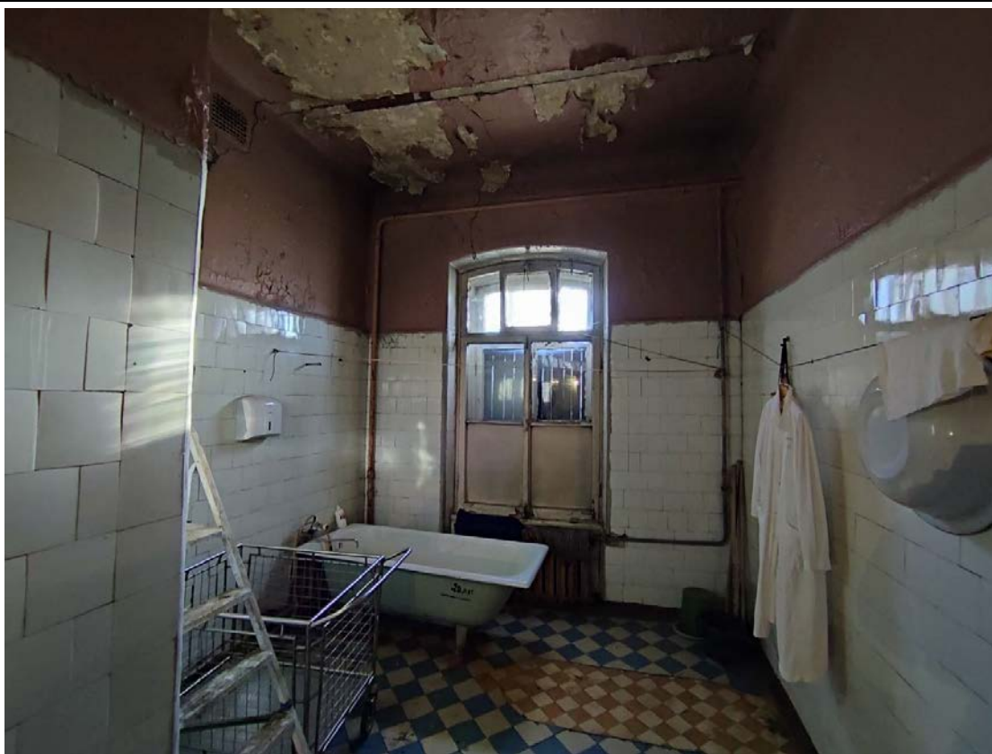
19. Общий вид помещения 2-Н (12) в уровне 1-го этажа.
