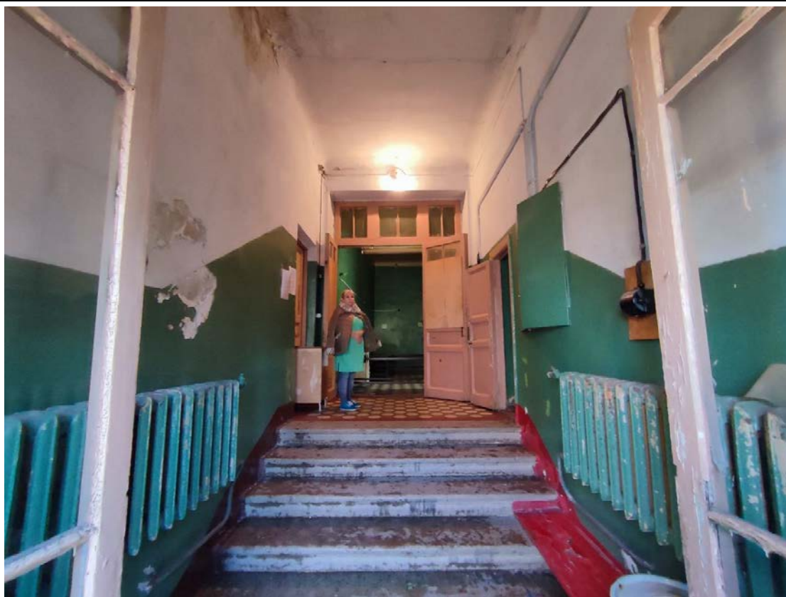
13. Общий вид помещения 2-Н (2) в уровне 1-го этажа.
