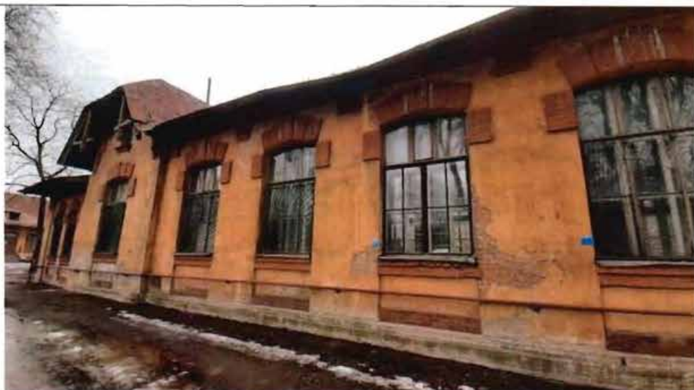
4. Фрагмент северного фасада
