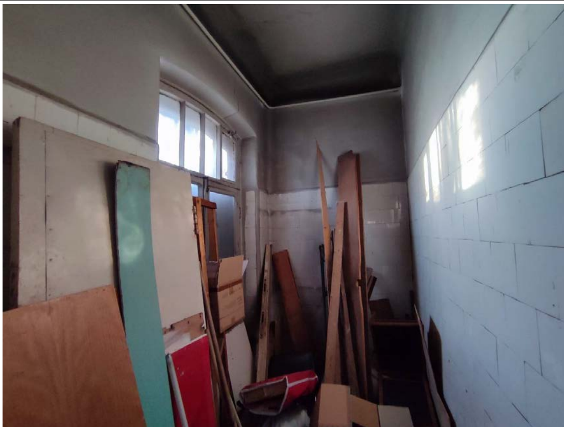
16. Общий вид помещения 2-Н (16) в уровне 1-го этажа.
