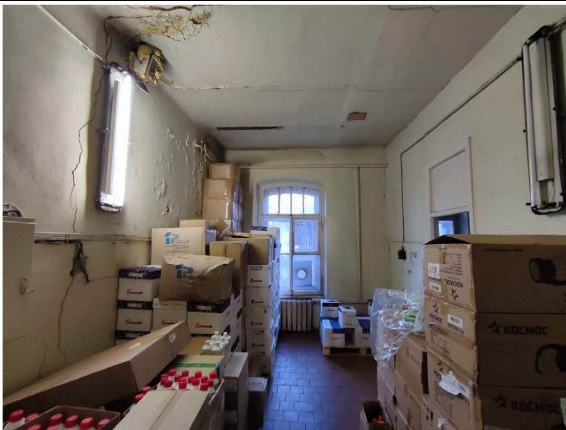
14. Общий вид помещения 1-Н (4) в уровне 1-го этажа.
