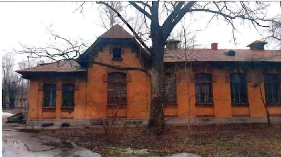
3. Фрагмент южного фасада
