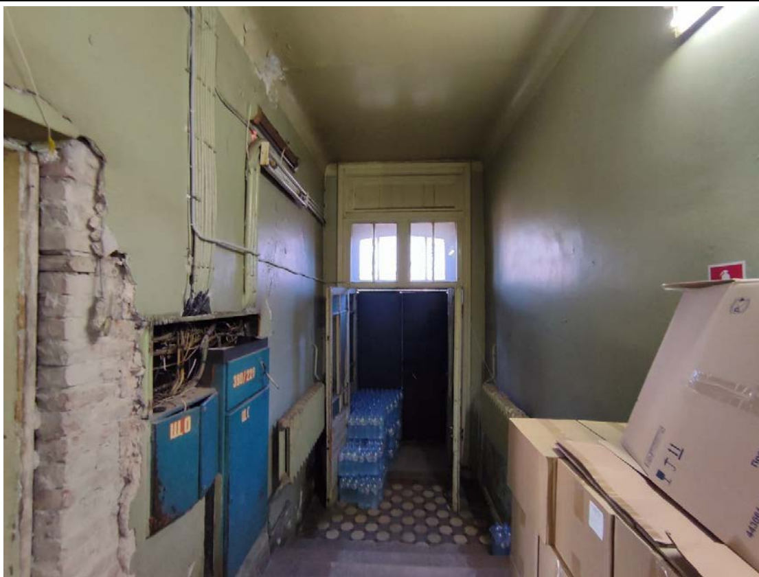
18. Общий вид помещения 1-Н (1, 2) в уровне 1-го этажа.
