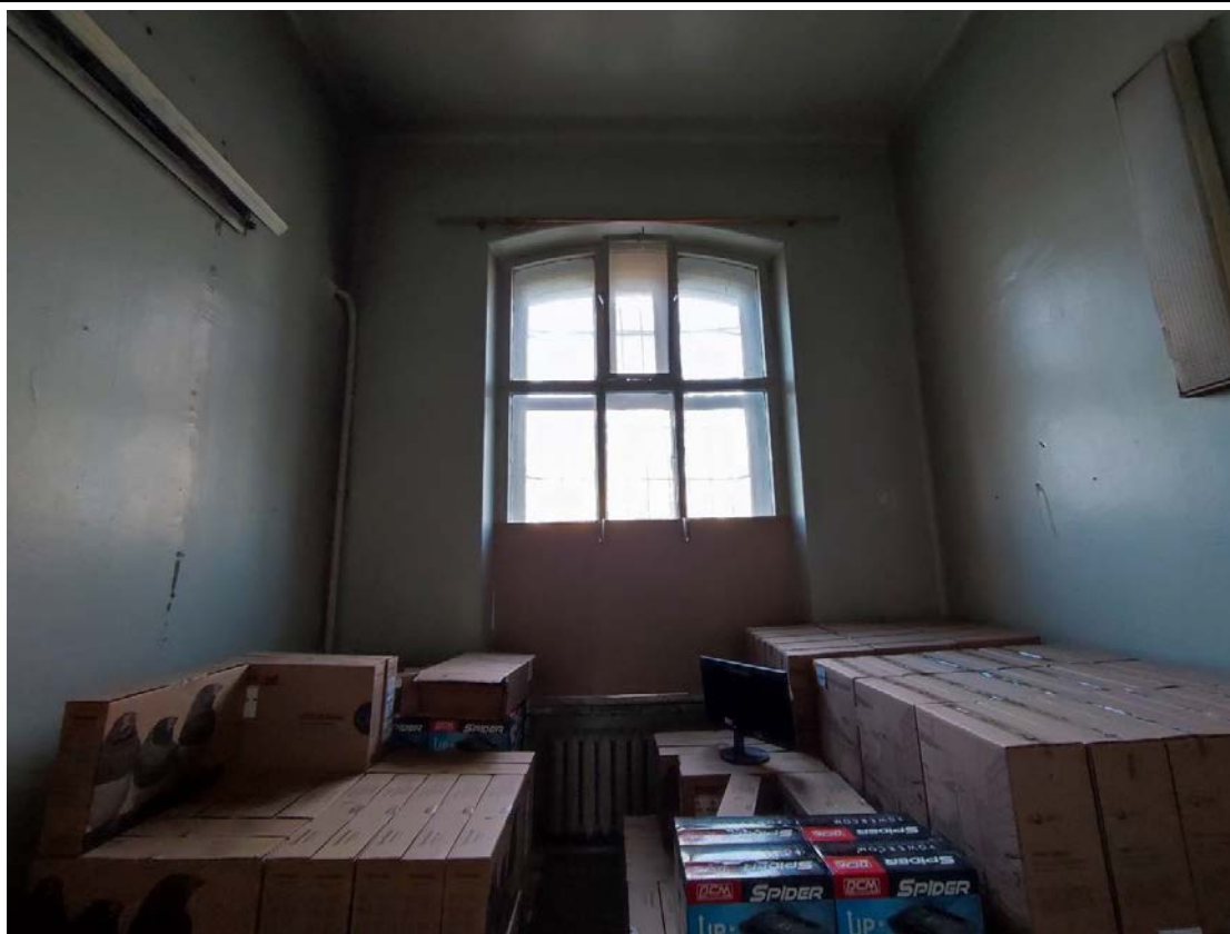
26. Общий вид помещения 1-Н (22) в уровне 1-го этажа.
