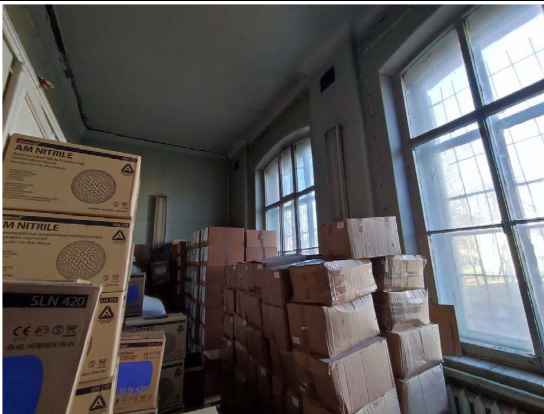
24. Общий вид помещения 1-Н (25) в уровне 1-го этажа.
