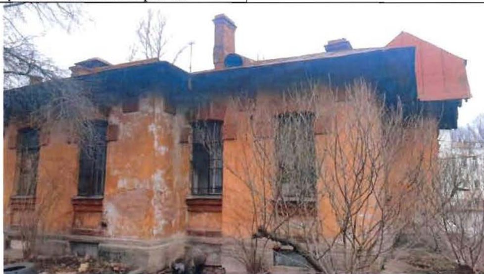
6. Фрагмент южного фасада
