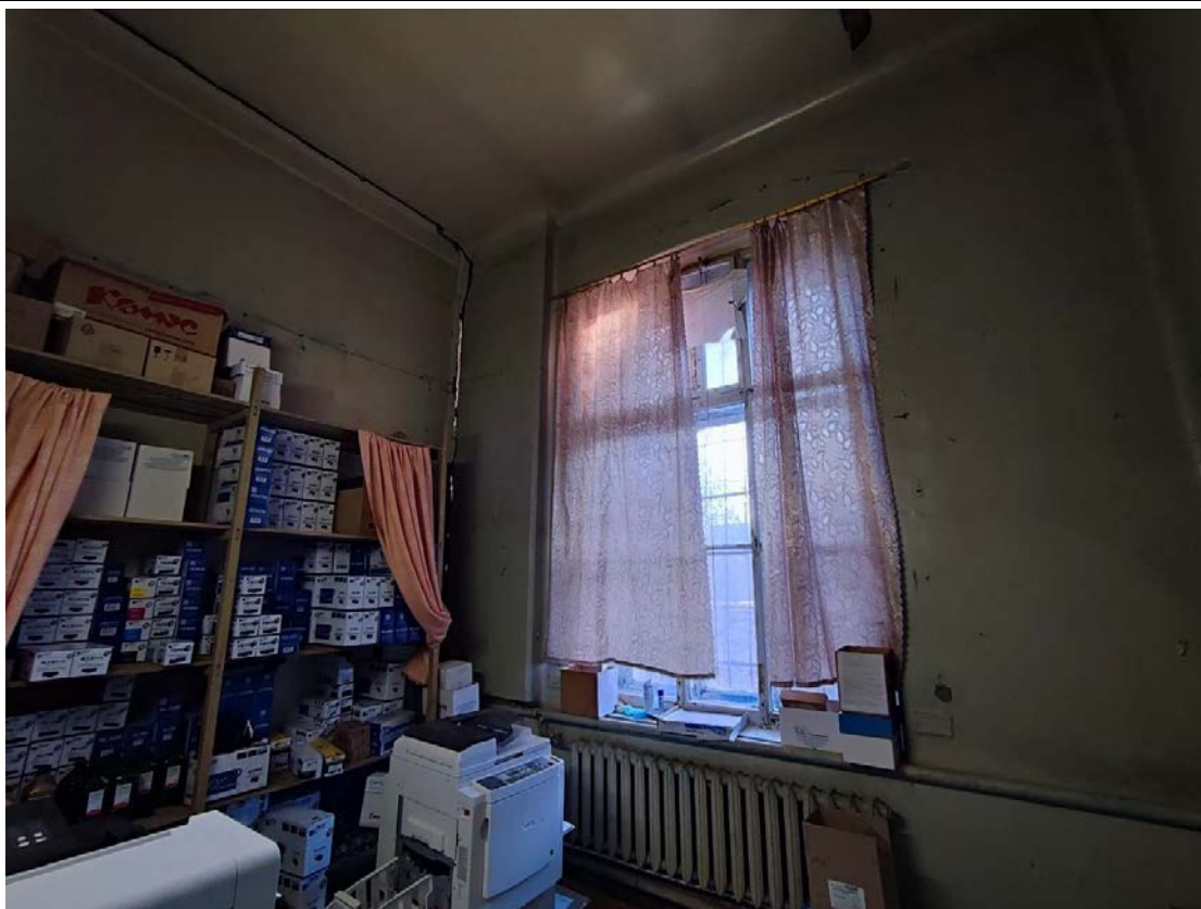
11. Общий вид помещения 1-Н (14) в уровне 1-го этажа.
