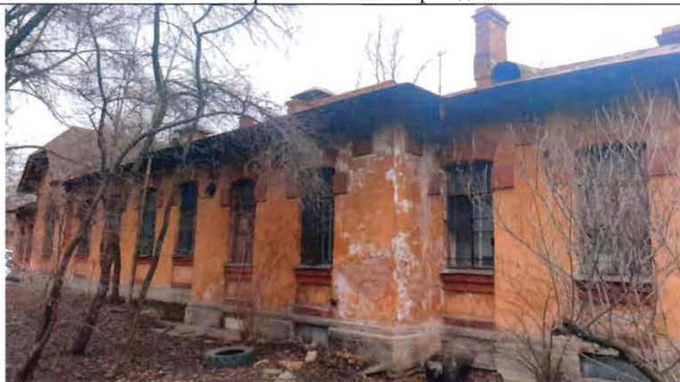
7. Фрагмент южного фасада
