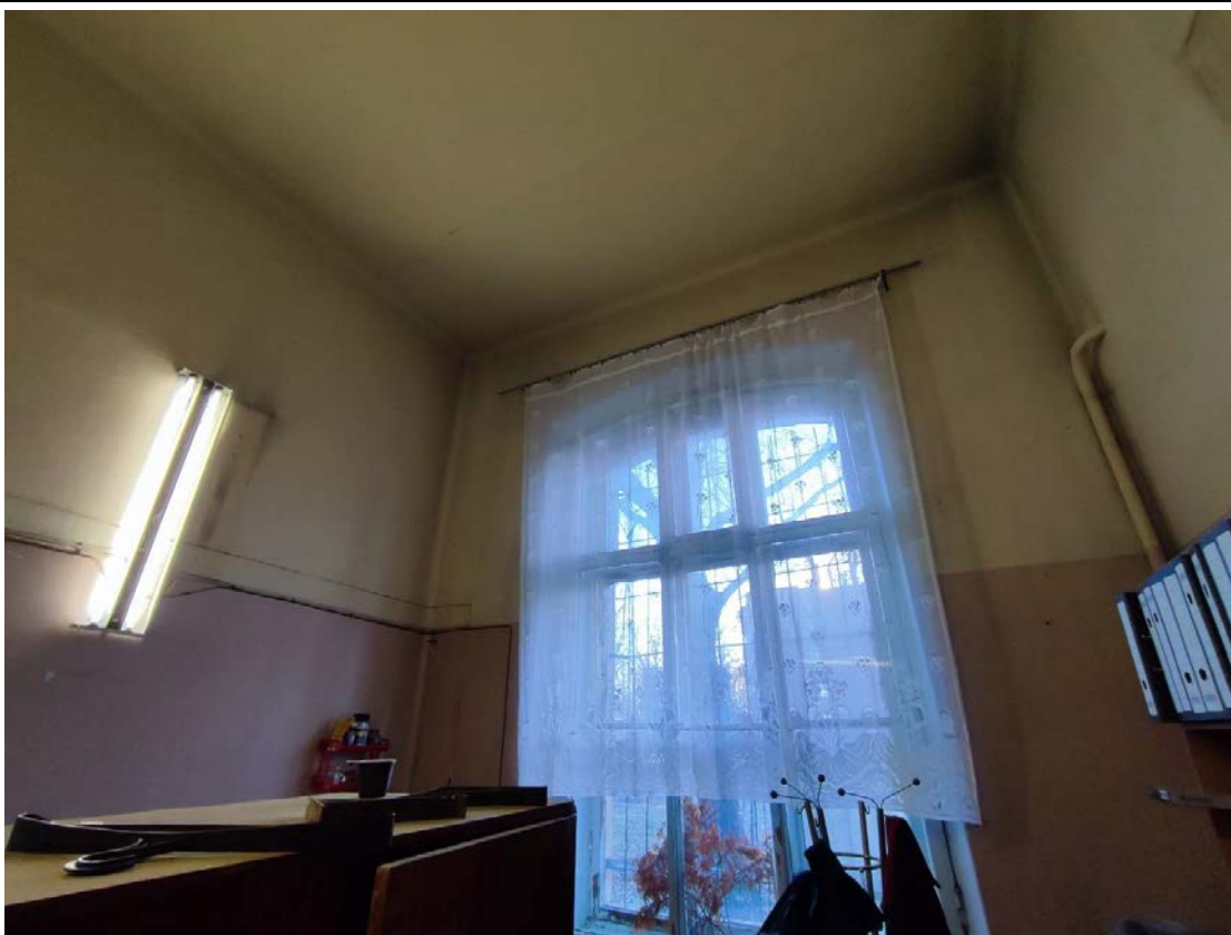
10. Общий вид помещения 1-Н (15) в уровне 1-го этажа.
