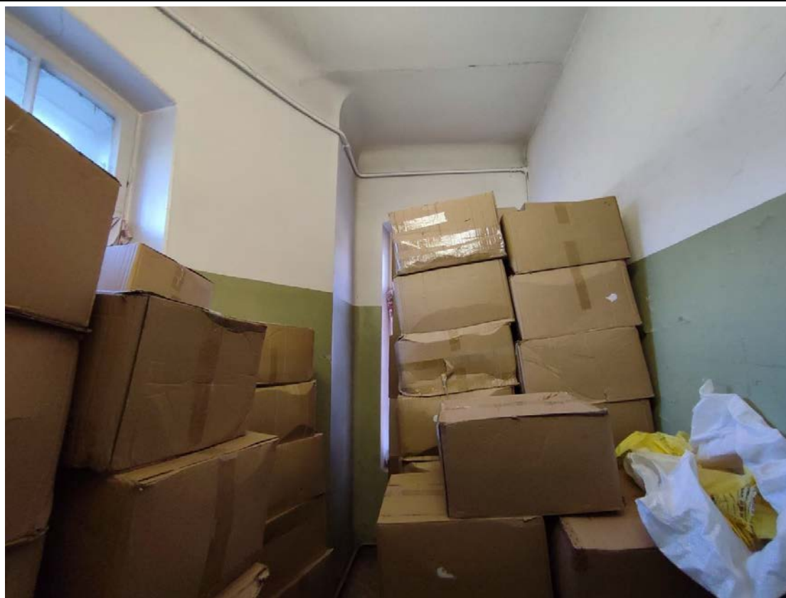
28. Общий вид помещения 1-Н (20) в уровне 1-го этажа.
