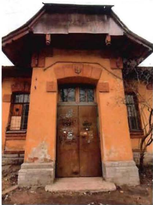
4. Фрагмент восточного фасада
