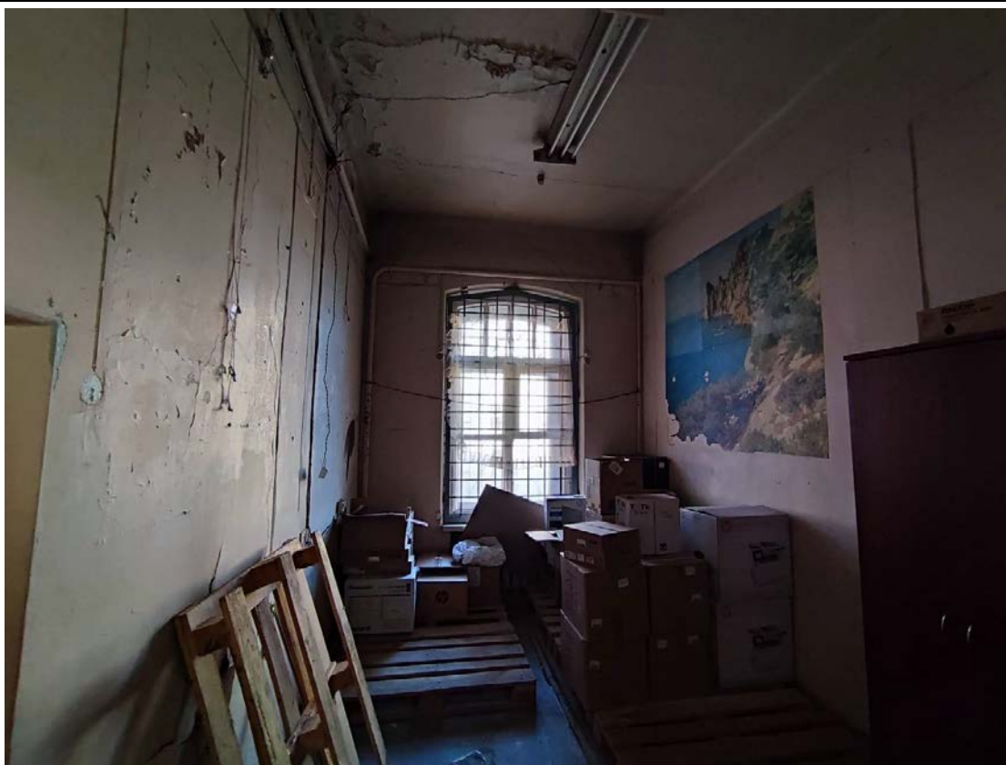
22. Общий вид помещения 1-Н (27) в уровне 1-го этажа.
