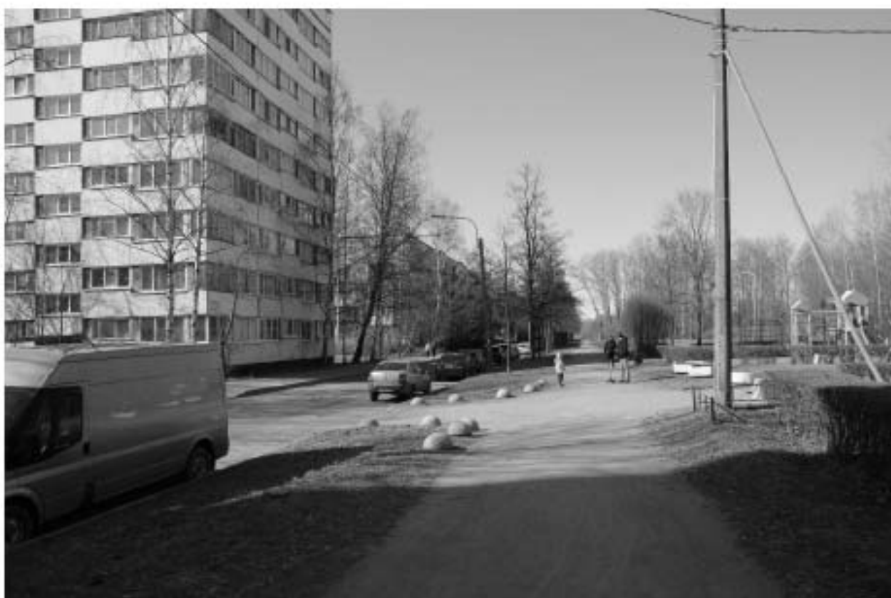
4. Объект проектирования по адресу: Козлова ул., 19, корпус 1. Вид с юго-востока
