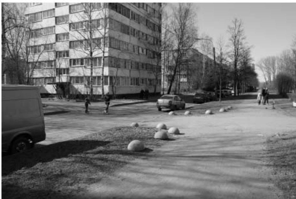
5. Объект проектирования по адресу: Козлова ул., 19, корпус 1. Вид с юго-востока.
