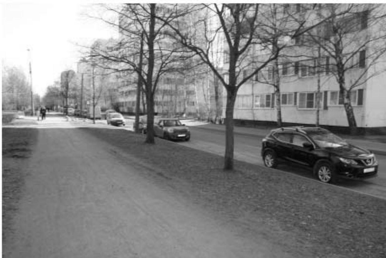
1. Объект проектирования по адресу: Козлова ул., 19, корпус 1. Общий вид с севера.
