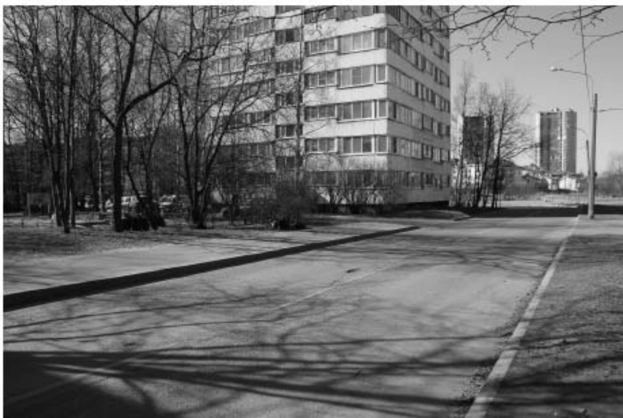
7. Объект проектирования по адресу: Козлова ул., 13, корпус 1. Вид с юго-востока.
