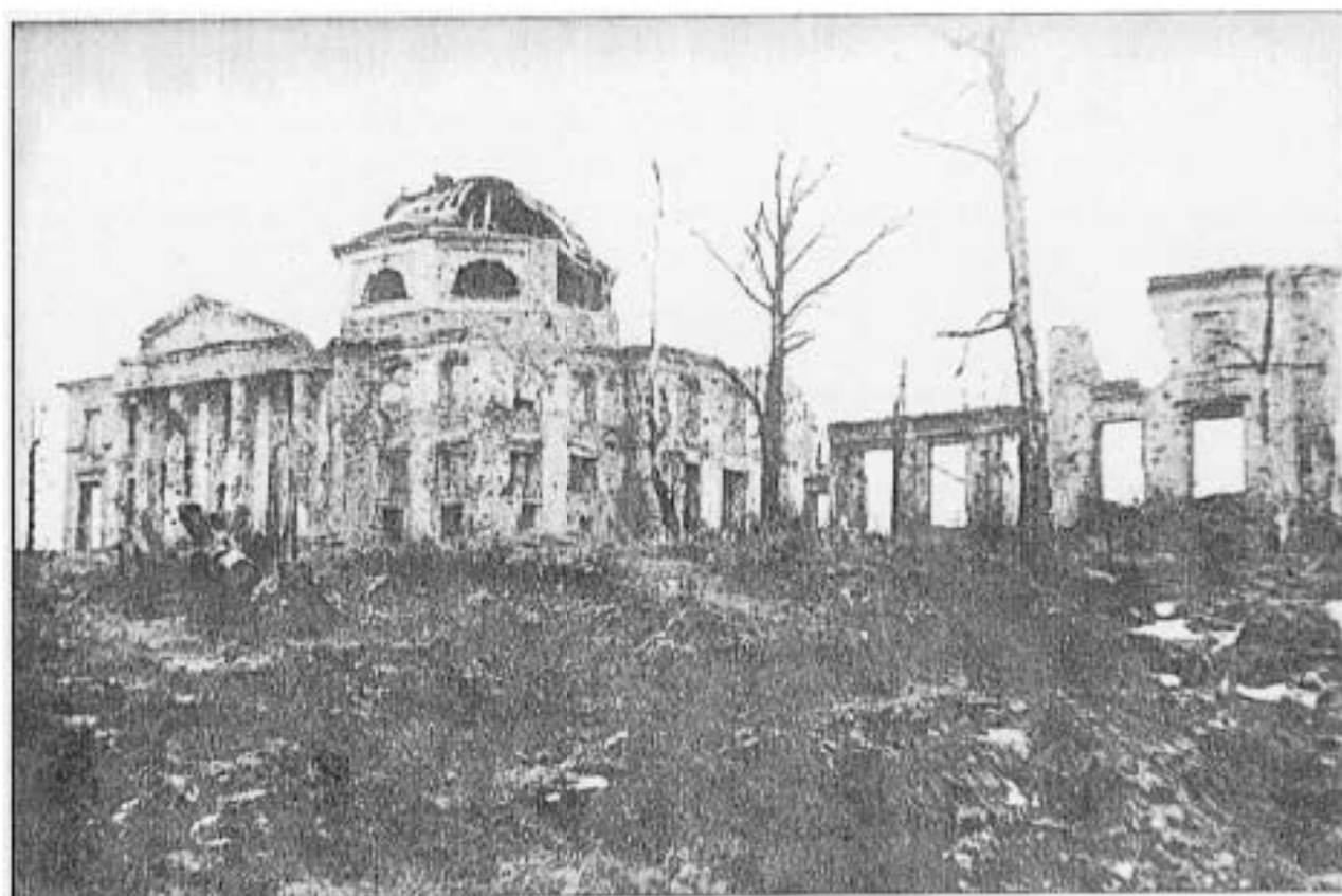
Ил. 28. Разрушенный усадебный дом с флигелями. Вид с северо-запада. 1944 г. Фото ТАСС. КГИОП.
