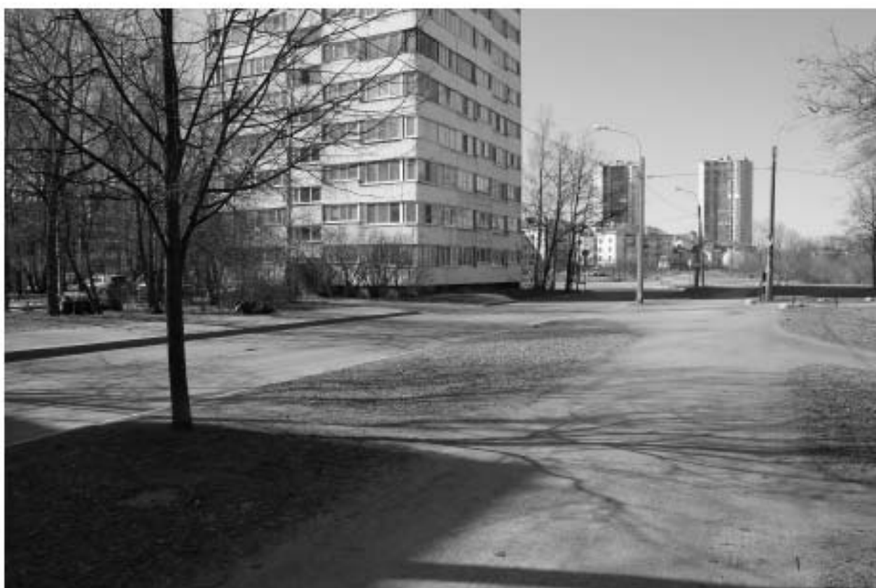
8. Объект проектирования по адресу: Козлова ул., 13, корпус 1. Вид с юго-востока.
