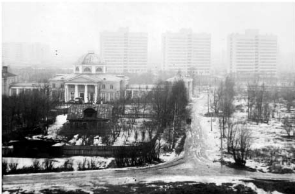
Ил. 31. Усадебный дом усадьбы Александрина и общежития Ленинградского кораблестроительного института. Фото около 1980 года. Из личного архива С. Б. Горбатенко.
