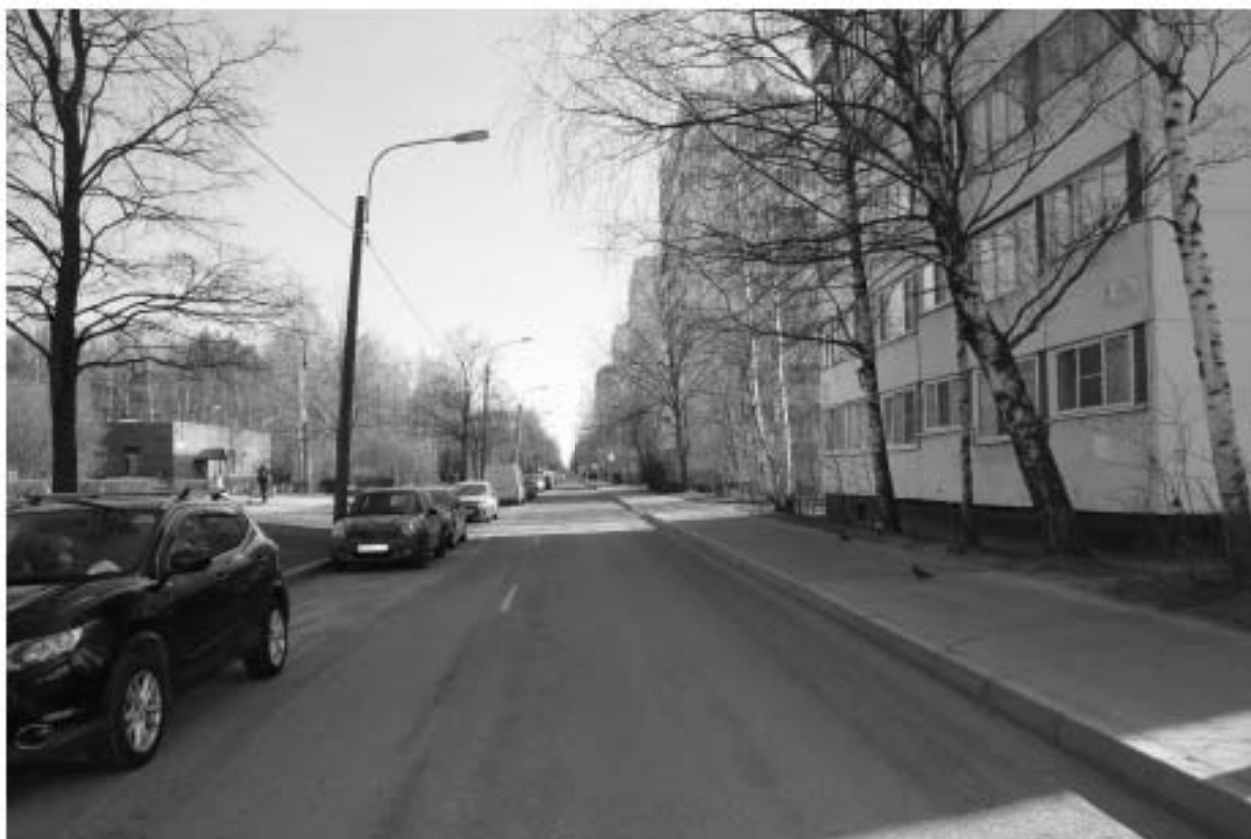
8. Объект проектирования по адресу: Козлова ул., 19, корпус 1. Вид с севера.
