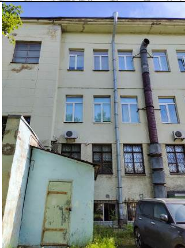
Фото 11. Выявленный ОКН «Здание школы». Фрагмент западного фасада.
