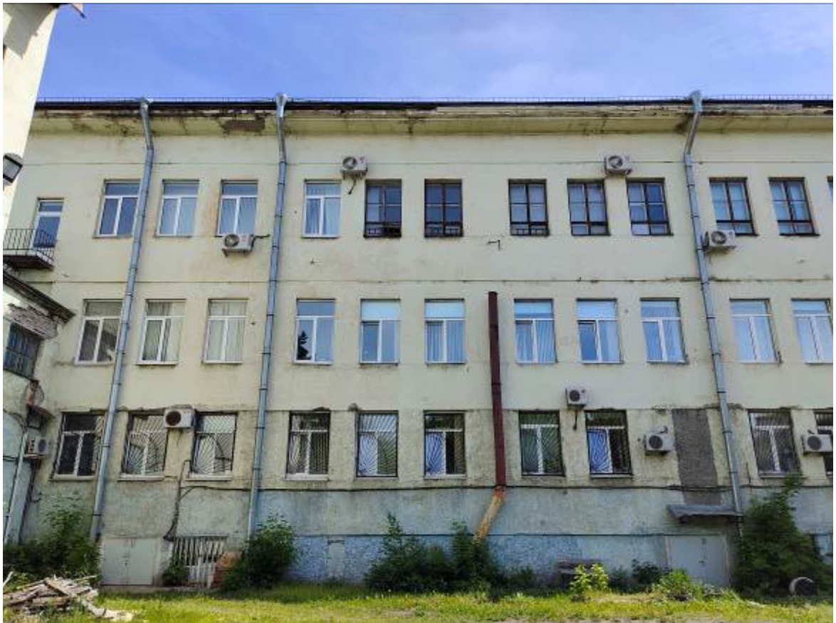
Фото 12. Выявленный ОКН «Здание школы». Фрагмент западного фасада.
