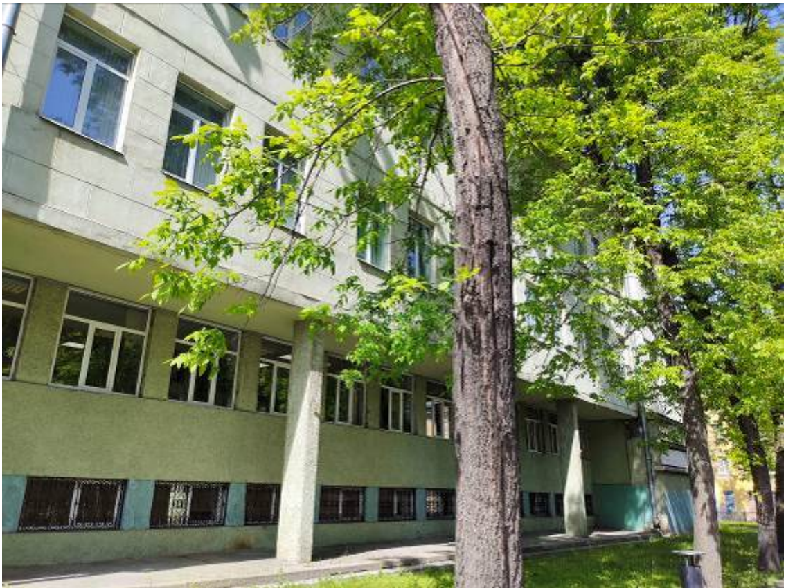
Фото 4. Выявленный ОКН «Здание школы». Фрагмент восточного фасада.
