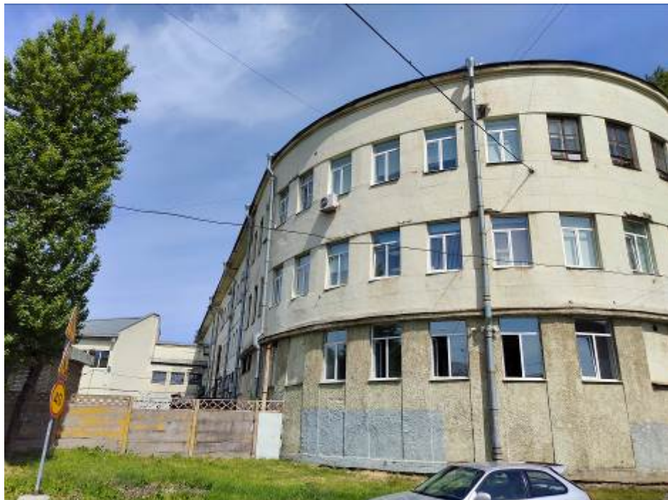
Фото 10. Выявленный ОКН «Здание школы». Общий вид западного фасада. Вид с юга.
