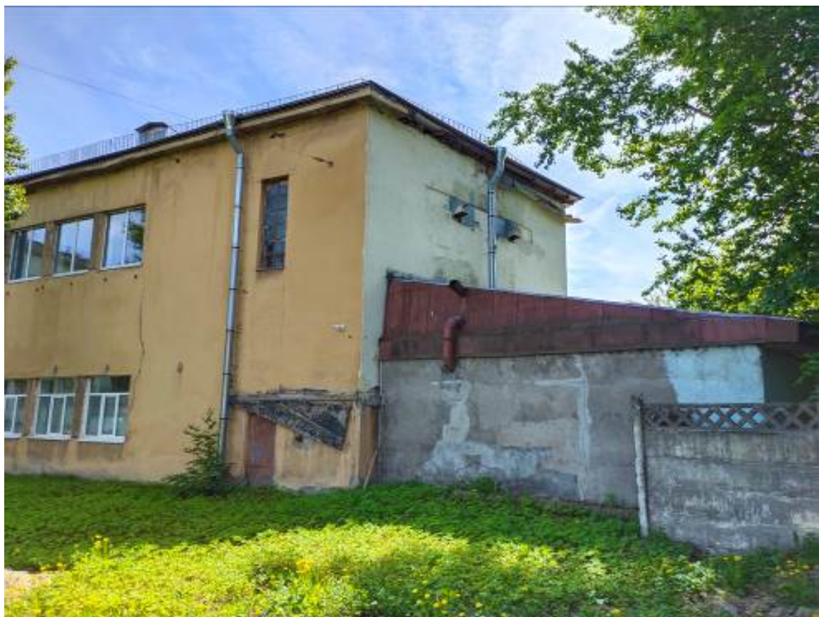
Фото 19. Выявленный ОКН «Здание школы». Фрагмент северного фасада.
