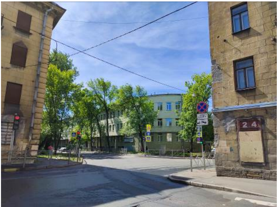
Фото 1. Выявленный ОКН «Здание школы». Общий вид здания с перекрестка ул. Балтийской и Охотничего пер.
