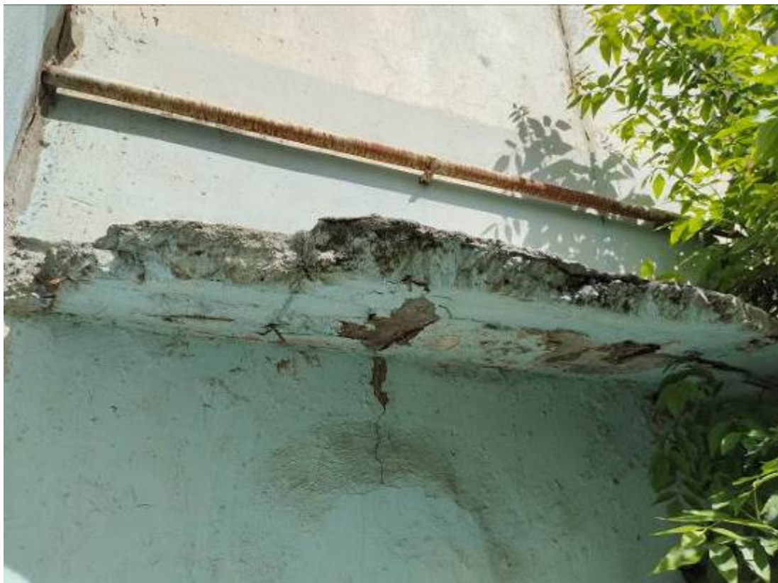
Фото 16. Выявленный ОКН «Здание школы». Фрагмент южного фасада.
