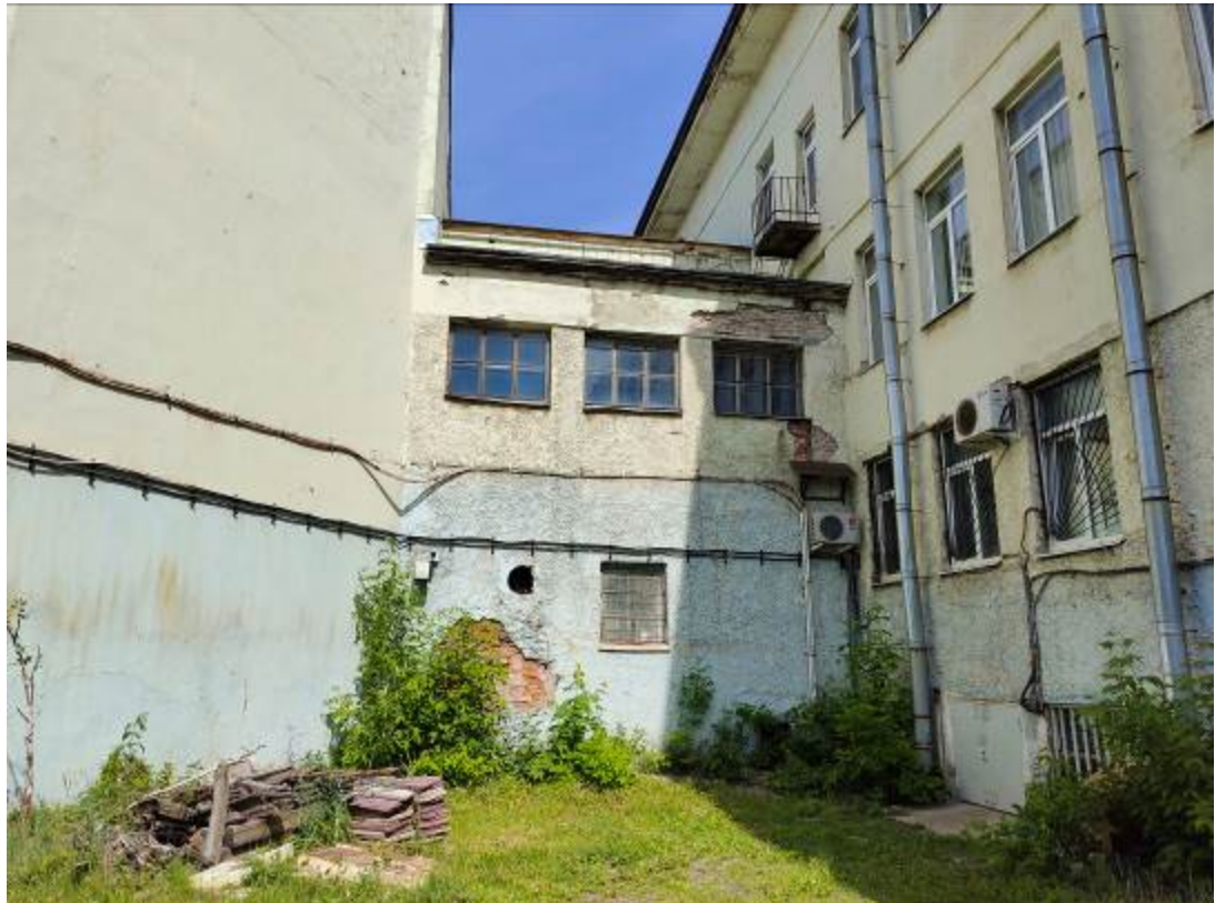
Фото 13. Выявленный ОКН «Здание школы». Фрагмент южного фасада.
