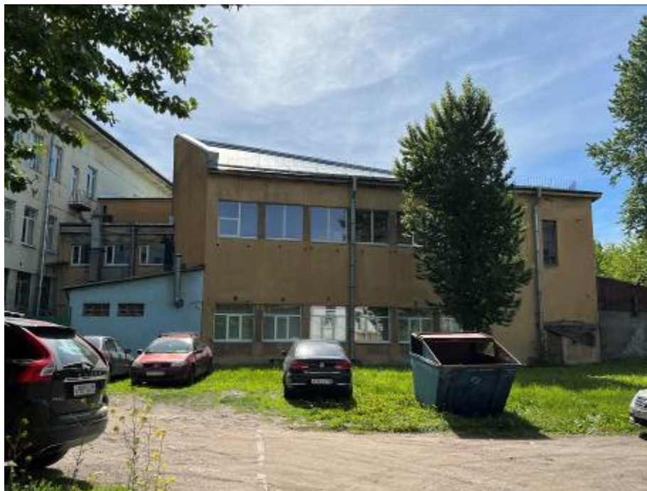
Фото 21. Выявленный ОКН «Здание школы». Фрагмент северного фасада.
