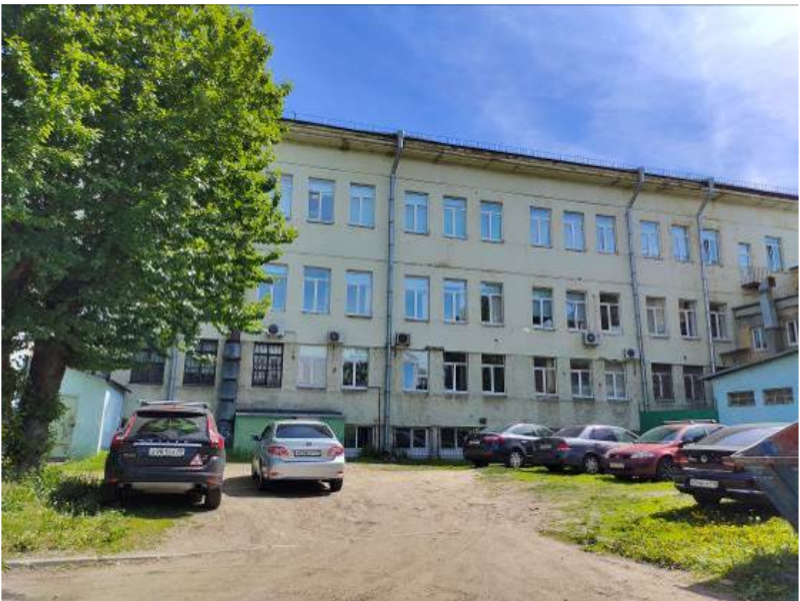
Фото 18. Выявленный ОКН «Здание школы». Фрагмент западного фасада.
