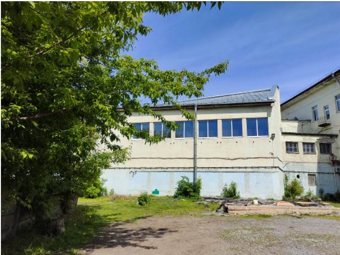
Фото 14. Выявленный ОКН «Здание школы». Фрагмент южного фасада.
