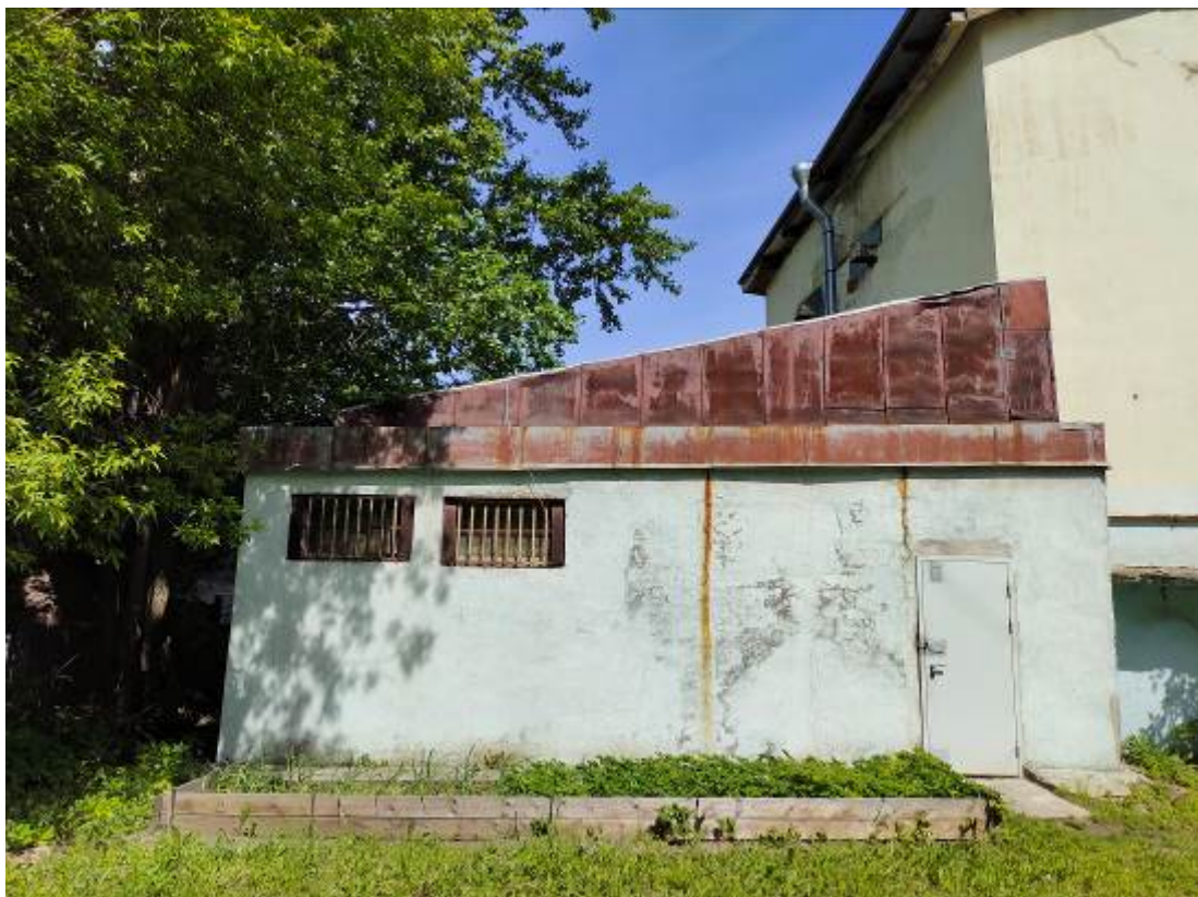
Фото 15. Выявленный ОКН «Здание школы». Фрагмент южного фасада.
