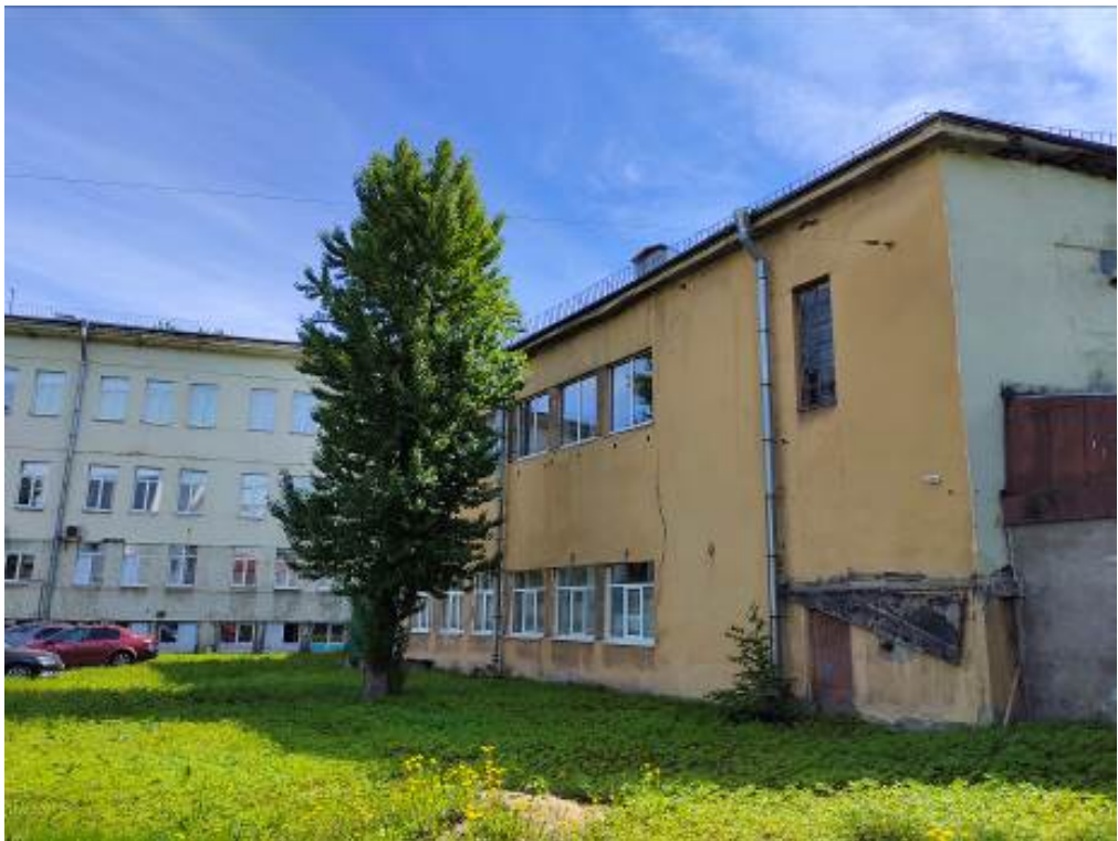
Фото 22. Выявленный ОКН «Здание школы». Фрагмент северного фасада. Вид с запада.
