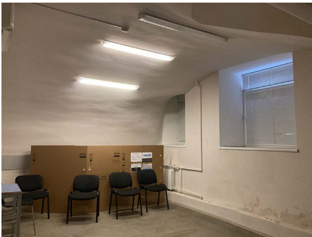
Фото 21. Интерьер цокольного этажа выявленного объекта культурного наследия «Дом А.Ф. Девриена»
