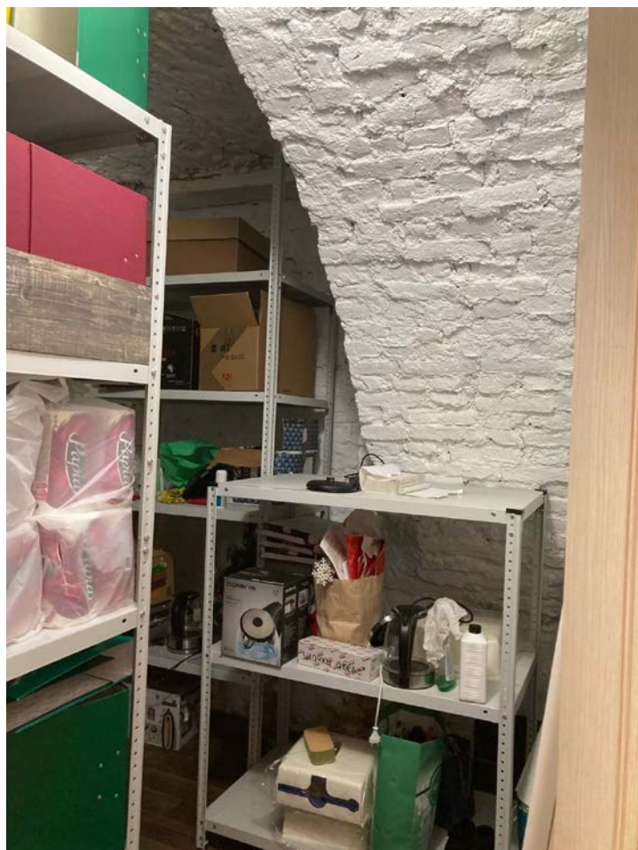
Фото 15. Интерьер цокольного этажа выявленного объекта культурного наследия «Дом А.Ф. Девриена»
