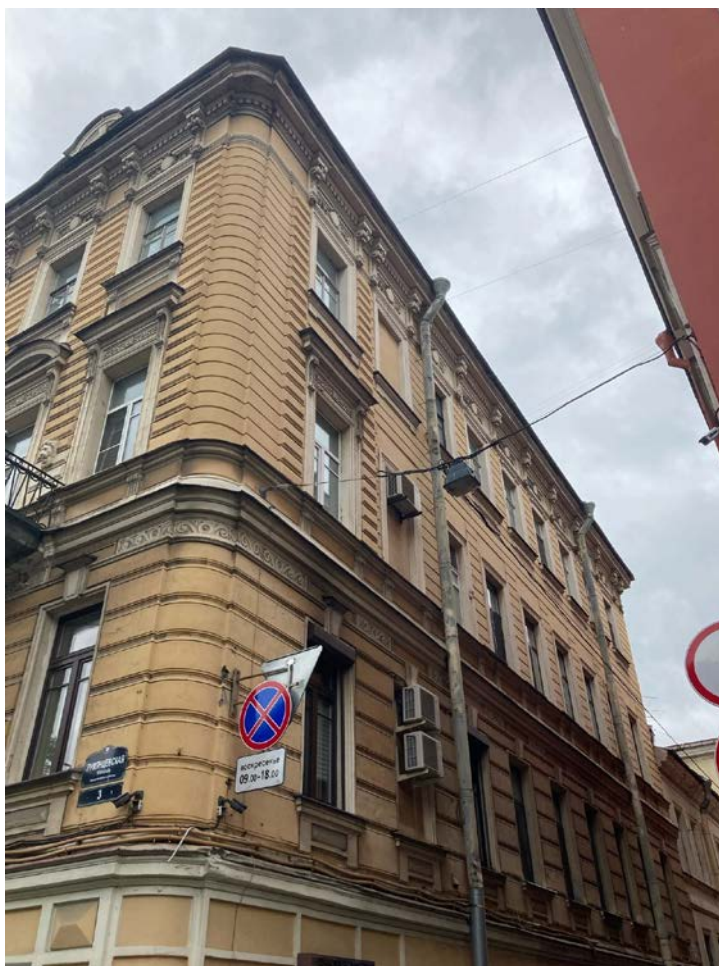
Фото 5. Фрагмент лицевого фасада выявленного объекта культурного наследия «Дом А. Ф. Девриена» (северо-восточный фасад)
