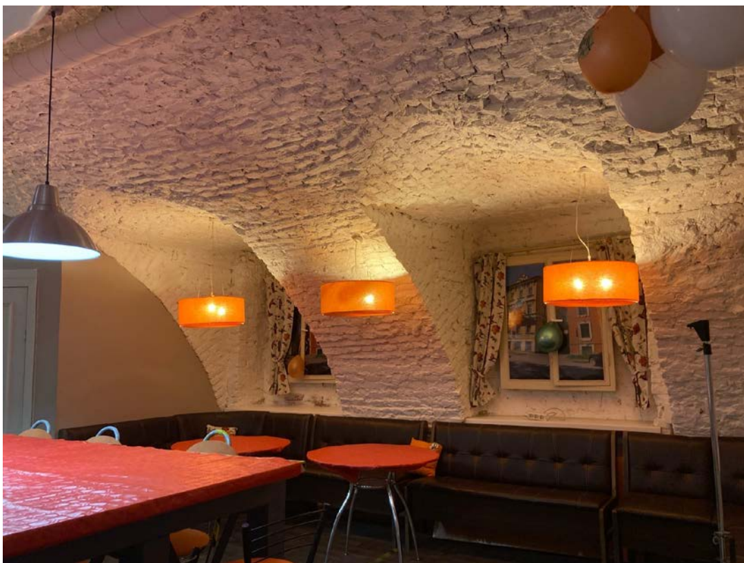
Фото 13. Интерьер цокольного этажа выявленного объекта культурного наследия «Дом А.Ф. Девриена»
