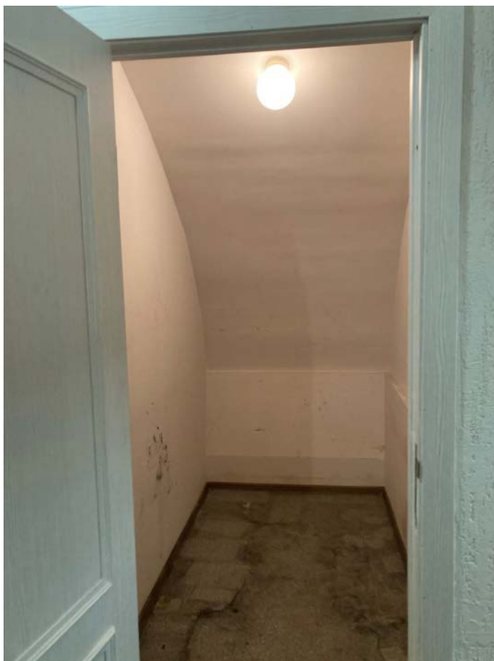
Фото 19. Интерьер цокольного этажа выявленного объекта культурного наследия «Дом А.Ф. Девриена»
