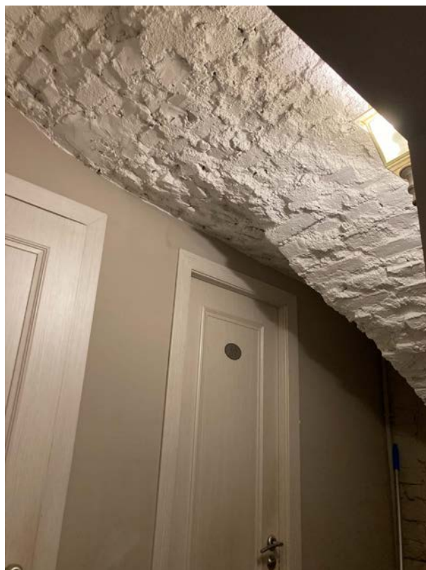
Фото 16. Интерьер цокольного этажа выявленного объекта культурного наследия «Дом А.Ф. Девриена»
