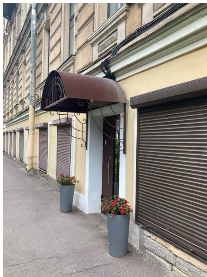
Фото 4. Фрагмент лицевого фасада выявленного объекта культурного наследия «Дом А. Ф. Девриена», вход на цокольный этаж (юго-западный фасад)
