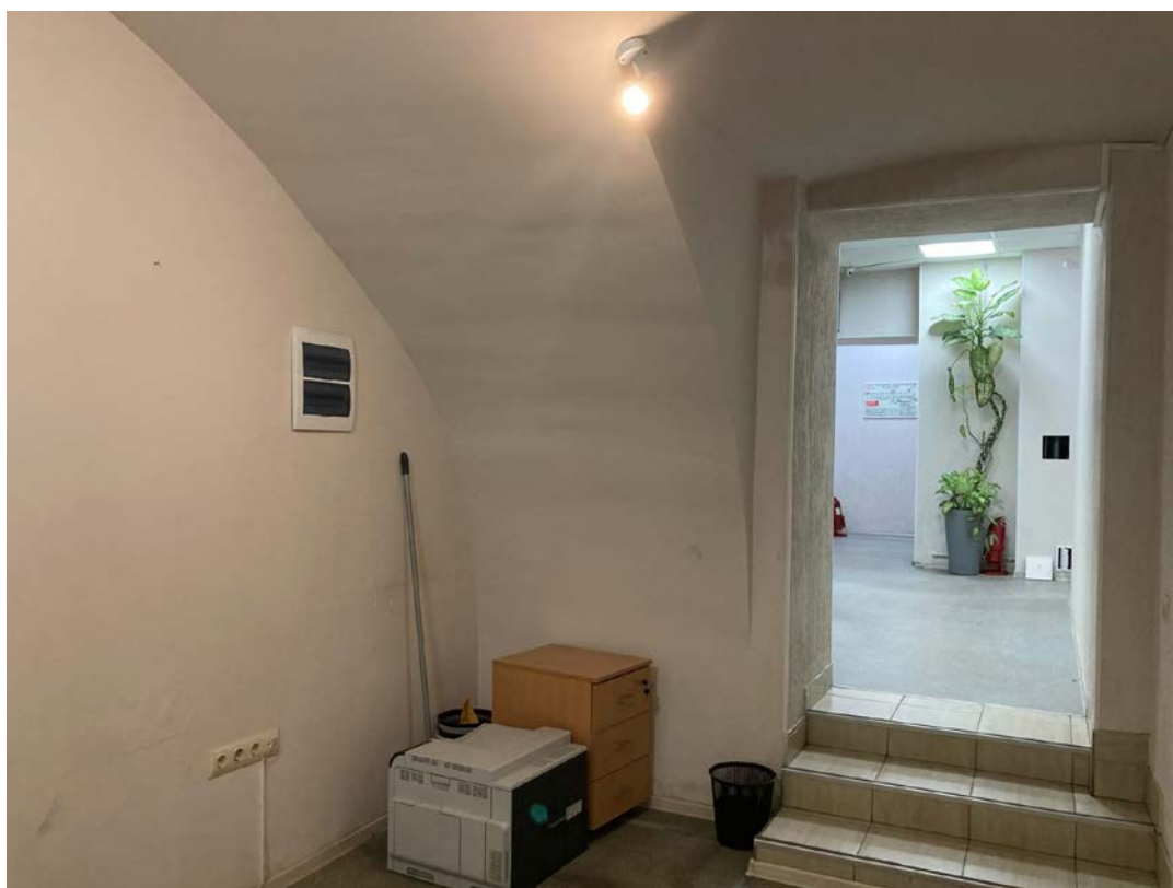
Фото 18. Интерьер цокольного этажа выявленного объекта культурного наследия «Дом А.Ф. Девриена»
