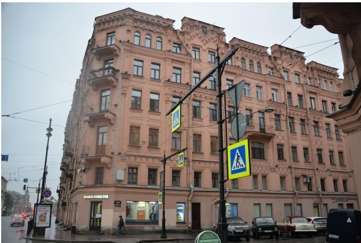
3. Лицевой фасад выявленного объекта культурного наследия «Комплекс доходных домов Н.И. Львовой (8 зданий)» со стороны Углового переулка
