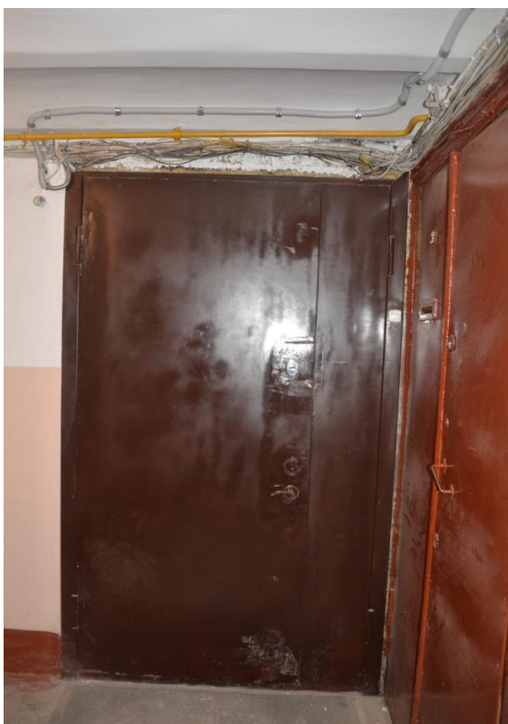
4. Дверь в квартиру №2
