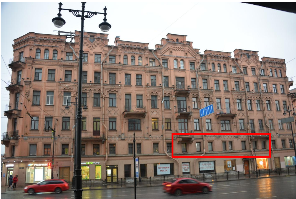
1. Лицевой фасад выявленного объекта культурного наследия «Комплекс доходных домов Н.И. Львовой (8 зданий)» со стороны Московского проспекта
