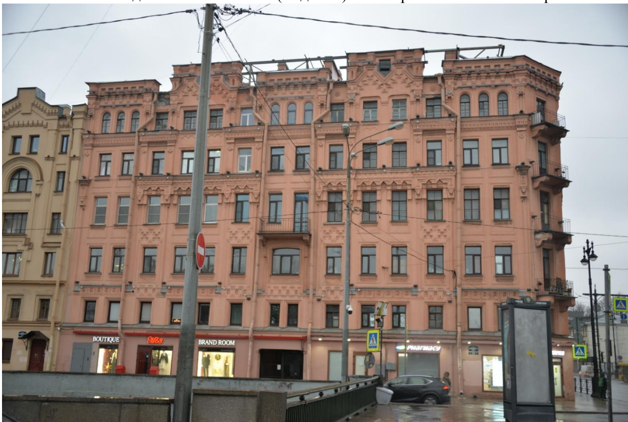
2. Лицевой фасад выявленного объекта культурного наследия «Комплекс доходных домов Н.И. Львовой (8 зданий)» со стороны Обводного канала
