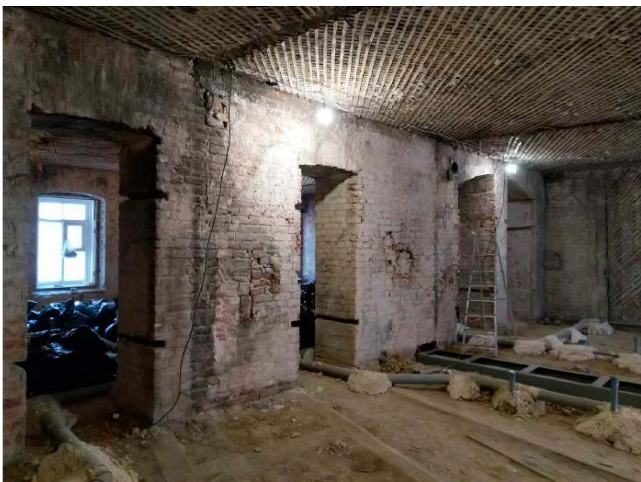
б. Помещение №12 квартиры №21 в уровне 3-го этажа выявленного объекта культурного наследия «Дом И.И. Антонова», расположенного по адресу: г. Санкт-Петербург, Литейный пр., д. 61, лит. А. 20.12.2020.
