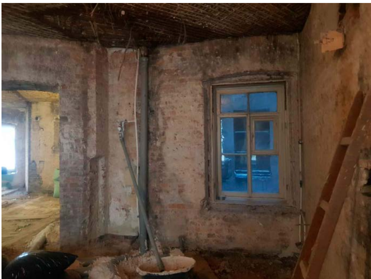
9. Помещение №5 квартиры №21 в уровне 3-го этажа выявленного объекта культурного наследия «Дом И.И. Антонова», расположенного по адресу: г. Санкт-Петербург, Литейный пр., д. 61, лит. А. 20.12.2020.
