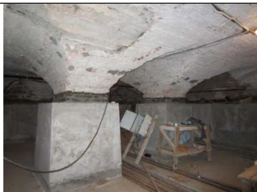
арочные проемы перехода – местоположение, габариты, конструкция (прорезанный тремя арками);
