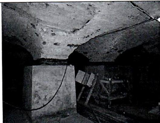
арочные проемы перехода – местоположение, габариты, конструкция (прорезанный тремя арками);
