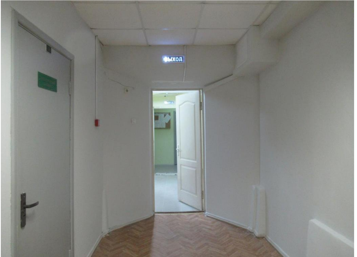
22. Фрагмент нежилого помещения 5-Н (в соответствии с планом ПИБ). Вид на раскрытый (ранее существовавший исторический) дверной проем между нежилыми помещениями 1-Н и 5-Н.
