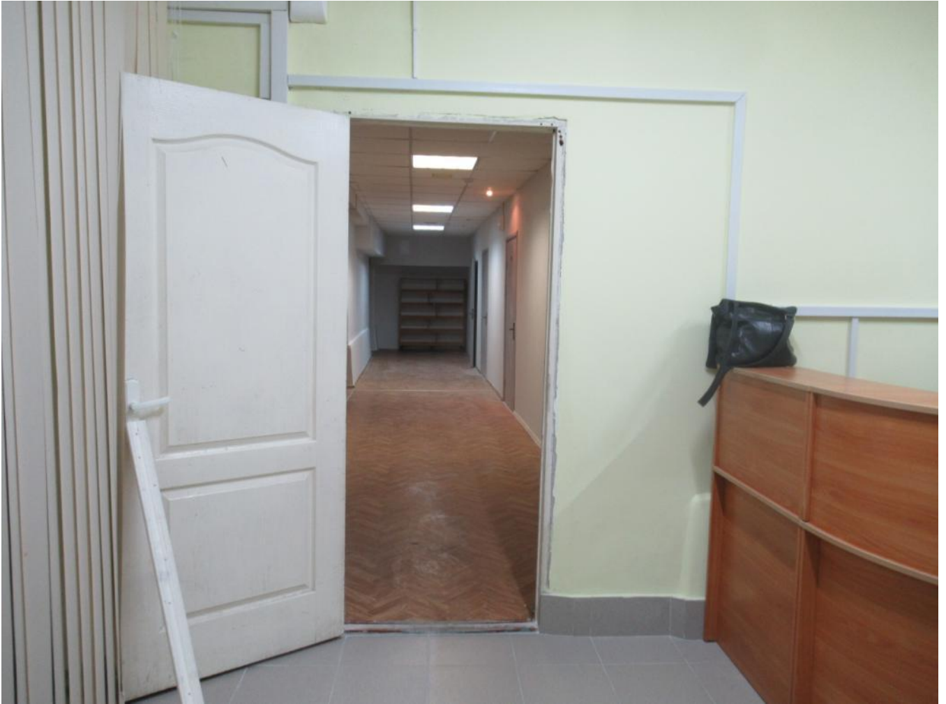
20. Фрагмент нежилого помещения 1-Н (в соответствии с планом ПИБ). Вид на раскрытый (ранее существовавший исторический) дверной проем между нежилыми помещениями 1-Н и 5-Н.
