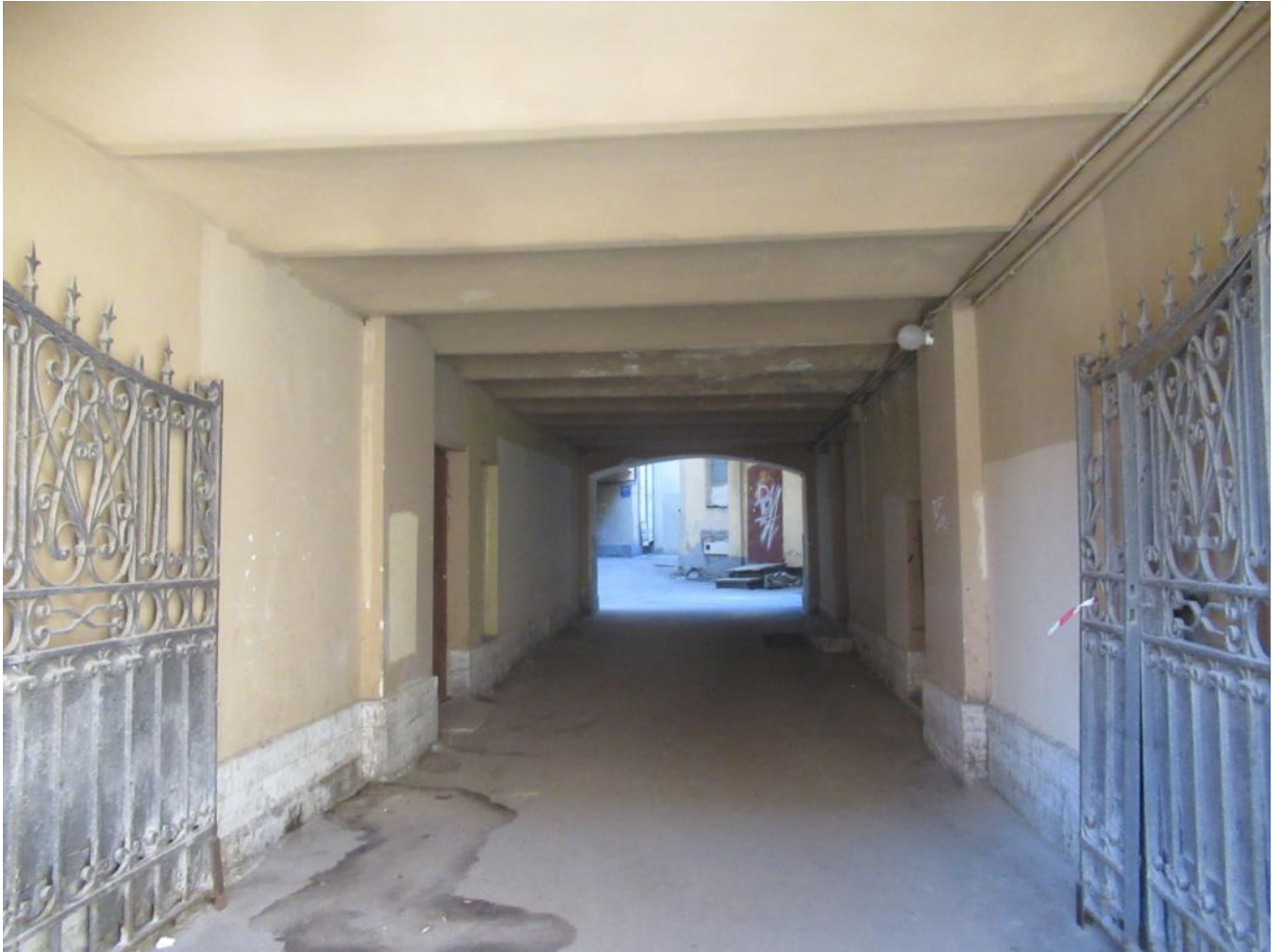
9. Воротный проезд во внутренние дворы со стороны Волховского переулка
