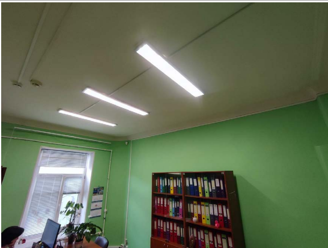
38. Общий вид пом. 10-Н (4, 5) в уровне 3-го этажа.
