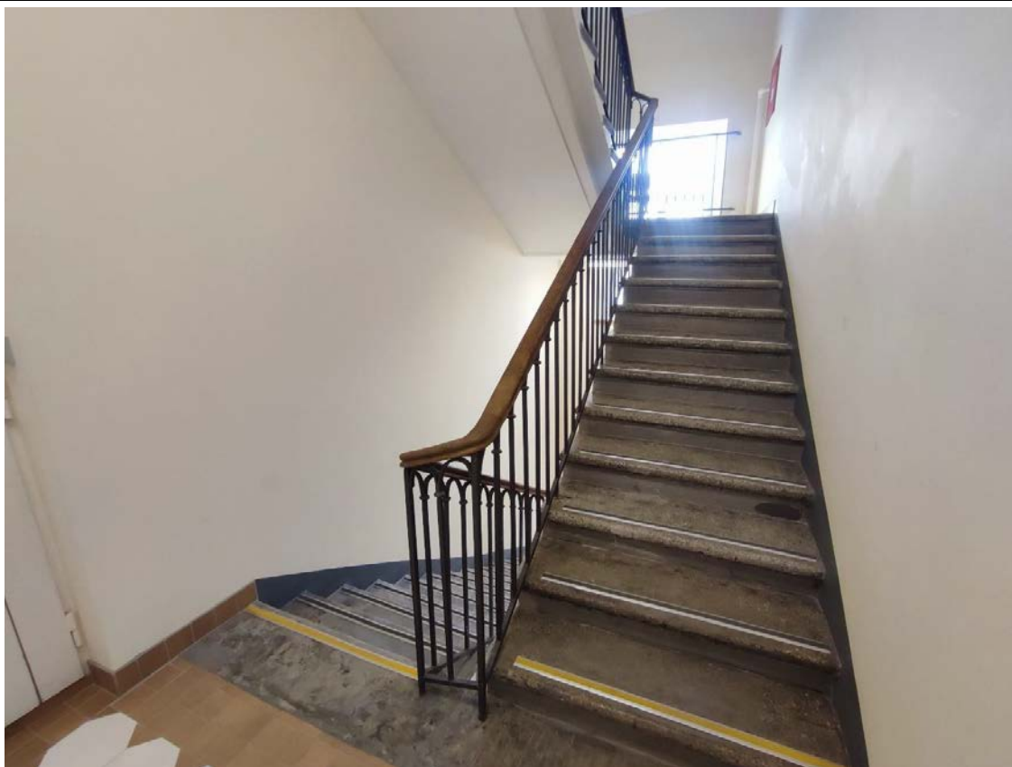
77. Общий вид площадки двухмаршевой лестницы 4ЛК в уровне 4-го этажа.
