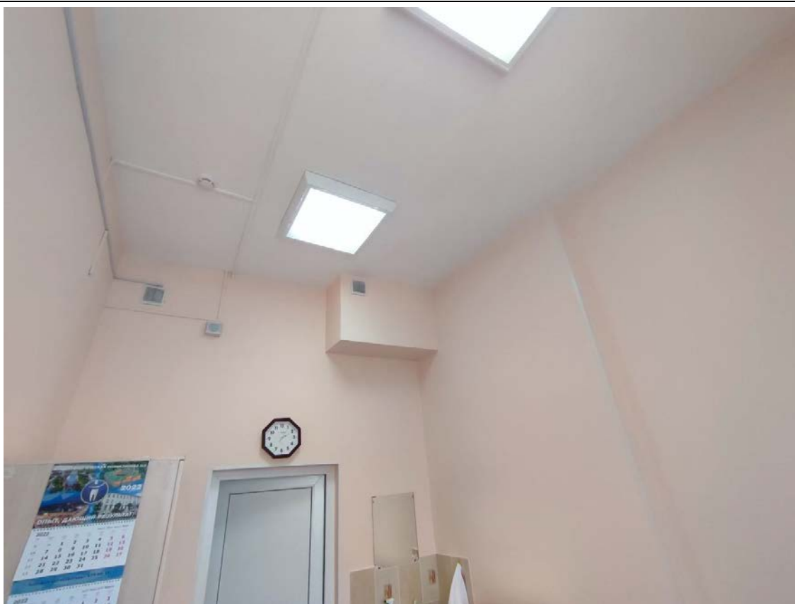
75. Фрагмент пом. 14-Н (29) в уровне 4-го этажа.
