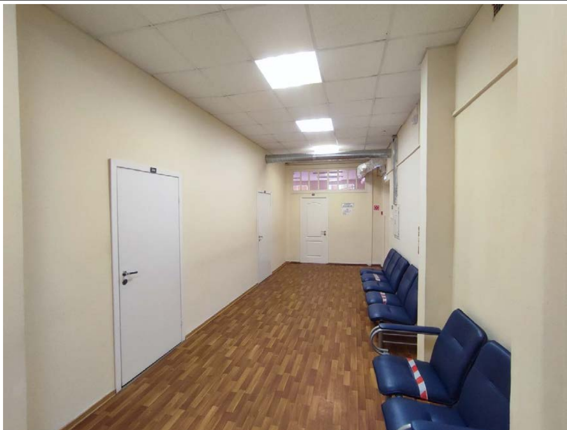
54. Общий вид пом. 11-Н (1) в уровне 3-го этажа.
