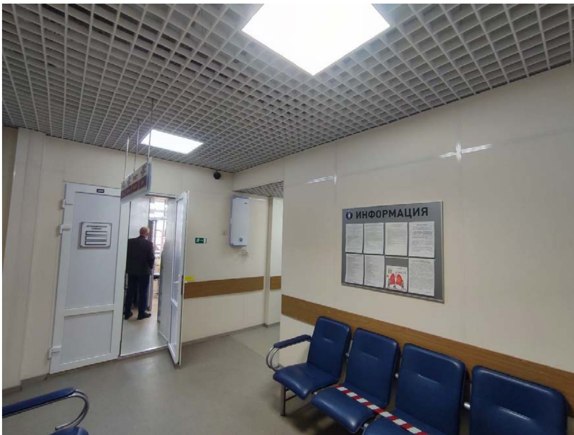
66. Общий вид пом. 14-Н (39) в уровне 4-го этажа.
