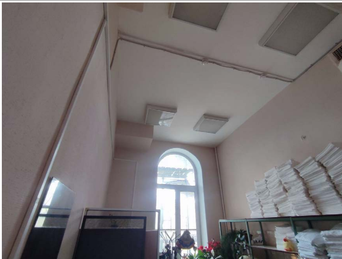
31. Общий вид пом. 9-Н (33) в уровне 2-го этажа.
