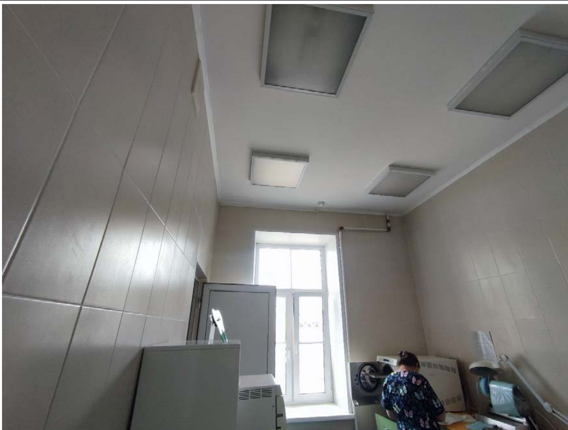
73. Общий вид пом. 14-Н (22) в уровне 4-го этажа.
