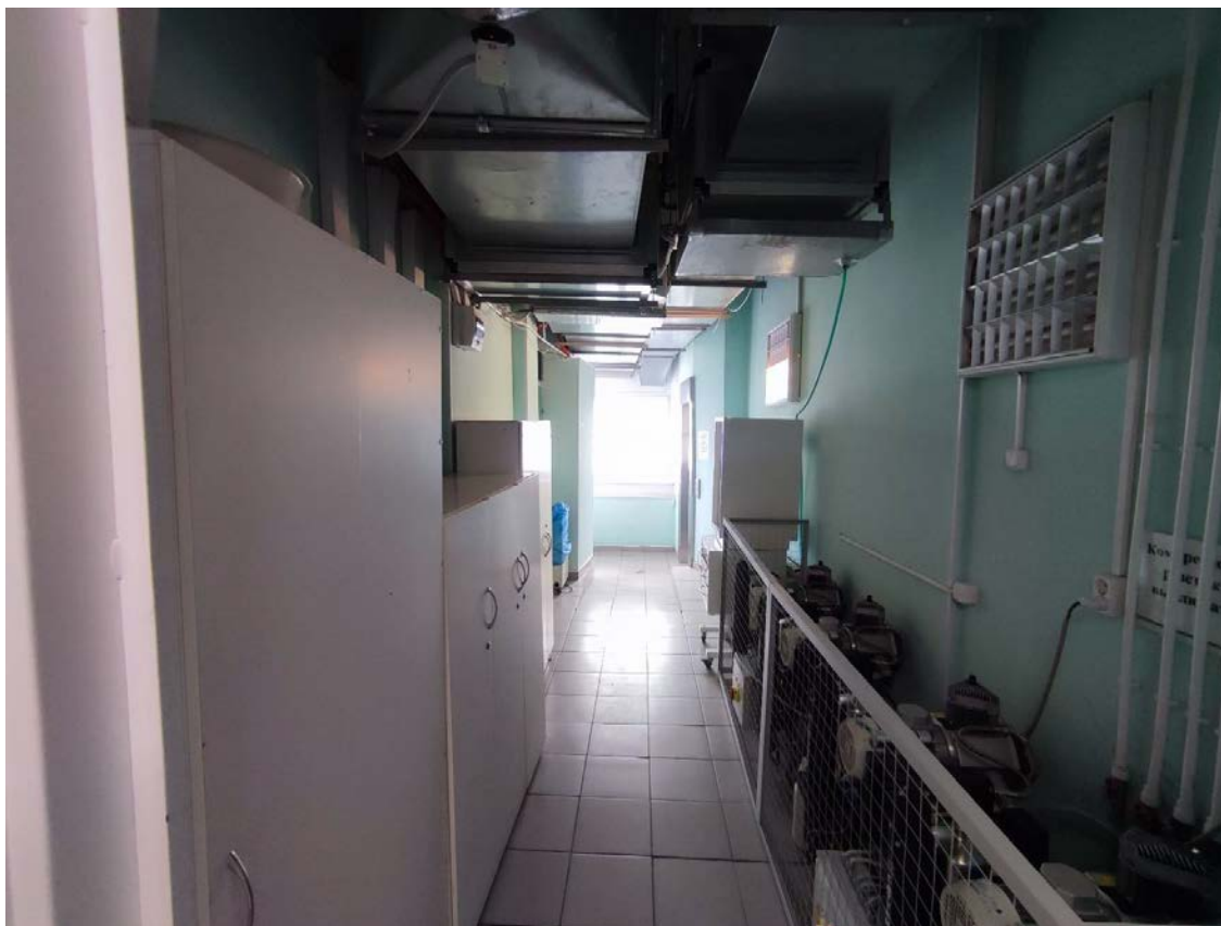
78. Общий вид пом. 14-Н (35, 36) в уровне 4-го этажа.
