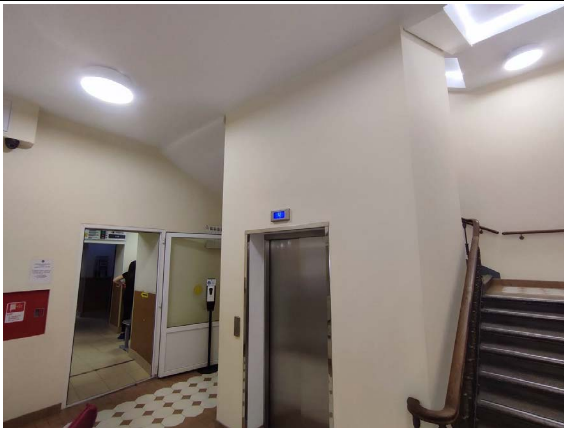
11. Общий вид нижней площадки лестницы 6ЛК (3) в уровне 1-го этажа.
