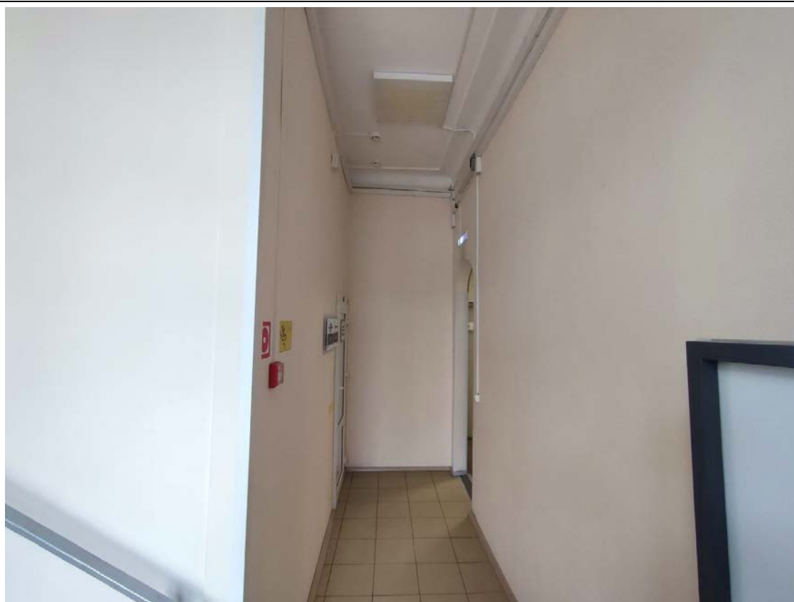
40. Общий вид пом. 11-Н (44) в уровне 3-го этажа.
