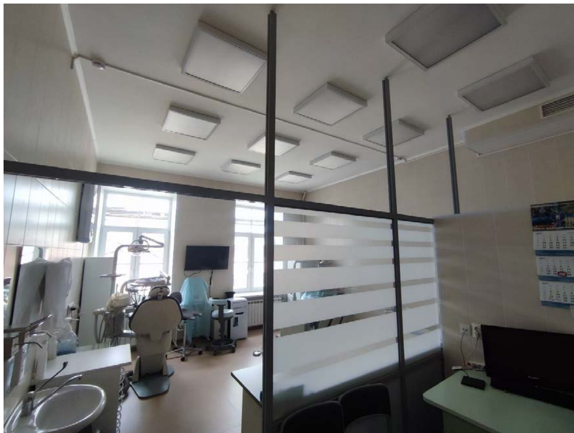
72. Общий вид пом. 14-Н (21) в уровне 4-го этажа.
