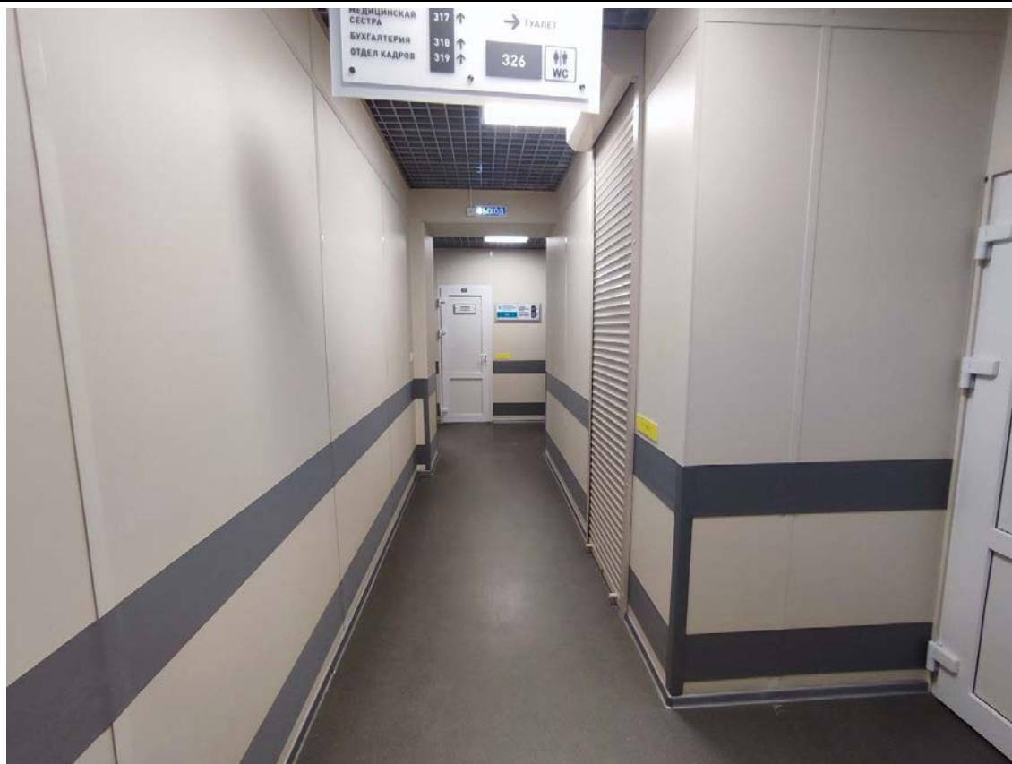
47. Фрагмент пом. 11-Н (16) в уровне 3-го этажа.
