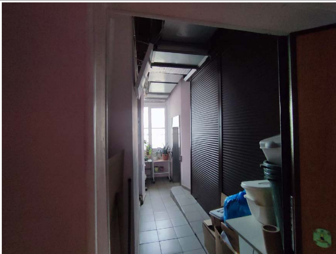
32. Общий вид пом. 9-Н (31) в уровне 2-го этажа.
