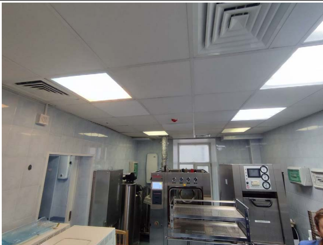
21. Общий вид пом. 6-Н (24) в уровне 1-го этажа.
