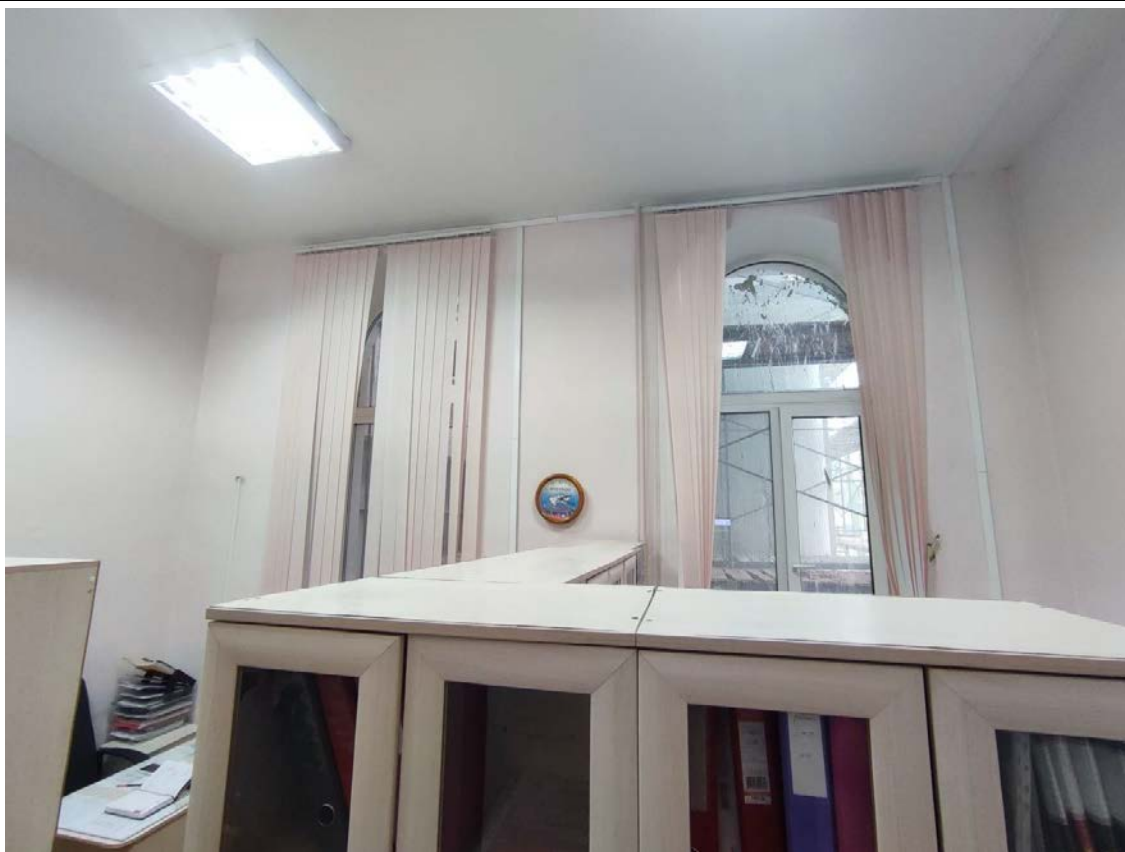
37. Общий вид пом. 9-Н (23) в уровне 2-го этажа.
