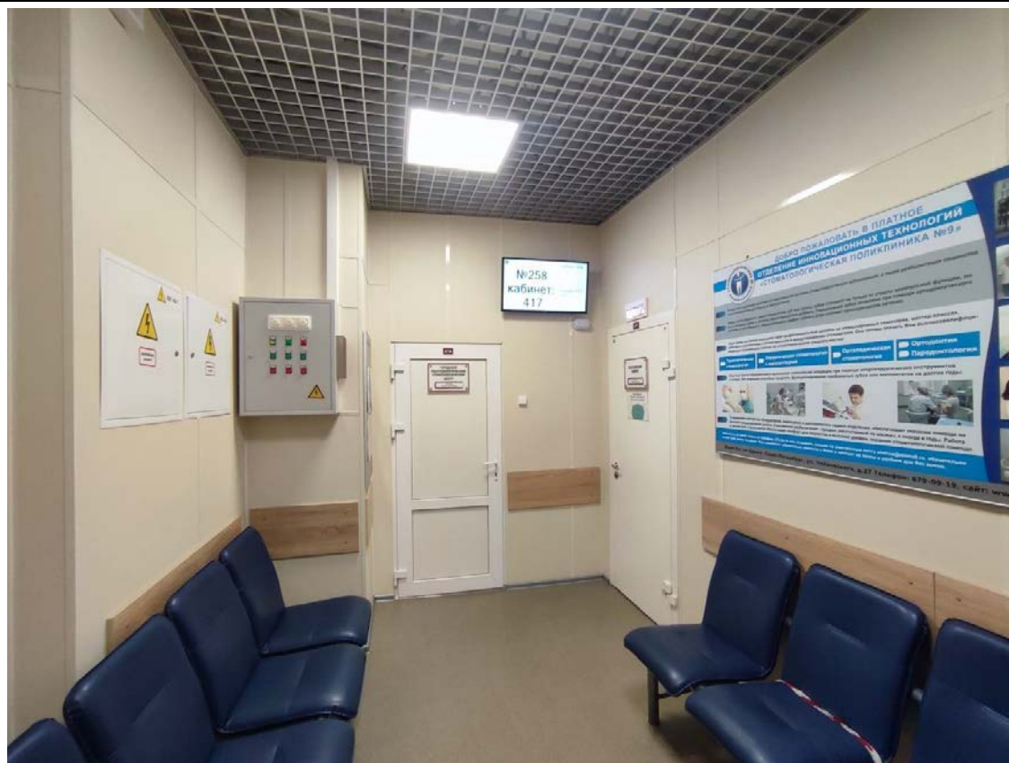
74. Общий вид пом. 14-Н (28) в уровне 4-го этажа.
