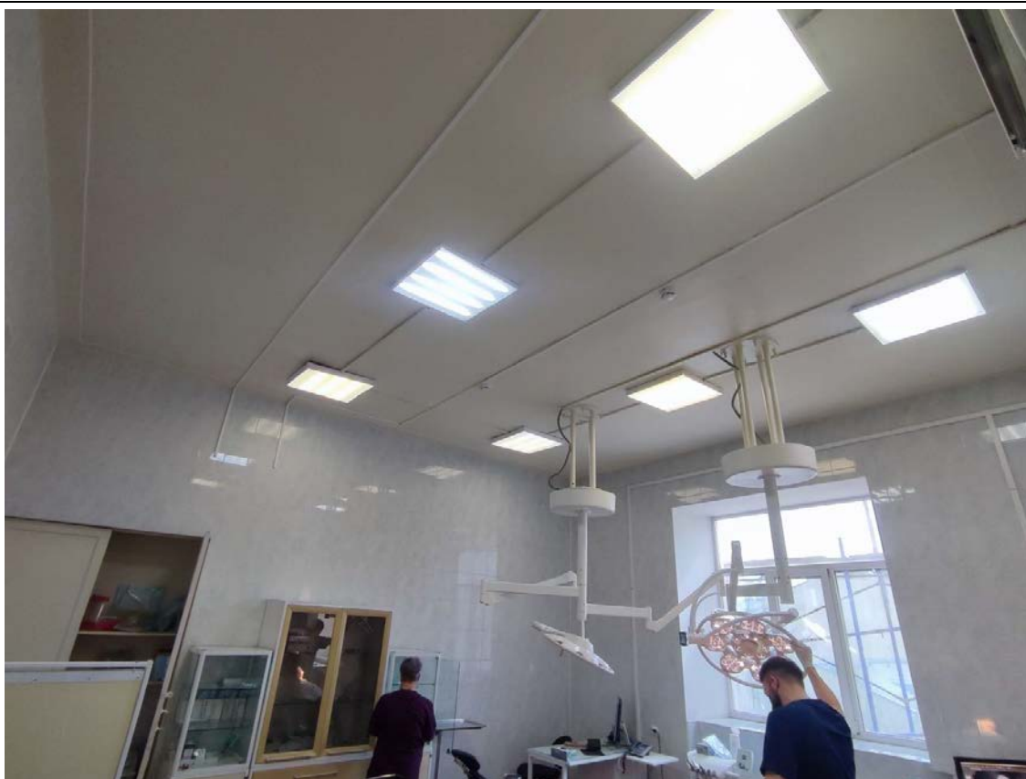
55. Общий вид пом. 15-Н (2) в уровне 4-го этажа.
