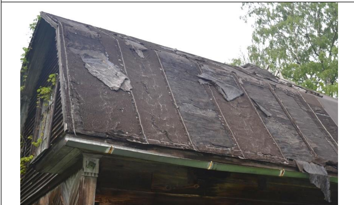
11. ОКН «Парк с озерами: Большое (Осинорощинское), Глухое, Малое и Среднее (Дворцовое)», входящего в состав объекта культурного наследия регионального значения «Усадьба Лопухиной Е.И. (Левашовых, Вяземских) «Осиновая Роща». Фрагмент кровли здания. Дата съёмки: 20.09.2021 г.
