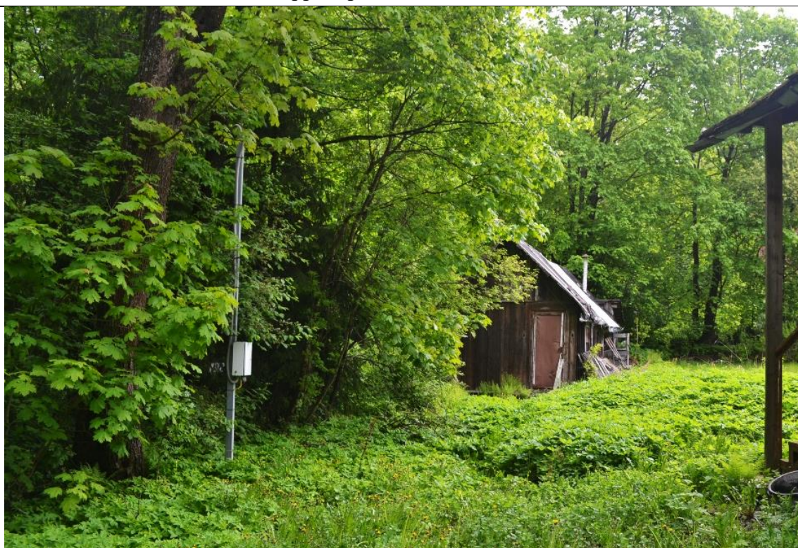
17. ОКН «Парк с озерами: Большое (Осинорощинское), Глухое, Малое и Среднее (Дворцовое)», входящего в состав объекта культурного наследия регионального значения «Усадьба Лопухиной Е.И. (Левашовых, Вяземских) «Осиновая Роща». Общий вид территории, вид на сарай. Дата съёмки: 20.09.2021 г.
