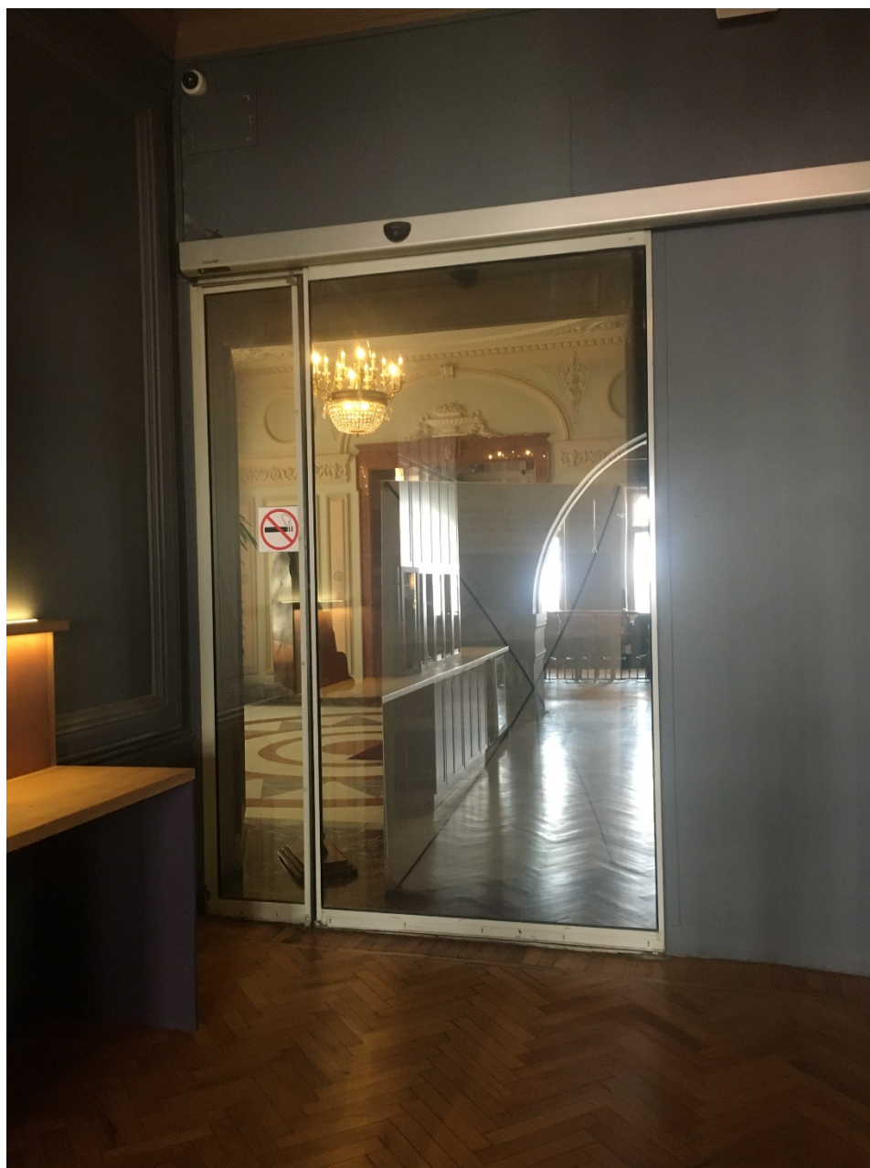
3. Проем между помещениями №3 и №1 помещения 58-Н (2 этаж). Вид со стороны помещения №1. 24.05.2021
