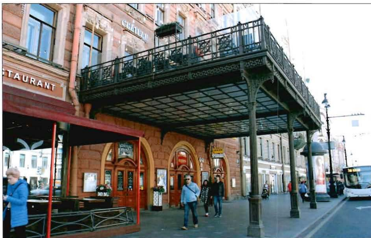
Фото №2. Выносной балкон на столбах по Невскому проспекту.
