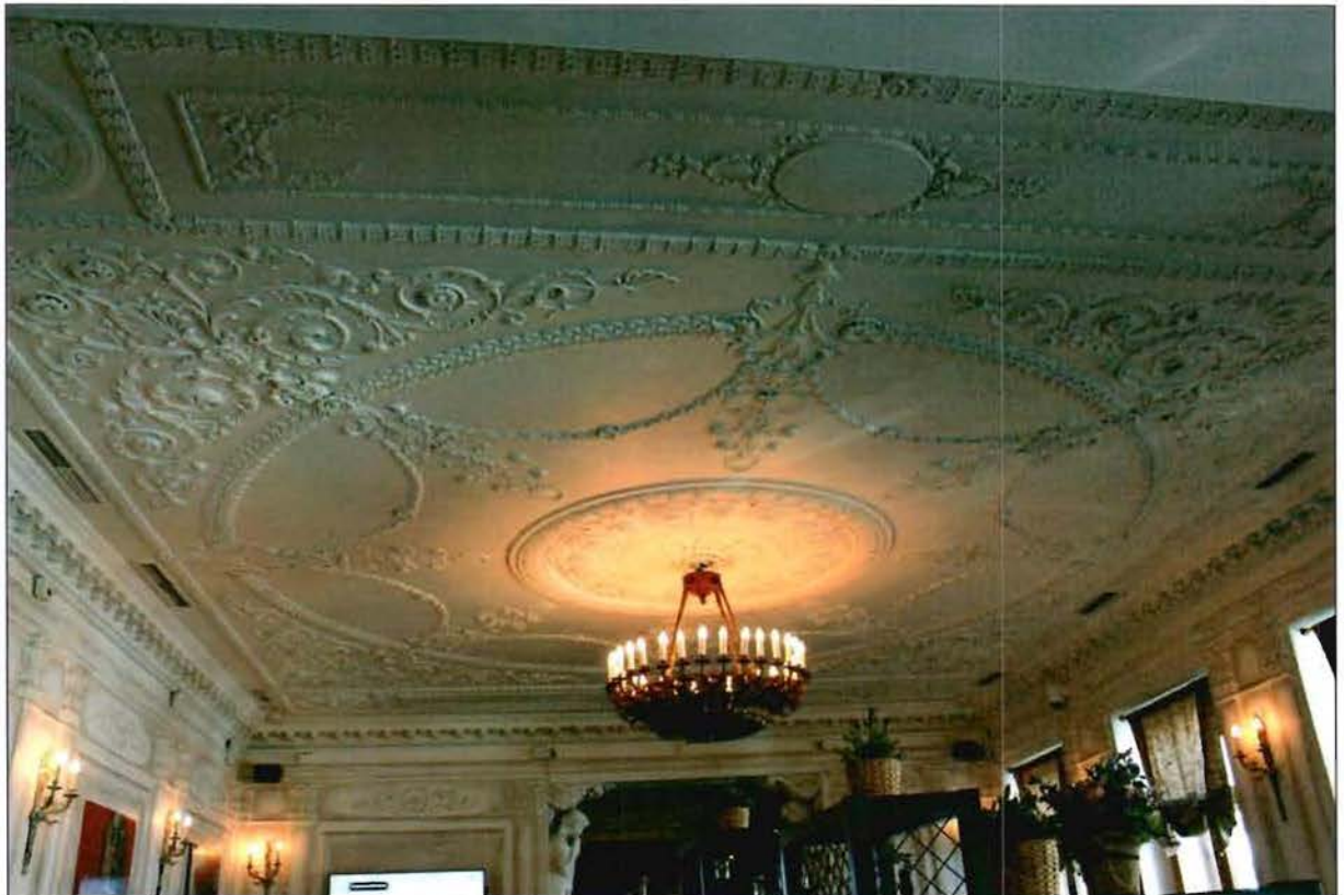
Фото №3, 4. Помещение 58-Н (1) 2-го этажа.
