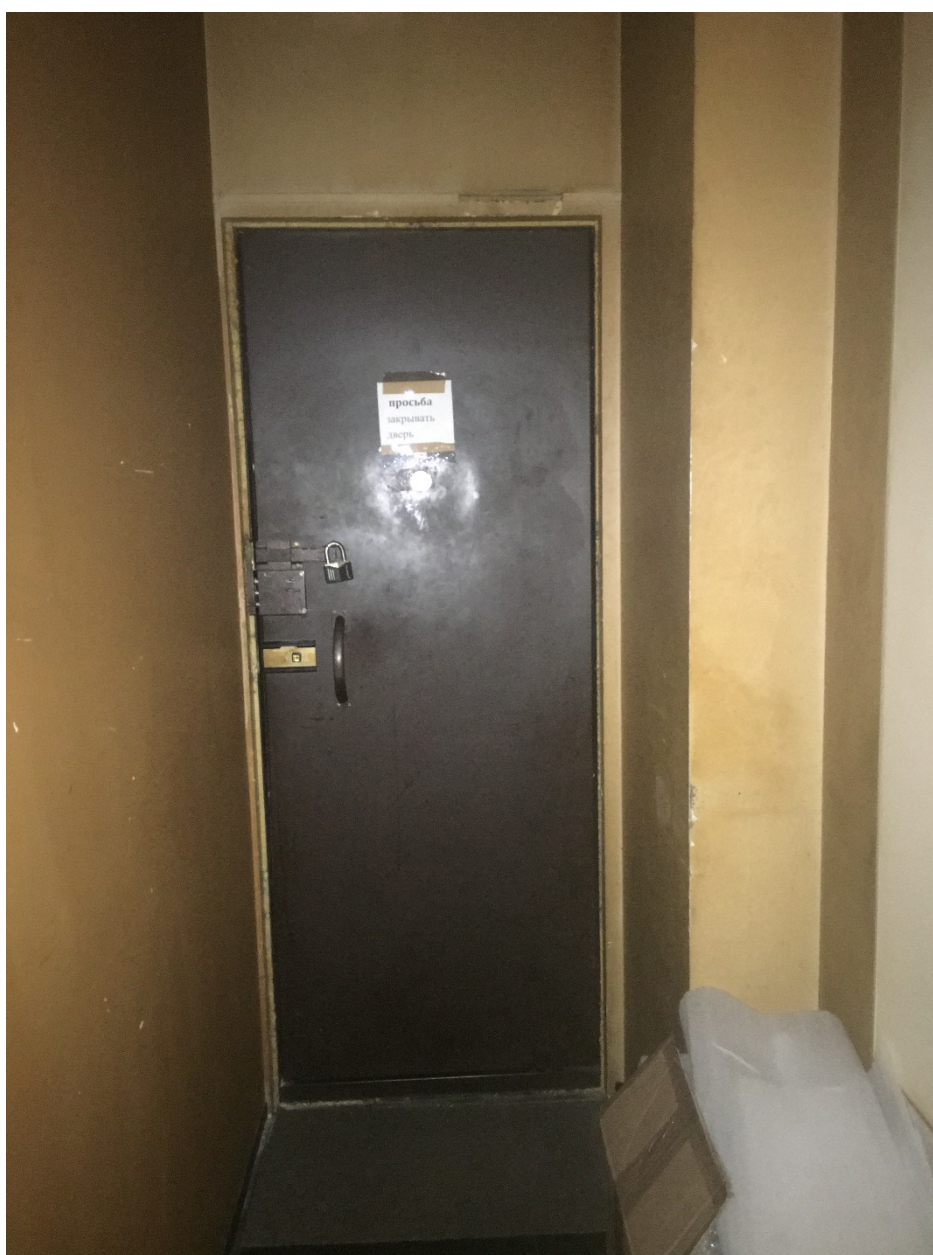
5. Проем между помещениями №28 и №27 помещения 58-Н (2 этаж). Вид со стороны помещения №27. 24.05.2021
