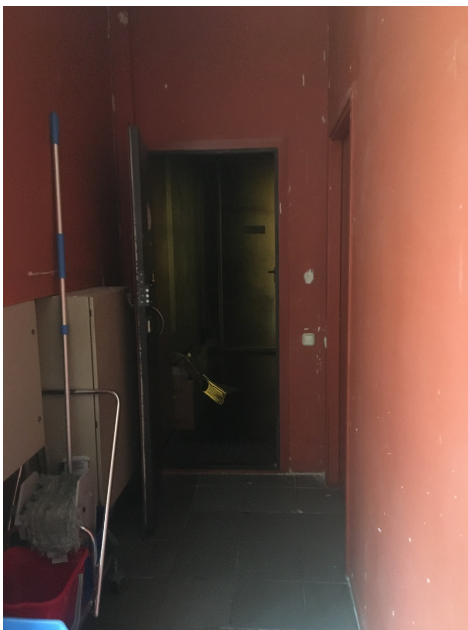
6. Проем между помещениями №28 и №27 помещения 58-Н (2 этаж). Вид со стороны помещения №28. 24.05.2021
