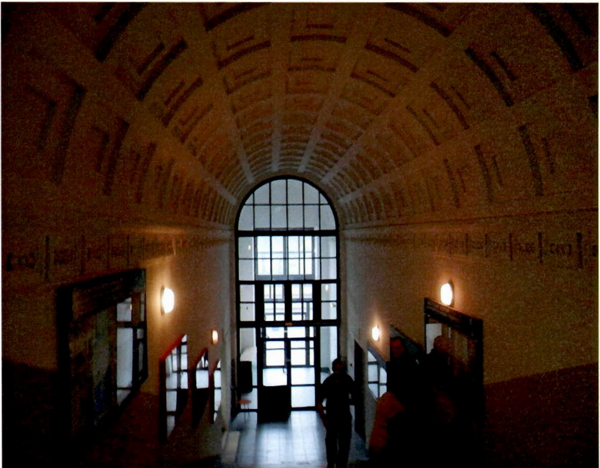
7. Цилиндрический свод в объеме лестничных клеток.
