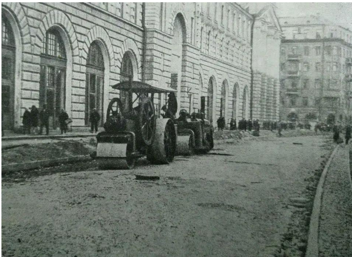
48. Ремонтные работы по замене дорожного покрытия на проспекте Максима Горького. 1930 – 1932 гг. [Электронный доступ]: https://pastvu.com/p/873001 .
