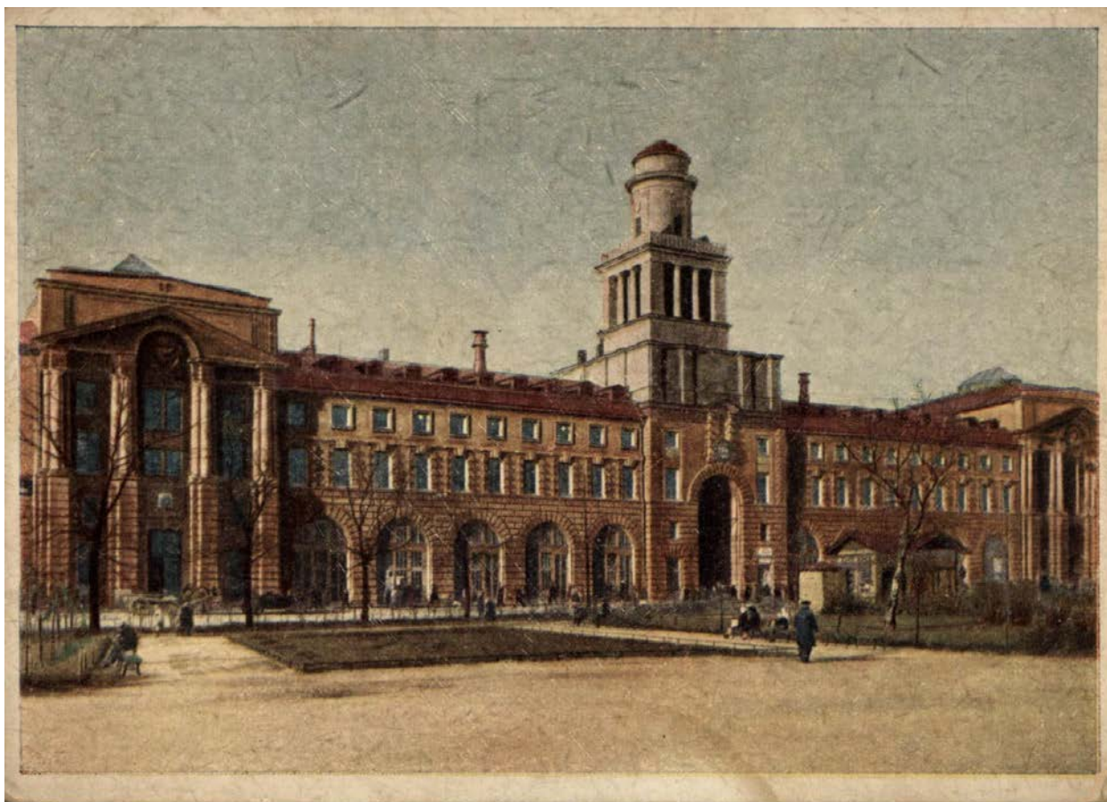
41. Биржа труда на Кронверкском проспекте. 1920 – 1929 гг. Автор съемки: не установлен. [Электронный доступ]: https://pastvu.com/p/134550 .
