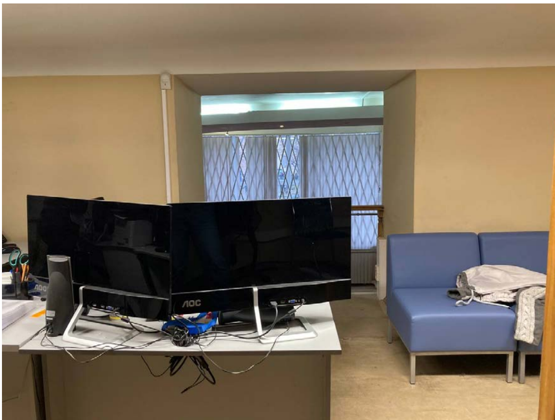
Фото №26. Конструкции встроенной антресоли. Проем в стене. Грязь, физический износ.
