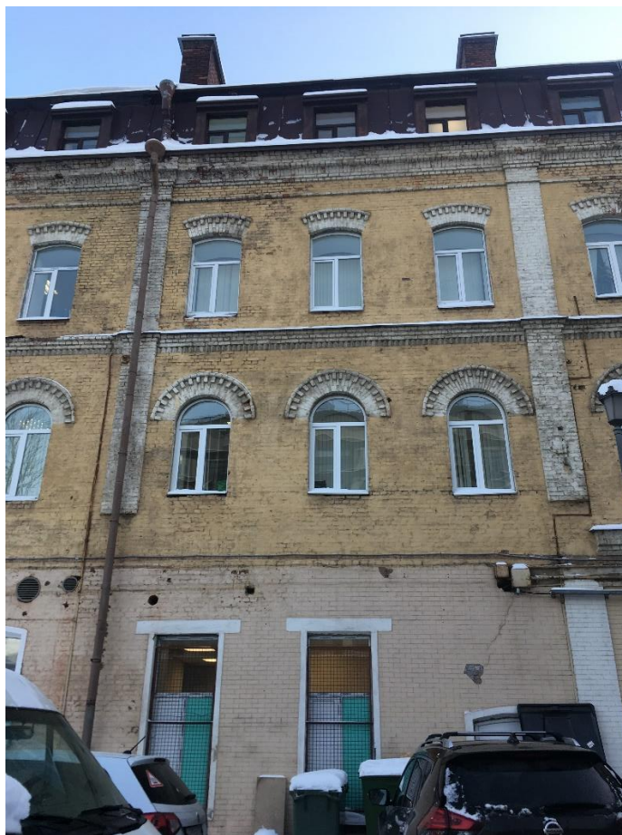
Фото 11. Фрагмент дворового фасада по оси «Е» в осях «4-3».
