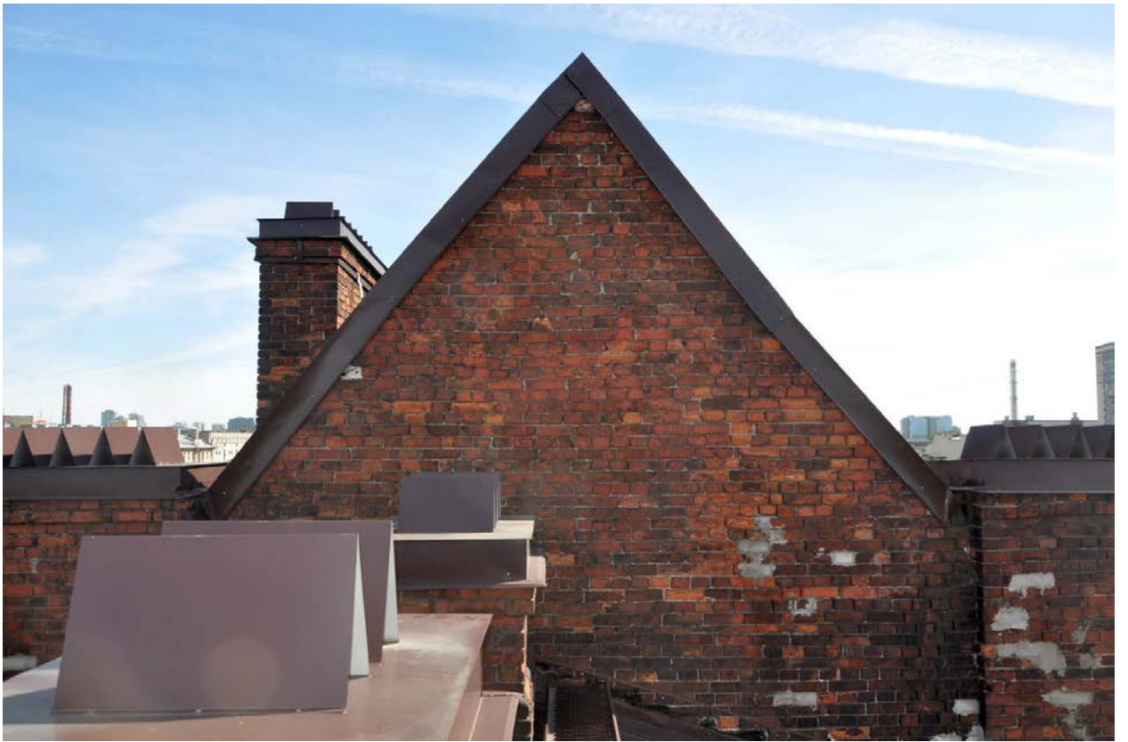
Фото 25. Вид с кровли на световой фонарь в осях «6-5».
