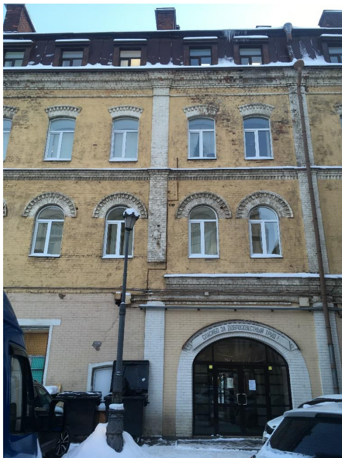
Фото 13. Фрагмент дворового фасада по оси «Е» в осях «3-2».
