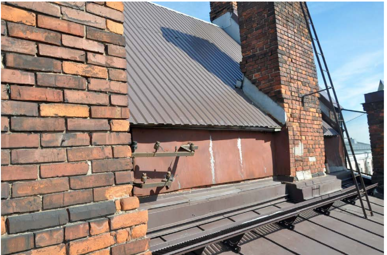
Фото 24. Вид с кровли на световой фонарь в осях «4-3».
