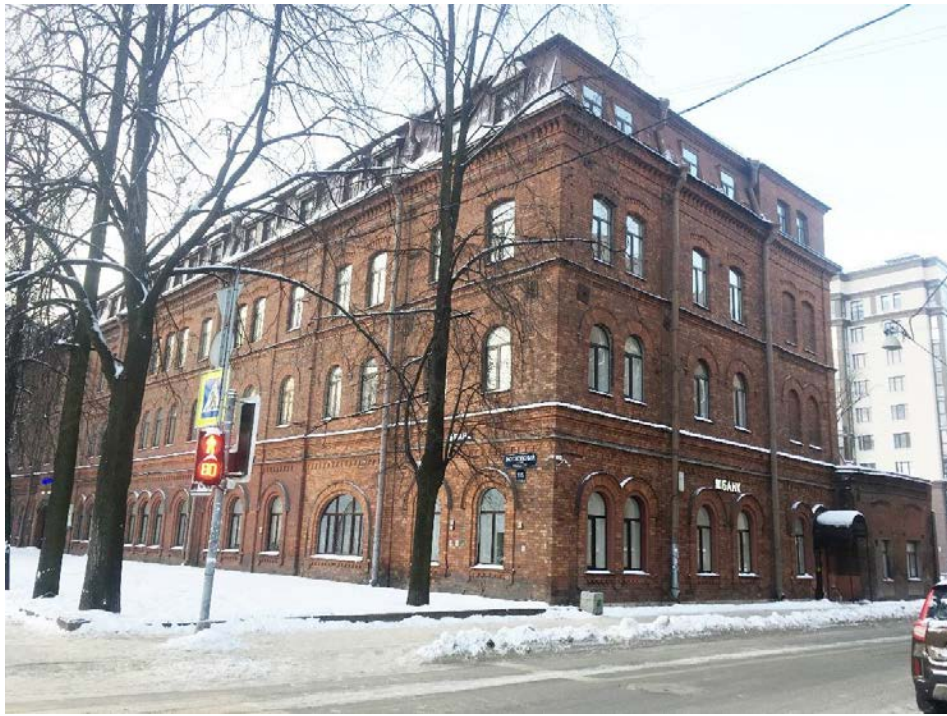
Фото 5. Перспективный вид с Московского проспекта. Лицевой и боковой фасады. Общее загрязнение цокольной части.
