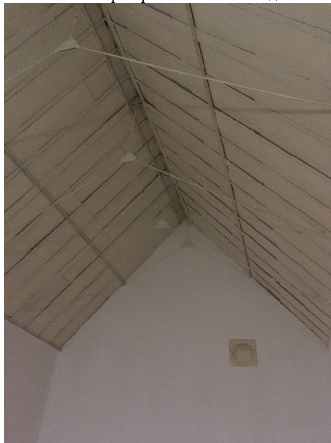
Фото 22. Световой фонарь в осях «4-3». Вид с лестницы.
