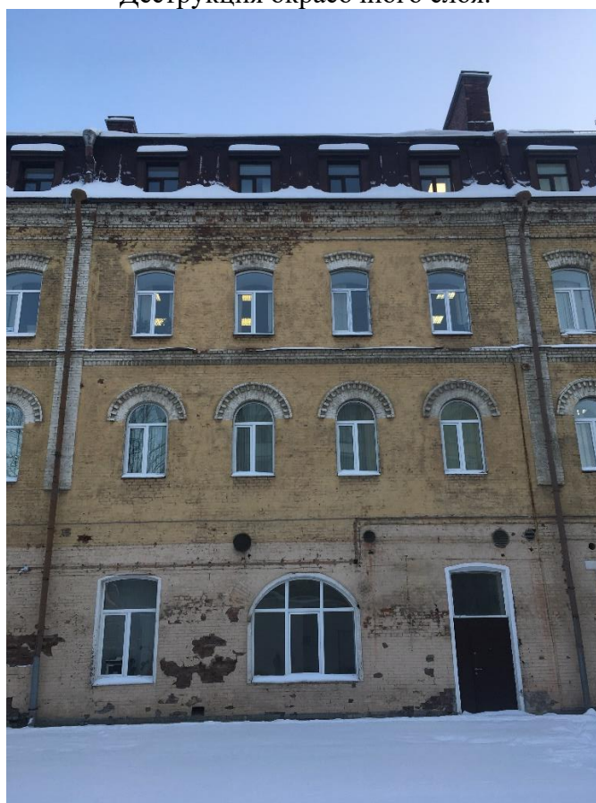
Фото 10. Фрагмент дворового фасада по оси «Е» в осях «5-4».
