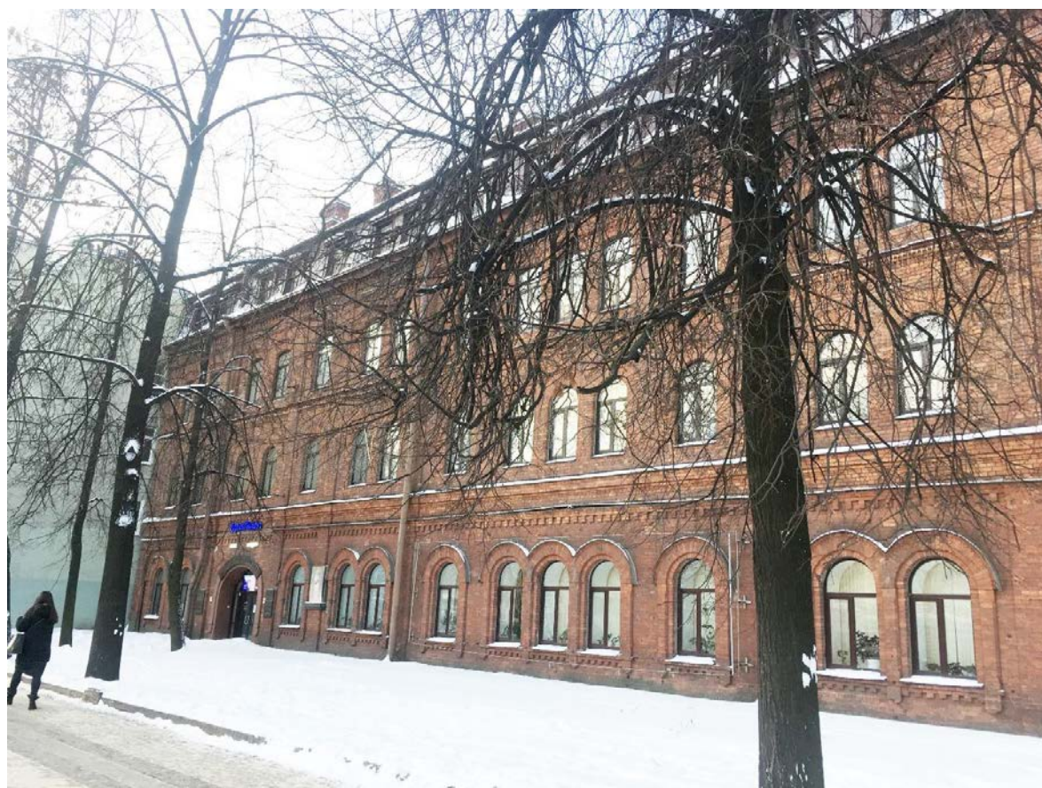
Фото 2. Лицевой фасад по Московскому проспекту. Общий вид по оси «А» в осях «1-7».
