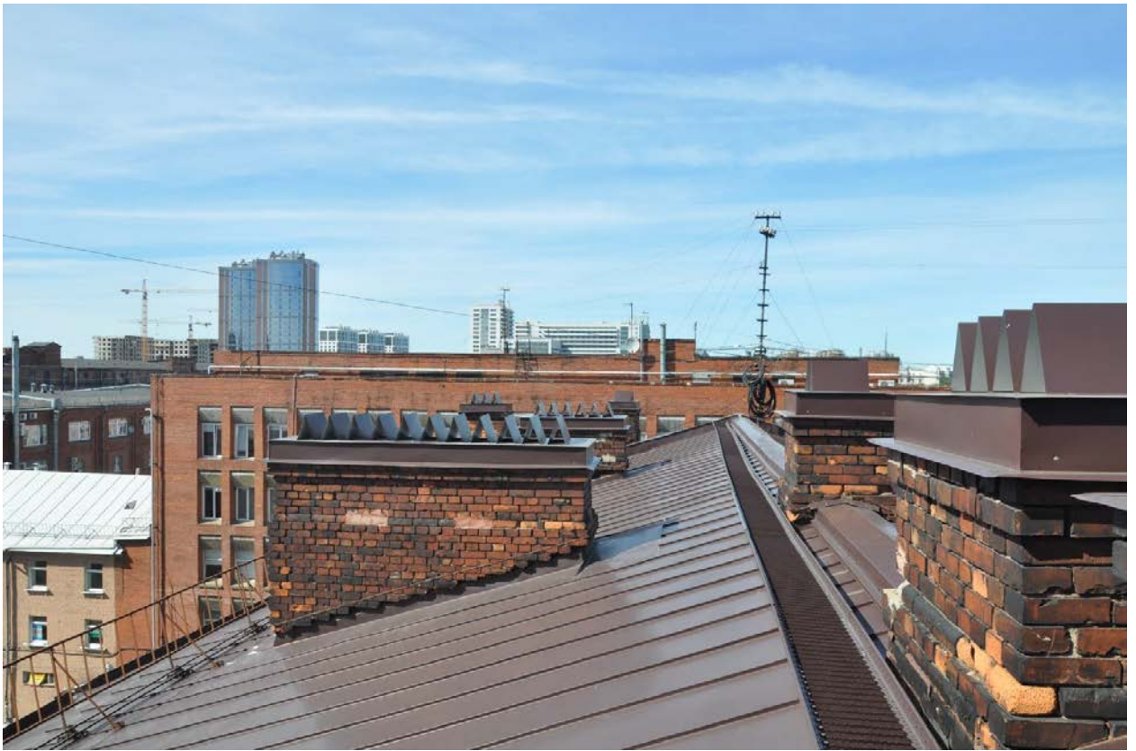
Фото 23. Вид с кровли на Заставскую улицу.
