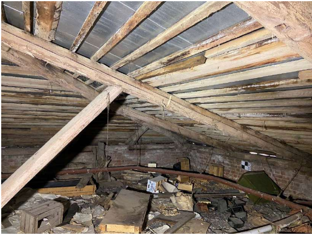
Фото №39. Чердачное пространство.
