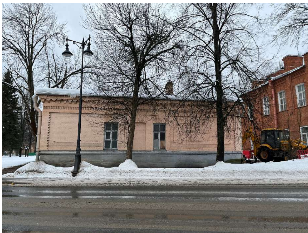
Фото №1. Северо-восточный фасад, общий вид.
