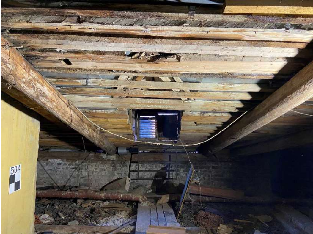
Фото №41. Чердачное пространство, слуховое окно.
