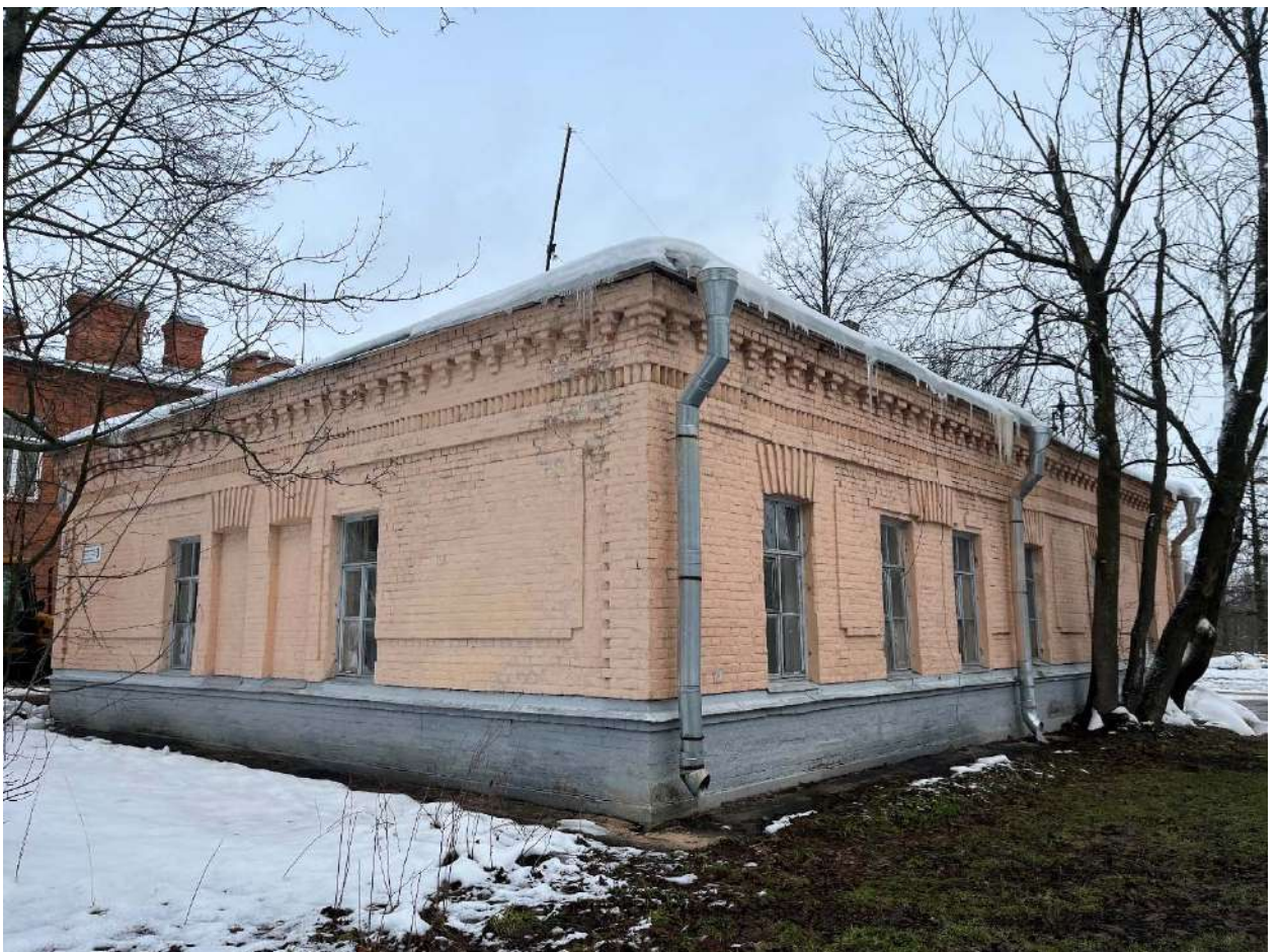
Фото №2. Юго-западный и юго-восточный фасады здания.
