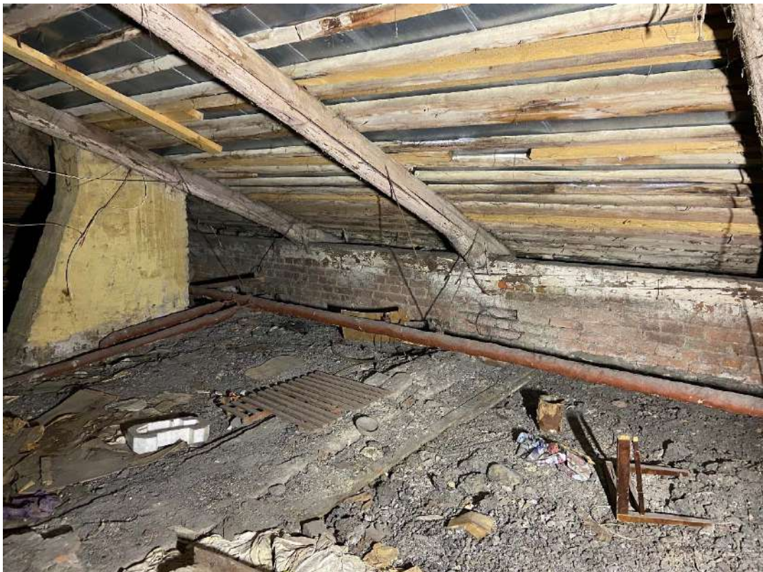
Фото №40. Чердачное пространство.
