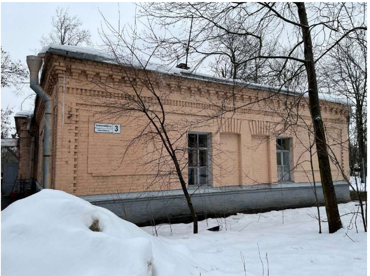
Фото №4. Юго-западный фасад здания.
