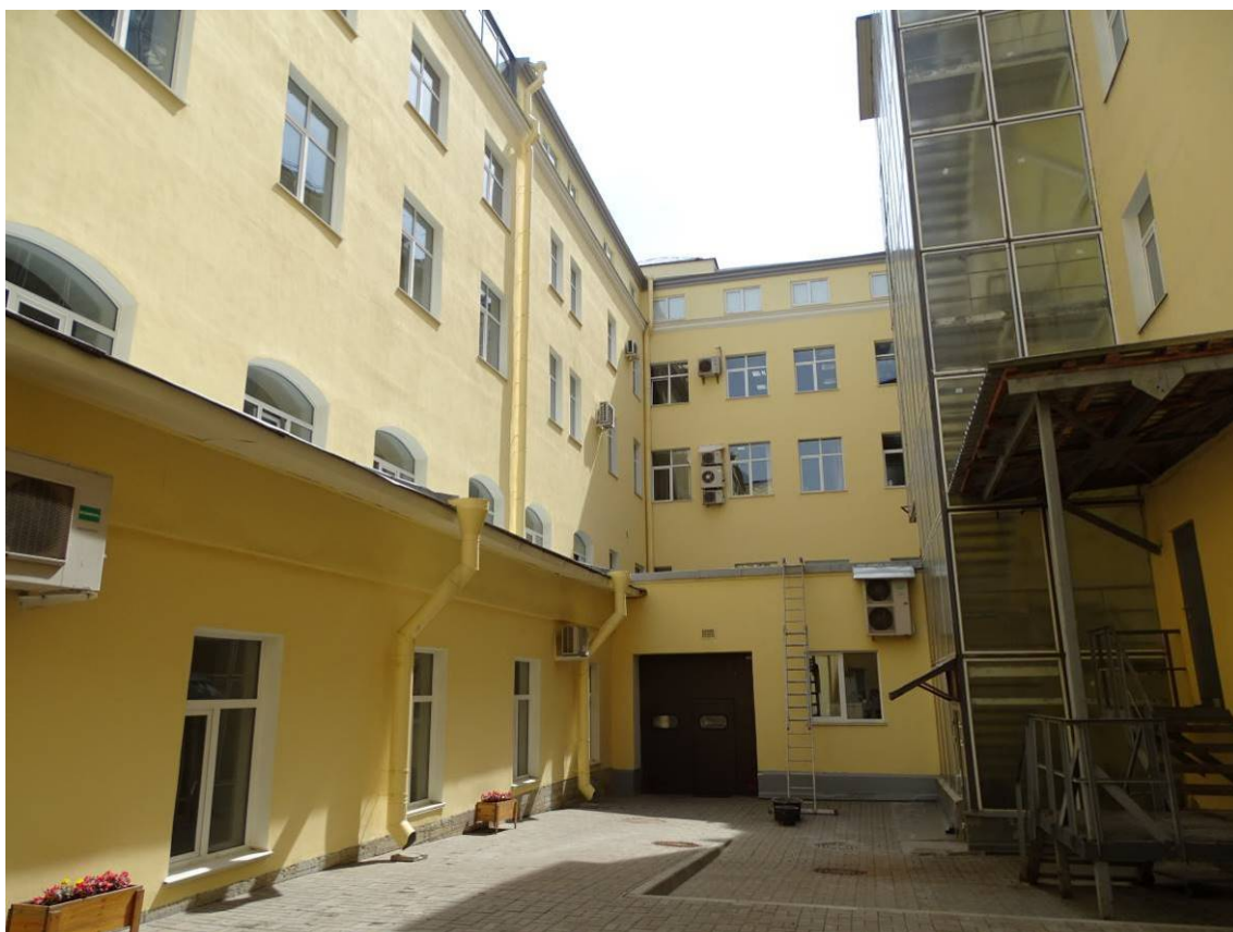
Фото 9. Выявленный объект культурного наследия «Склады торгового дома "Братья Елисеевы" (здание ГОИ им. С. И. Вавилова)». Дворовой фасад. Фрагмент. Съемка 10.06.2022 г. Трушковский В.Э.
