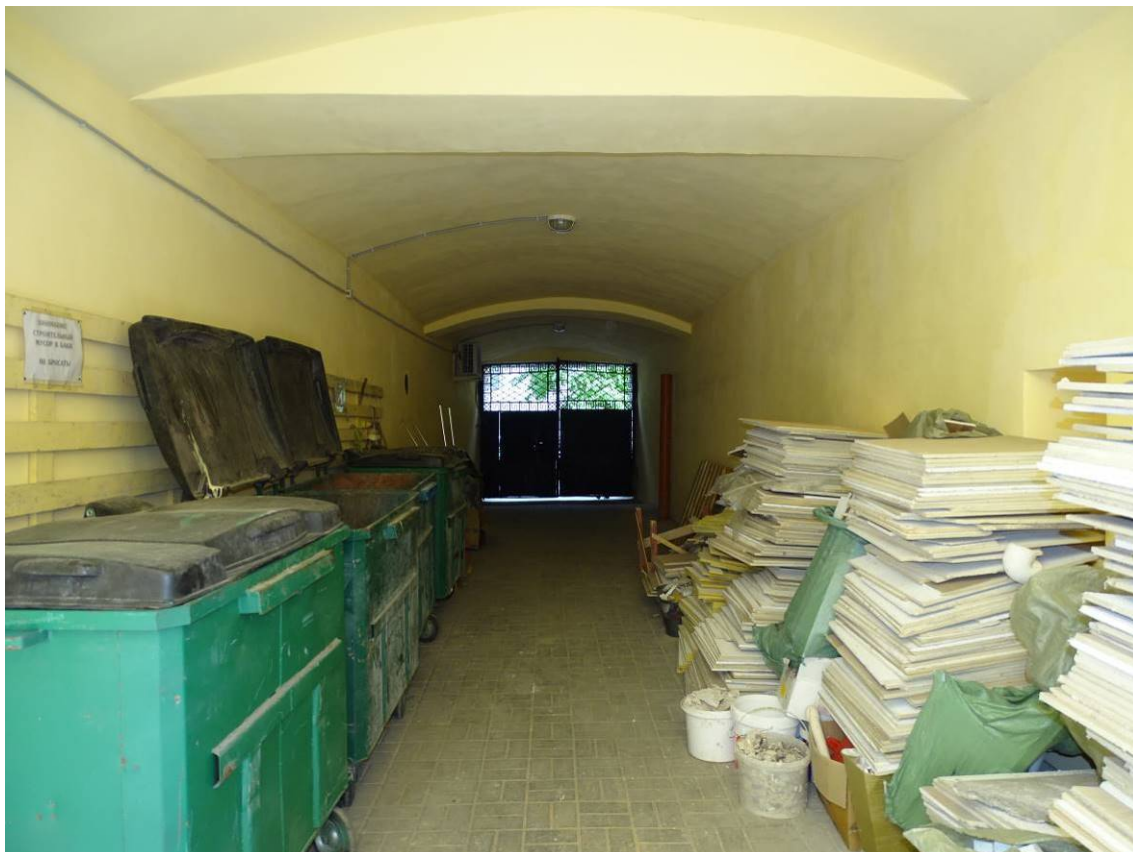
Фото 8. Выявленный объект культурного наследия «Склады торгового дома "Братья Елисеевы" (здание ГОИ им. С. И. Вавилова)». Воротный проезд. Съемка 10.06.2022 г. Трушковский В.Э.
