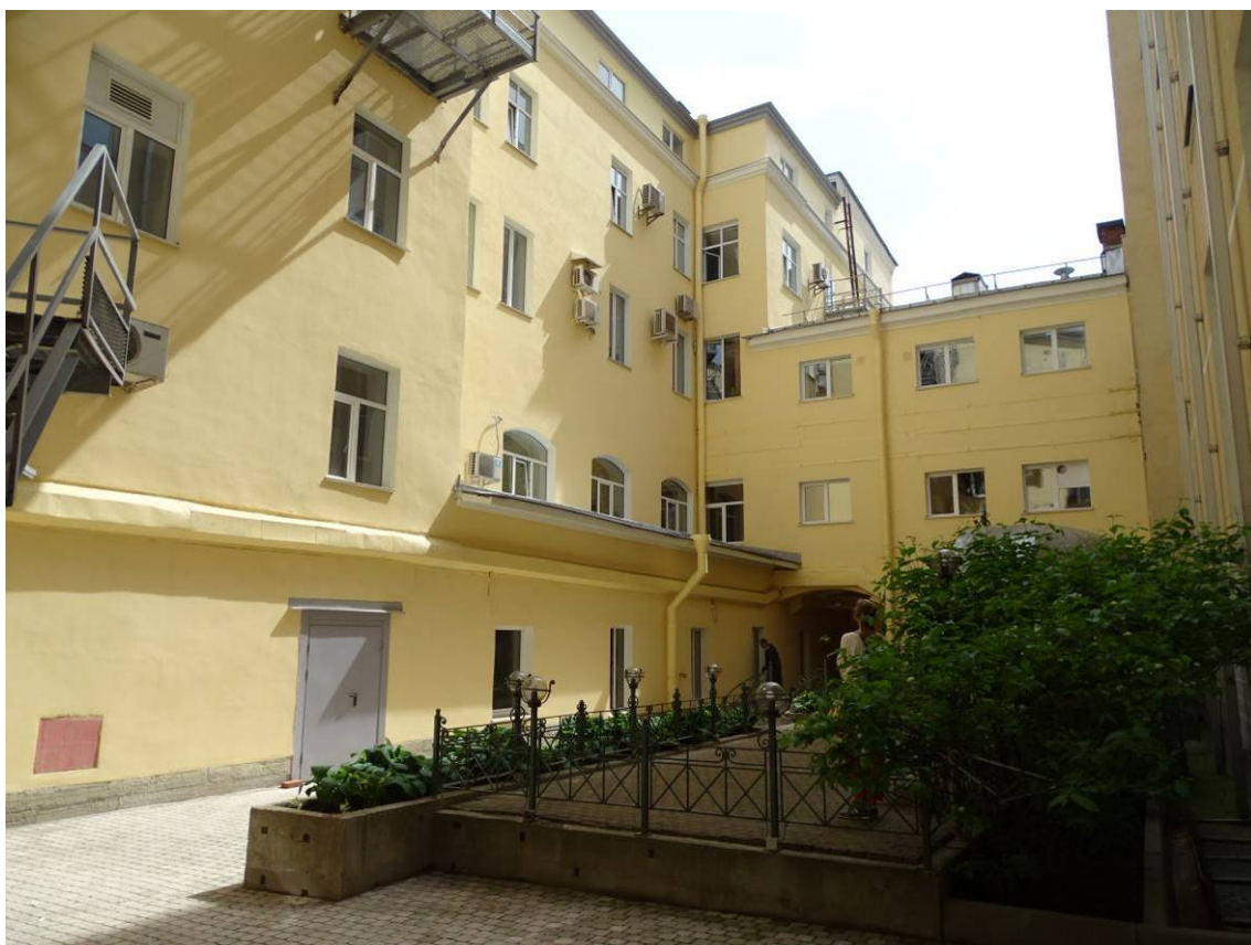
Фото 5. Выявленный объект культурного наследия «Склады торгового дома "Братья Елисеевы" (здание ГОИ им. С. И. Вавилова)». Дворовой фасад. Фрагмент. Съемка 10.06.2022 г. Трушковский В.Э.
