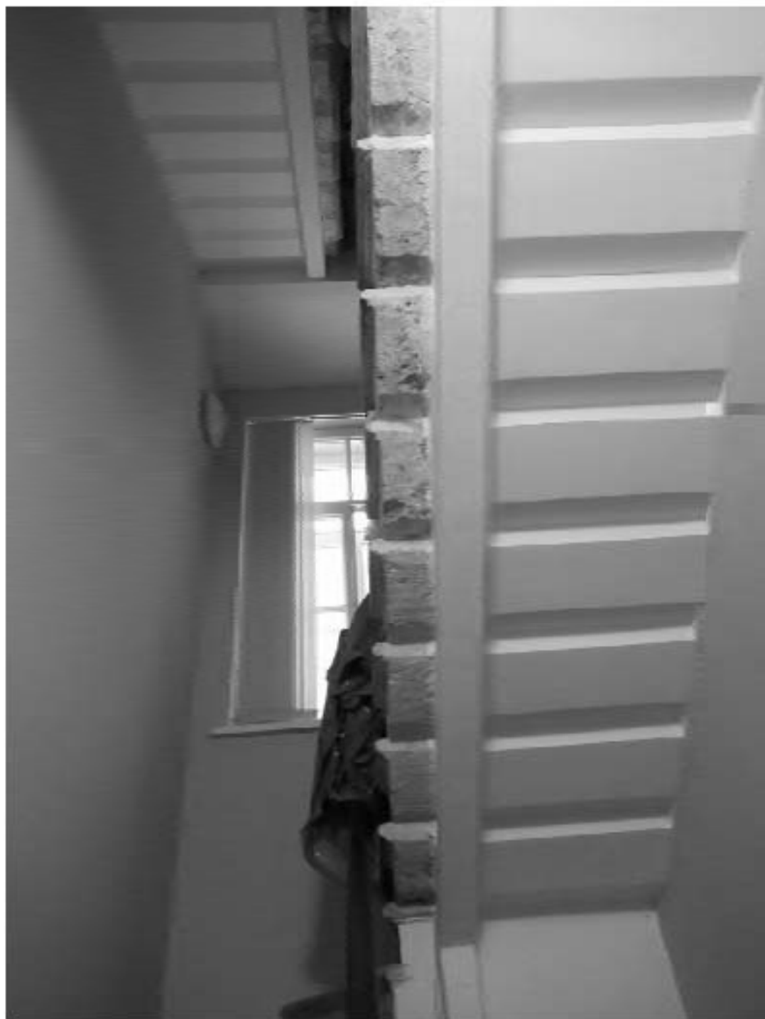
26. ОКН "Усадьба Военного министра", расположенный по адресу: г. Санкт-Петербург, ул. Садовая, д. 4, лит. А Особняк. Историческая служебная лестница Л-2. Дата фотофиксации: 17.11.2021
