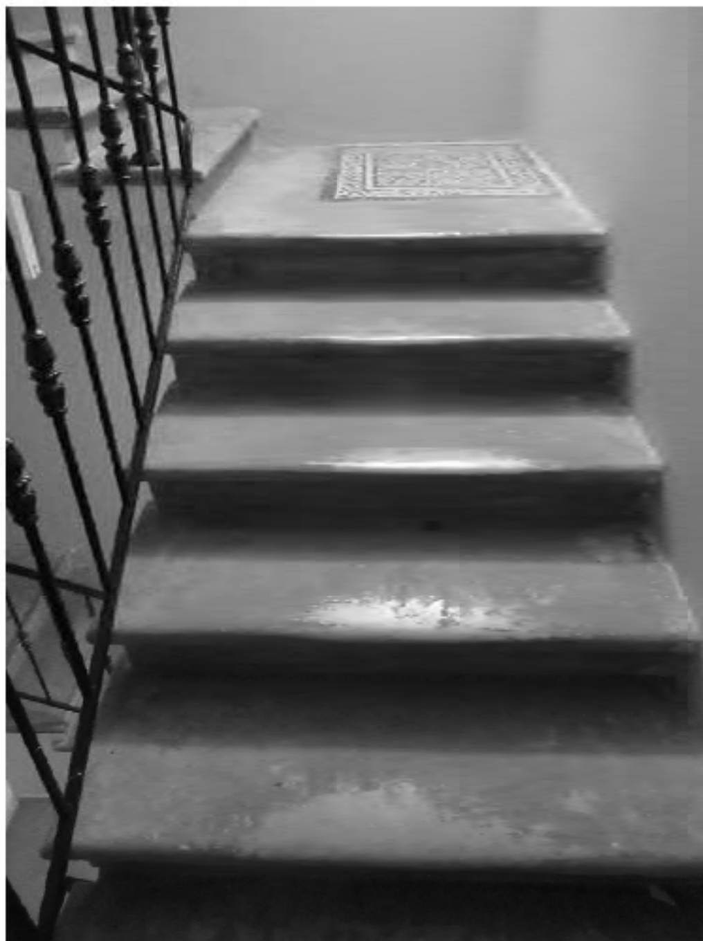
34. ОКН "Усадьба Военного министра", расположенный по адресу: г. Санкт-Петербург, ул. Садовая, д. 4, лит. А. Особняк. Историческая служебная лестница Л-3. Дата фотофиксации: 17.11.2021
