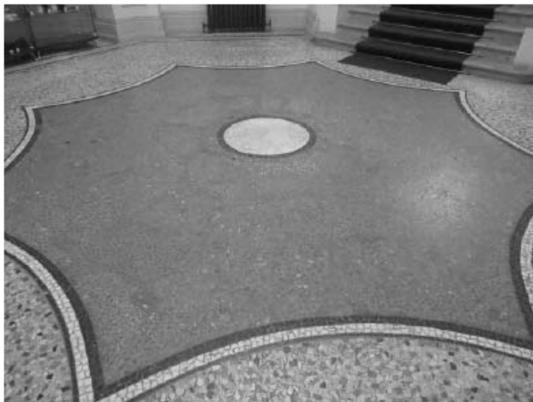
5. ОКН "Усадьба Военного министра", расположенный по адресу: г. Санкт-Петербург, ул. Садовая, д. 4, лит. А. Особняк. Вестибюль. Нижний уровень. Дата фотофиксации: 17.11.2021
