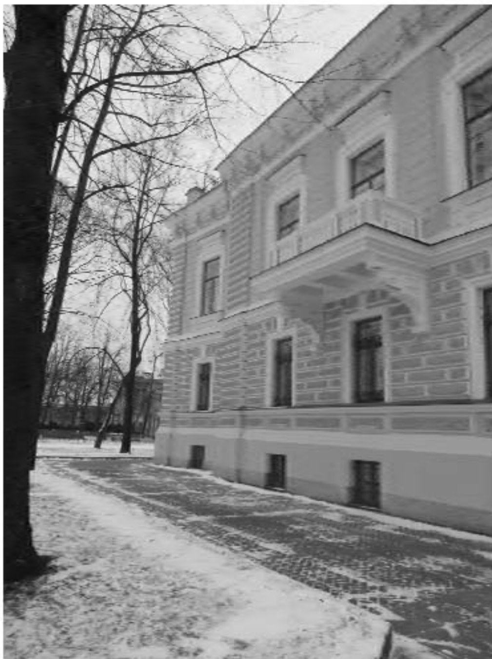
10. ОКН "Усадьба Военного министра", расположенный по адресу: г. Санкт-Петербург, ул. Садовая, д. 4, лит. А. Северный фасад (Особняк). Дата фотофиксации: 17.11.2021
