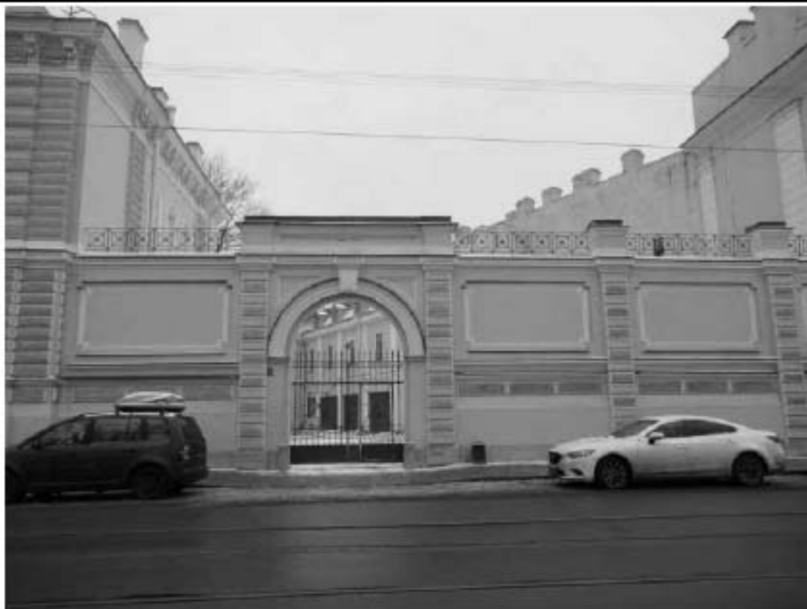
1. ОКН "Усадьба Военного министра", расположенный по адресу: г. Санкт-Петербург, ул. Садовая, д. 4, лит. А. Каменные ворота с оградой. Дата фотофиксации: 17.11.2021
