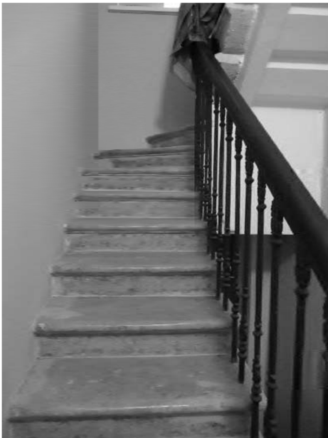
25. ОКН "Усадьба Военного министра", расположенный по адресу: г. Санкт-Петербург, ул. Садовая, д. 4, лит. А. Особняк. Историческая служебная лестница Л-2. Дата фотофиксации: 17.11.2021
