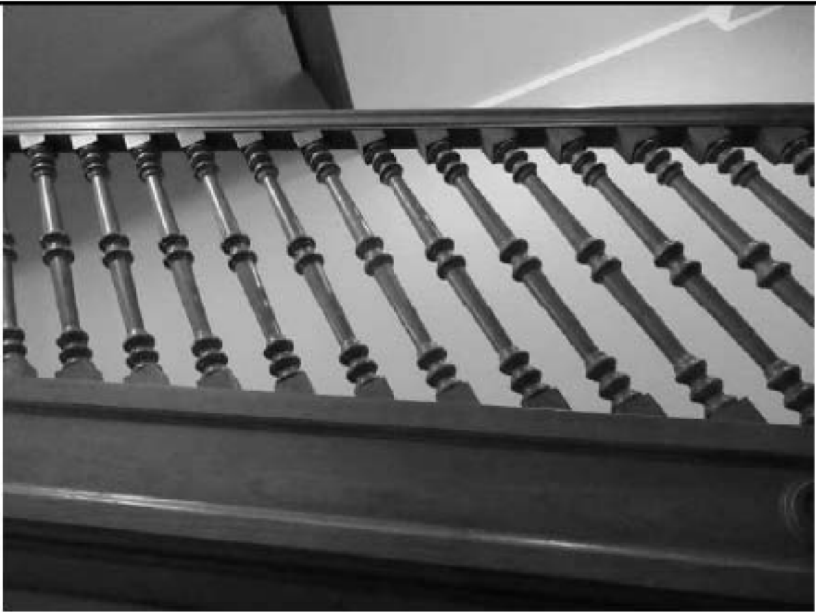
21. ОКН "Усадьба Военного министра", расположенный по адресу: г. Санкт-Петербург, ул. Садовая, д. 4, лит. А. Особняк. Дубовая лестница. Дата фотофиксации: 17.11.2021
