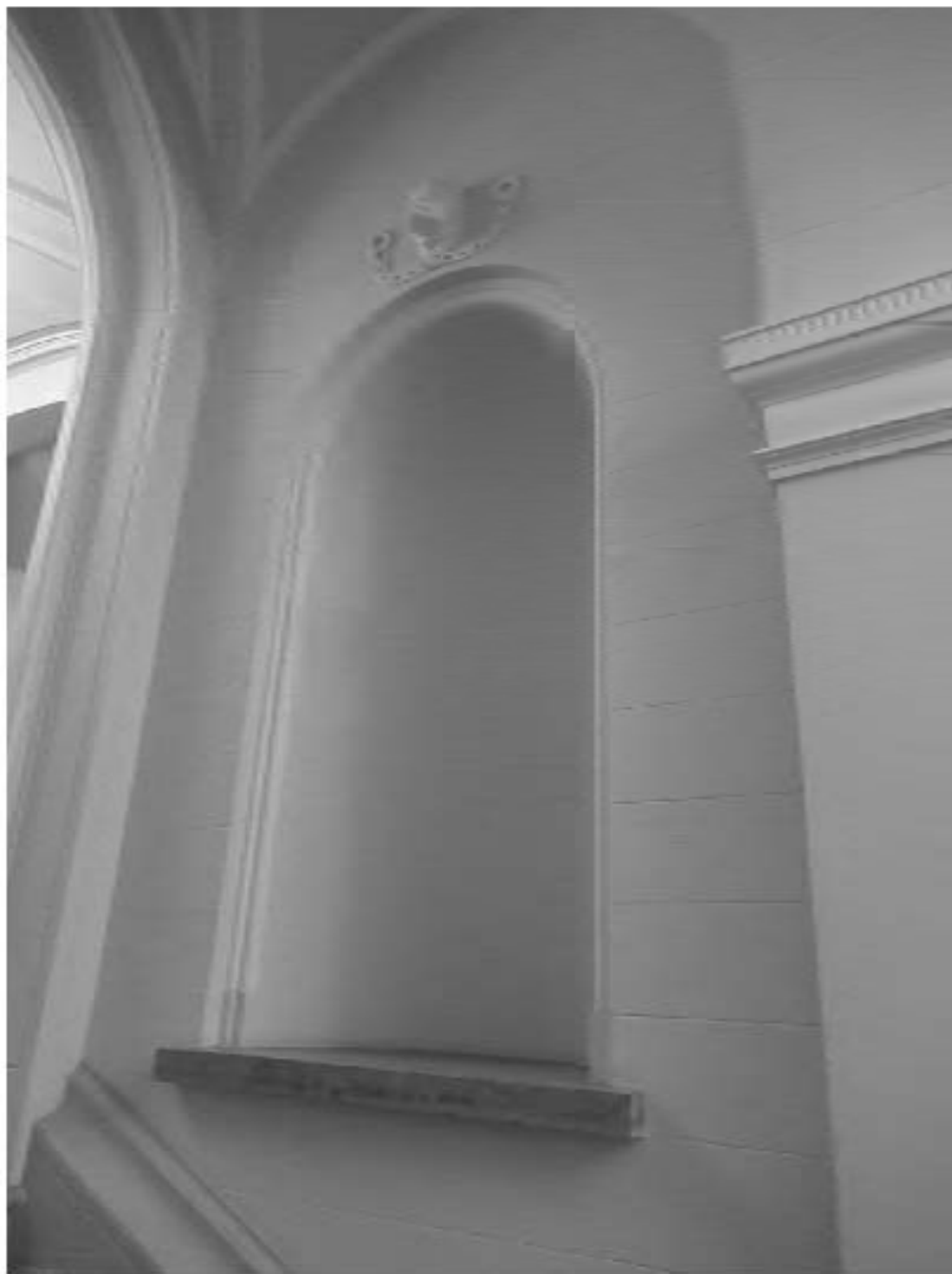
10. ОКН "Усадьба Военного министра", расположенный по адресу: г. Санкт-Петербург, ул. Садовая, д. 4, лит. А. Особняк. Вестибюль. Нижний уровень. Дата фотофиксации: 17.11.2021
