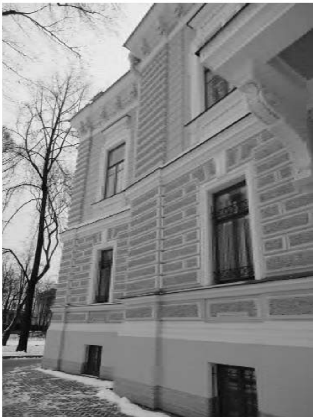
12. ОКН "Усадьба Военного министра", расположенный по адресу: г. Санкт-Петербург, ул. Садовая, д. 4, лит. А. Северный фасад (Особняк). Дата фотофиксации: 17.11.2021
