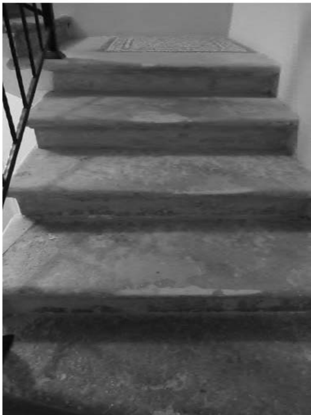
34. ОКН "Усадьба Военного министра", расположенный по адресу: г. Санкт-Петербург, ул. Садовая, д. 4, лит. А. Особняк. Историческая служебная лестница Л-3. Дата фотофиксации: 17.11.2021
