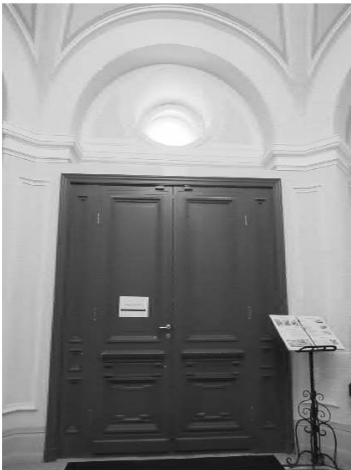
3. ОКН "Усадьба Военного министра", расположенный по адресу: г. Санкт-Петербург, ул. Садовая, д. 4, лит. А. Особняк. Вестибюль. Нижний уровень. Дата фотофиксации: 17.11.2021
