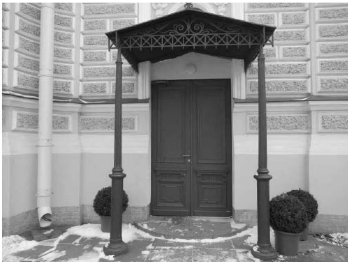
9. ОКН "Усадьба Военного министра", расположенный по адресу: г. Санкт-Петербург, ул. Садовая, д. 4, лит. А. Крыльцо северного фасада (Особняк). Дата фотофиксации: 17.11.2021
