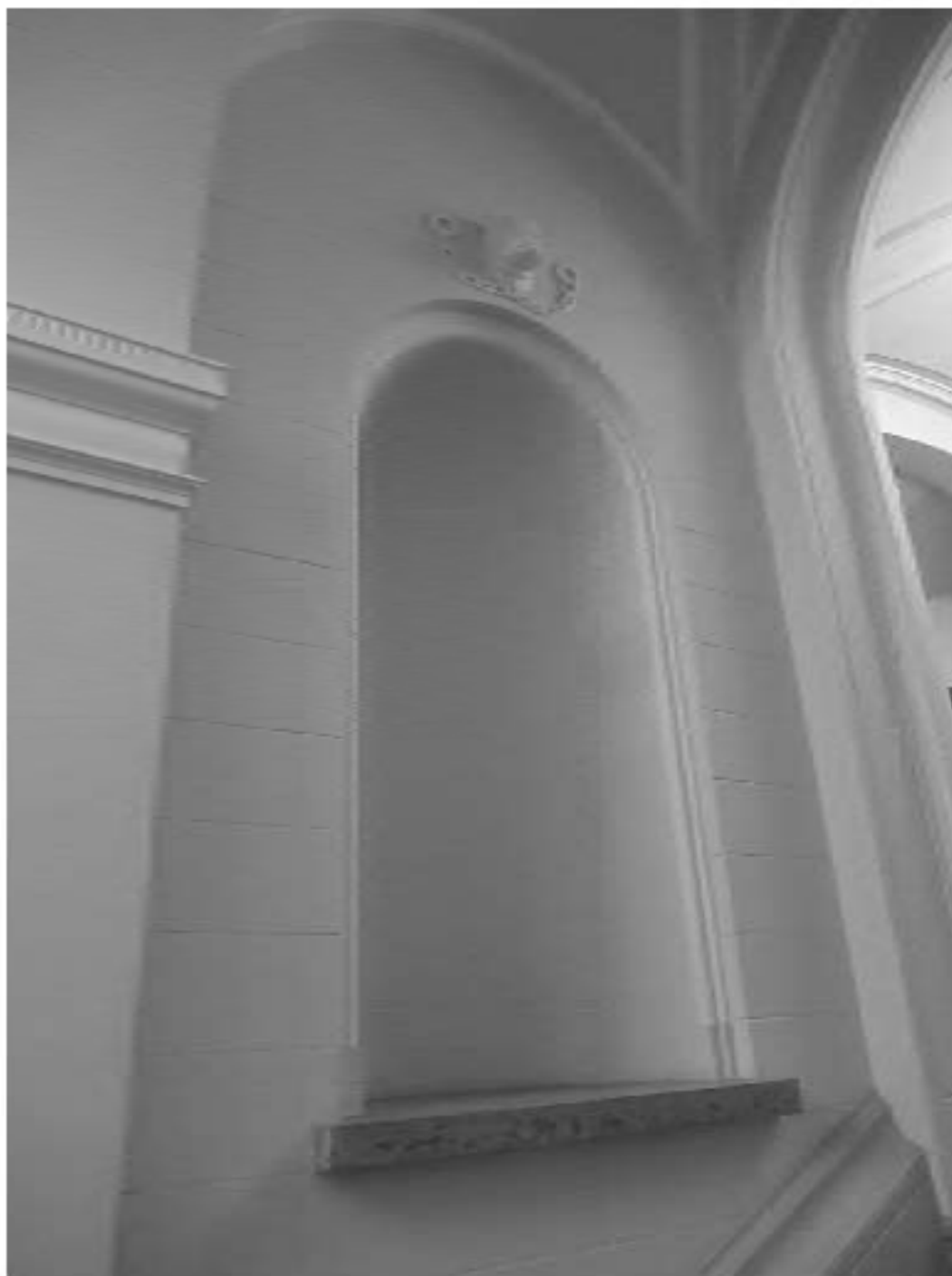
9. ОКН "Усадьба Военного министра", расположенный по адресу: г. Санкт-Петербург, ул. Садовая, д. 4, лит. А. Особняк. Вестибюль. Нижний уровень. Дата фотофиксации: 17.11.2021
