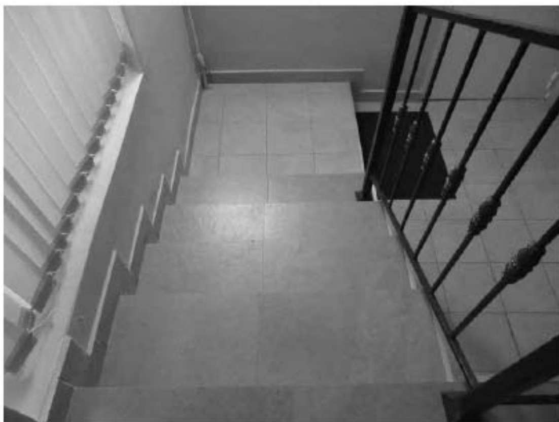
31. ОКН "Усадьба Военного министра", расположенный по адресу: г. Санкт-Петербург, ул. Садовая, д. 4, лит. А. Особняк. Историческая служебная лестница Л-3. Дата фотофиксации: 17.11.2021
