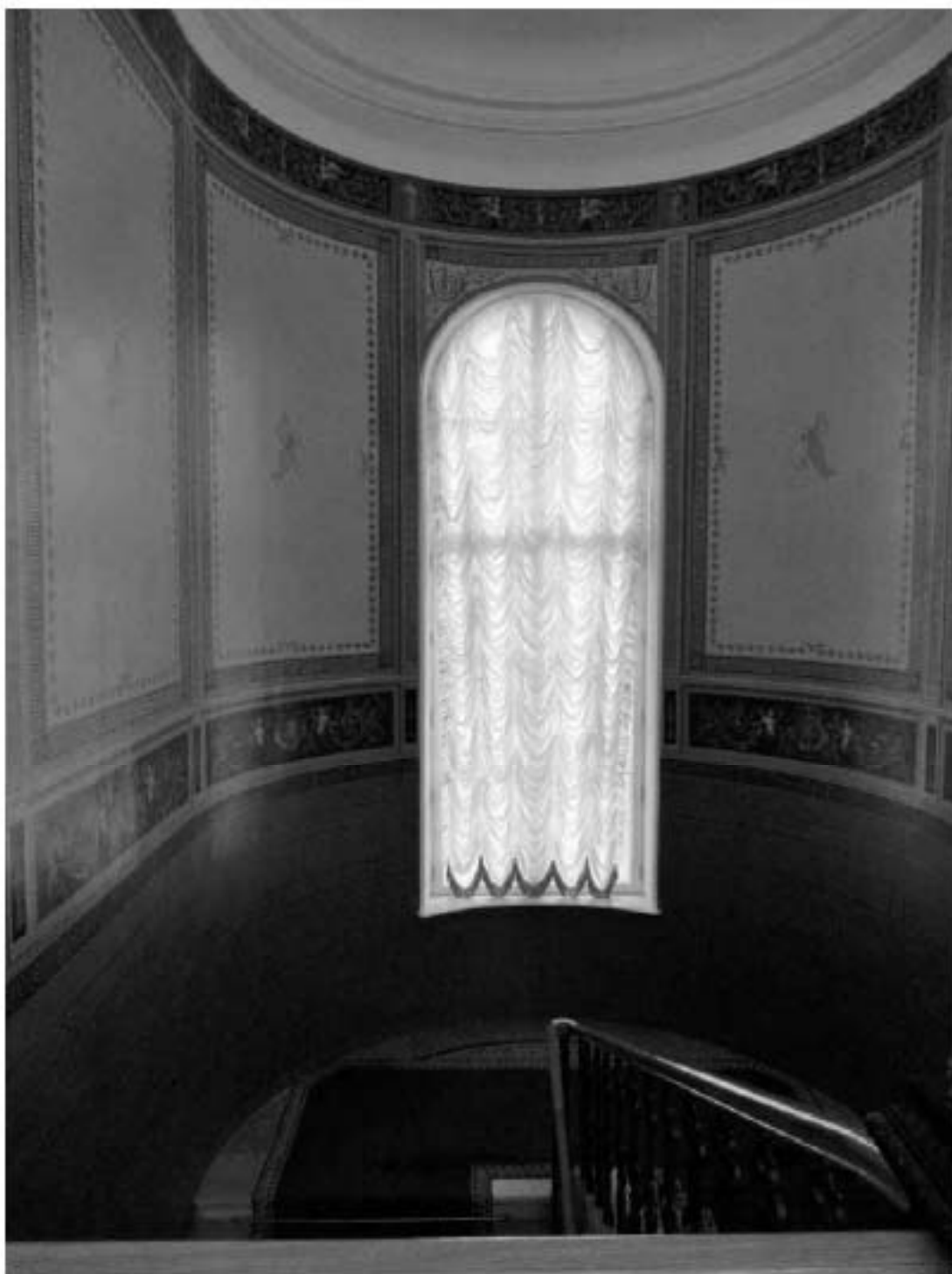
3. ОКН "Усадьба Военного министра", расположенный по адресу: г. Санкт-Петербург, ул. Садовая, д. 4, лит. А. Парадная лестница. Вид на площадку. Дата фотофиксации: 17.11.2021
