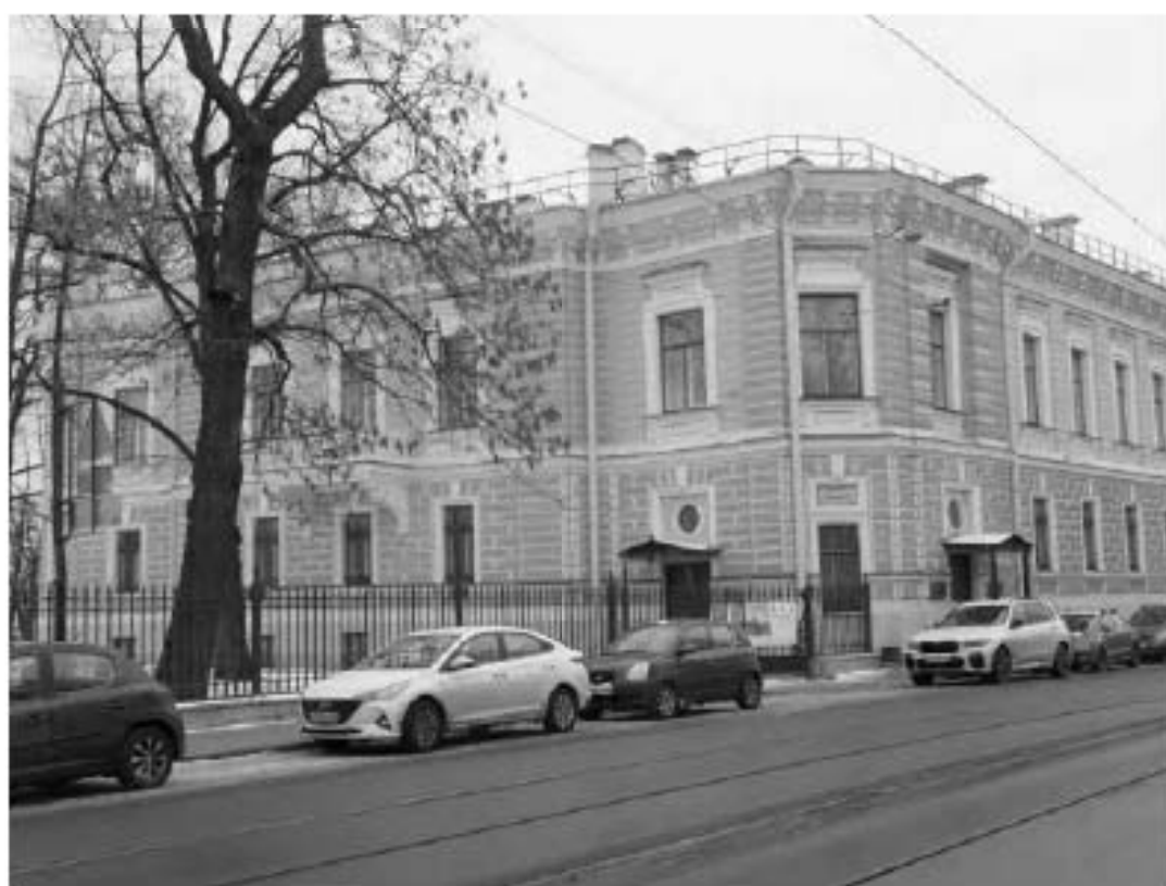
6. ОКН "Усадьба Военного министра", расположенный по адресу: г. Санкт-Петербург, ул. Садовая, д. 4, лит. А. Северный фасад (Особняк). Дата фотофиксации: 17.11.2021
