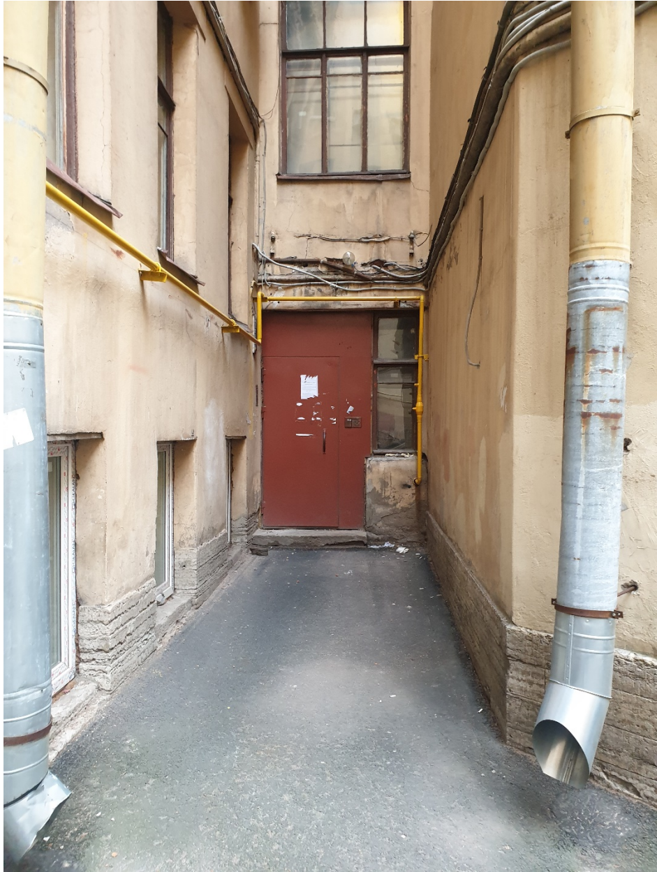
Фото 8 – Дворовой фасад. Вход в подъезд.
