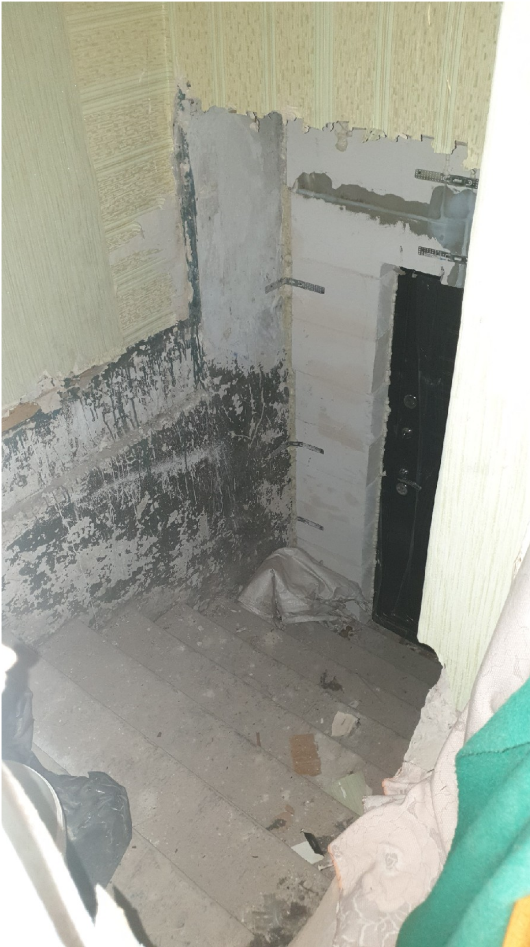
Фото 20 – Устроенный вход со стороны арки
