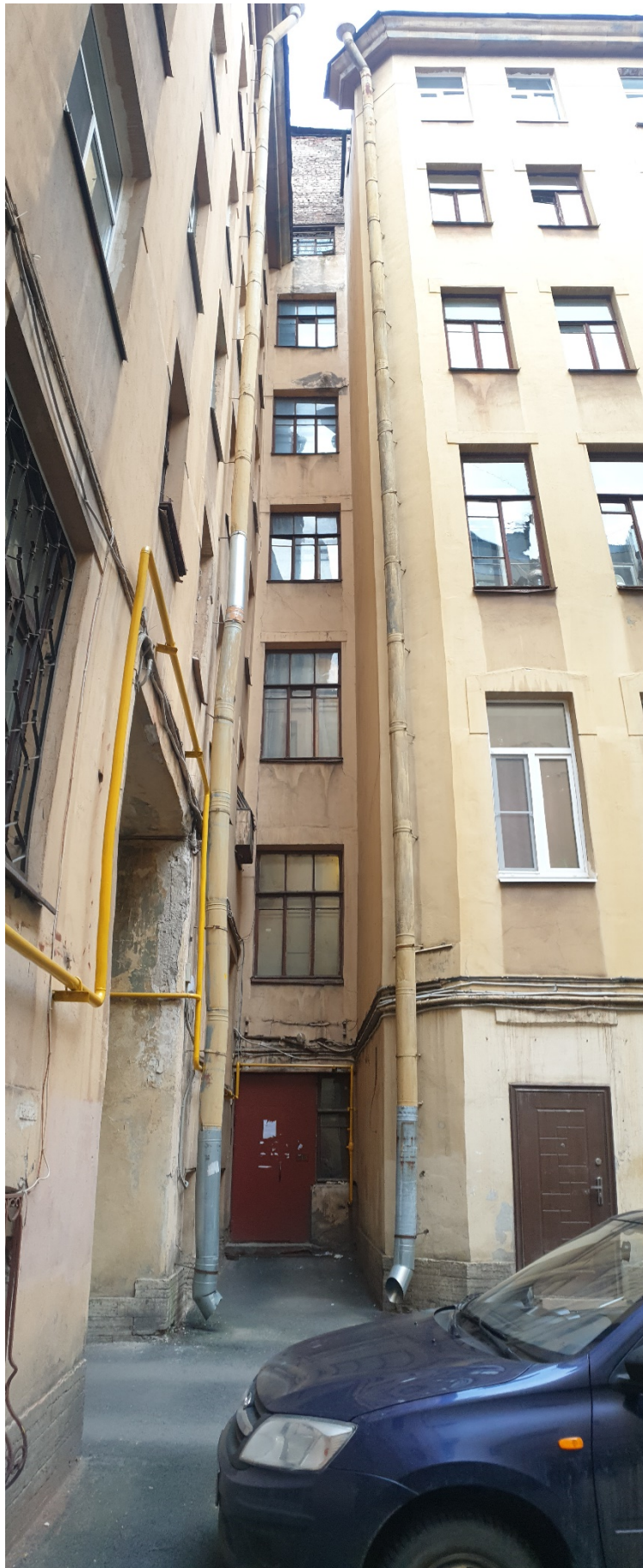
Фото 4 – Дворовой фасад. Вход в подъезд, слева арка.
