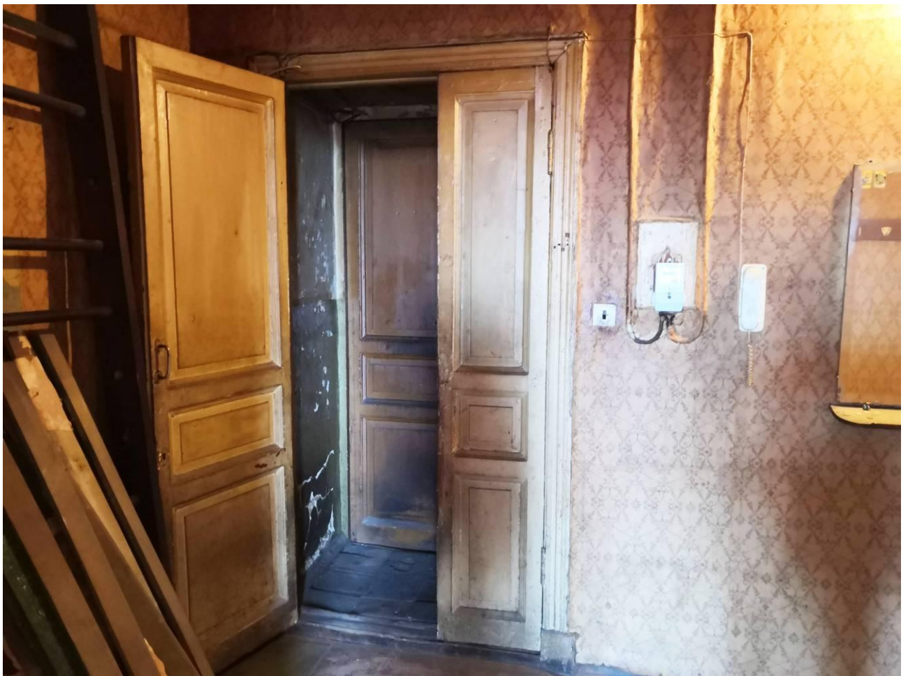
Фото 13. Холл (помещение 1). Вид на входную дверь.
