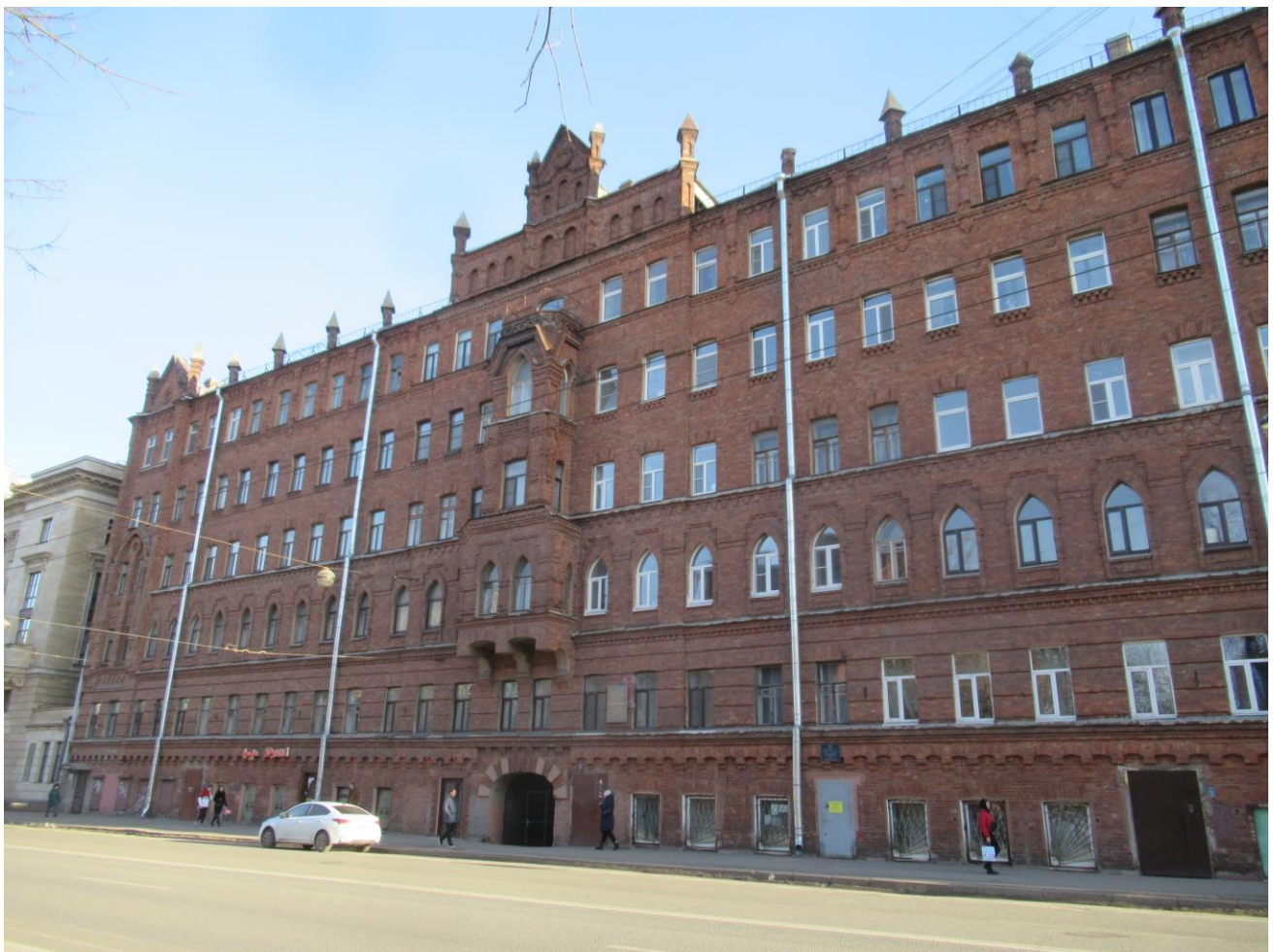
Фото 2. Общий вид лицевого фасада объекта культурного наследия регионального значения «Дом Еремеевой А.А.» со стороны Большого проспекта. Фрагмент.
