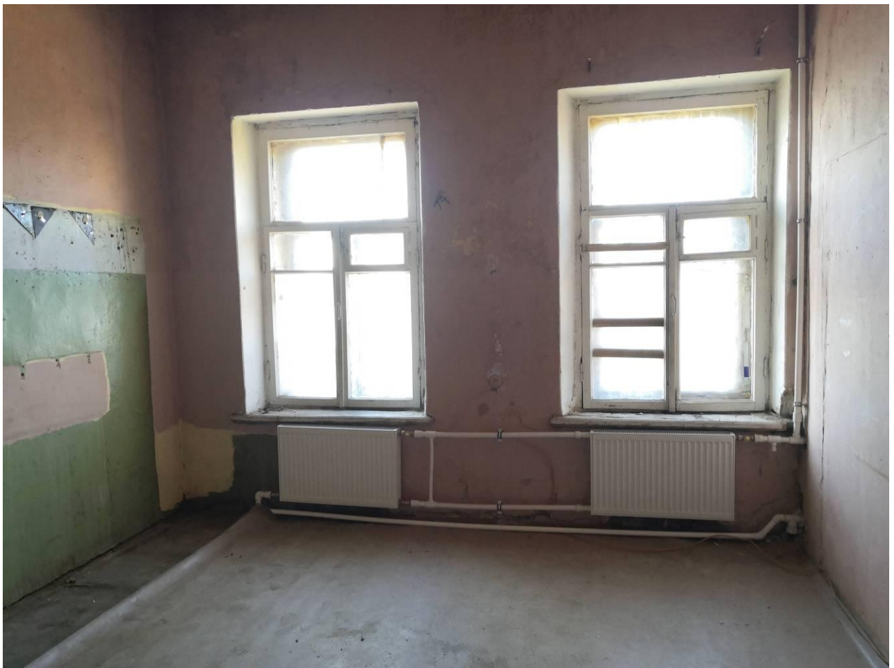
Фото 20. Кухня (помещение 3). Вид в сторону окон.
