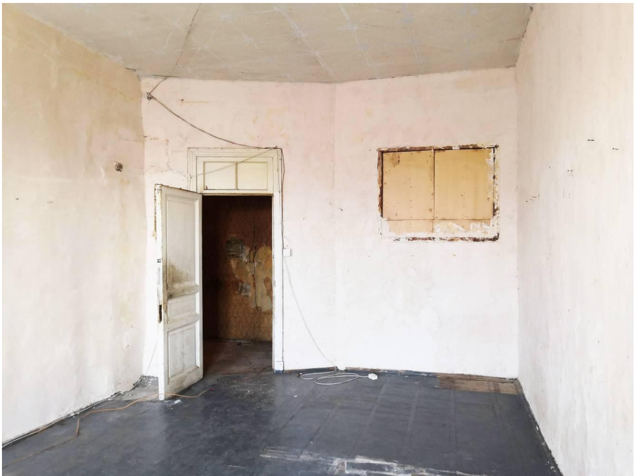
Фото 18. Жилая комната (помещение 5). Вид от окон.
