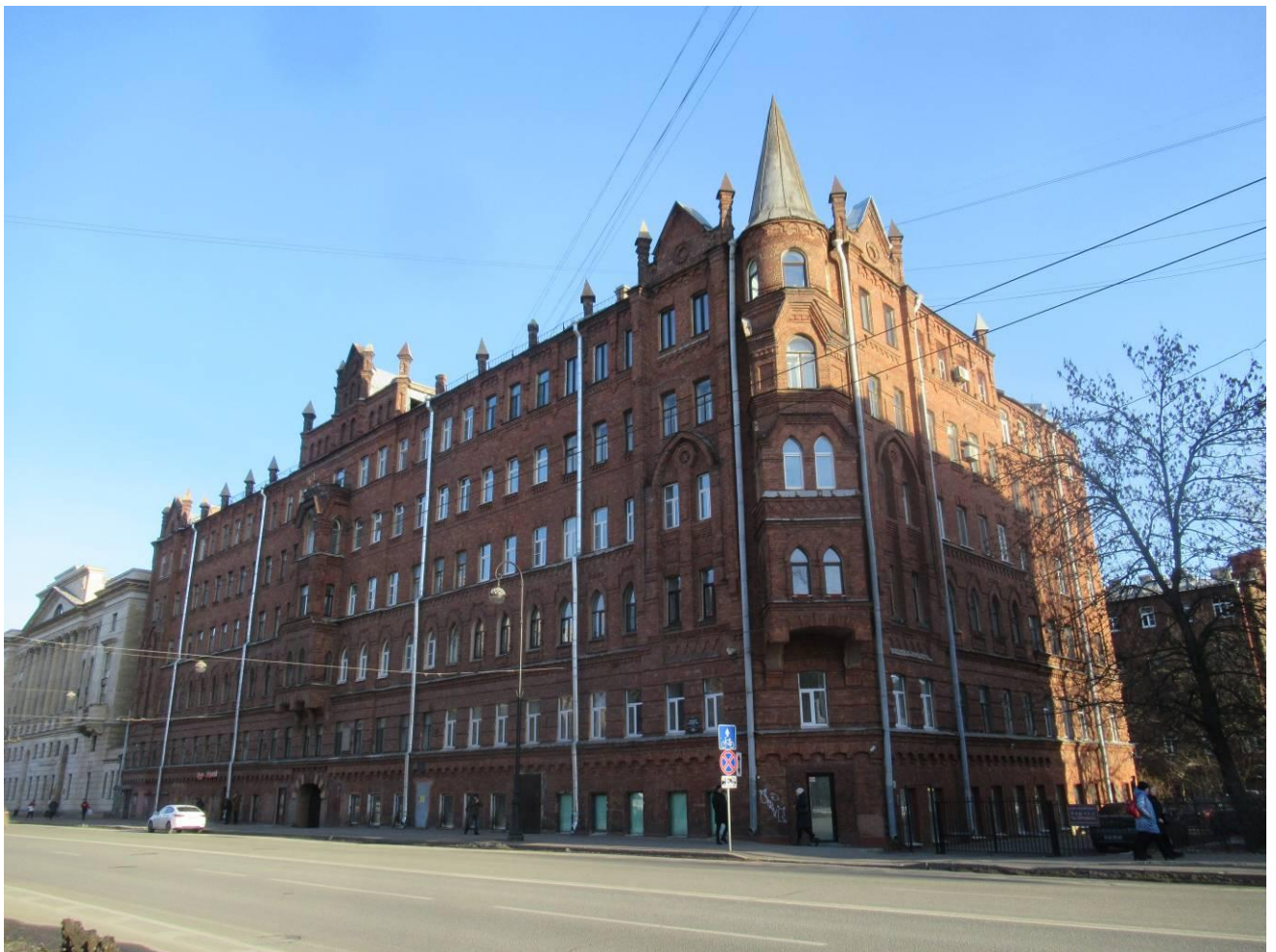
Фото 1. Общий вид лицевых фасадов объекта культурного наследия регионального значения «Дом Еремеевой А.А.» со стороны Большого проспекта.
