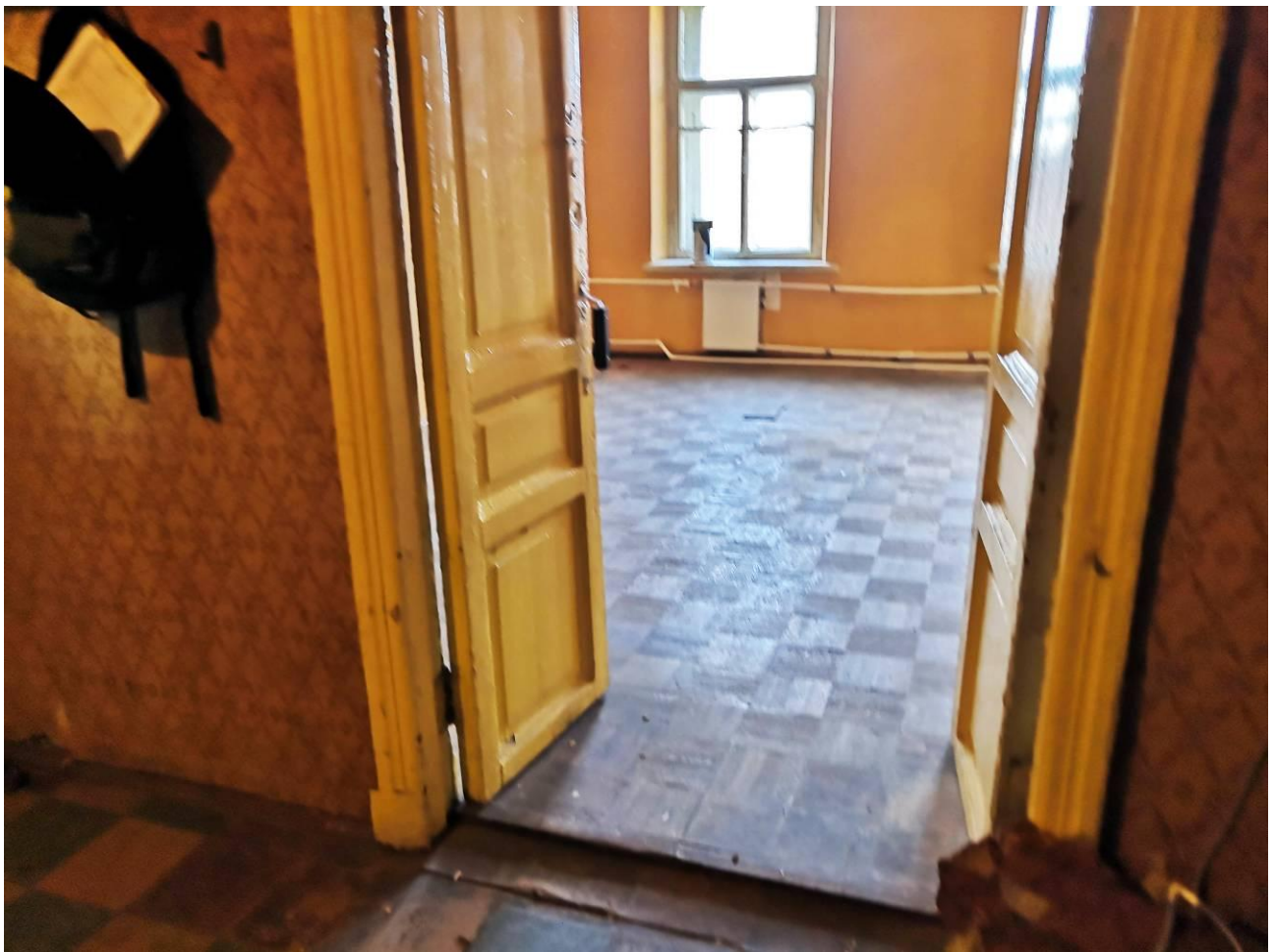
Фото 14. Вид из холла (помещение 1) в жилую комнату (помещение 6).
