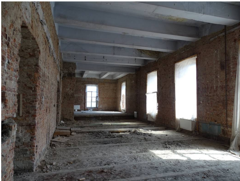
Илл. 77. Второй этаж. Помещение 152. Съемка 22.04.21 г. Трушковский В.Э.
