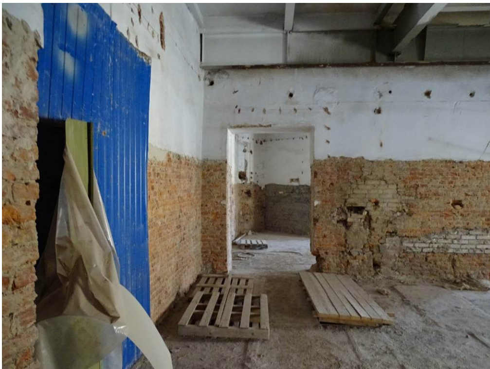
Илл. 21. Четвертый этаж. Помещение 279. Съемка 22.04.21 г. Трушковский В.Э.
