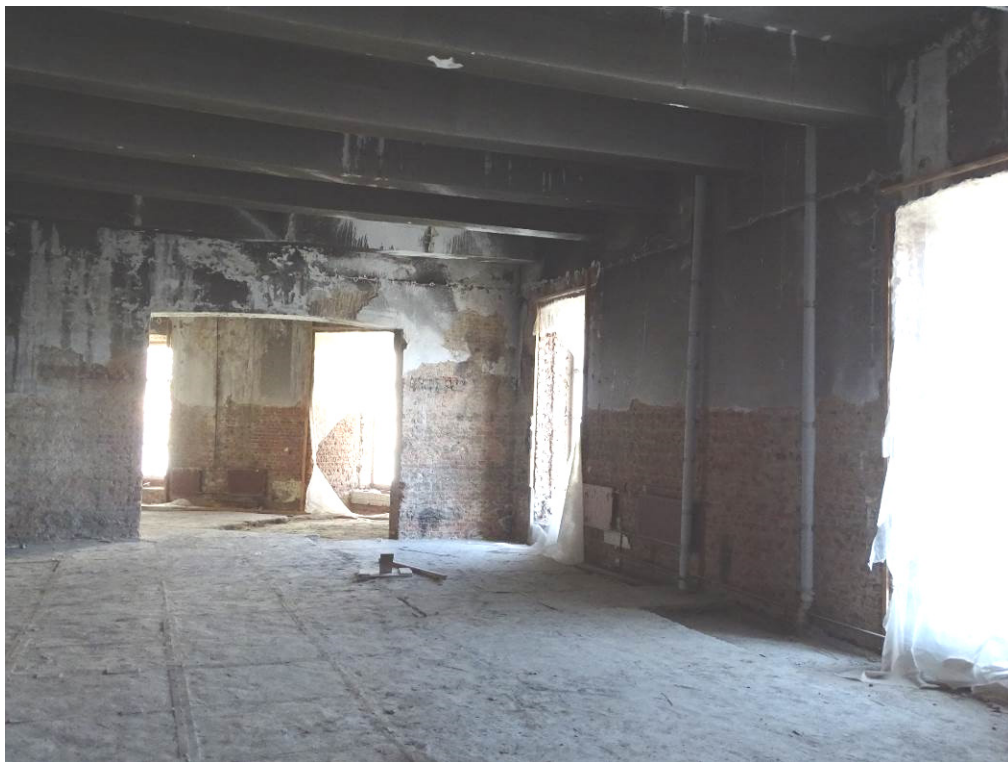
Илл. 7. Третий этаж. Помещение 242. Съемка 22.04.21 г. Трушковский В.Э.
