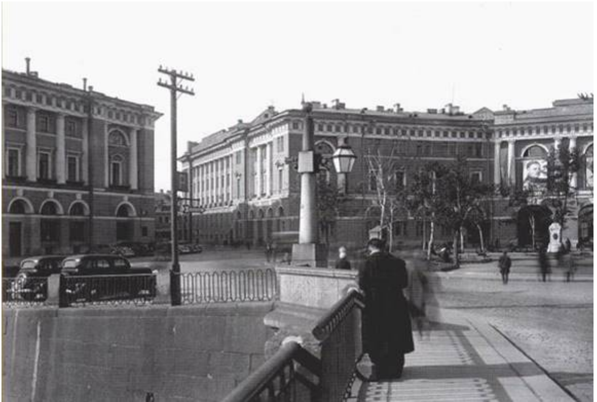
48. Здание Министерства внутренних дел у Чернышева моста. 1937 г. // ЦГАКФФД СПб. // Лебедев С. Комитет по градостроительству и архитектуре.
