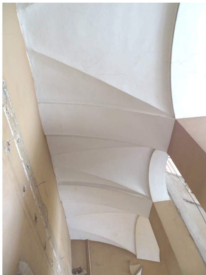
Илл. 37. Фрагмент потолка лестницы. Съемка 22.04.21 г. Трушковский В.Э.
