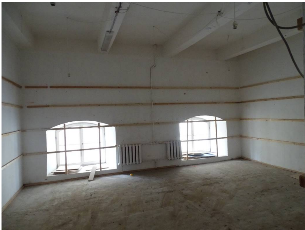
Илл. 69. Второй этаж. Помещение 176. Съемка 22.04.21 г. Трушковский В.Э.
