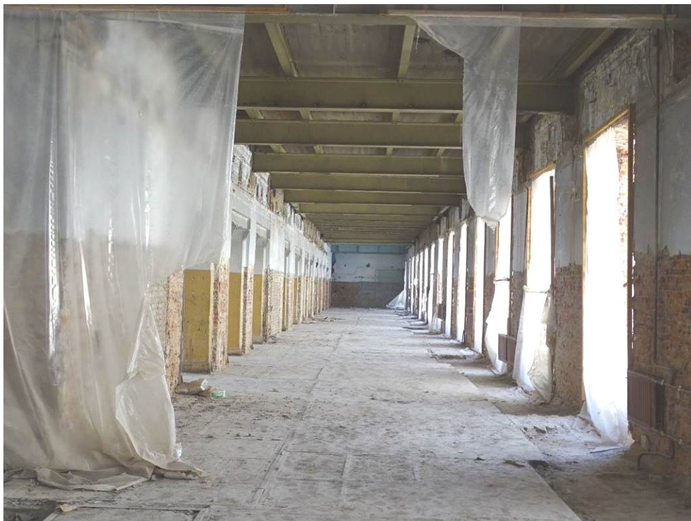
Илл. 11. Третий этаж. Помещение 242. Съемка 22.04.21 г. Трушковский В.Э.
