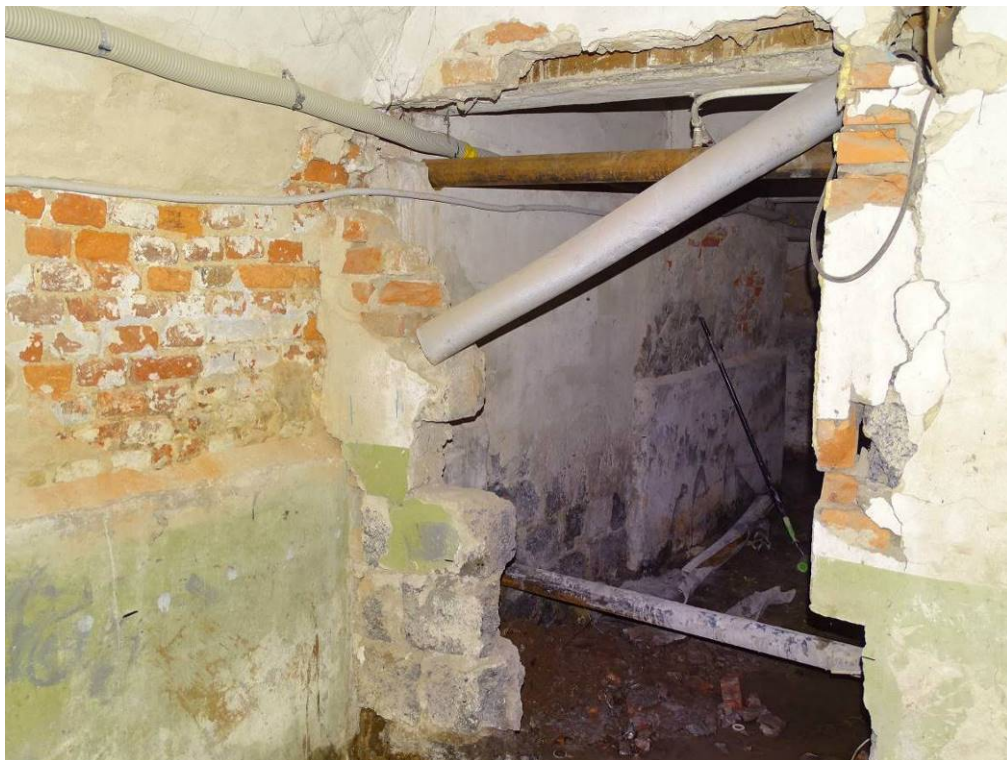
Илл. 3. Подвал 5-Н. Помещение 5/31,9. Съемка 22.04.21 г. Трушковский В.Э.
