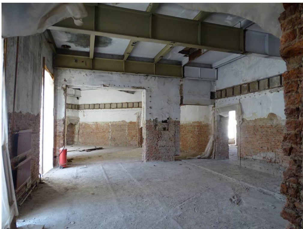
Илл. 4. Третий этаж. Помещение 219. Съемка 22.04.21 г. Трушковский В.Э.
