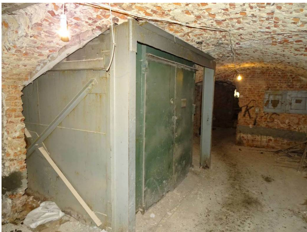
Илл. 14. Подвал 1-Н. Помещение 22. Съемка 22.04.21 г. Трушковский В.Э.
