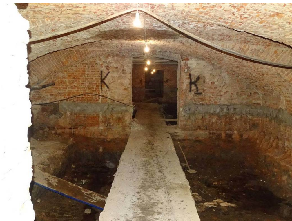
Илл. 10. Подвал 1-Н. Помещение 12. Съемка 22.04.21 г. Трушковский В.Э.
