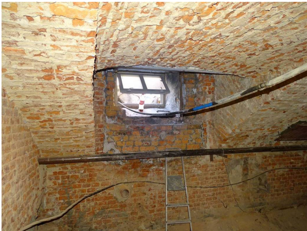
Илл. 11. Подвал 1-Н. Помещение 12. Съемка 22.04.21 г. Трушковский В.Э.
