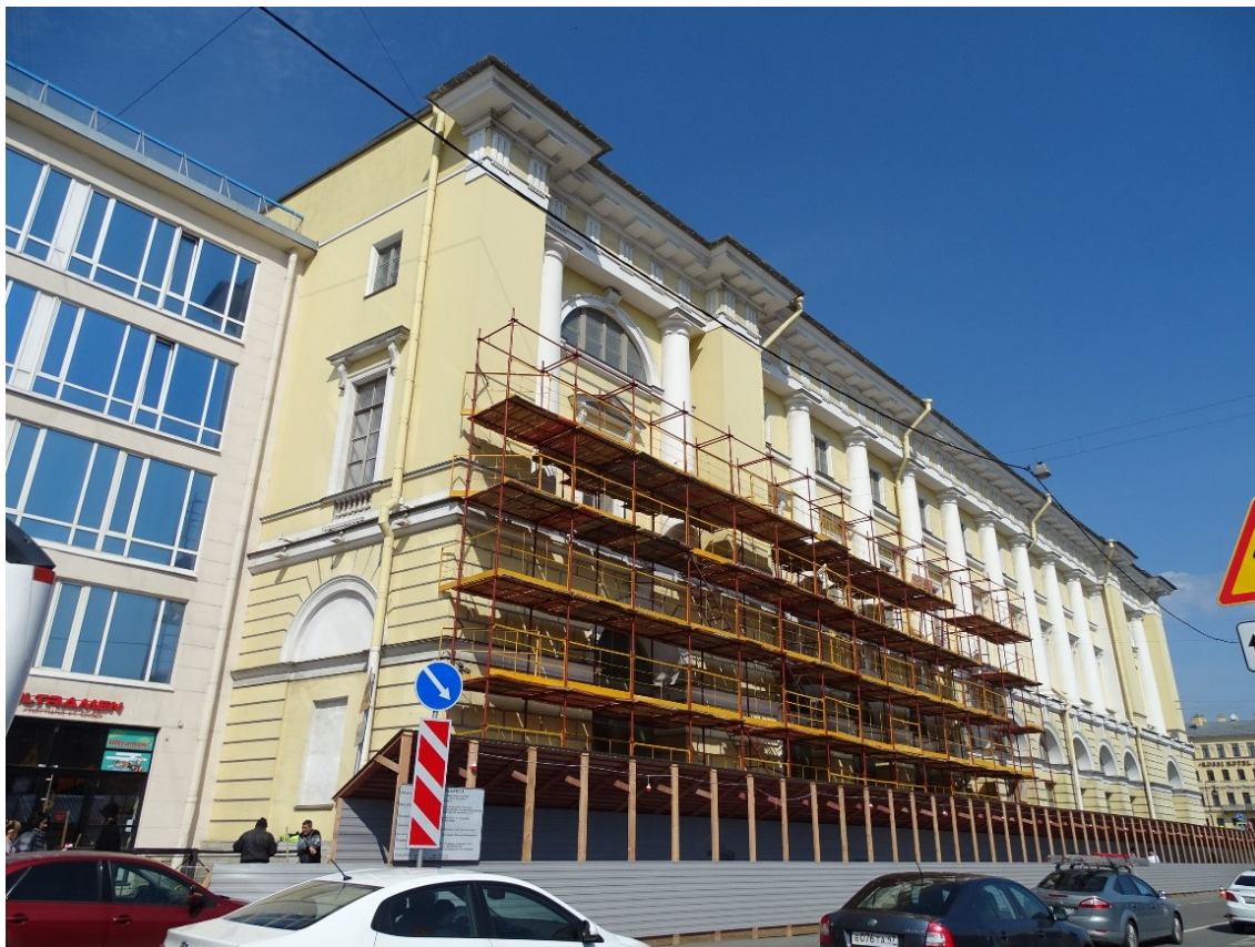
Илл. 7. Юго-восточный фасад. Съемка 22.04.21 г. Трушковский В.Э.
