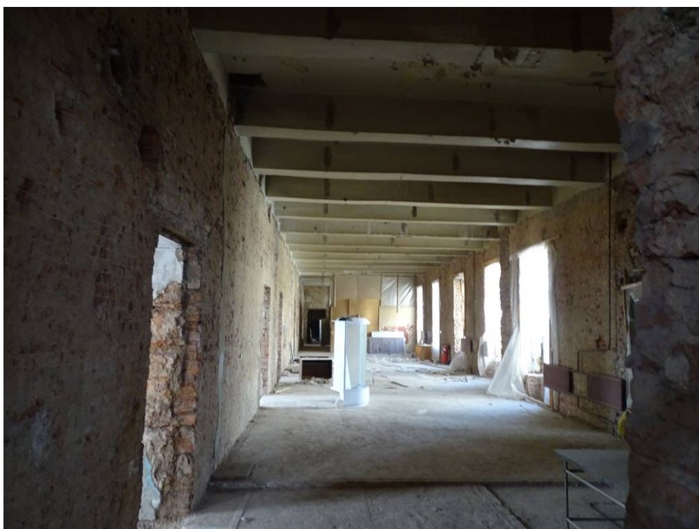
Илл. 80. Второй этаж. Помещение 131. Съемка 22.04.21 г. Трушковский В.Э.
