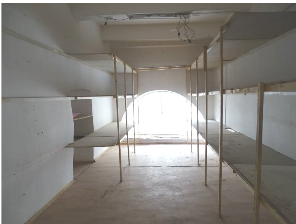
Илл. 62. Второй этаж. Помещение 188. Съемка 22.04.21 г. Трушковский В.Э.
