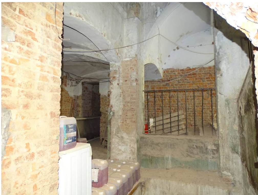
Илл. 50. Первый этаж. Съемка 22.04.21 г. Трушковский В.Э.
