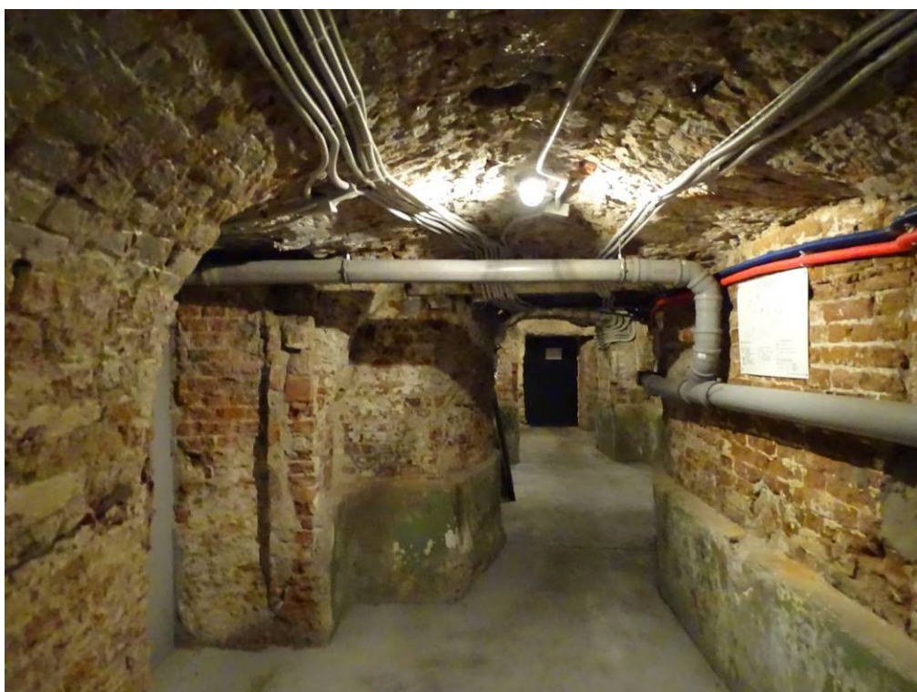
Илл. 16. Подвал 1-Н. Помещение 48. Съемка 22.04.21 г. Трушковский В.Э.
