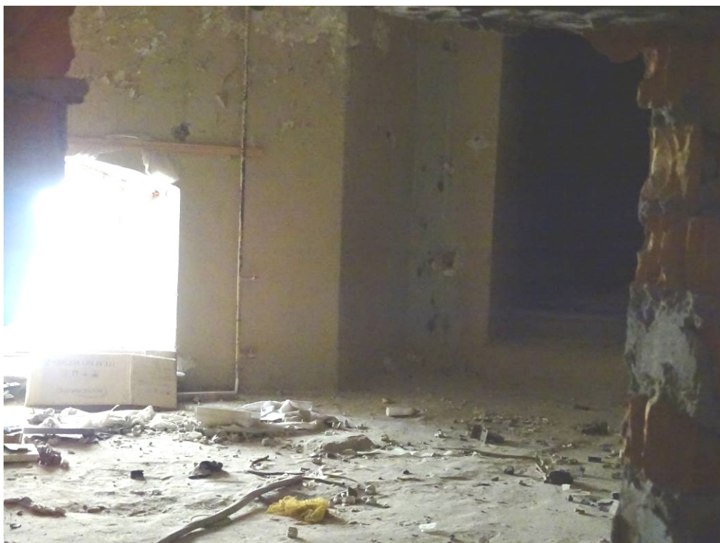
Илл. 70. Второй этаж. Помещение 177. Съемка 22.04.21 г. Трушковский В.Э.
