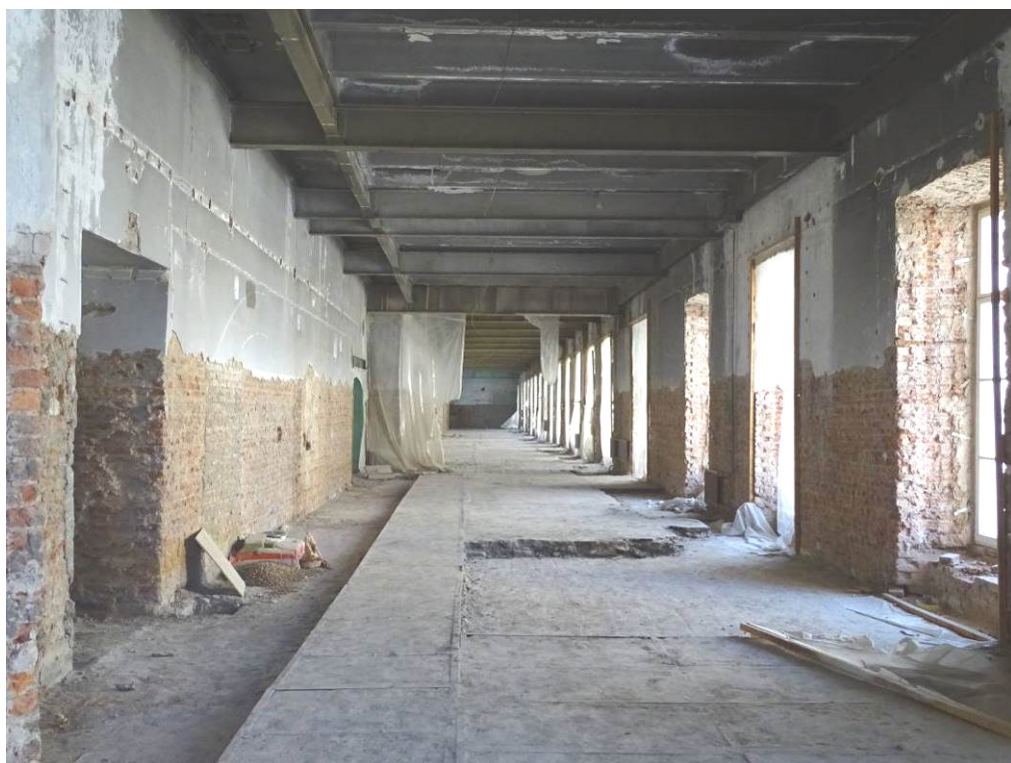
Илл. 8. Третий этаж. Помещение 242. Съемка 22.04.21 г. Трушковский В.Э.
