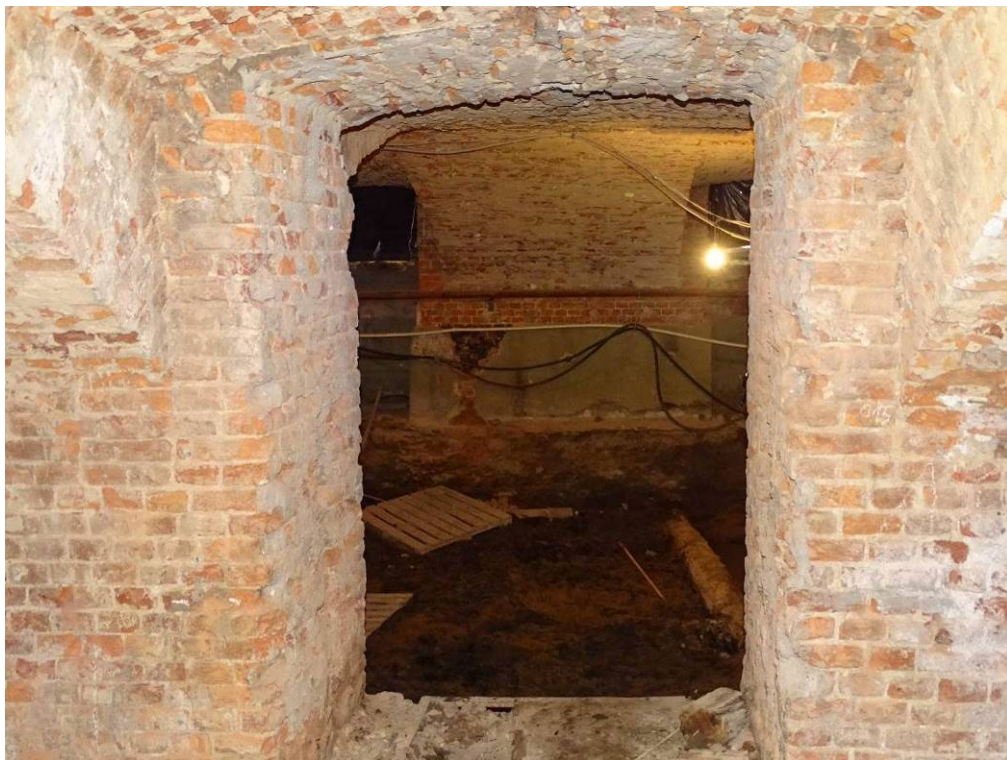
Илл. 9. Подвал 1-Н. Помещение 7. Съемка 22.04.21 г. Трушковский В.Э.
