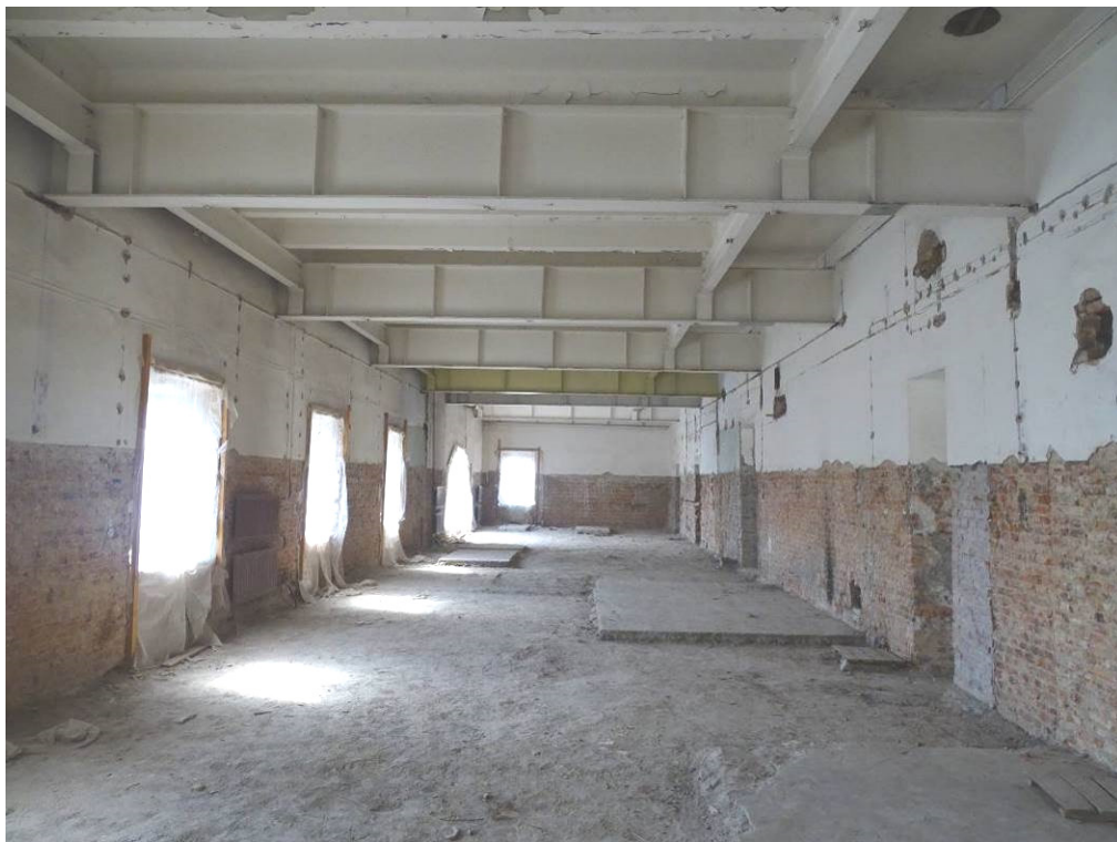
Илл. 25. Четвертый этаж. Помещение 251. Съемка 22.04.21 г. Трушковский В.Э.
