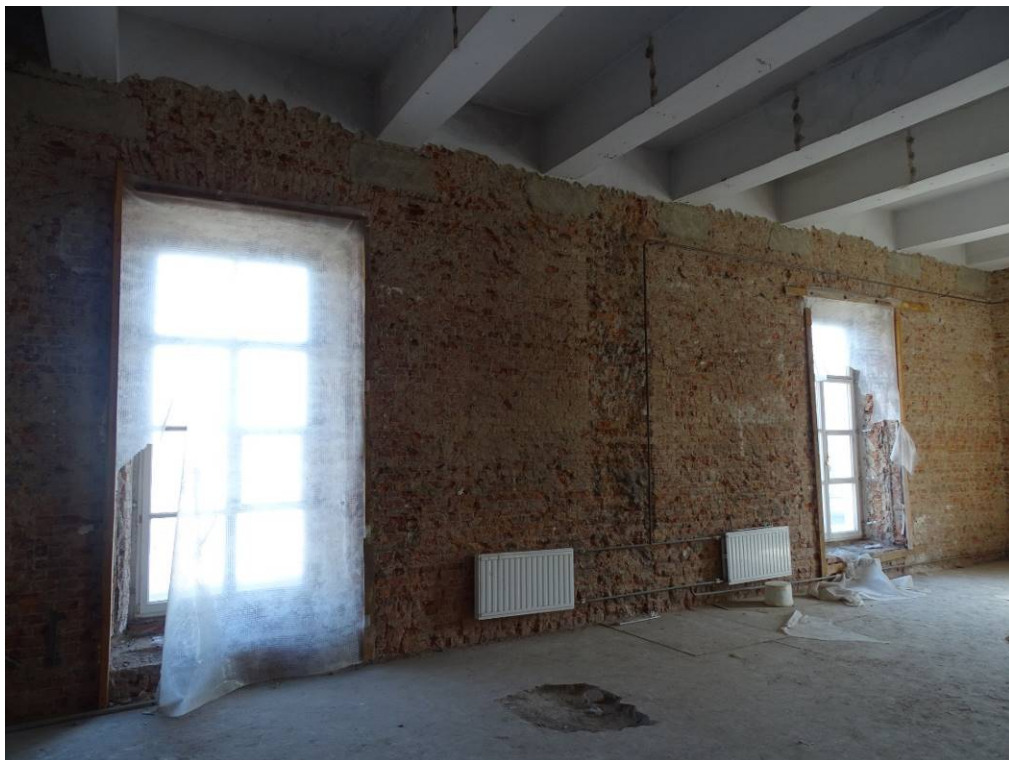
Илл. 79. Второй этаж. Помещение 152. Съемка 22.04.21 г. Трушковский В.Э.
