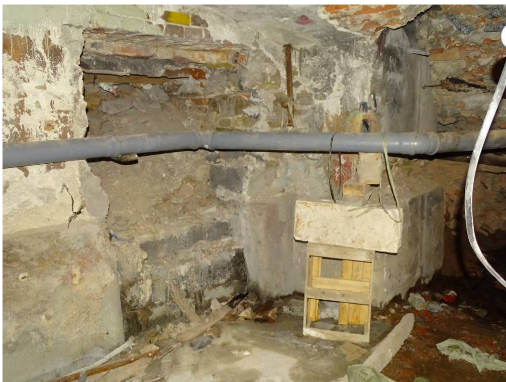
Илл. 4. Подвал 5-Н. Помещение 2/17,3. Съемка 22.04.21 г. Трушковский В.Э.
