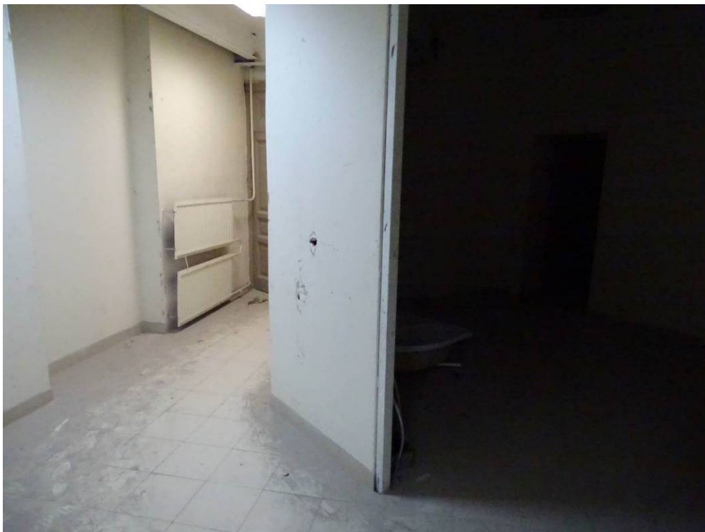
Илл. 29. Первый этаж. Помещение 83. Съемка 22.04.21 г. Трушковский В.Э.
