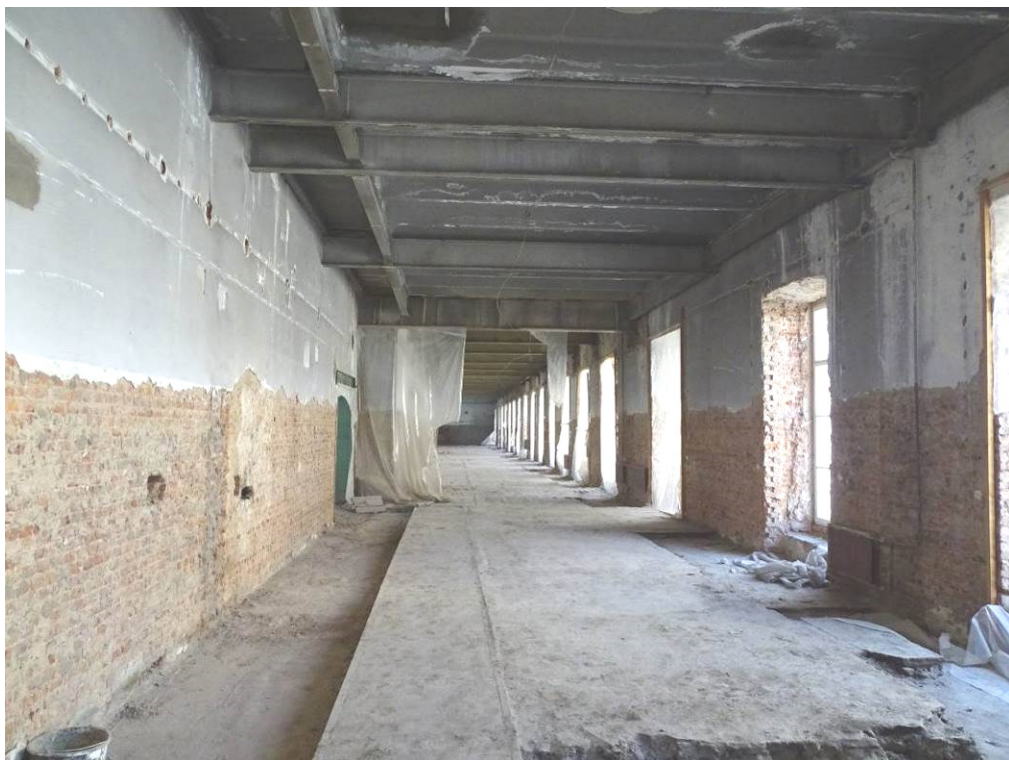
Илл. 10. Третий этаж. Помещение 242. Съемка 22.04.21 г. Трушковский В.Э.
