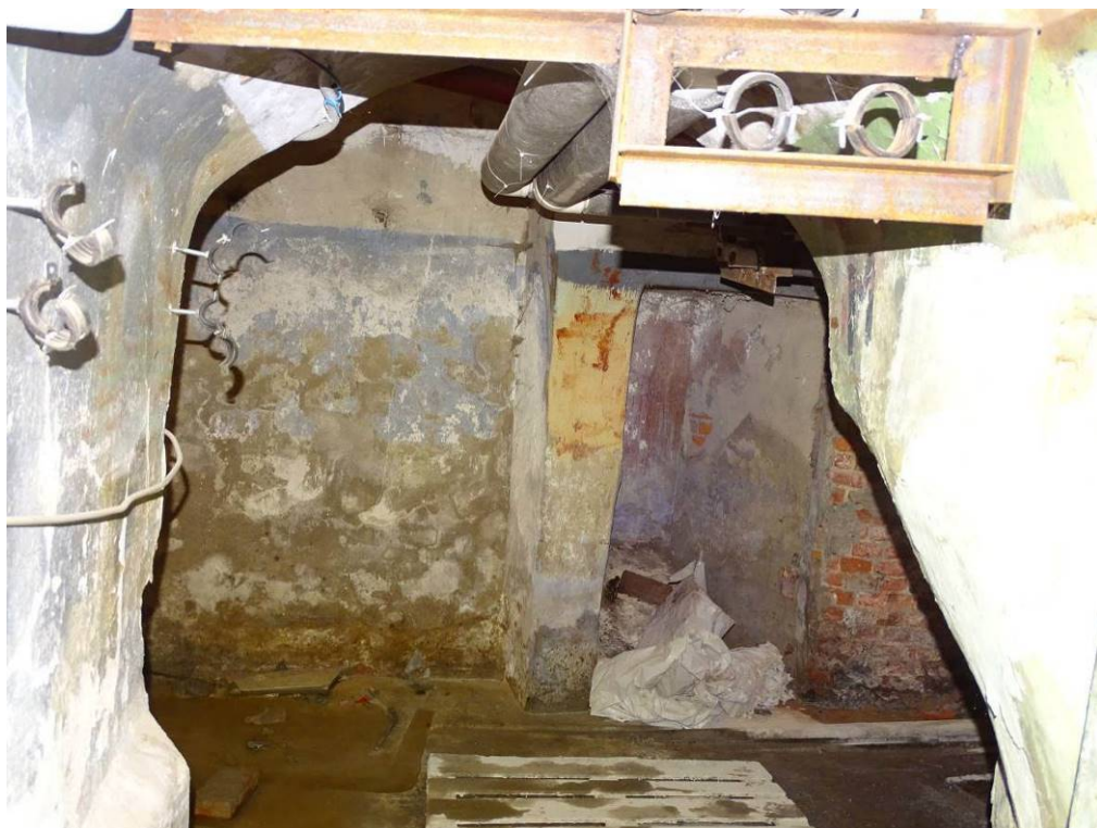
Илл. 5. Подвал 5-Н. Помещение 1. Съемка 22.04.21 г. Трушковский В.Э.
