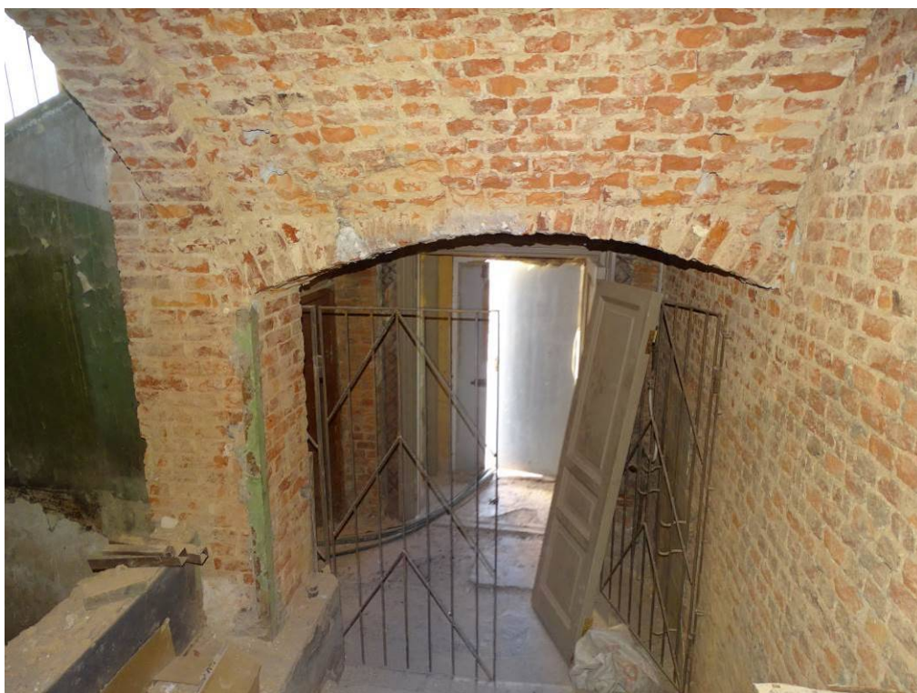
Илл. 51. Первый этаж. Съемка 22.04.21 г. Трушковский В.Э.
