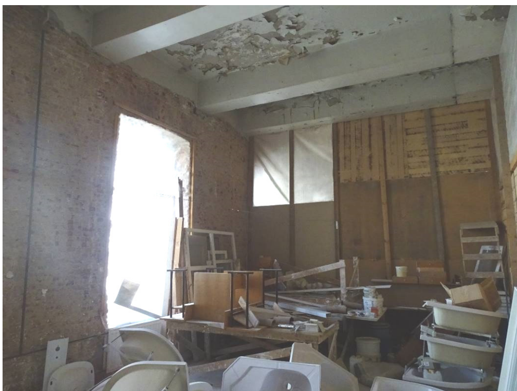
Илл. 74. Второй этаж. Помещение 132. Съемка 22.04.21 г. Трушковский В.Э.
