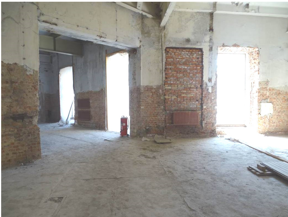
Илл. 9. Третий этаж. Помещение 221. Съемка 22.04.21 г. Трушковский В.Э.
