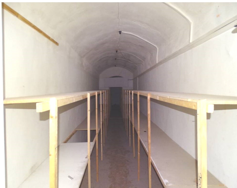
Илл. 64. Второй этаж. Помещение 174. Съемка 22.04.21 г. Трушковский В.Э.
