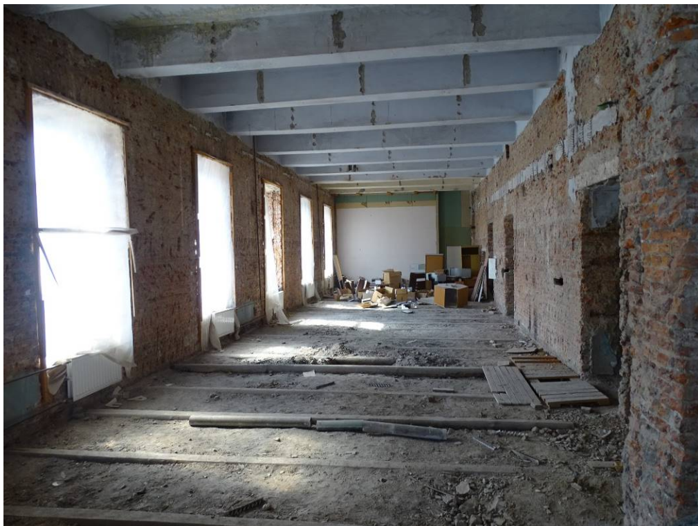
Илл. 81. Второй этаж. Помещение 152. Съемка 22.04.21 г. Трушковский В.Э.
