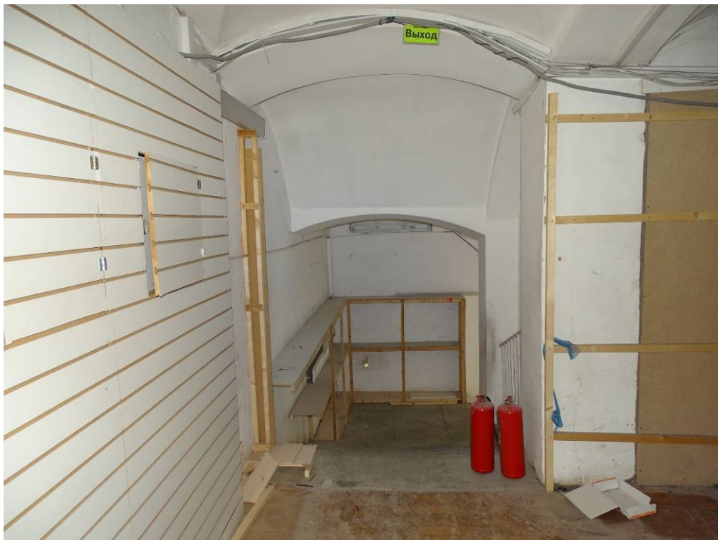
Илл. 61. Второй этаж. Помещение 175. Вид на лестницу. Съемка 22.04.21 г. Трушковский В.Э.
