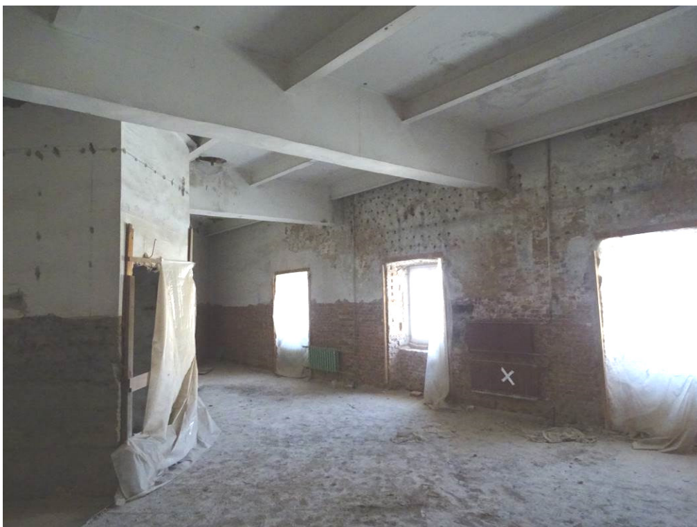
Илл. 22. Четвертый этаж. Помещение 280. Съемка 22.04.21 г. Трушковский В.Э.
