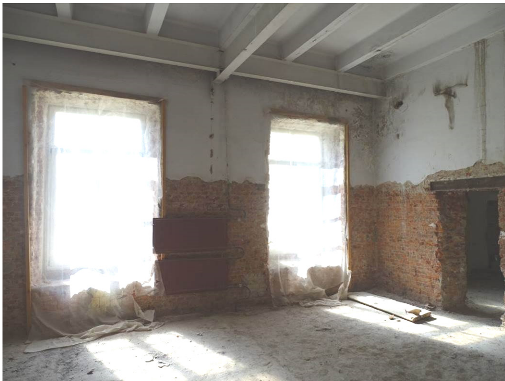
Илл. 19. Четвертый этаж. Помещение 274. Съемка 22.04.21 г. Трушковский В.Э.
