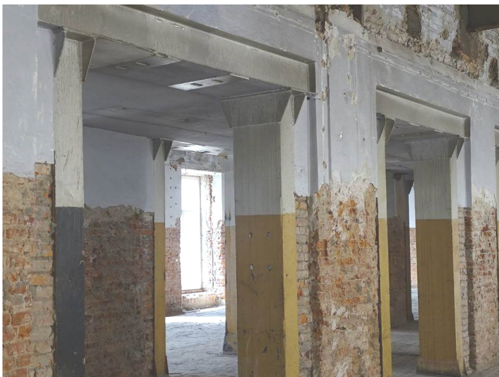
Илл. 12. Третий этаж. Помещение 242. Съемка 22.04.21 г. Трушковский В.Э.
