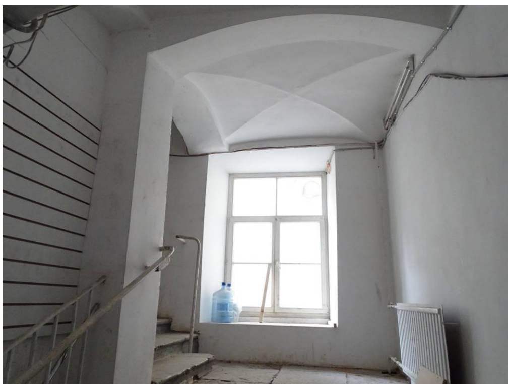
Илл. 33. Первый этаж. Съемка 22.04.21 г. Трушковский В.Э.
