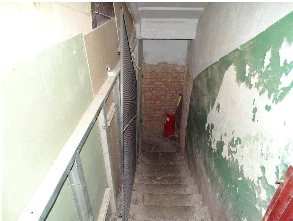
Илл. 57. Первый этаж. Съемка 22.04.21 г. Трушковский В.Э.
