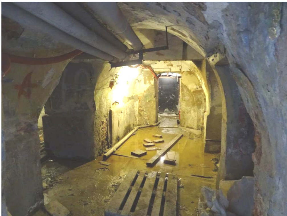
Илл. 1. Подвал 5-Н. Помещение 1. Съемка 22.04.21 г. Трушковский В.Э.
