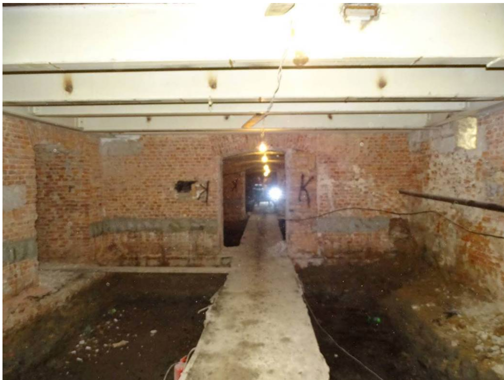
Илл. 13. Подвал 1-Н. Помещение 15. Съемка 22.04.21 г. Трушковский В.Э.
