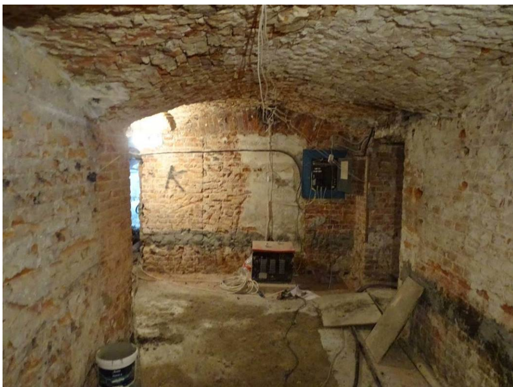
Илл. 8. Подвал 1-Н. Помещение 1. Съемка 22.04.21 г. Трушковский В.Э.
