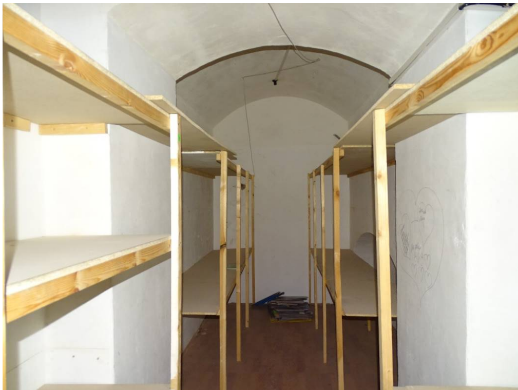
Илл. 65. Второй этаж. Помещение 174. Съемка 22.04.21 г. Трушковский В.Э.
