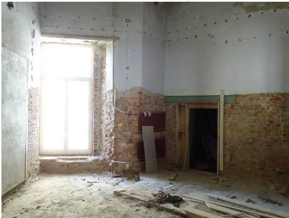
Илл. 17. Третий этаж. Помещение 229. Съемка 22.04.21 г. Трушковский В.Э.
