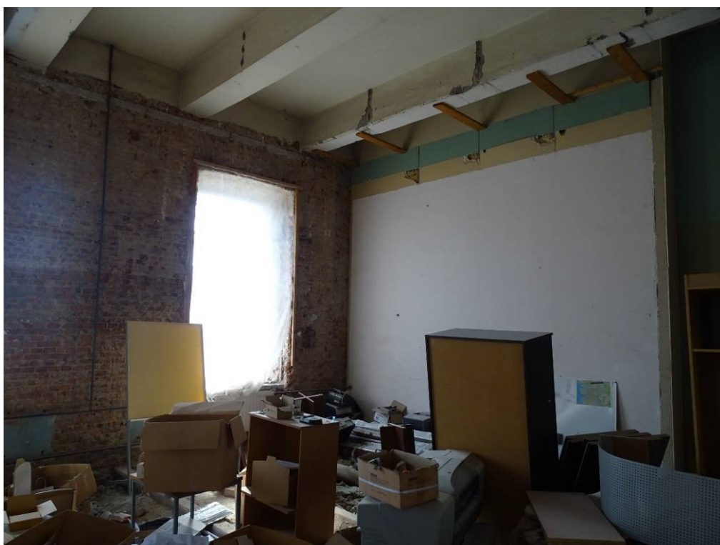
Илл. 76. Второй этаж. Помещение 152. Съемка 22.04.21 г. Трушковский В.Э.
