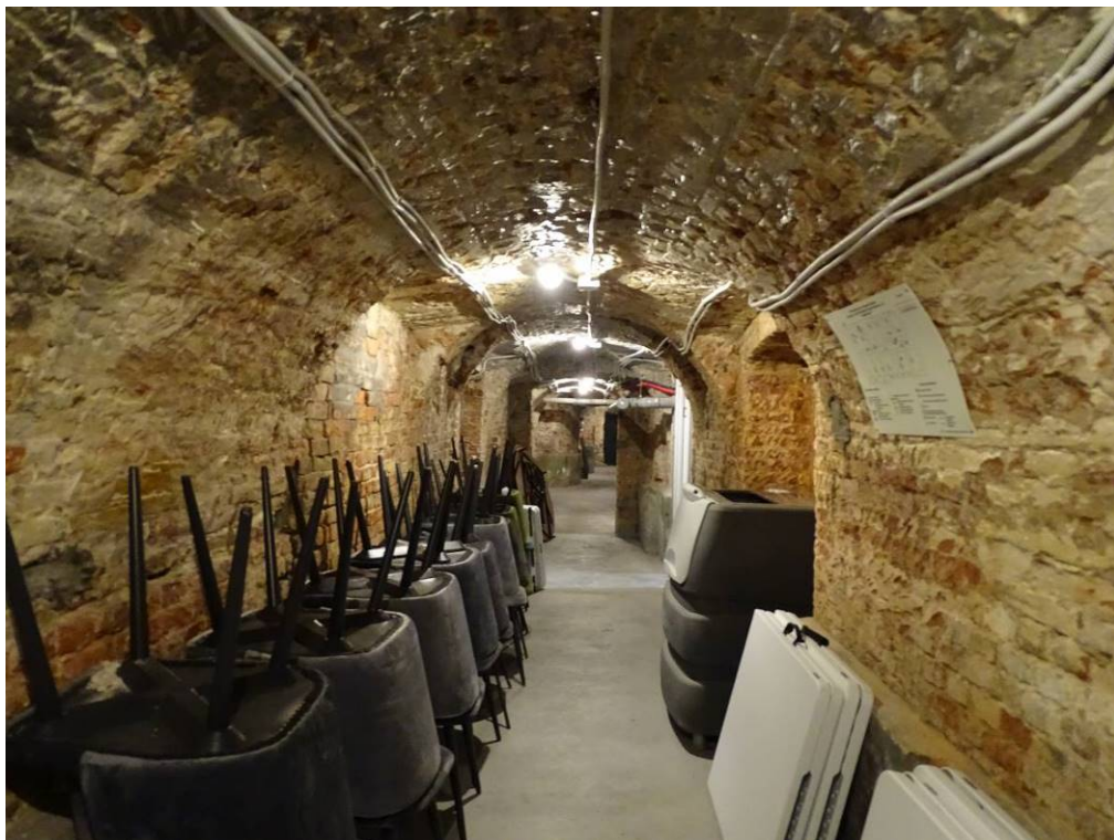
Илл. 19. Подвал 1-Н. Помещение 42. Съемка 22.04.21 г. Трушковский В.Э.
