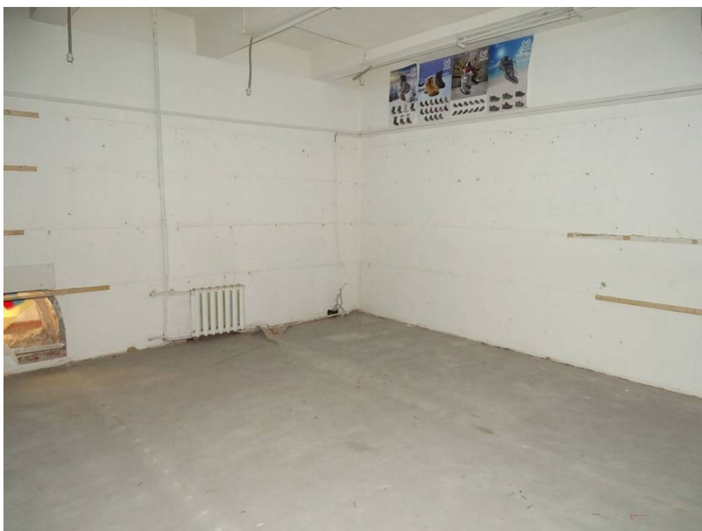
Илл. 66. Второй этаж. Помещение 187. Съемка 22.04.21 г. Трушковский В.Э.
