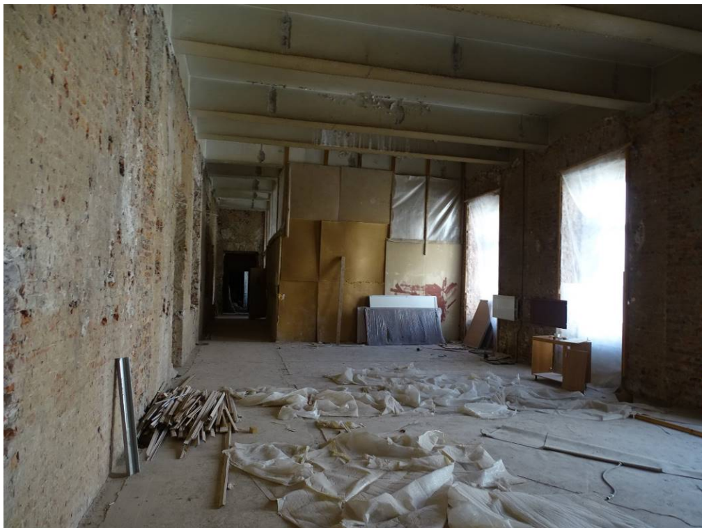
Илл. 75. Второй этаж. Помещение 131. Съемка 22.04.21 г. Трушковский В.Э.
