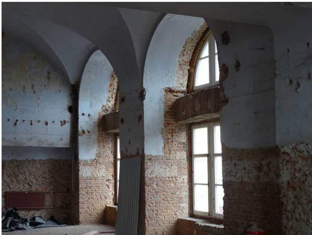
Илл. 39. Первый этаж. Помещение 58
