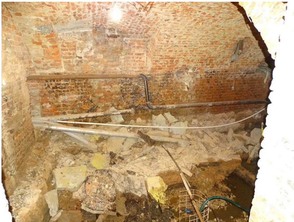
Илл. 7. Подвал 1-Н. Помещение 5. Съемка 22.04.21 г. Трушковский В.Э.
