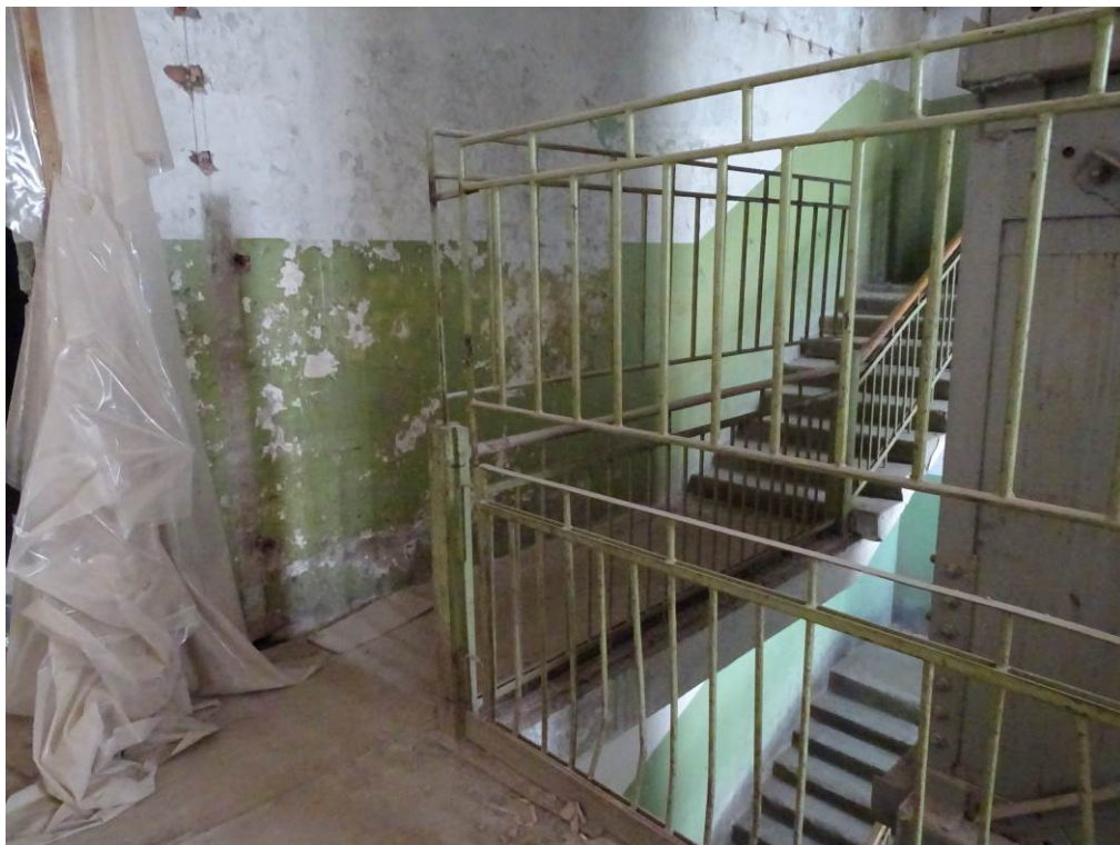
Илл. 49. Четвертый этаж. Съемка 22.04.21 г. Трушковский В.Э.
