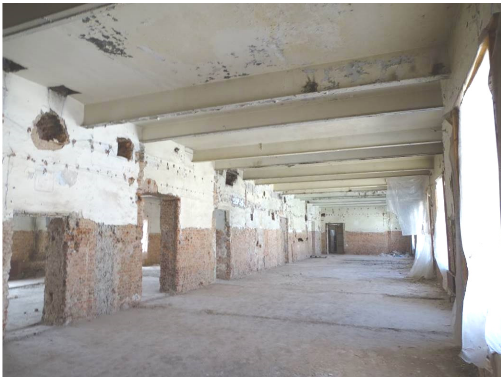
Илл. 27. Четвертый этаж. Помещение 247. Съемка 22.04.21 г. Трушковский В.Э.
