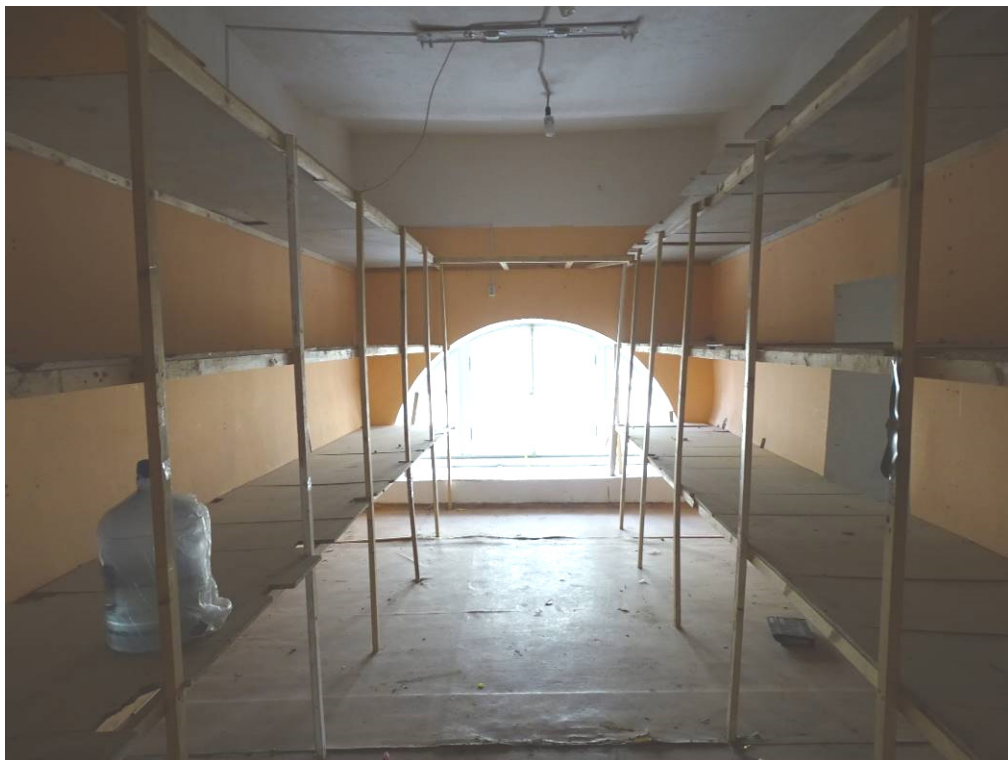
Илл. 63. Второй этаж. Помещение 174. Съемка 22.04.21 г. Трушковский В.Э.
