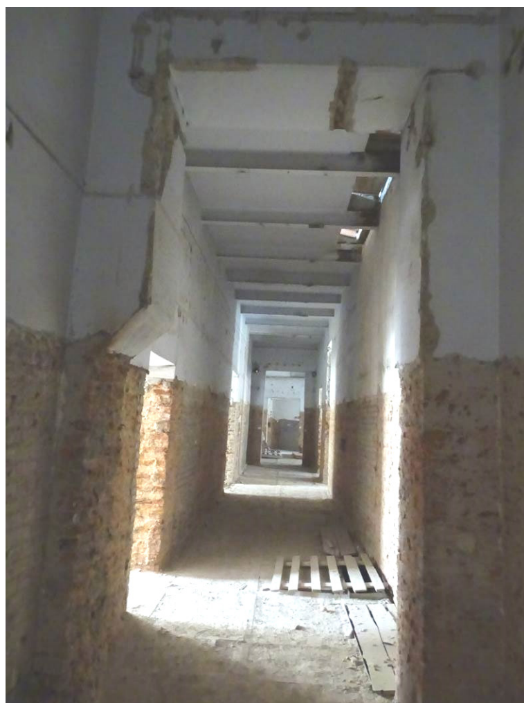
Илл. 18. Четвертый этаж. Помещение 273. Съемка 22.04.21 г. Трушковский В.Э.
