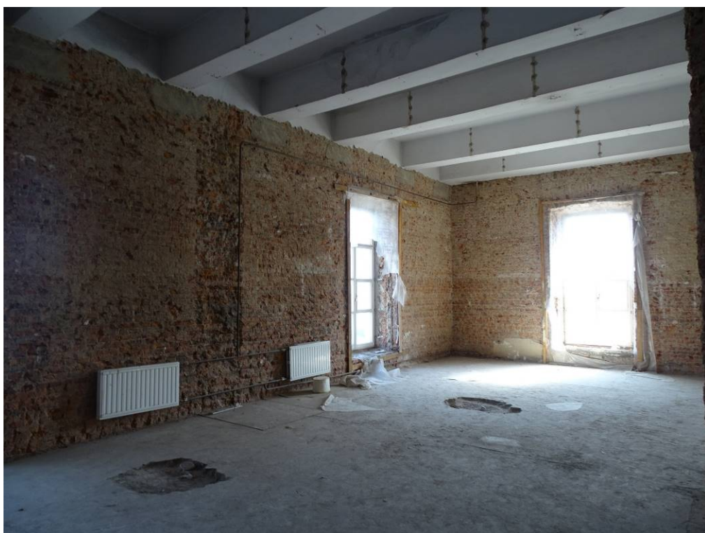
Илл. 78. Второй этаж. Помещение 152. Съемка 22.04.21 г. Трушковский В.Э.
