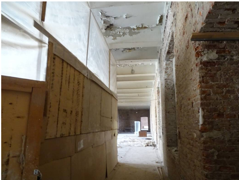
Илл. 73. Второй этаж. Помещение 131. Съемка 22.04.21 г. Трушковский В.Э.
