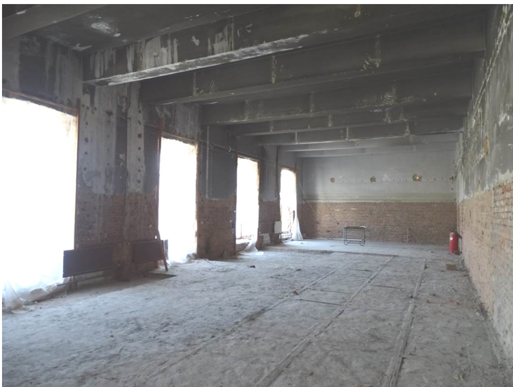
Илл. 6. Третий этаж. Помещение 242. Съемка 22.04.21 г. Трушковский В.Э.
