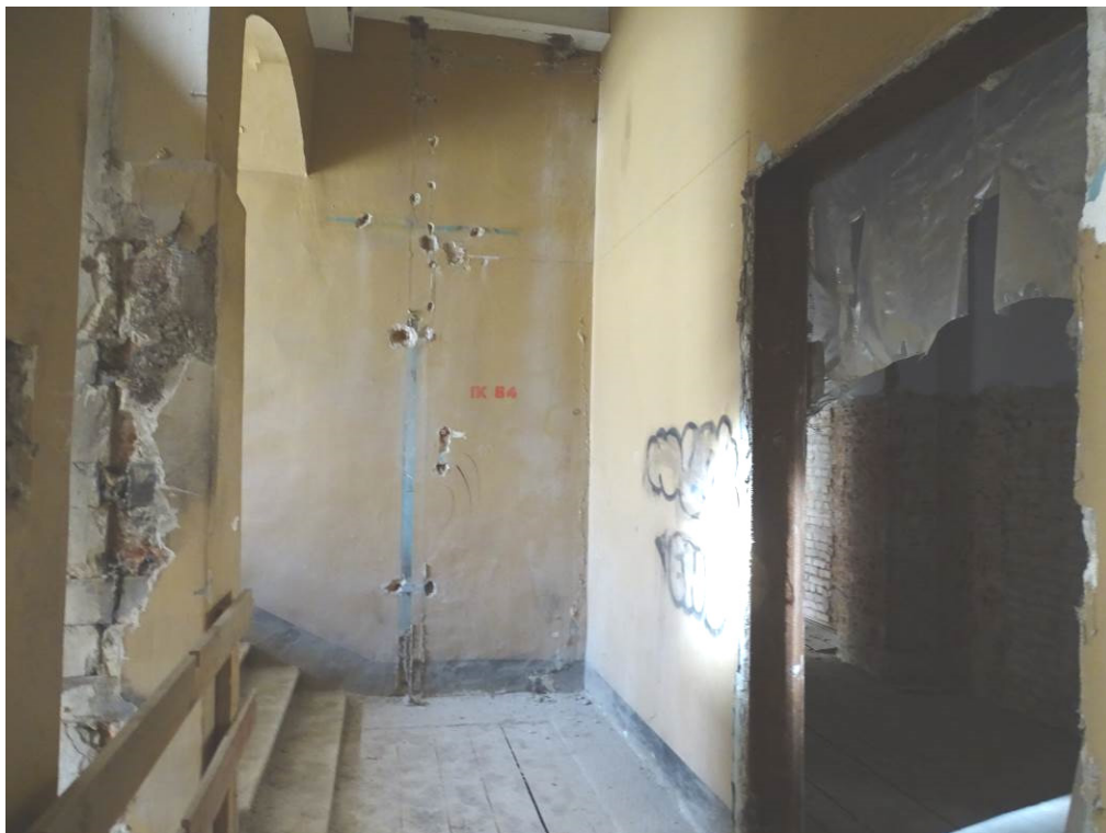
Илл. 40. Четвертый этаж. Съемка 22.04.21 г. Трушковский В.Э.
