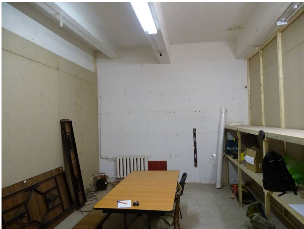
Илл. 71. Второй этаж. Помещение 187. Съемка 22.04.21 г. Трушковский В.Э.
