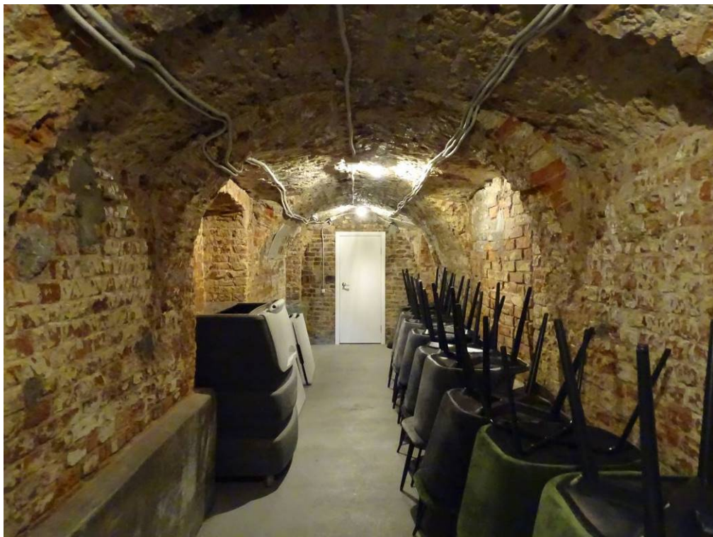
Илл. 17. Подвал 1-Н. Помещение 42. Съемка 22.04.21 г. Трушковский В.Э.
