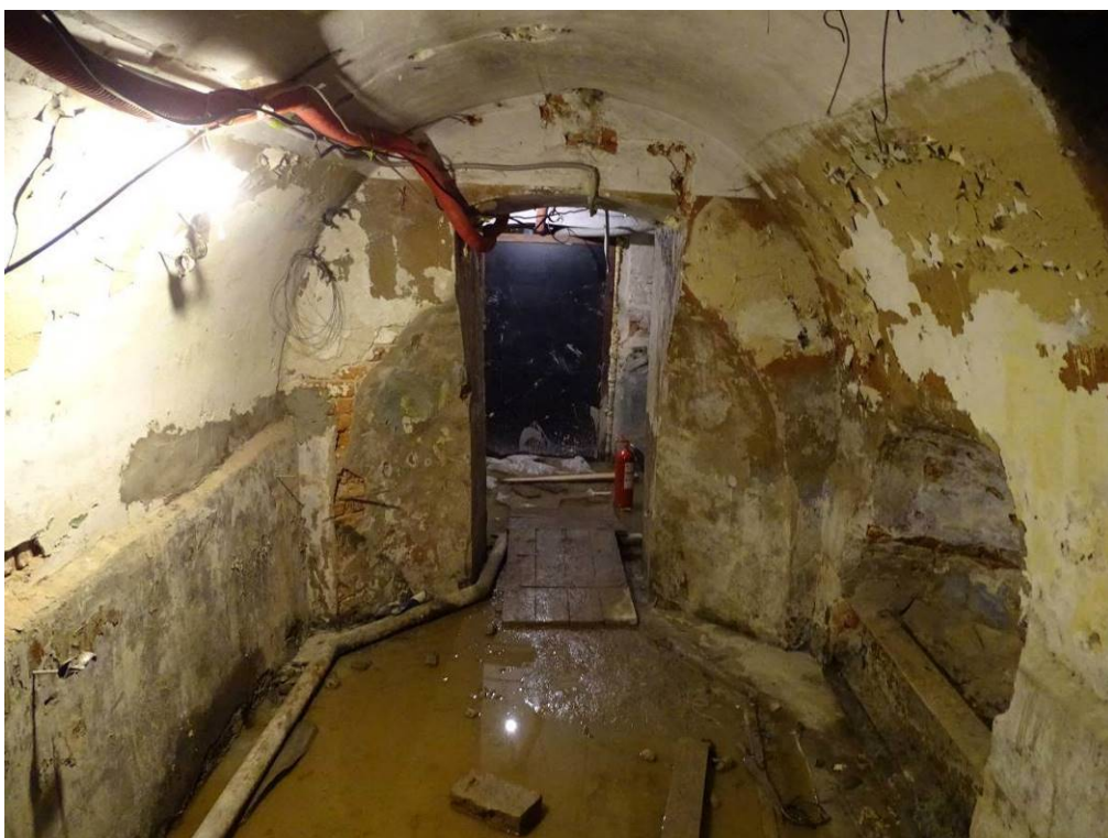
Илл. 2. Подвал 5-Н. Помещение 1. Съемка 22.04.21 г. Трушковский В.Э.
