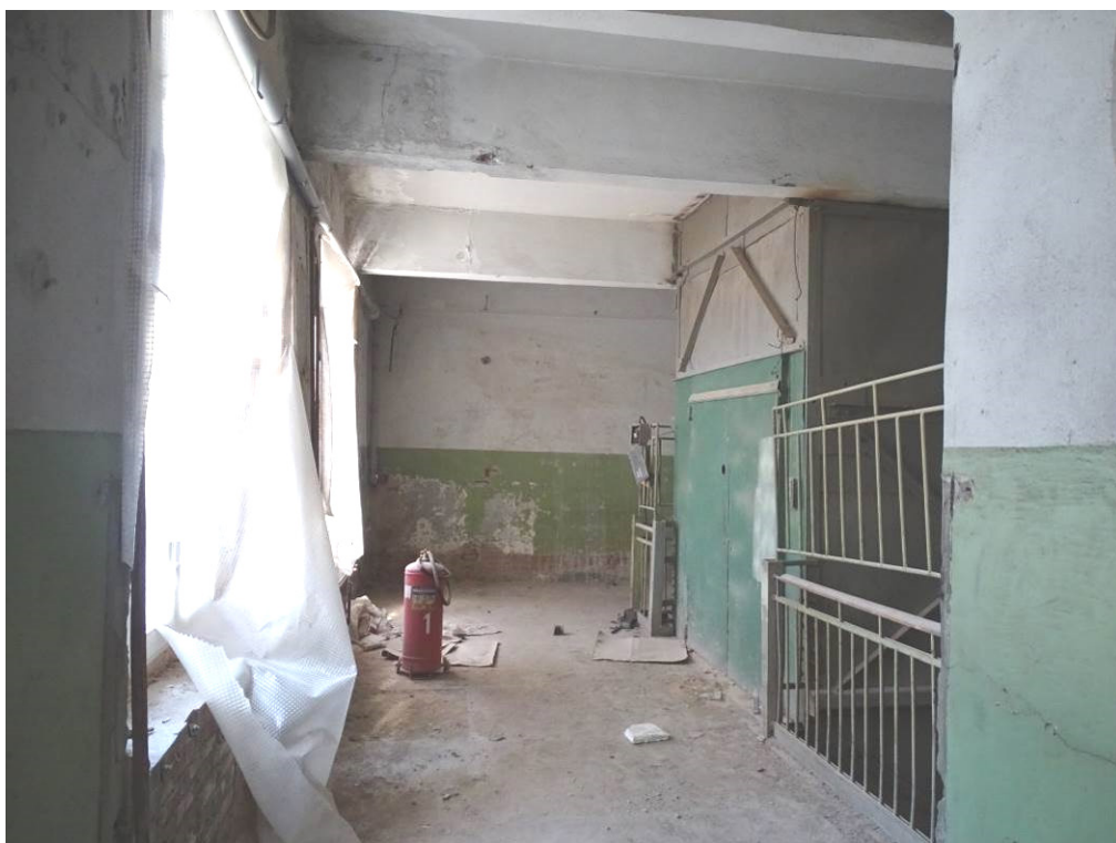
Илл. 48. Четвертый этаж. Съемка 22.04.21 г. Трушковский В.Э.
