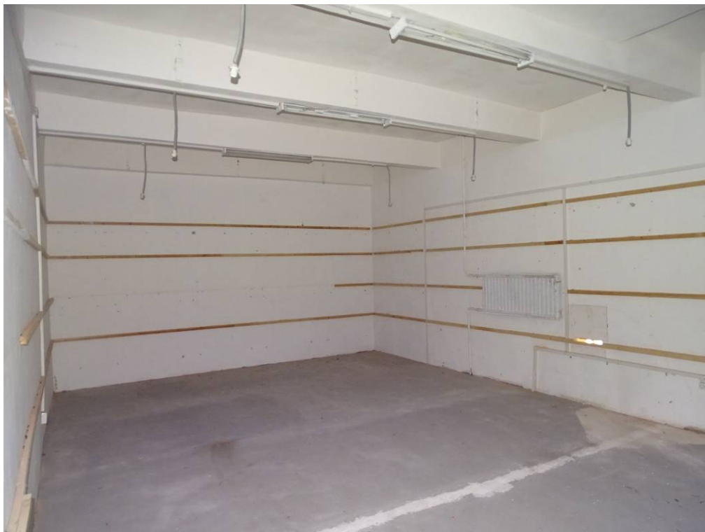
Илл. 67. Второй этаж. Помещение 187. Съемка 22.04.21 г. Трушковский В.Э.
