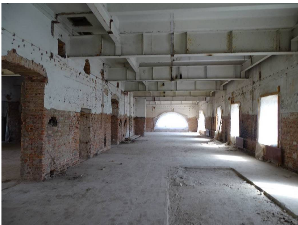
Илл. 26. Четвертый этаж. Помещение 246, 280, 249-251. Съемка 22.04.21 г. Трушковский В.Э.
