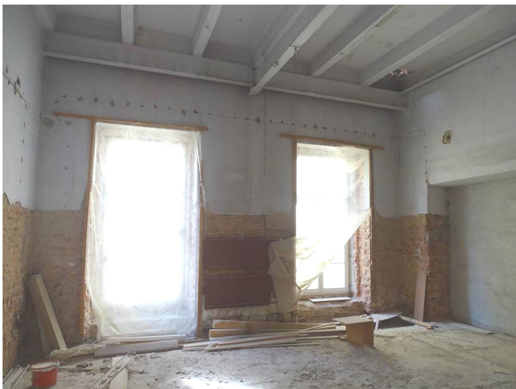
Илл. 14. Третий этаж. Помещение 228. Съемка 22.04.21 г. Трушковский В.Э.
