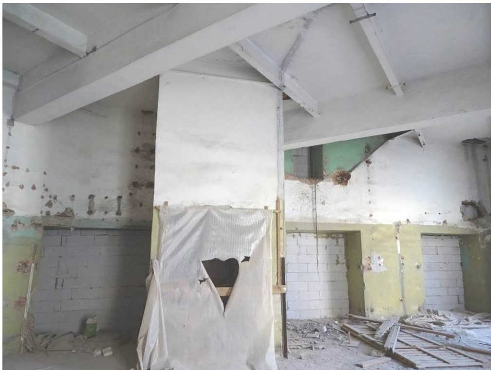
Илл. 15. Третий этаж. Помещение 238. Съемка 22.04.21 г. Трушковский В.Э.
