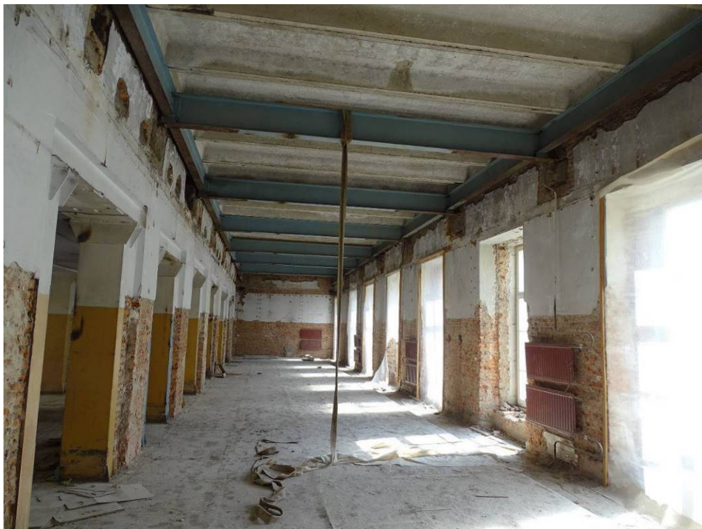
Илл. 13. Третий этаж. Помещение 224. Съемка 22.04.21 г. Трушковский В.Э.
