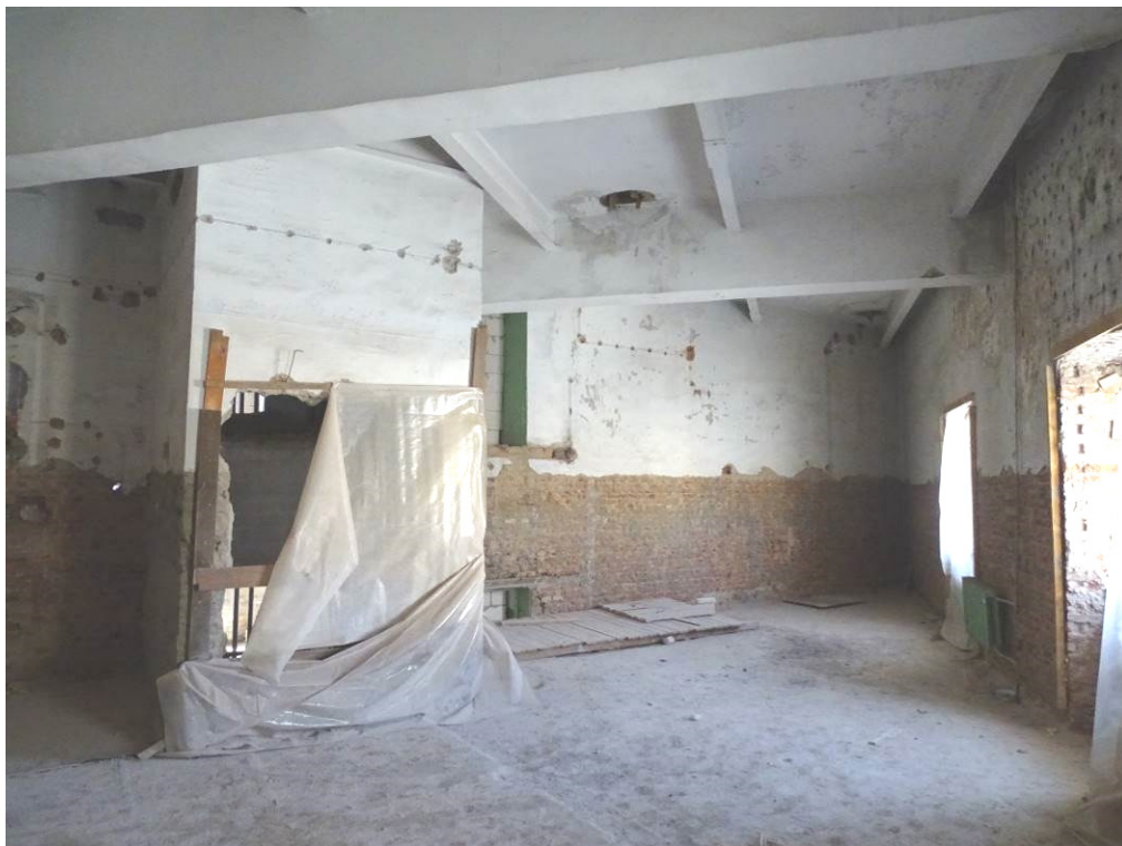
Илл. 23. Четвертый этаж. Помещение 273. Съемка 22.04.21 г. Трушковский В.Э.
