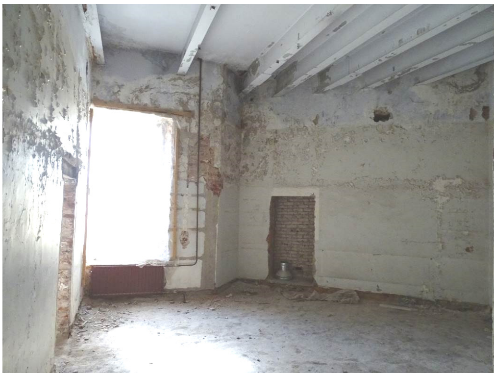
Илл. 20. Четвертый этаж. Помещение 276. Съемка 22.04.21 г. Трушковский В.Э.
