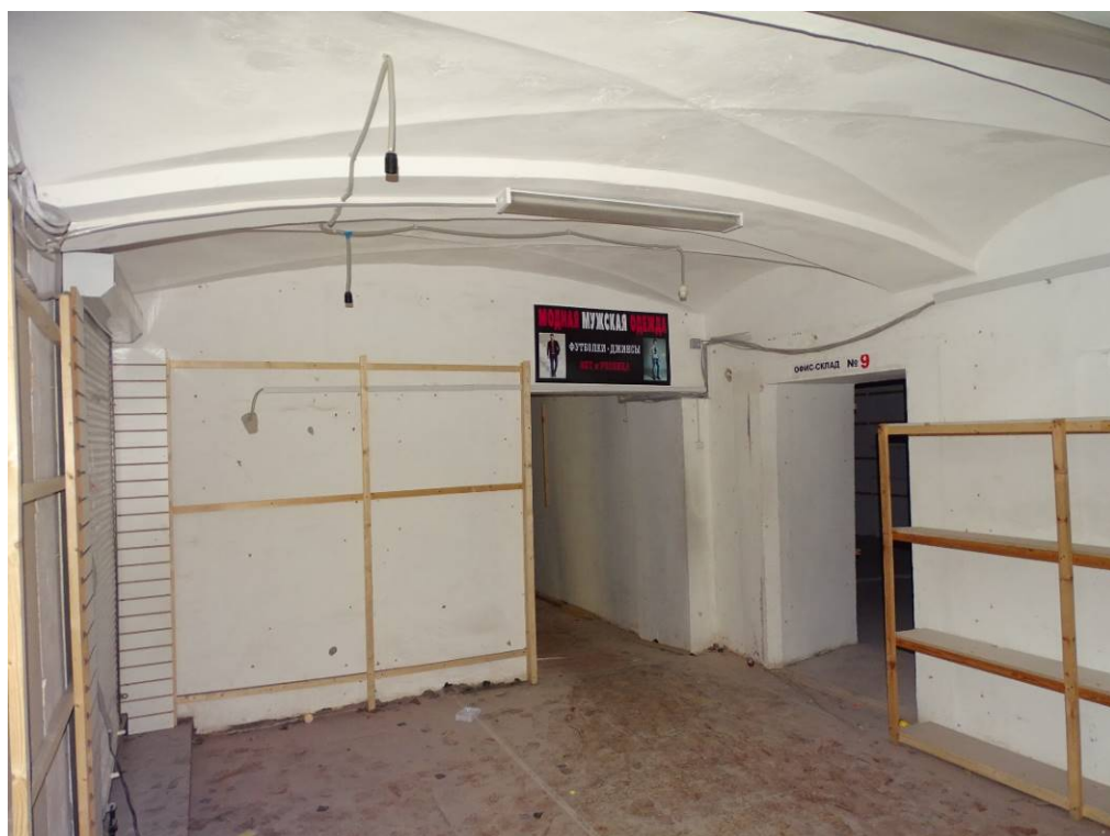
Илл. 60. Второй этаж. Помещение 175. Съемка 22.04.21 г. Трушковский В.Э.
