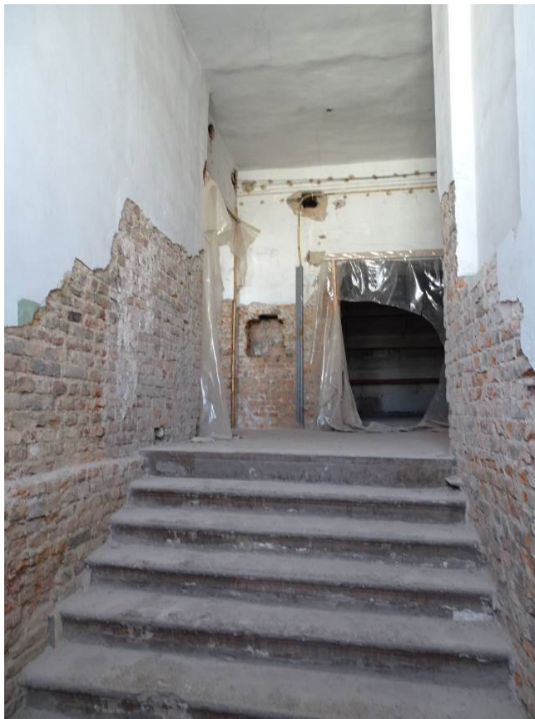
Илл. 56. Четвертый этаж. Съемка 22.04.21 г. Трушковский В.Э.
