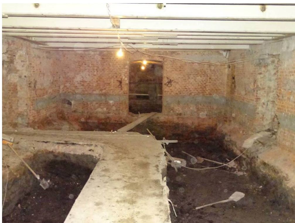
Илл. 12. Подвал 1-Н. Помещение 15. Съемка 22.04.21 г. Трушковский В.Э.
