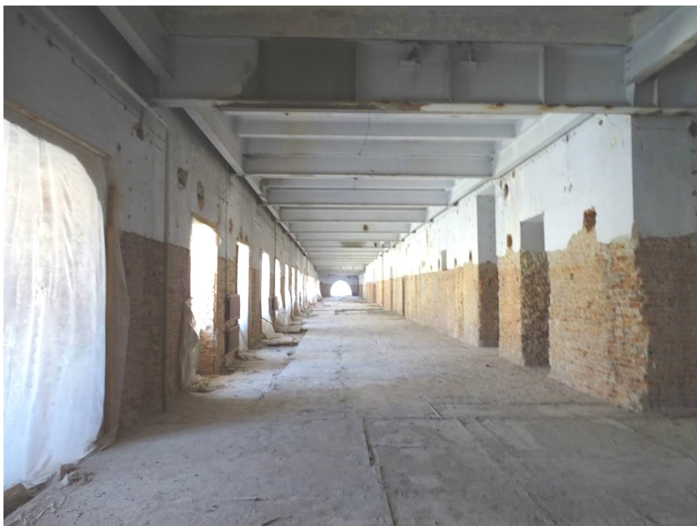
Илл. 24. Четвертый этаж. Помещение 280. Съемка 22.04.21 г. Трушковский В.Э.
