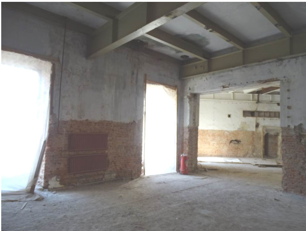
Илл. 5. Третий этаж. Помещение 219. Съемка 22.04.21 г. Трушковский В.Э.
