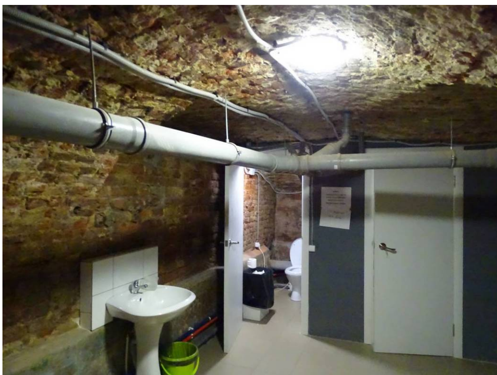
Илл. 18. Подвал 1-Н. Помещение 37. Съемка 22.04.21 г. Трушковский В.Э.
