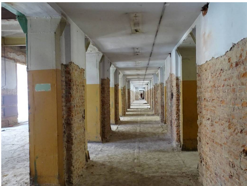
Илл. 16. Третий этаж. Помещение 225. Съемка 22.04.21 г. Трушковский В.Э.
