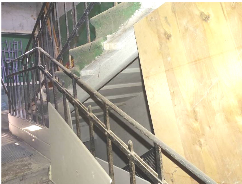
Илл. 58. Первый этаж. Съемка 22.04.21 г. Трушковский В.Э.
