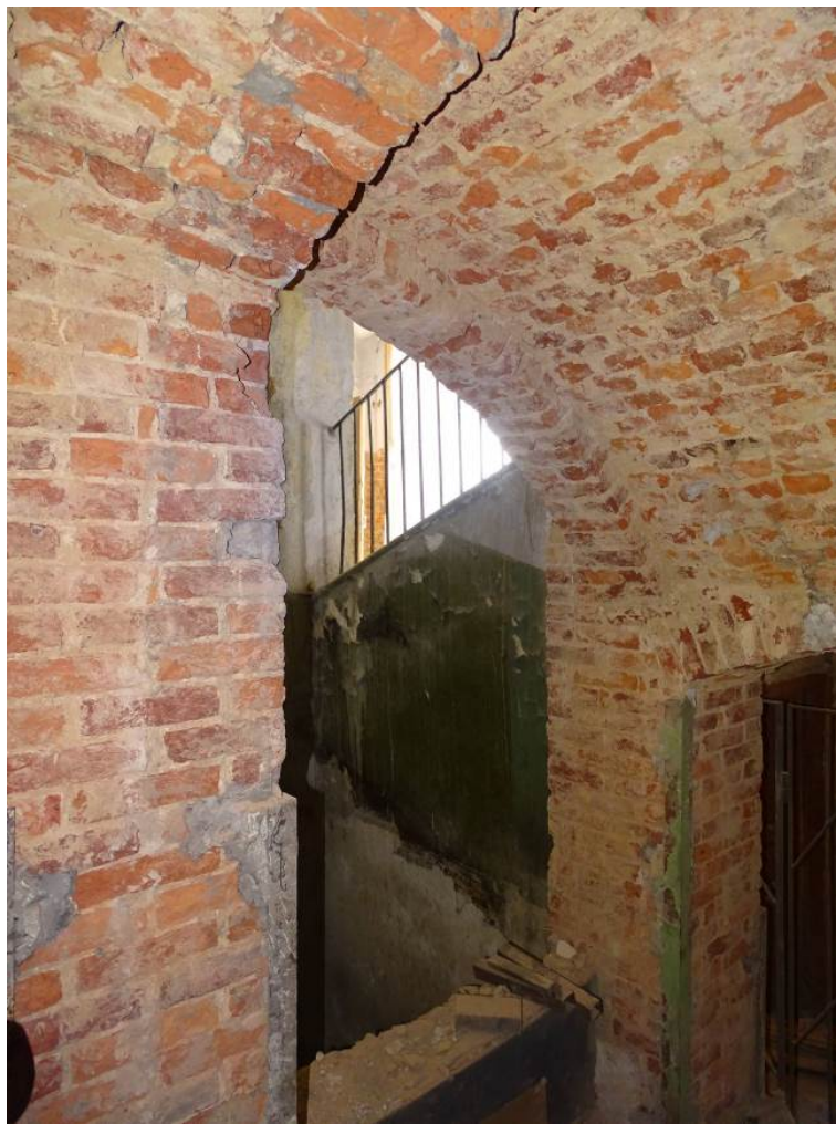
Илл. 52. Первый этаж. Съемка 22.04.21 г. Трушковский В.Э.
