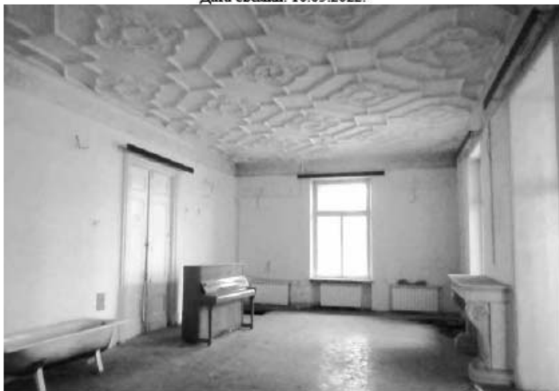
Фото 5. ОКН «Лечебница А.Л. Эбермана». Главное здание по адресу: СПб, г. Пушкин, Московское шоссе, д. 7. Помещение 1.12. Общий вид. Дата съёмки: 10.05.2022.
