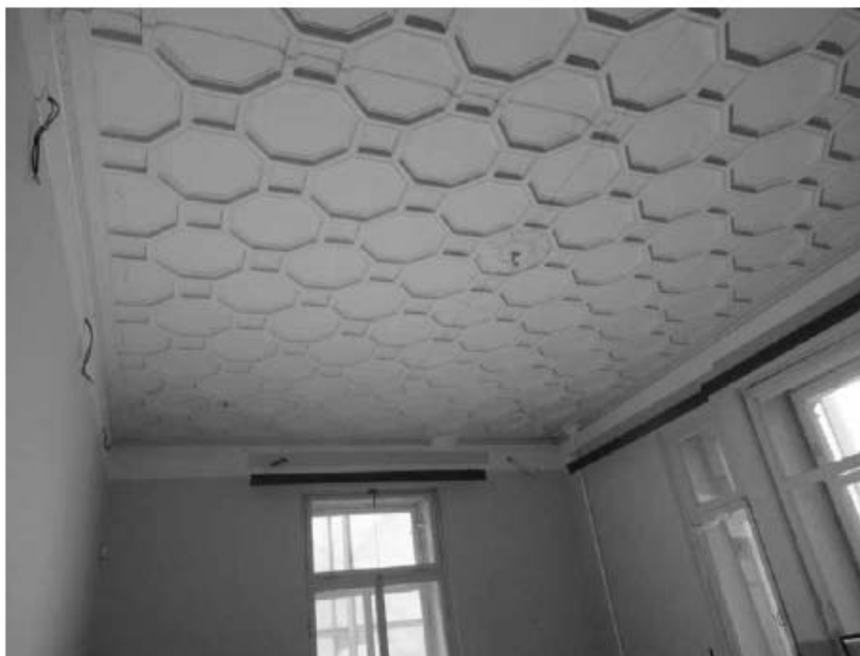
Фото 21. ОКН «Лечебница А.Л. Эбермана». Главное здание по адресу: СПб, г. Пушкин, Московское шоссе, д. 7. Помещение 1.16. Общий вид. Дата съёмки: 10.05.2022.
