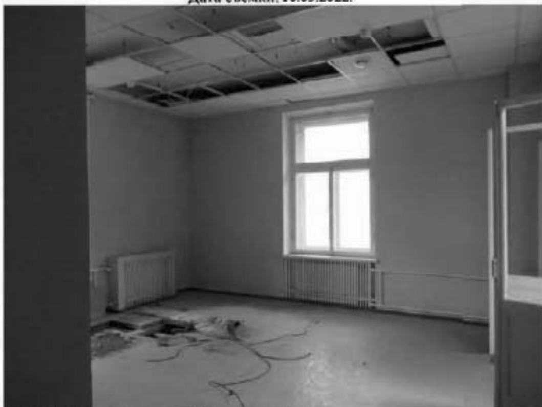
Фото 29. ОКН «Лечебница А.Л. Эбермана». Главное здание по адресу: СПб, г. Пушкин, Московское шоссе, д. 7. Помещение 2.12. Общий вид. Дата съёмки: 10.05.2022.
