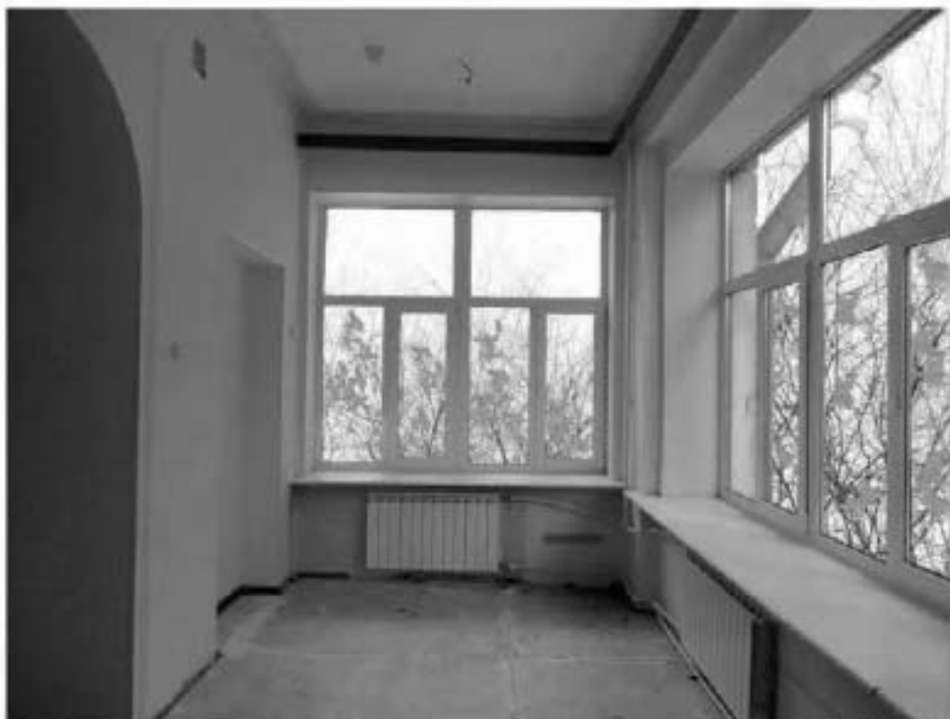
Фото 28. ОКН «Лечебница А.Л. Эбермана». Главное здание по адресу: СПб, г. Пушкин, Московское шоссе, д. 7. Помещение 2.2. Общий вид. Дата съёмки: 10.05.2022.
