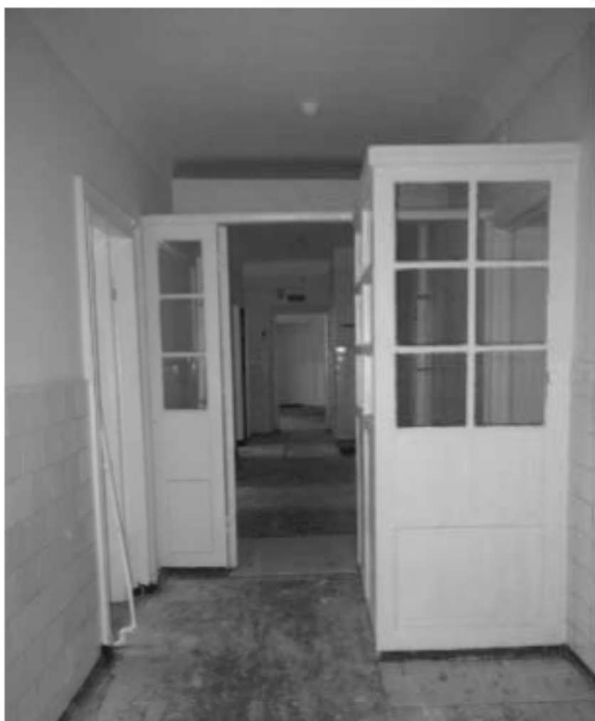
Фото 32. ОКН «Лечебница А.Л. Эбермана». Главное здание по адресу: СПб, г. Пушкин, Московское шоссе, д. 7. Помещение 2.7. Общий вид. Дата съёмки: 10.05.2022.
