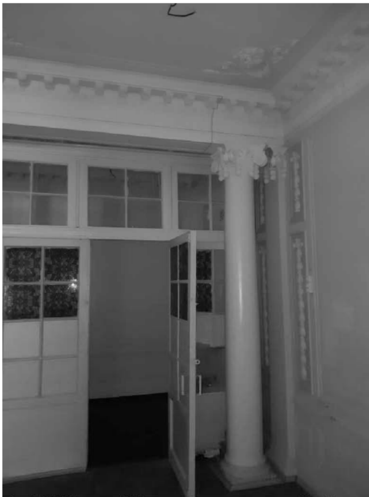
Фото 13. ОКН «Лечебница А.Л. Эбермана». Главное здание по адресу: СПб, г. Пушкин, Московское шоссе, д. 7. Помещение 1.12. Общий вид. Дата съёмки: 10.05.2022.
