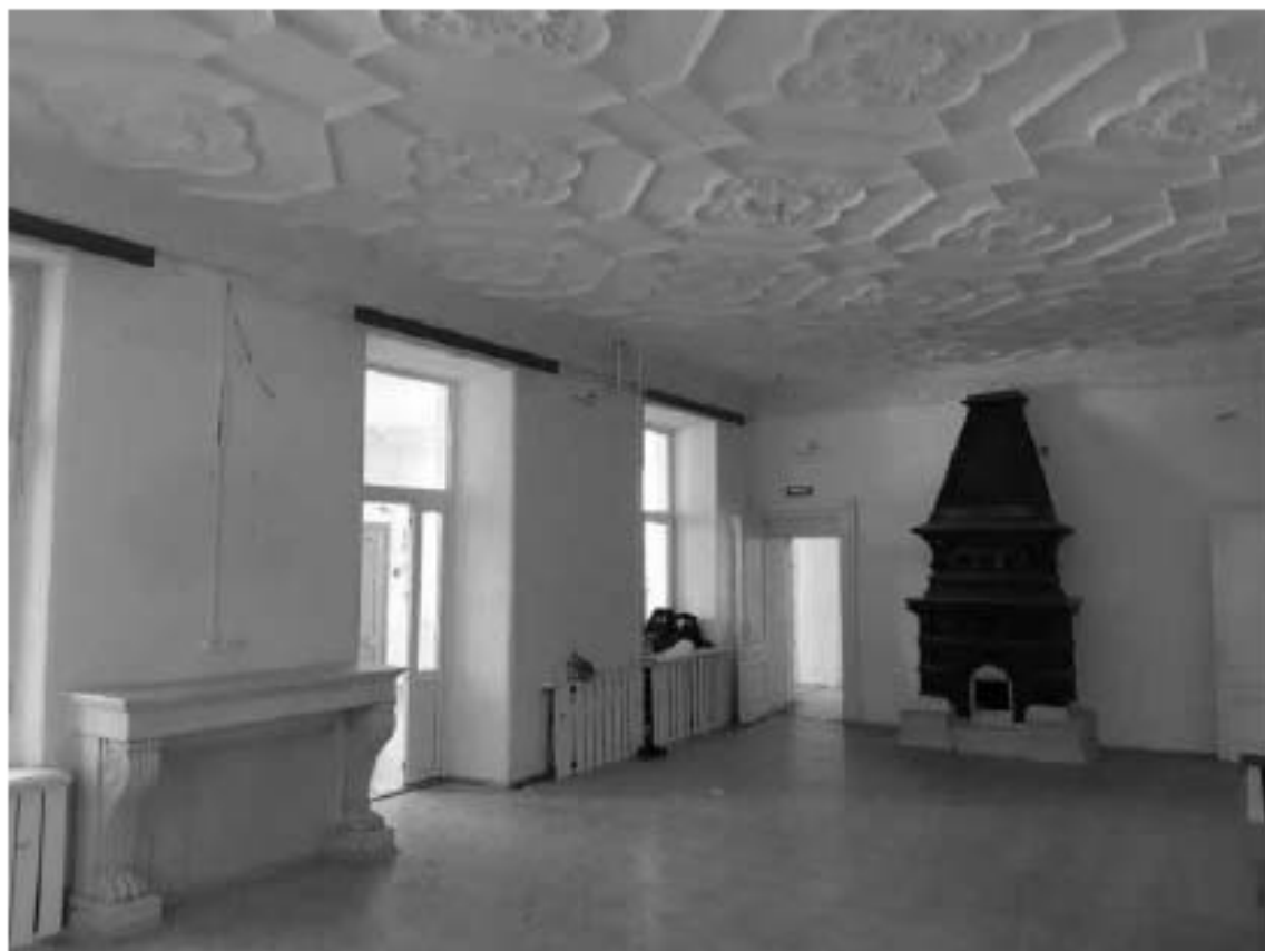
Фото 6. ОКН «Лечебница А.Л. Эбермана». Главное здание по адресу: СПб, г. Пушкин, Московское шоссе, д. 7. Помещение 1.12. Общий вид. Дата съёмки: 10.05.2022.
