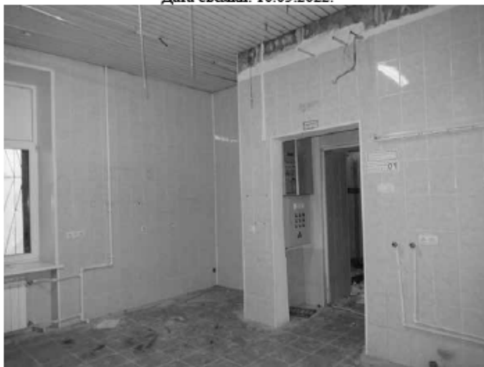
Фото 17. ОКН «Лечебница А.Л. Эбермана». Главное здание по адресу: СПб, г. Пушкин, Московское шоссе, д. 7. Помещение 1.9. Общий вид. Дата съёмки: 10.05.2022.
