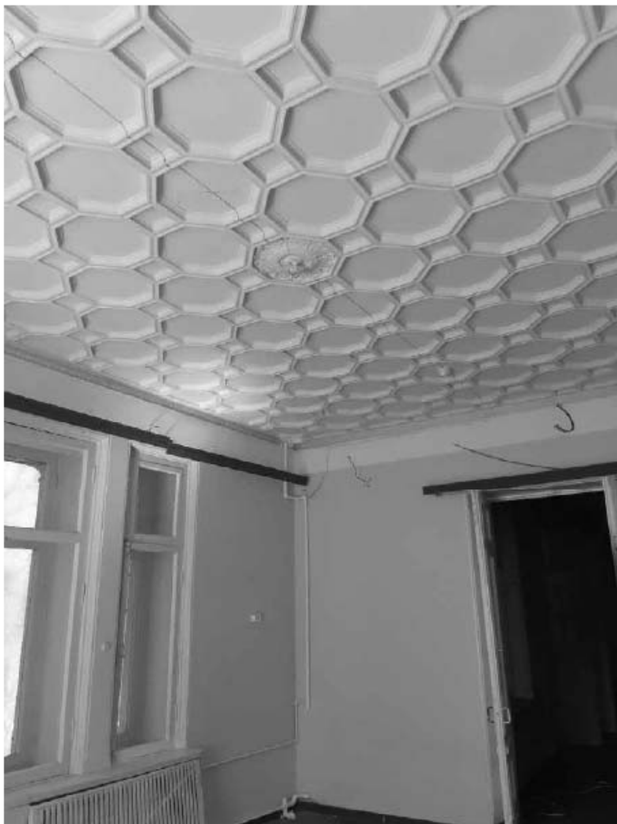
Фото 20. ОКН «Лечебница А.Л. Эбермана». Главное здание по адресу: СПб, г. Пушкин, Московское шоссе, д. 7. Помещение 1.16. Общий вид. Дата съёмки: 10.05.2022.
