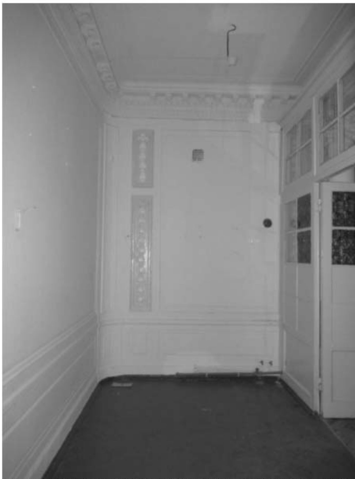
Фото 11. ОКН «Лечебница А.Л. Эбермана». Главное здание по адресу: СПб, г. Пушкин, Московское шоссе, д. 7. Помещение 1.13. Общий вид. Дата съёмки: 10.05.2022.
