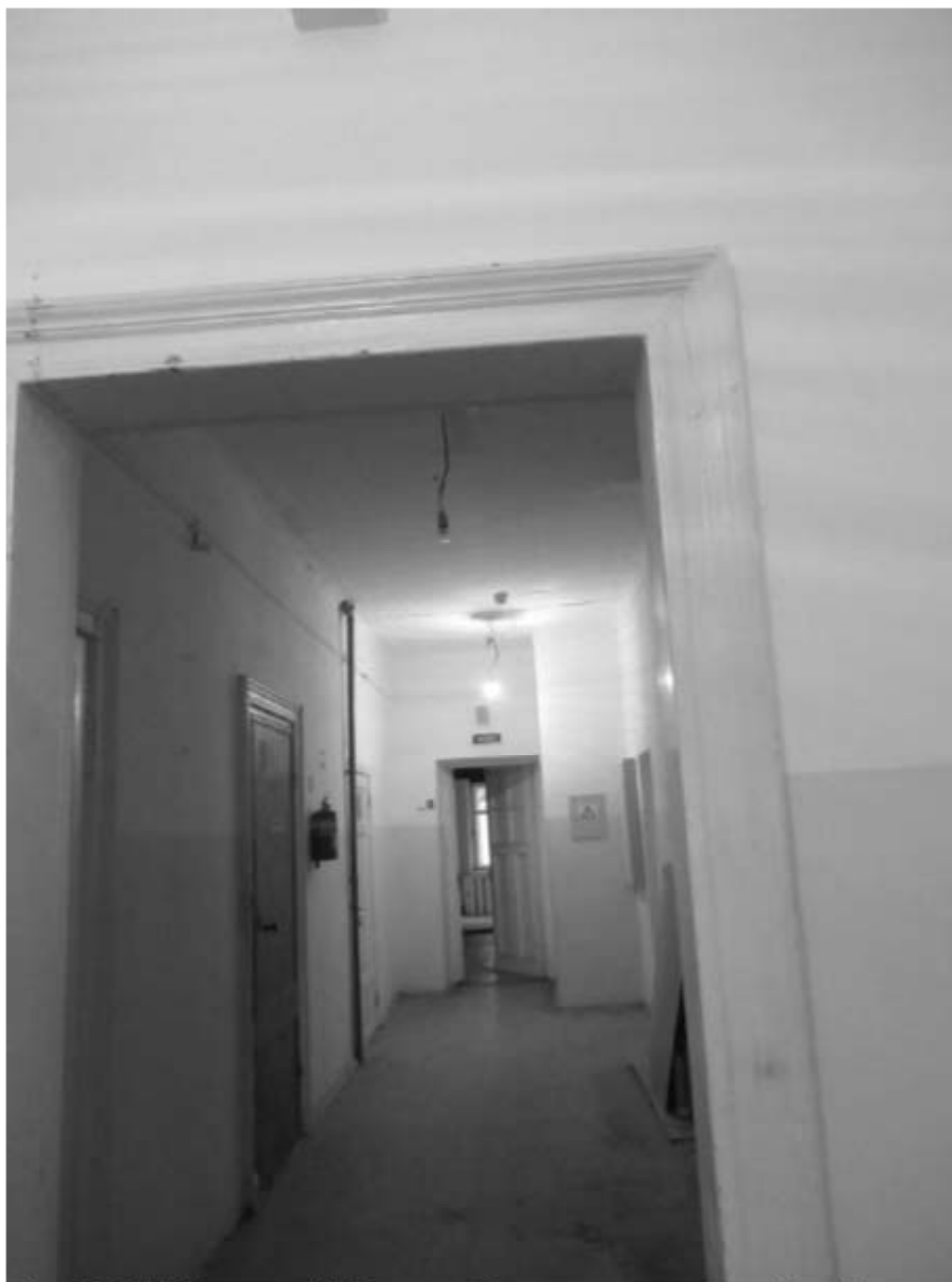
Фото 18. ОКН «Лечебница А.Л. Эбермана». Главное здание по адресу: СПб, г. Пушкин, Московское шоссе, д. 7. Помещение 1.8. Общий вид. Дата съёмки: 10.05.2022.
