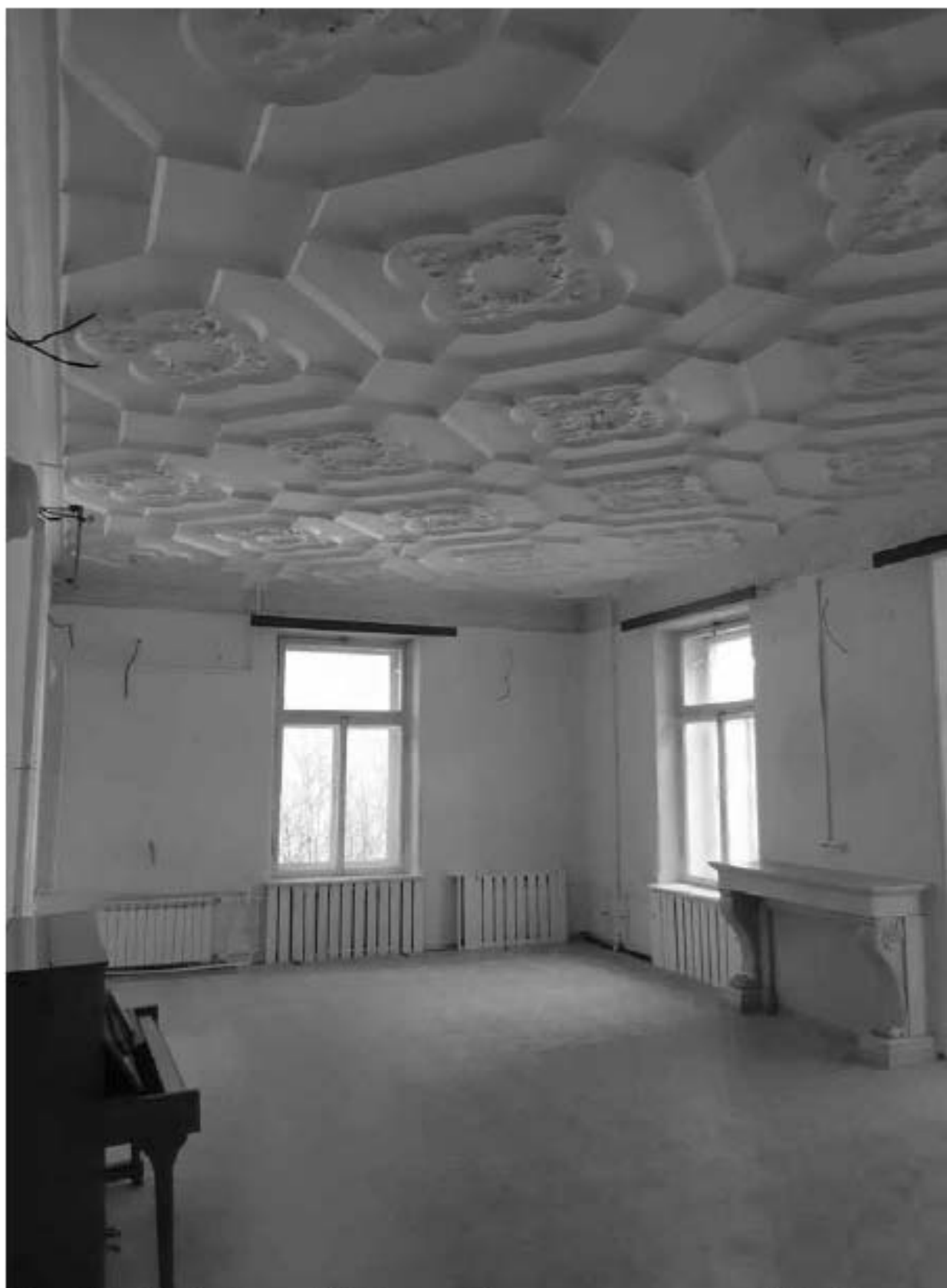
Фото 10. ОКН «Лечебница А.Л. Эбермана». Главное здание по адресу: СПб, г. Пушкин, Московское шоссе, д. 7. Помещение 1.12. Общий вид. Дата съёмки: 10.05.2022.
