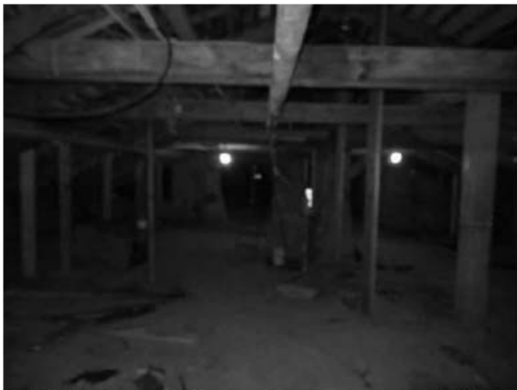
Фото 36. ОКН «Лечебница А.Л. Эбермана». Главное здание по адресу: СПб, г. Пушкин, Московское шоссе, д. 7. Помещение мансарды. Стропильные конструкции. Дата съёмки: 10.05.2022.
