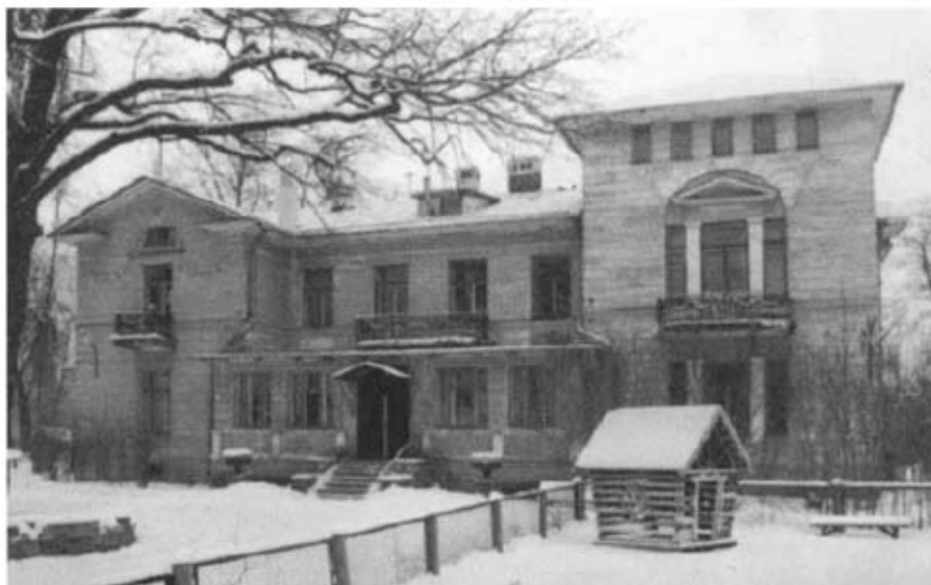
Ил. 37. Главное здание санатория «Малютка». Юго-западный фасад, 2004.
