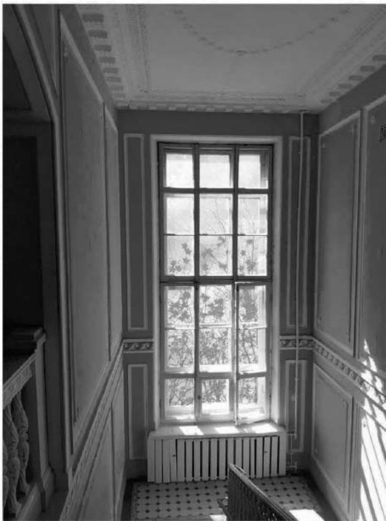
Фото 25. ОКН «Лечебница А.Л. Эбермана». Главное здание по адресу: СПб, г. Пушкин, Московское шоссе, д. 7. Помещение Л-1. Парадная лестница. Дата съёмки: 10.05.2022.
