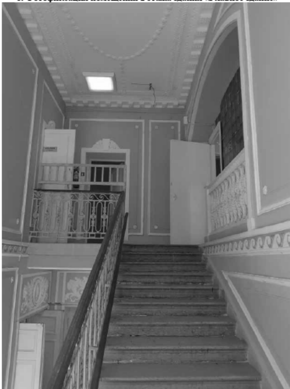
Фото 23. ОКН «Лечебница А.Л. Эбермана». Главное здание по адресу: СПб, г. Пушкин, Московское шоссе, д. 7. Помещение Л-1. Парадная лестница. Дата съёмки: 10.05.2022.
