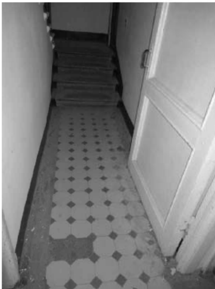
Фото 16. ОКН «Лечебница А.Л. Эбермана». Главное здание по адресу: СПб, г. Пушкин, Московское шоссе, д. 7. Помещение 1.22. Общий вид. Дата съёмки: 10.05.2022.
