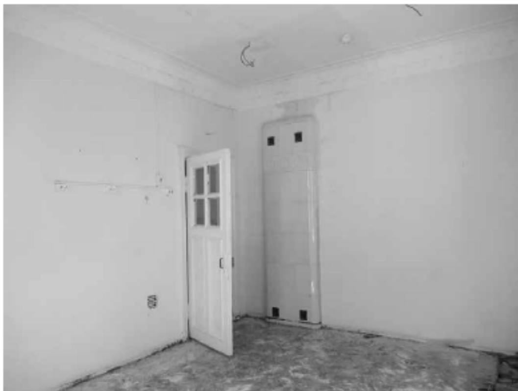
Фото 30. ОКН «Лечебница А.Л. Эбермана». Главное здание по адресу: СПб, г. Пушкин, Московское шоссе, д. 7. Помещение 2.16. Общий вид. Дата съёмки: 10.05.2022.
