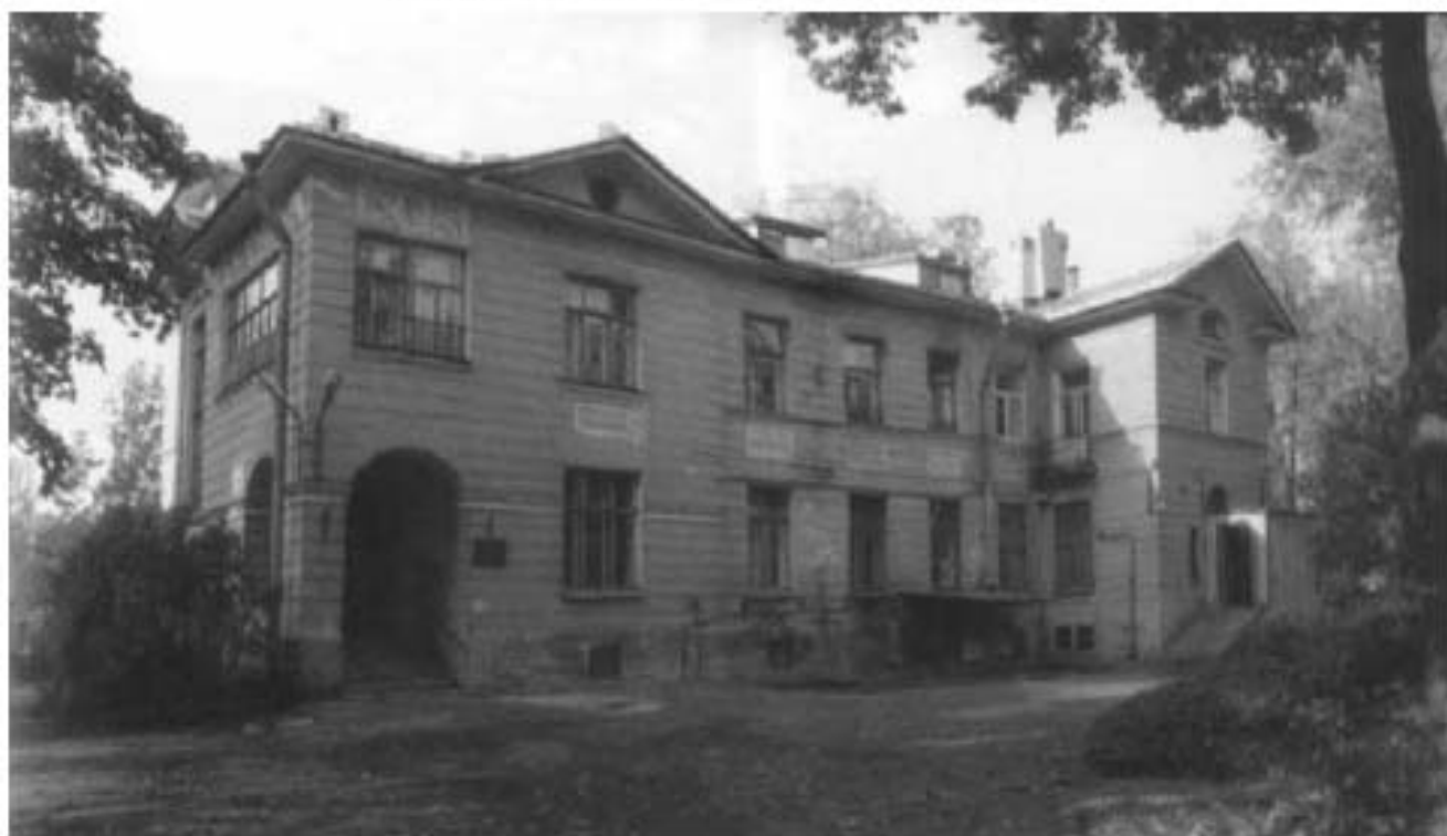
Ил. 45. Главное здание санатория «Малютка». Северо-восточный фасад, 2005.
