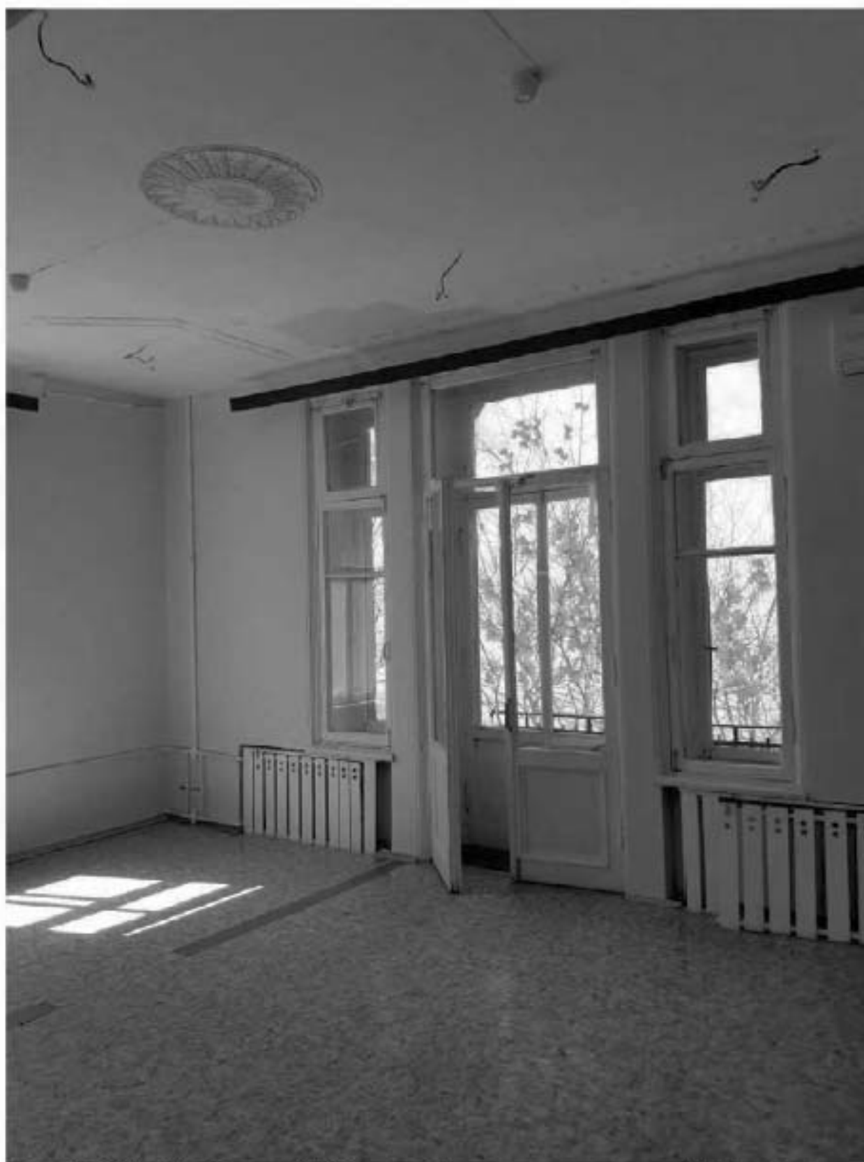
Фото 31. ОКН «Лечебница А.Л. Эбермана». Главное здание по адресу: СПб, г. Пушкин, Московское шоссе, д. 7. Помещение 2.19. Общий вид Дата съёмки: 10.05.2022.
