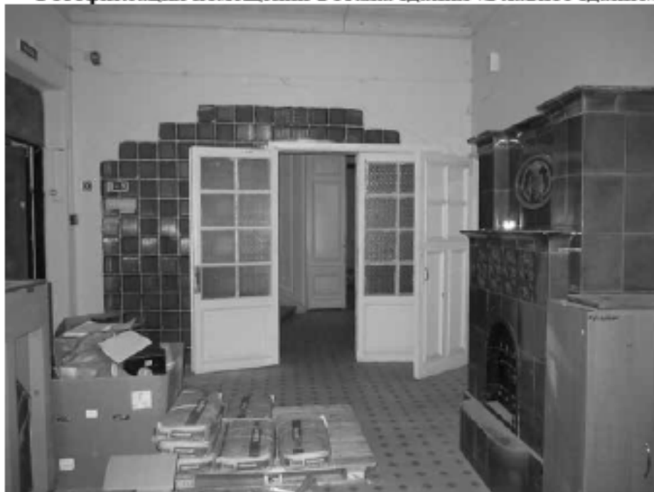
Фото 1. ОКН «Лечебница А.Л. Эбермана». Главное здание по адресу: СПб, г. Пушкин, Московское шоссе, д. 7. Помещение 1.1. Общий вид. Дата съёмки: 10.05.2022.
