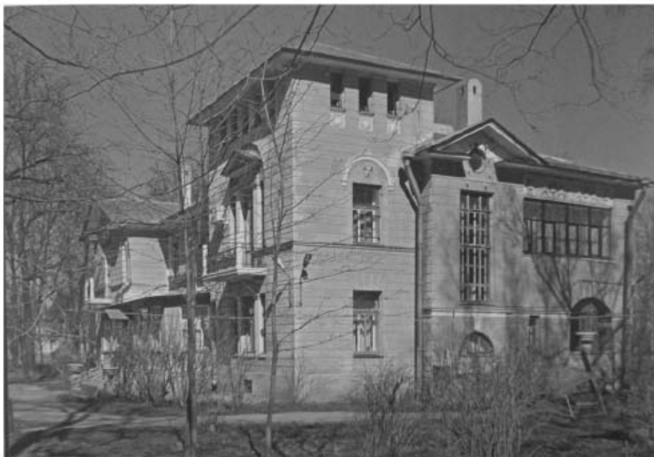
Ил. 46. Главное здание санатория «Малютка» (бывший дом сенатора Фролова), юго-восточный фасад, до 2010.
