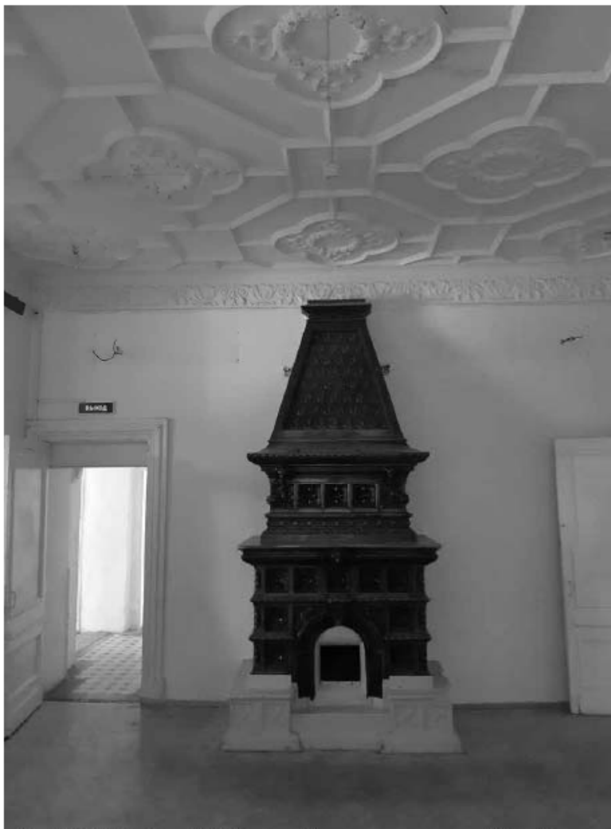
Фото 7. ОКН «Лечебница А.Л. Эбермана». Главное здание по адресу: СПб, г. Пушкин, Московское шоссе, д. 7. Помещение 1.12. Печь. Дата съёмки: 10.05.2022.
